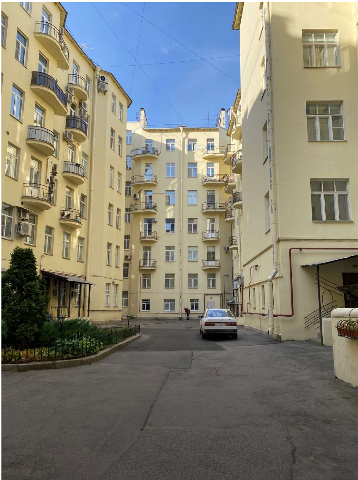
Фото 13. Общий вид дворового фасада объекта культурного наследия.
