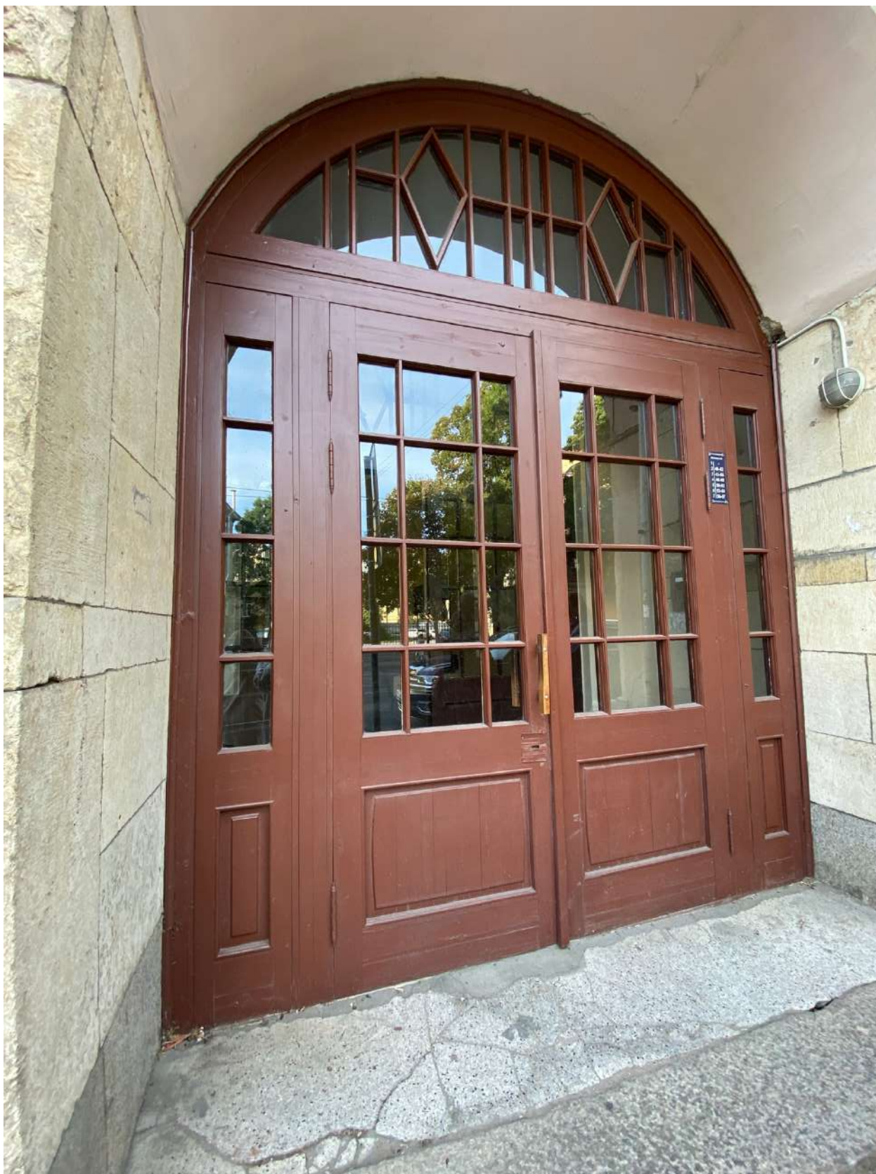
Фото 10. Вид на вход в парадную, ведущую в квартиру объекта культурного наследия.
