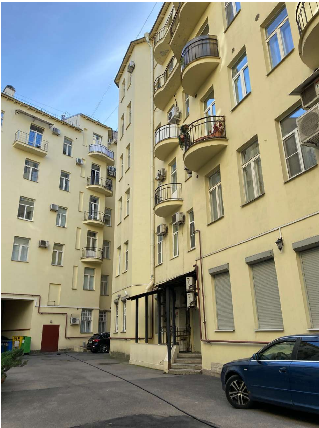
Фото 12. Общий вид дворового фасада объекта культурного наследия.
