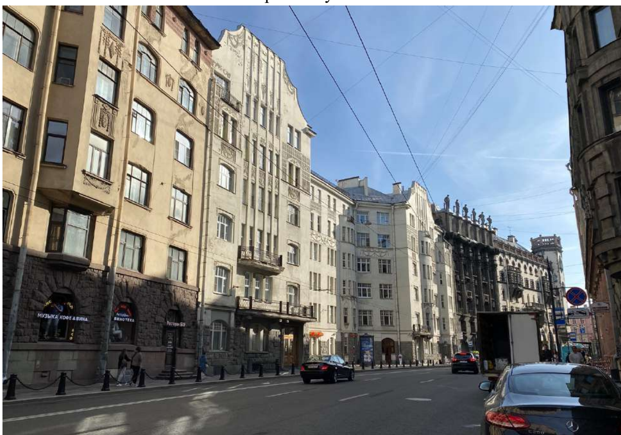
Фото 4. Общий вид фасада объекта культурного наследия по Большому проспекту П.С.
