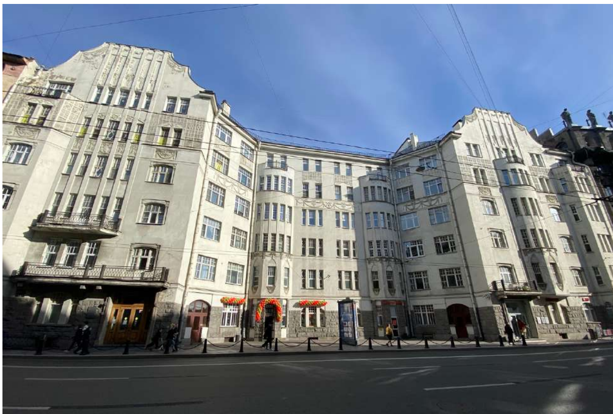
Фото 3. Общий вид фасада объекта культурного наследия по Большому проспекту П.С.
