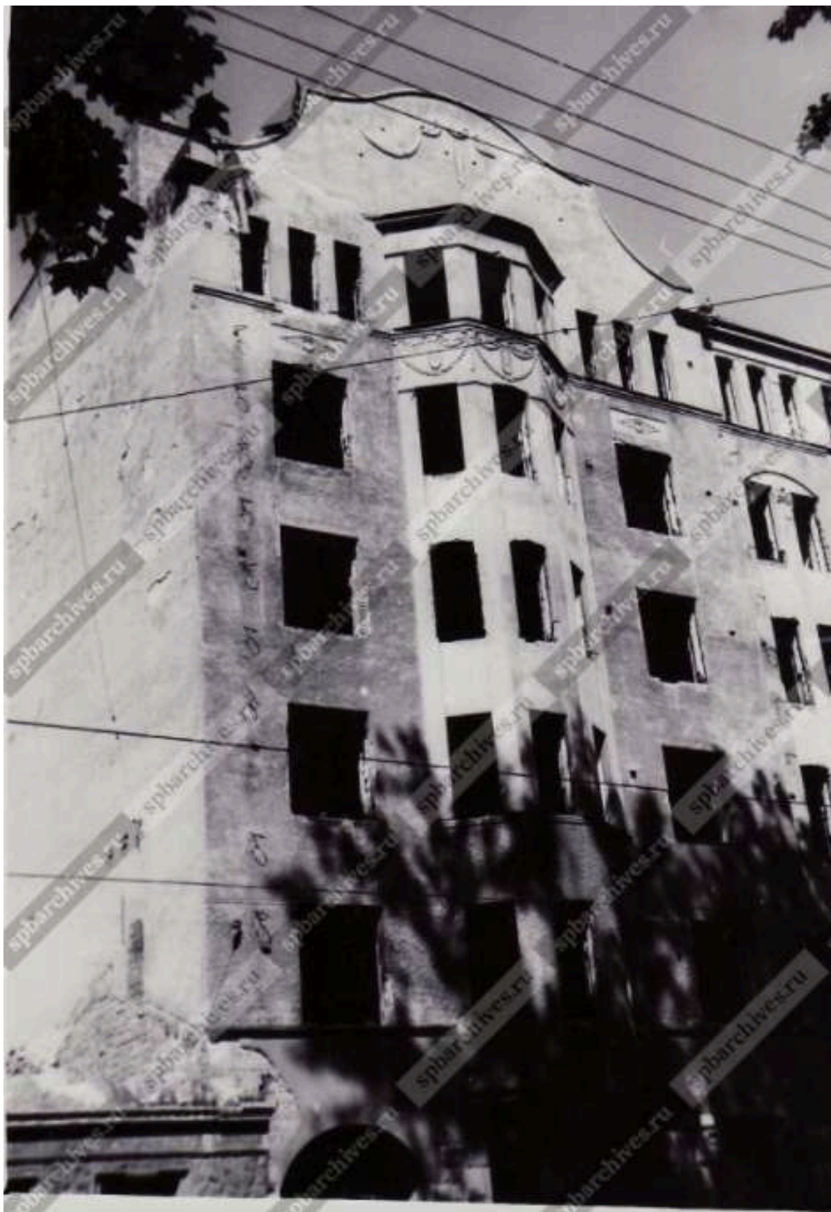
78. Вид части центрального фасада дома № 4 на улице Петропавловской во время капитального ремонта (архитектор С.С. Корвин-Круковский, 1910-1911 гг.), 1994 г. – ЦГАКФФД СПб – Фотодокумент Ар 215925
