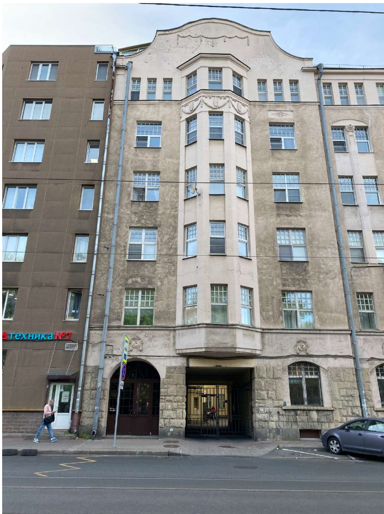
Фото 6. Фрагмент фасада объекта культурного наследия по Петропавловской улице.
