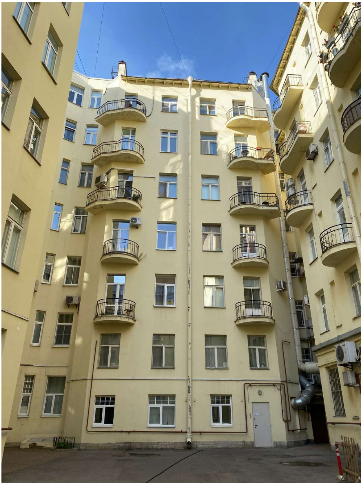
Фото 11. Общий вид дворового фасада объекта культурного наследия.
