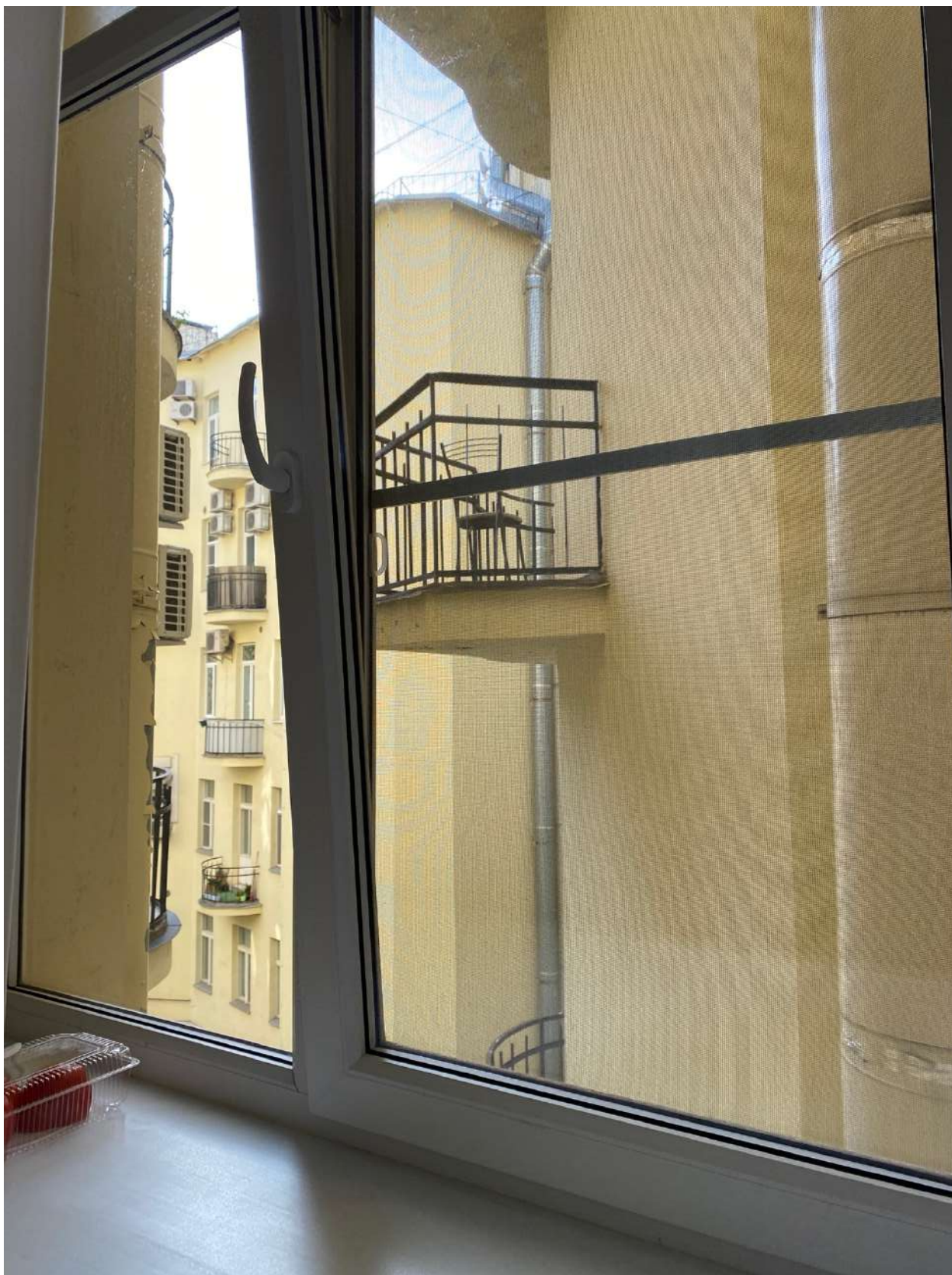
Фото 26. Вид на оконное заполнение квартиры № 49 объекта культурного наследия.
