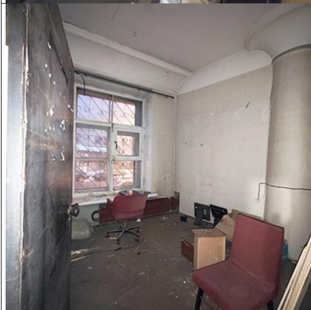
Фото №14. Вид на помещение 19.
