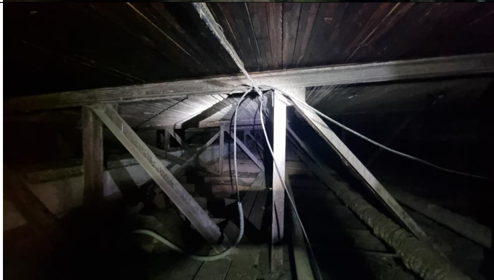
Фото №2. Вид на конструкции кровли
