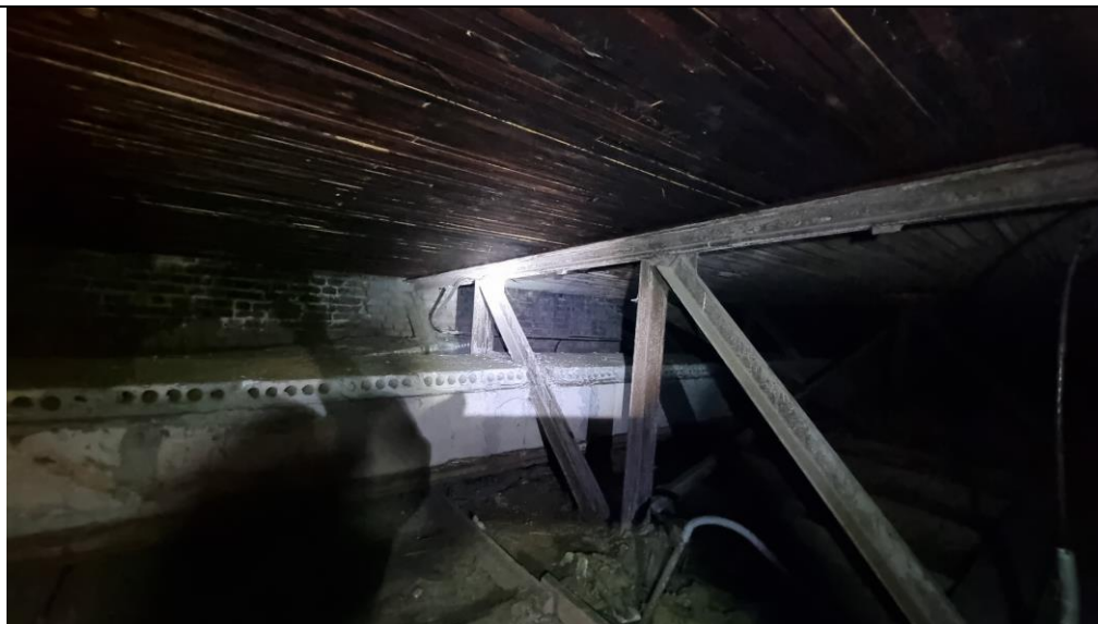
Фото №1. Вид на конструкции кровли
