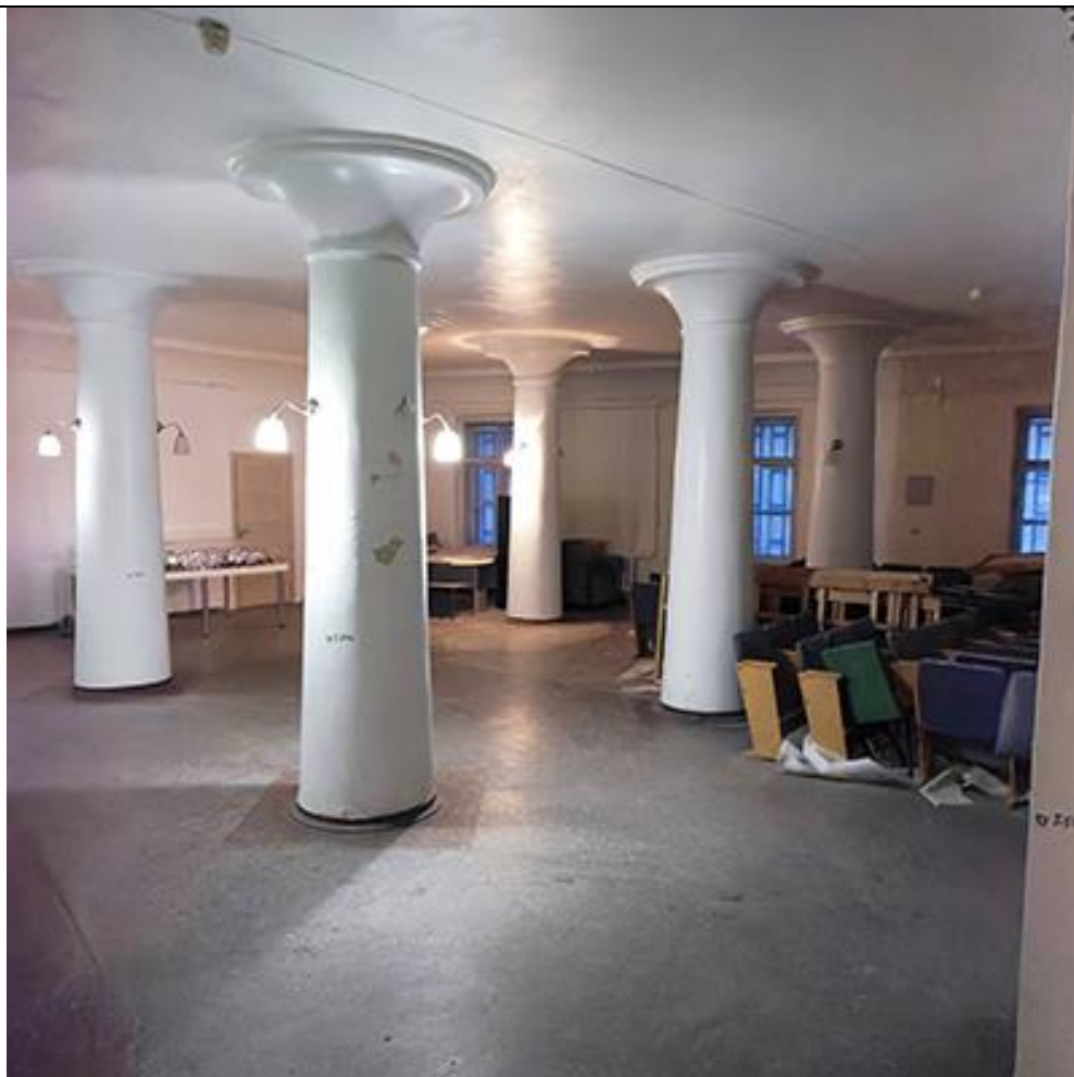
Фото №3. Вид на колонны. Пом.24
