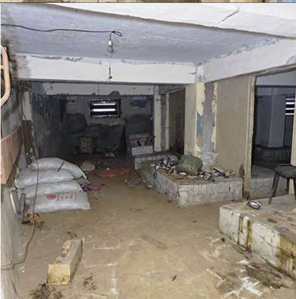
Фото №2. Вид на помещение 13.
