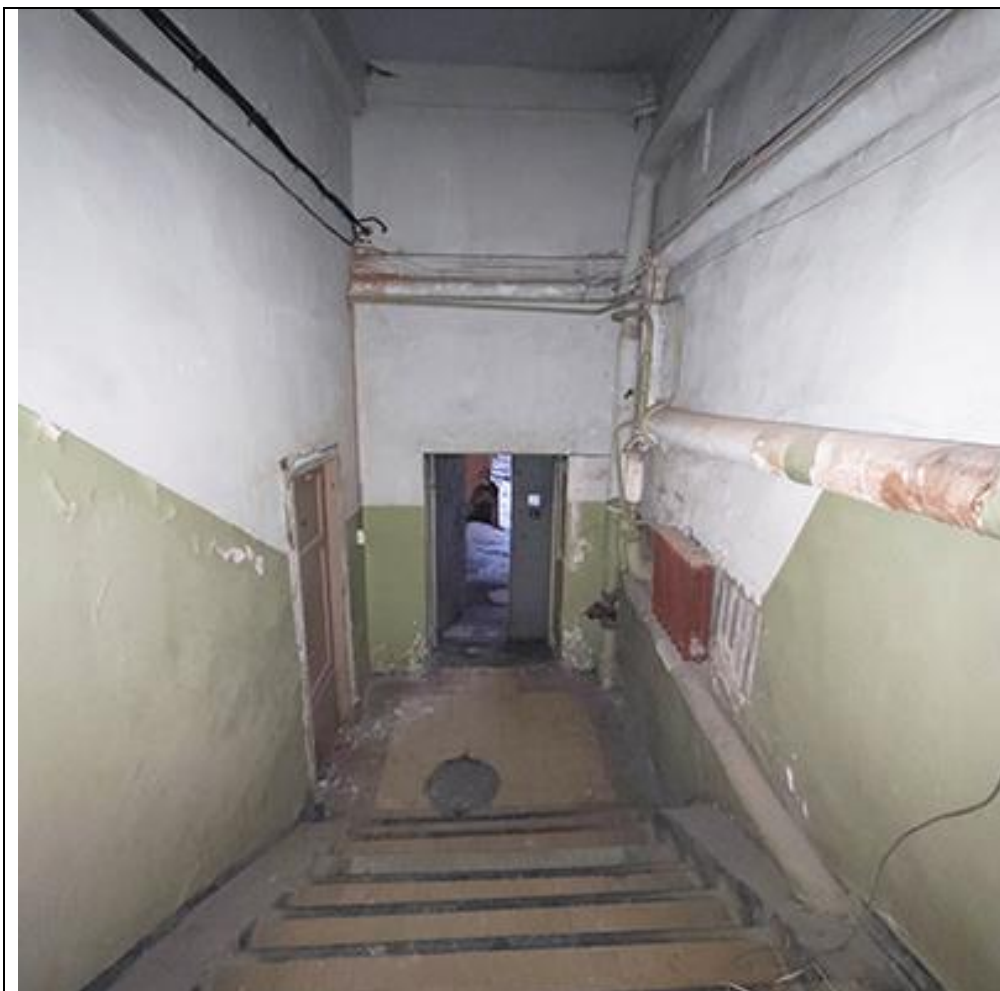
Фото №5. Вид на лестницу ведущую во двор.
