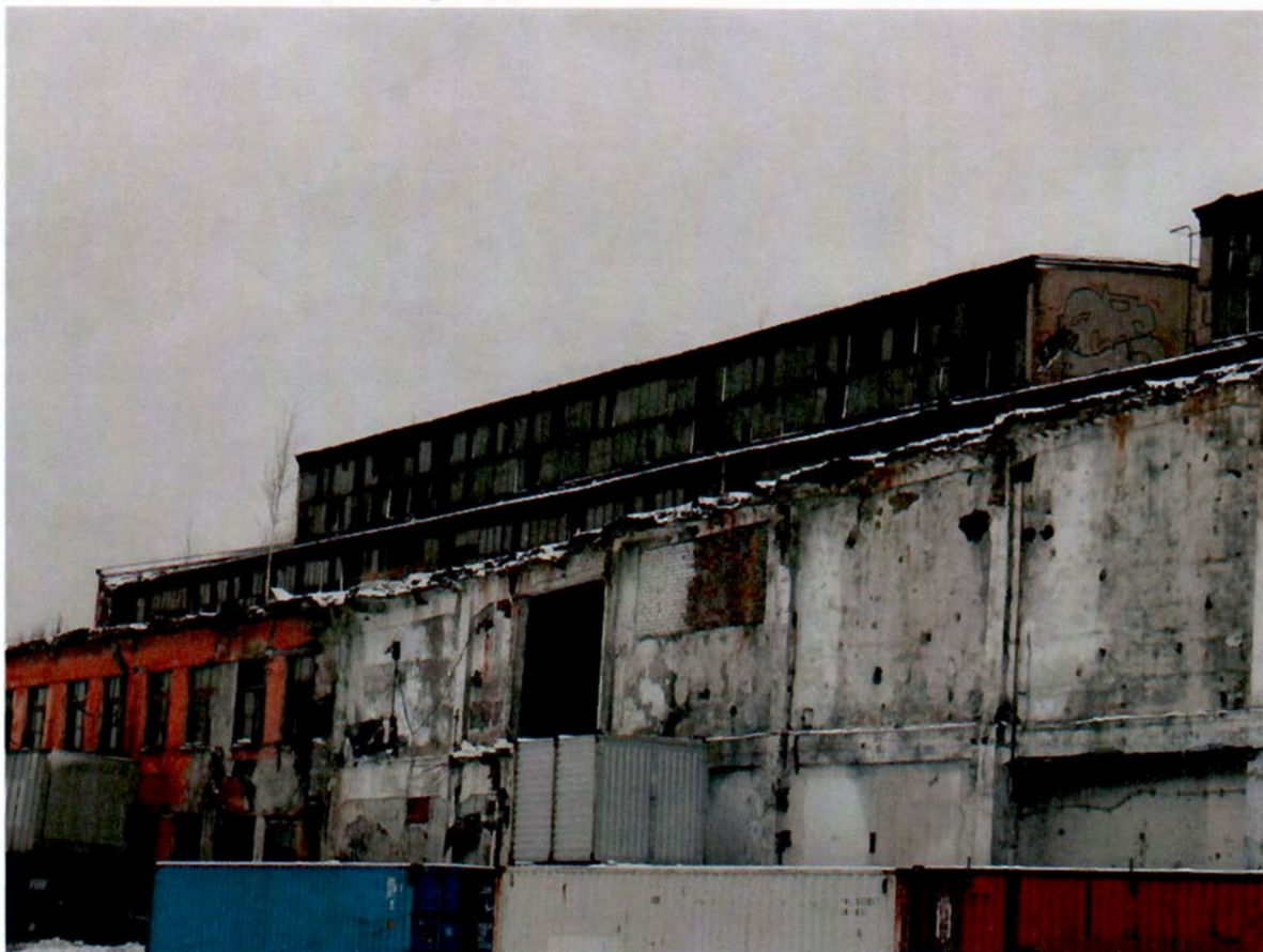
5. Западный дворовый фасад
