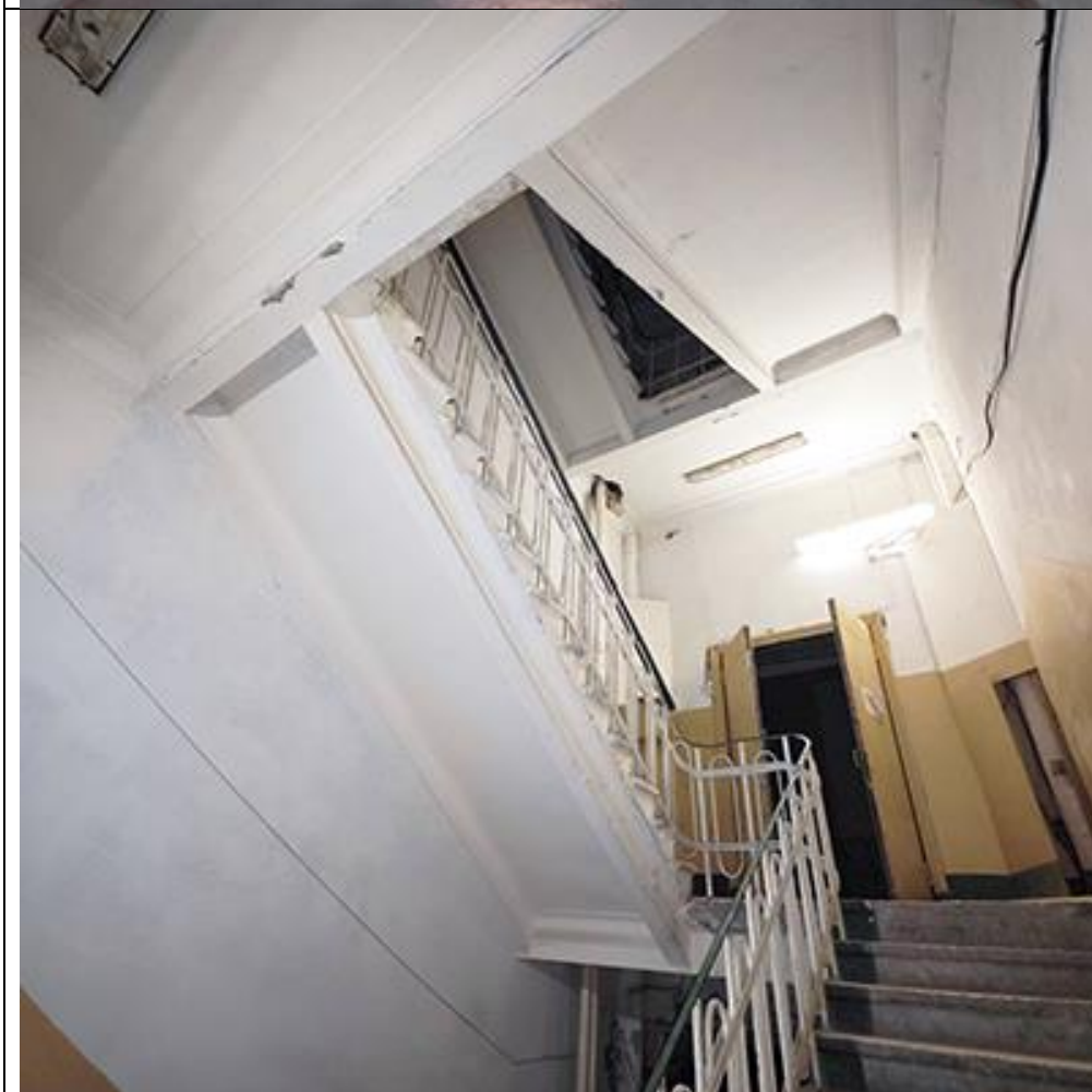
Фото №14. Вид на лестничную клетку.
