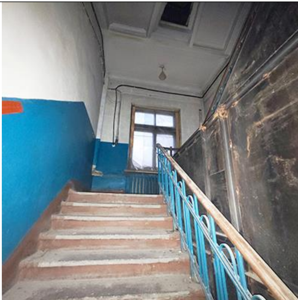
Фото №19. Вид на лестницу
