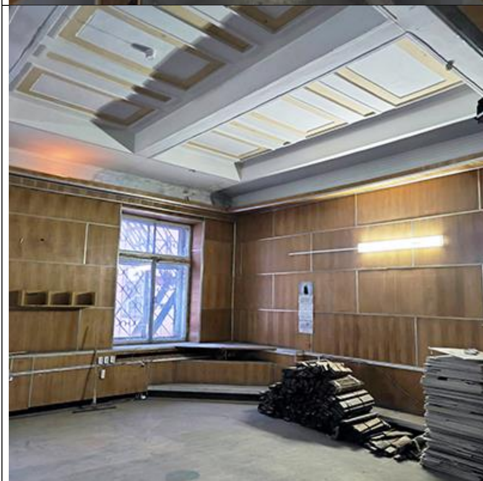
Фото №6. Вид на помещение. Пом. 48
