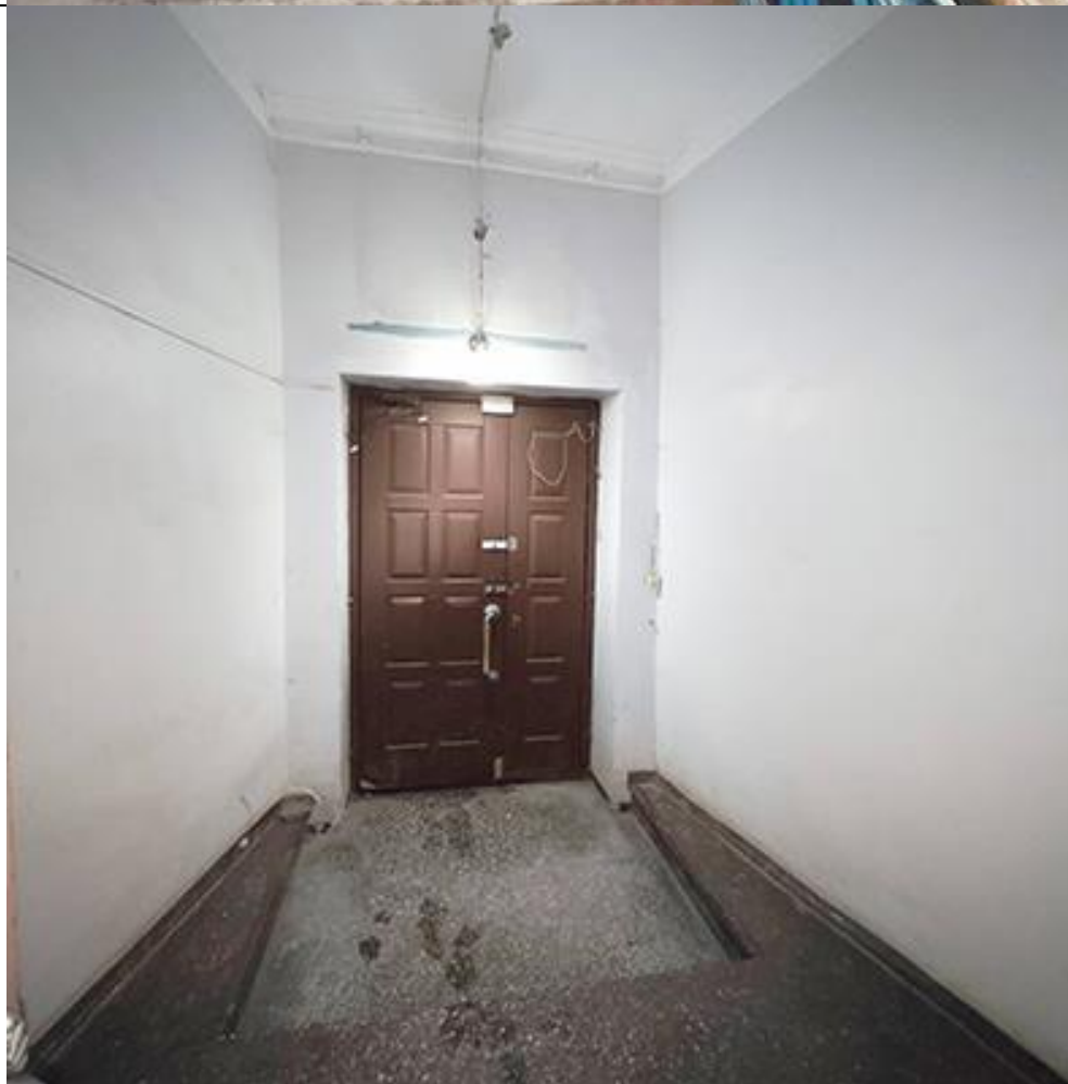
Фото №20. Вид на входную дверь. Пом. 21
