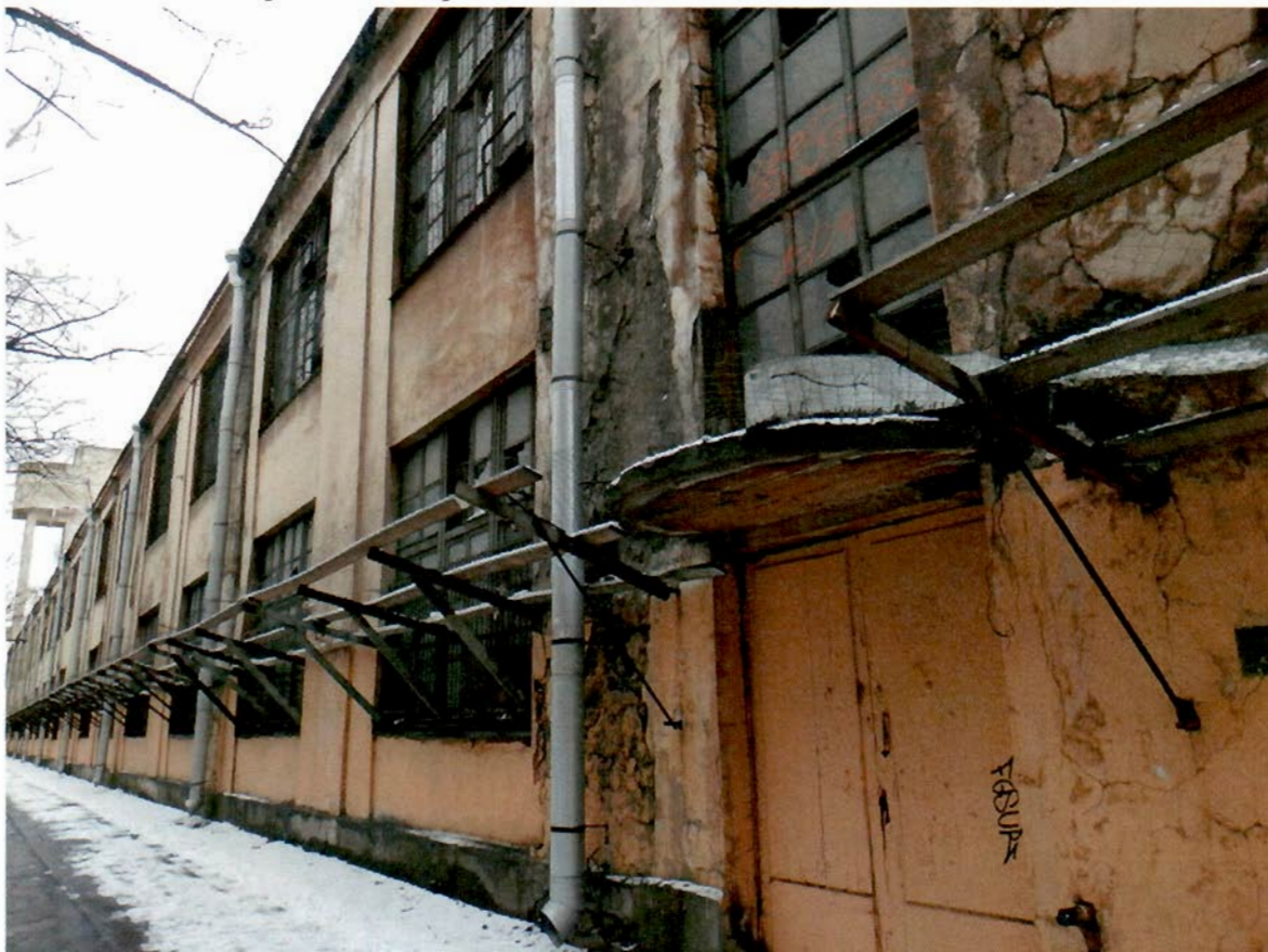
3. Лицевой фасад со стороны 25 линии В.О.
