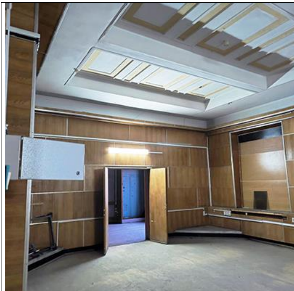
Фото №7. Вид на помещение. Пом. 48
