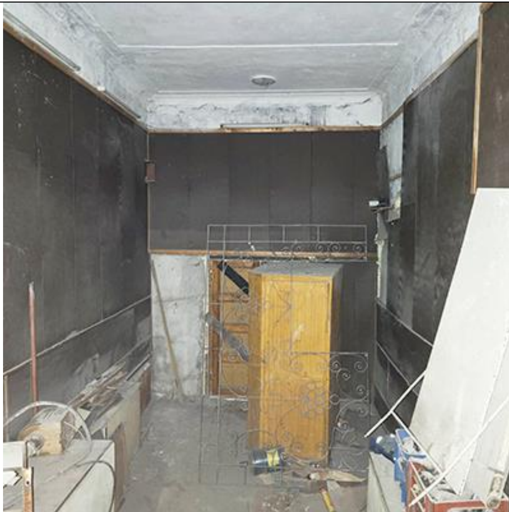
Фото №21. Вид на входную дверь из ЛК. Пом.7
