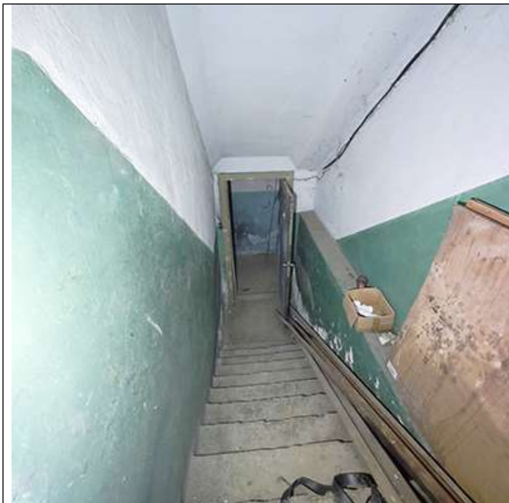
Фото №7. Вид на лестницу
