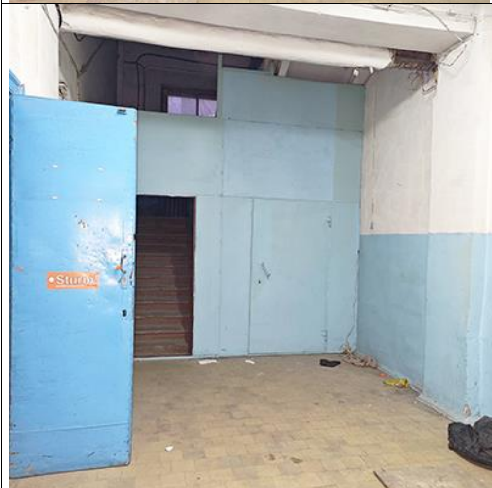
Фото №18. Вид на лестницу
