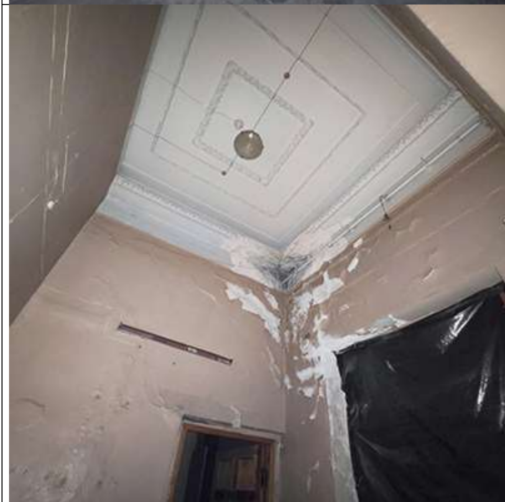
Фото №14. Вид на потолок помещения 27
