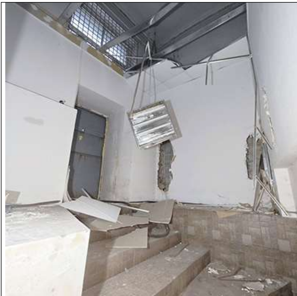
Фото №5. Вид на лестничную клетку.
