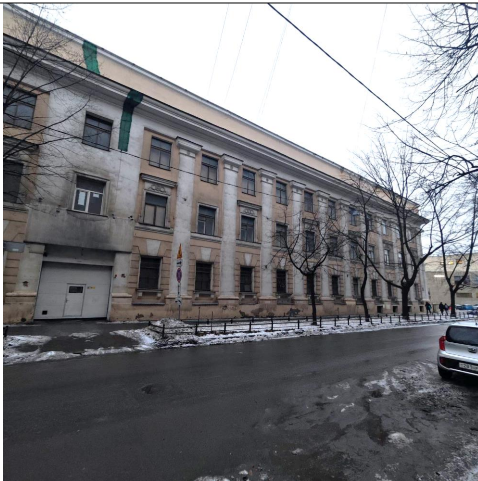
Фото № 3. Вид на главный фасад (северо-восточн) объекта культурного наследия регионального значения «Заводоуправление Сталепрокатного завода», расположенного по адресу: г. Санкт-Петербург, 25-я линия В.О., дом 8, литера А (Санкт-Петербург, Василеостровский район, 25-я линия, 8, литера А).
