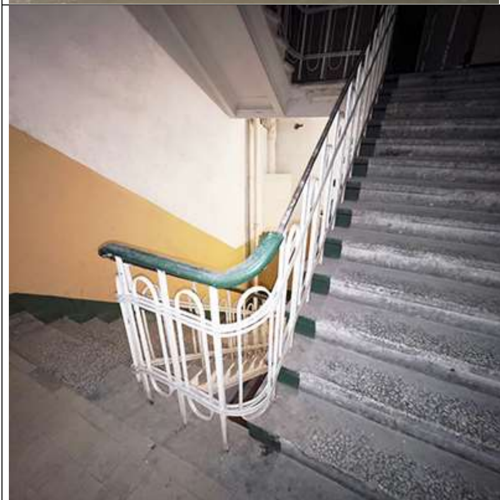
Фото №20. Вид на лестничную клетку.
