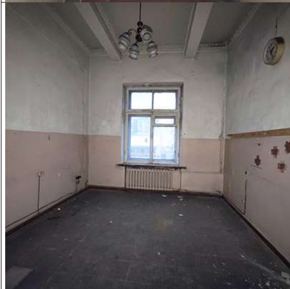
Фото №8. Вид на помещение. Пом. 12
