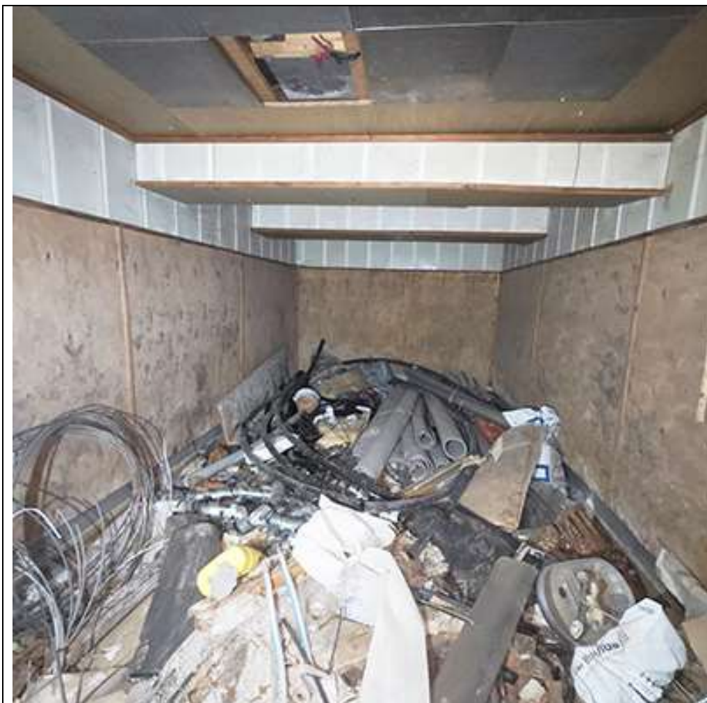
Фото №9. Вид на помещение 5
