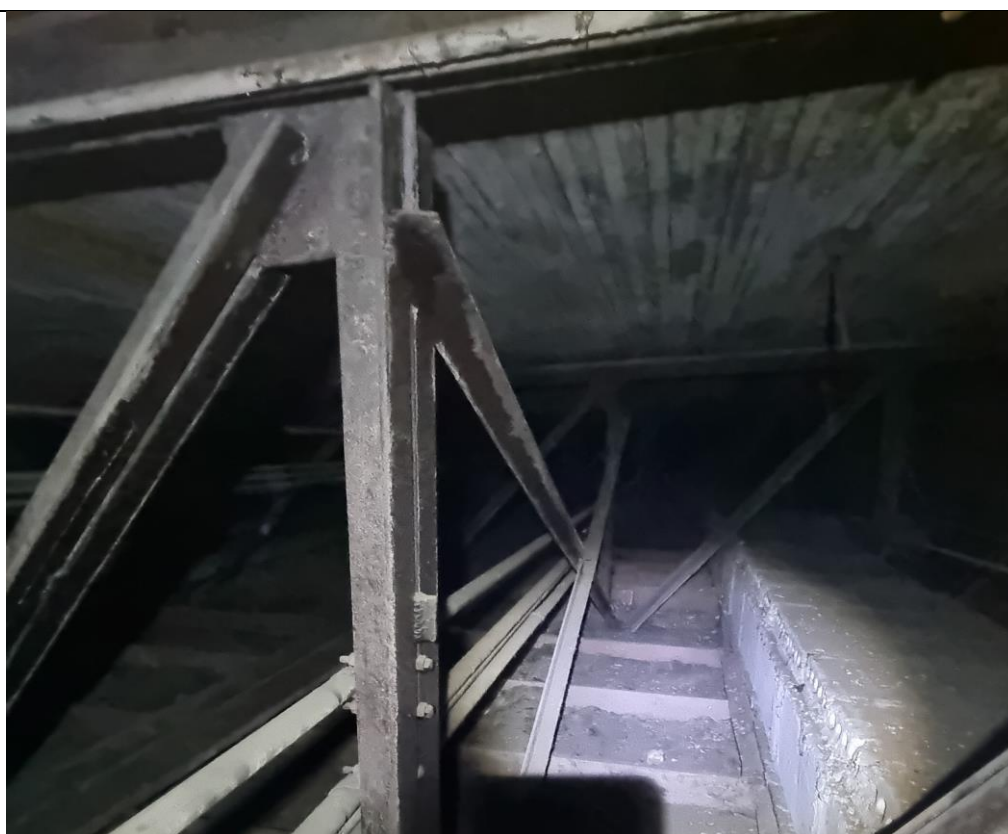
Фото №3. Вид на конструкции кровли
