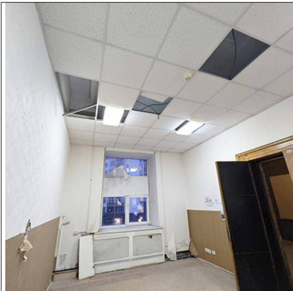
Фото №11. Вид на потолок. Пом. 44
