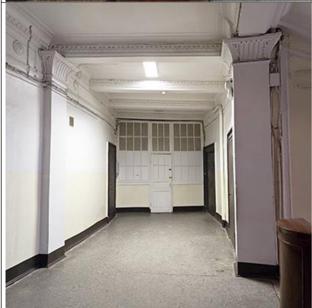
Фото №2. Вид на холл перед лестницей. Пом. 15
