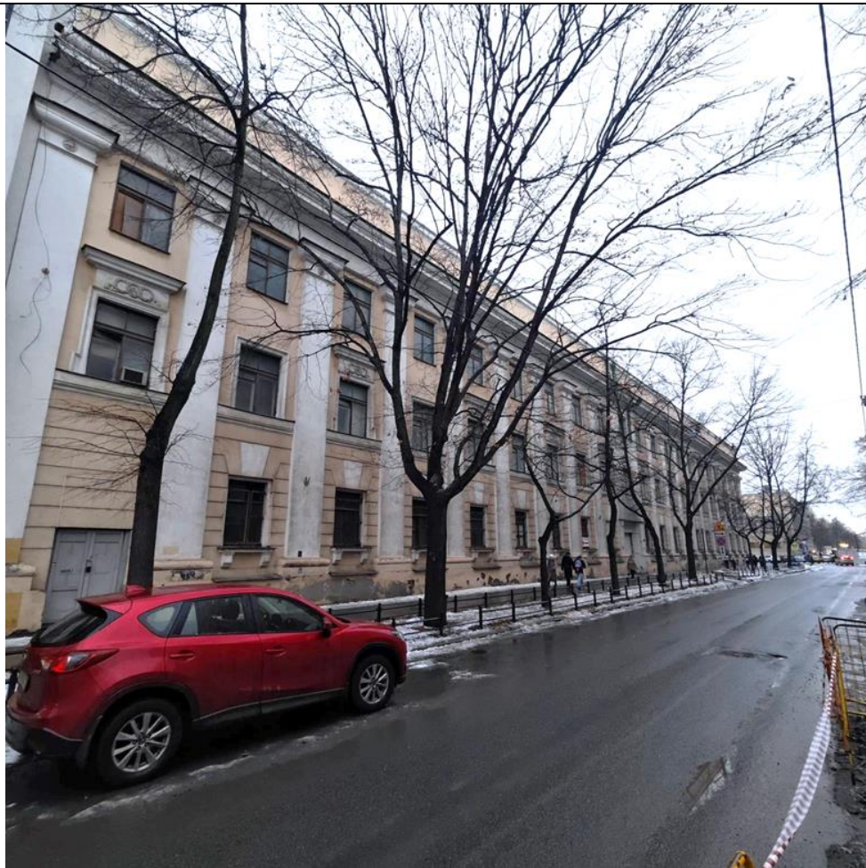
Фото № 1. Вид на главный фасад (северо-восточный) объекта культурного наследия регионального значения «Заводоуправление Сталепрокатного завода», расположенного по адресу: г. Санкт-Петербург, 25-я линия В.О., дом 8, литера А (Санкт-Петербург, Василеостровский район, 25-я линия, 8, литера А).
