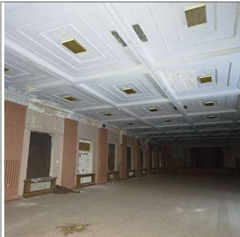
Фото №17. Вид на помещение 22
