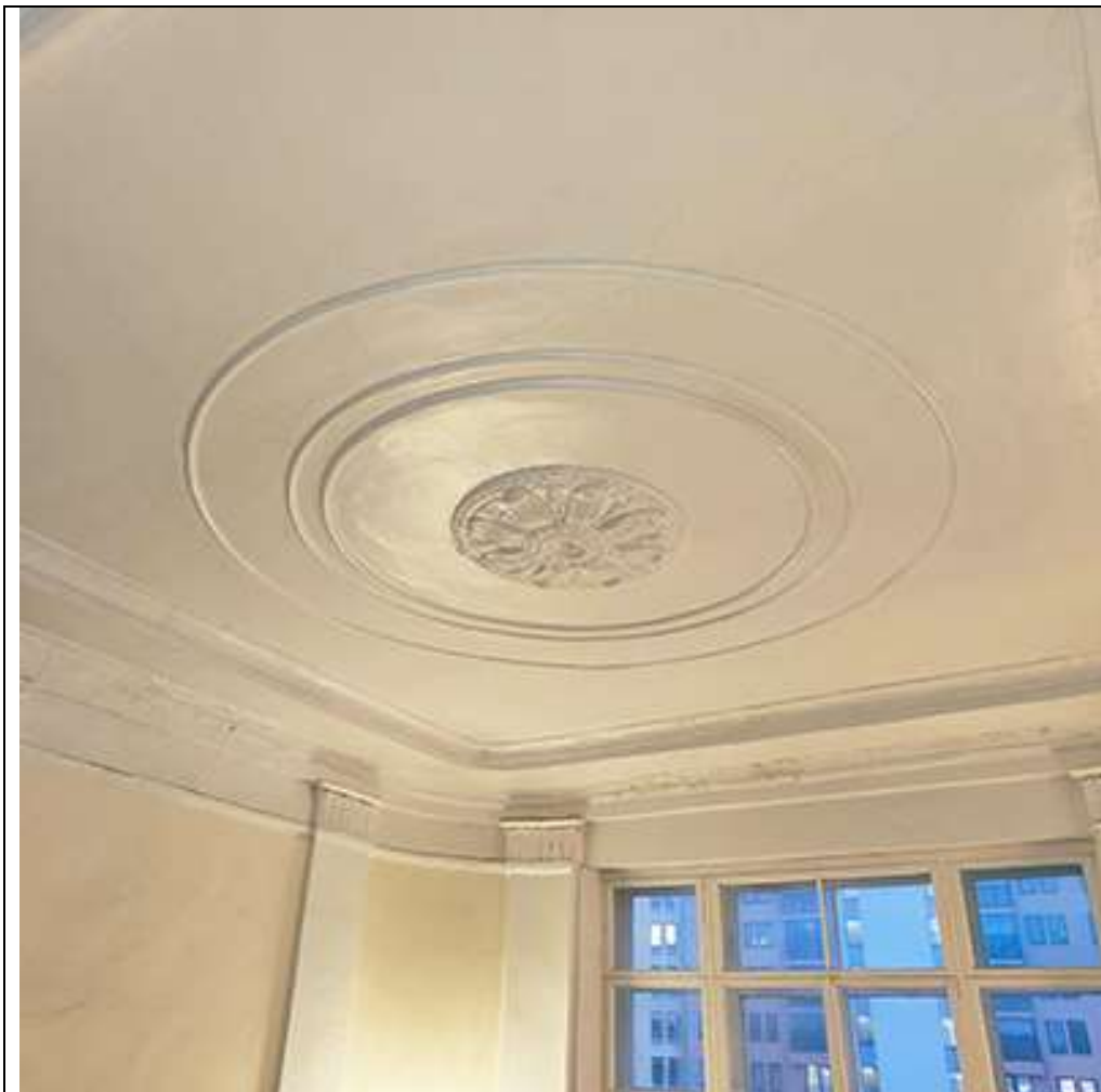
Фото №3. Вид на потолок лестницы главного входа
