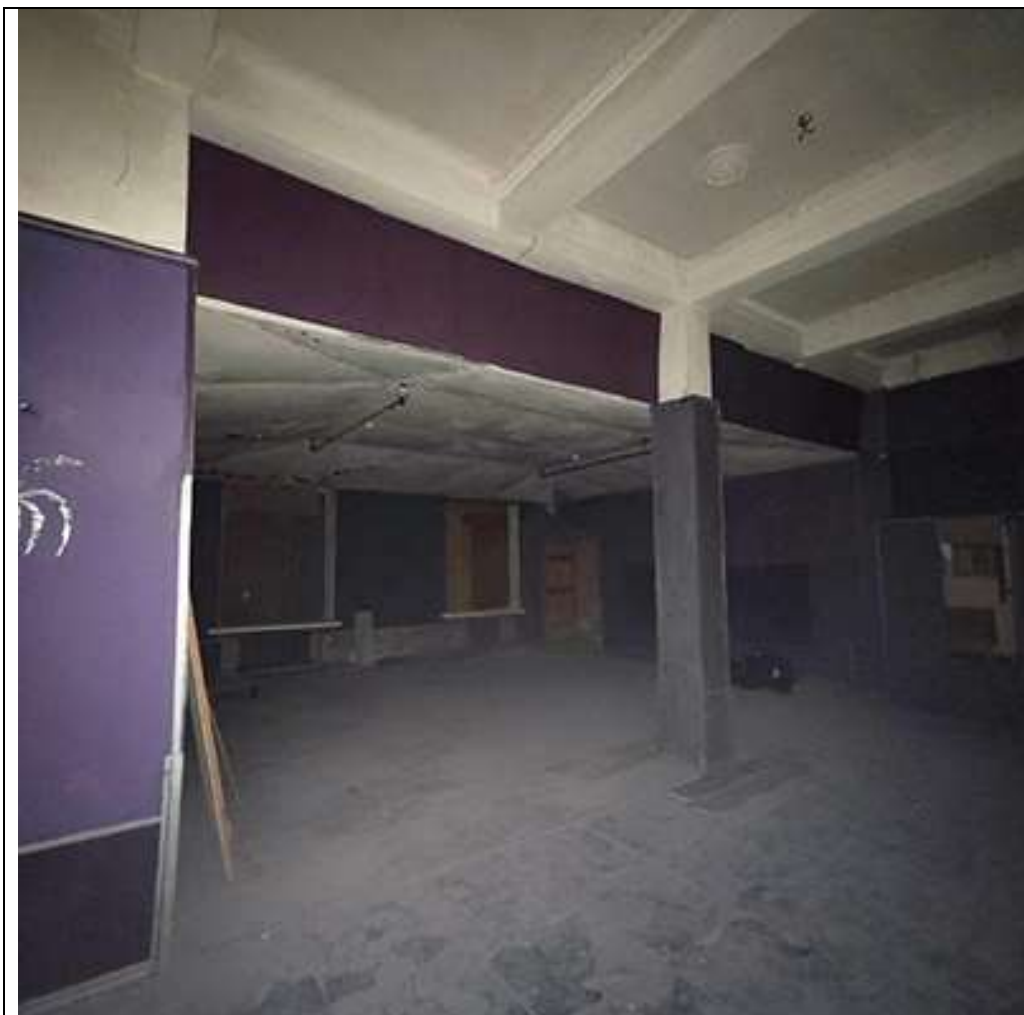
Фото №13. Вид на помещение 25
