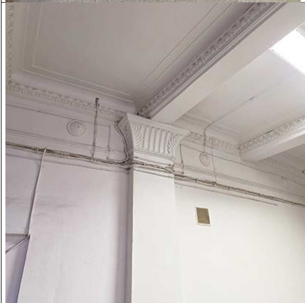
Фото №4. Вид на пилястру и потолок. Пом. 15
