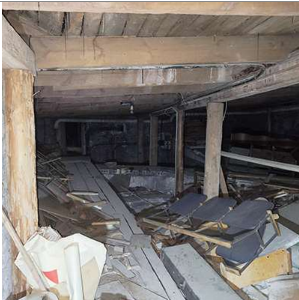
Фото №4. Вид на конструкции кровли
