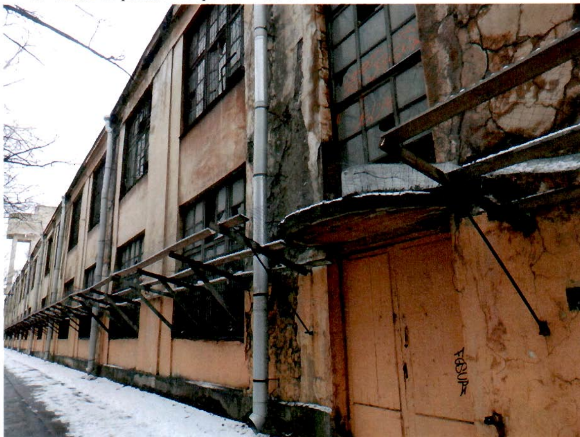
3. Лицевой фасад со стороны 25 линии В.О.
