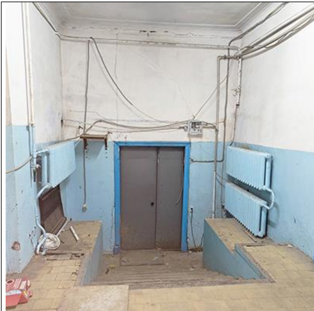
Фото №17. Вид на входную дверь на ЛК
