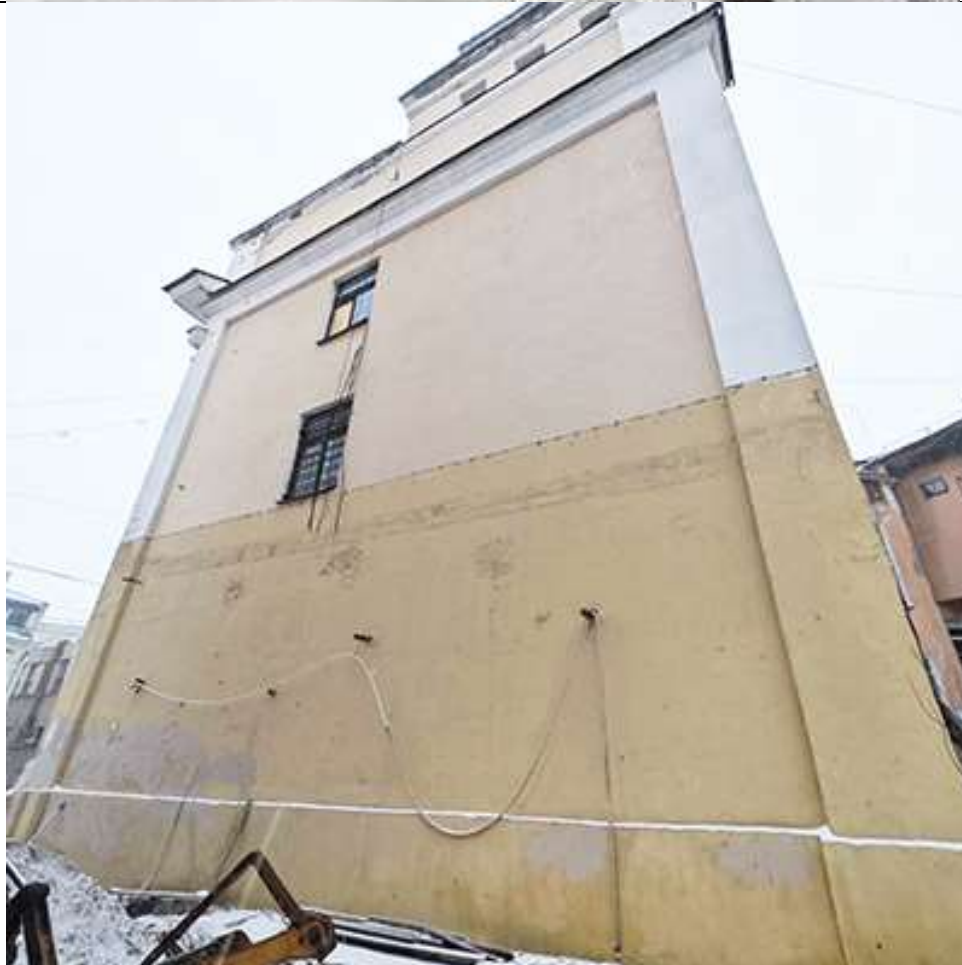
Фото № 10. Вид на лицевой фасад (юго-восточный) объекта культурного наследия регионального значения «Заводоуправление Сталепрокатного завода», расположенного по адресу: г. Санкт-Петербург, 25-я линия В.О., дом 8, литера А (Санкт-Петербург, Василеостровский район, 25-я линия, 8, литера А).
