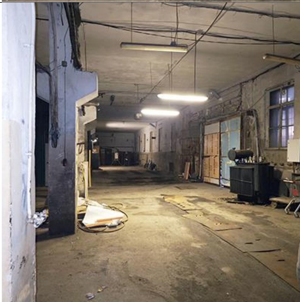
Фото №10. Вид на помещение 1.
