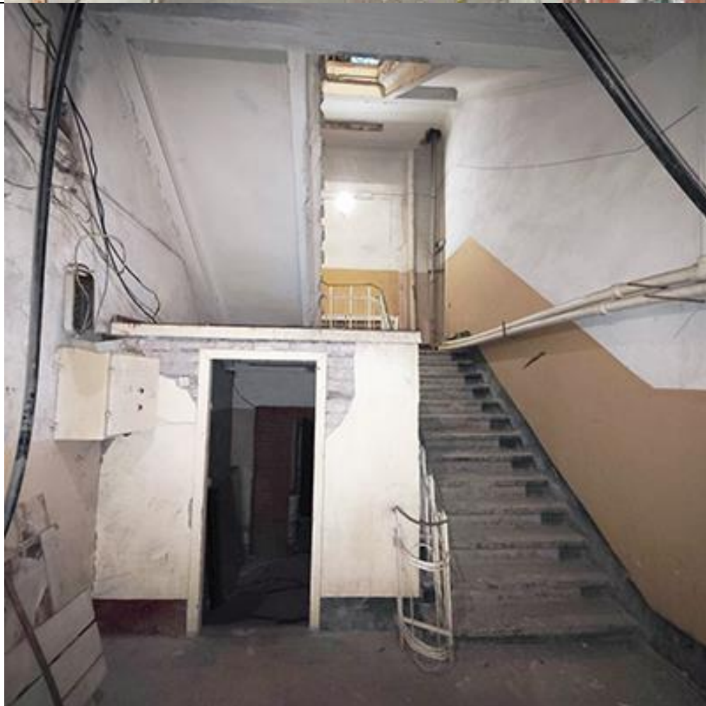
Фото №22. Вид на лестницу. Пом.7
