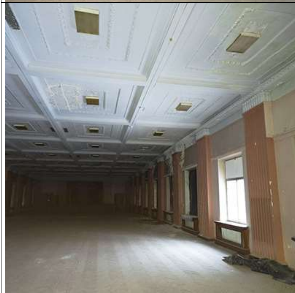
Фото №18. Вид на помещение 22
