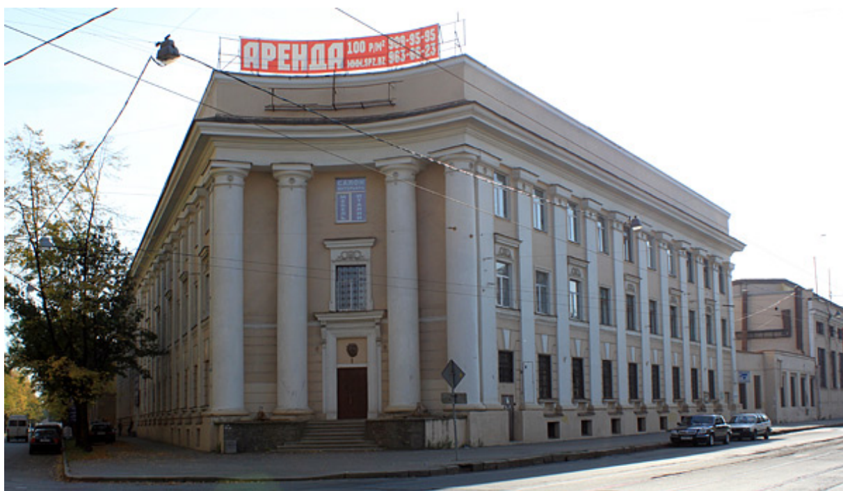
6. Заводское управление Сталепрокатного завода, фото 2010 г. https://www.citywalls.ru/house16217.html
