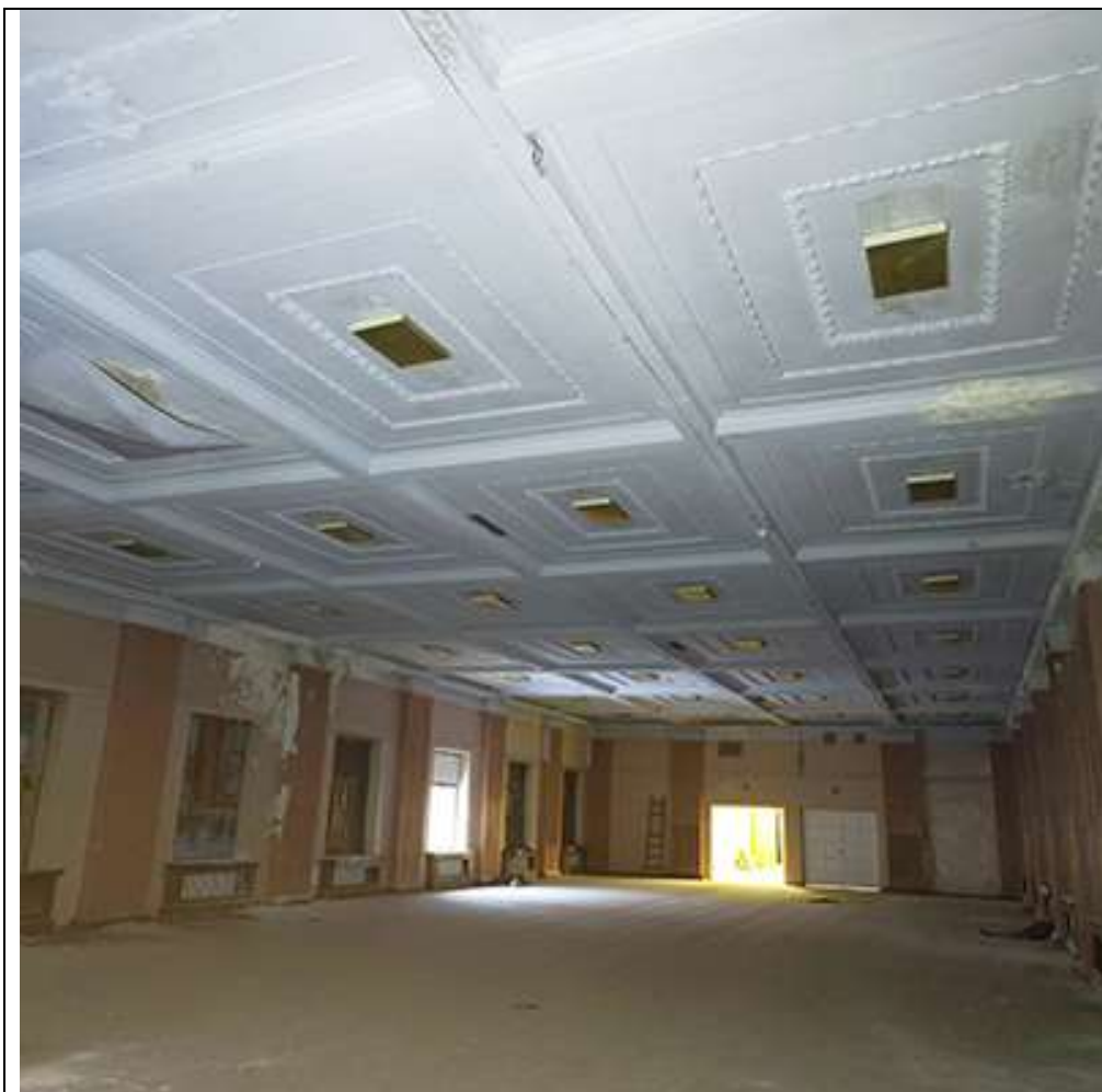
Фото №19. Вид на помещение 22
