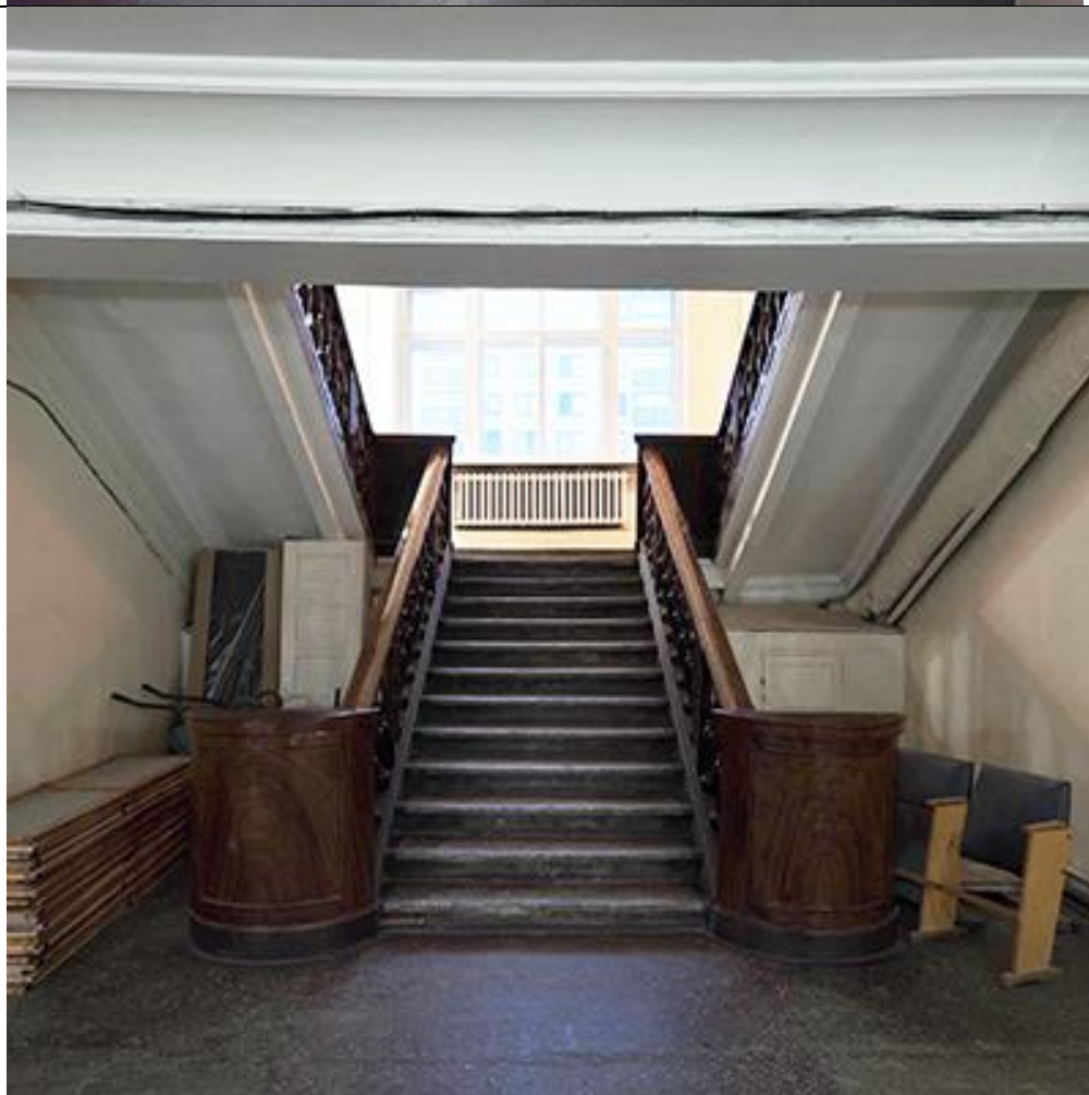
Фото №4. Вид на лестницу. Пом.24
