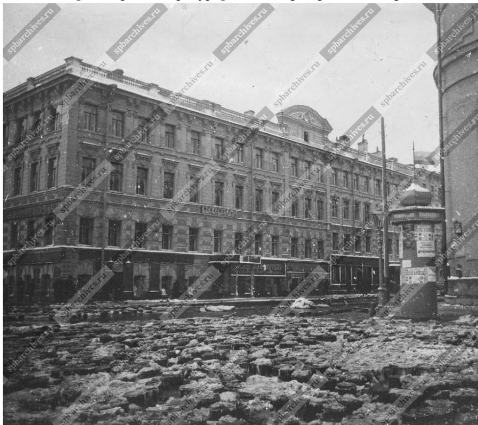
13. Разрушенная водой торцовая мостовая на пересечении улиц Офицерской и Глинки. Ноябрь 1903 г. // ЦГАКФФД СПб Б 1142.
