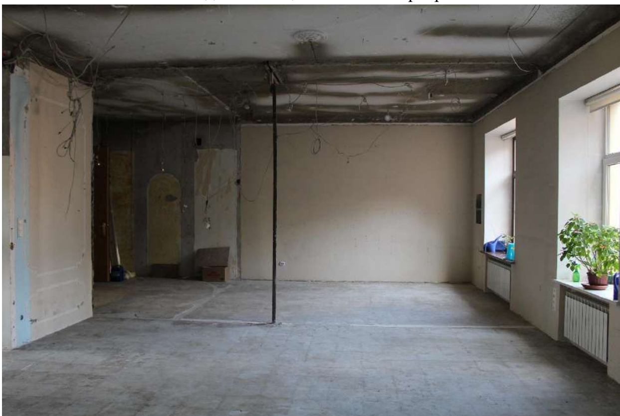
Фото 30. Вид на помещения № 1-4 квартиры № 557.
