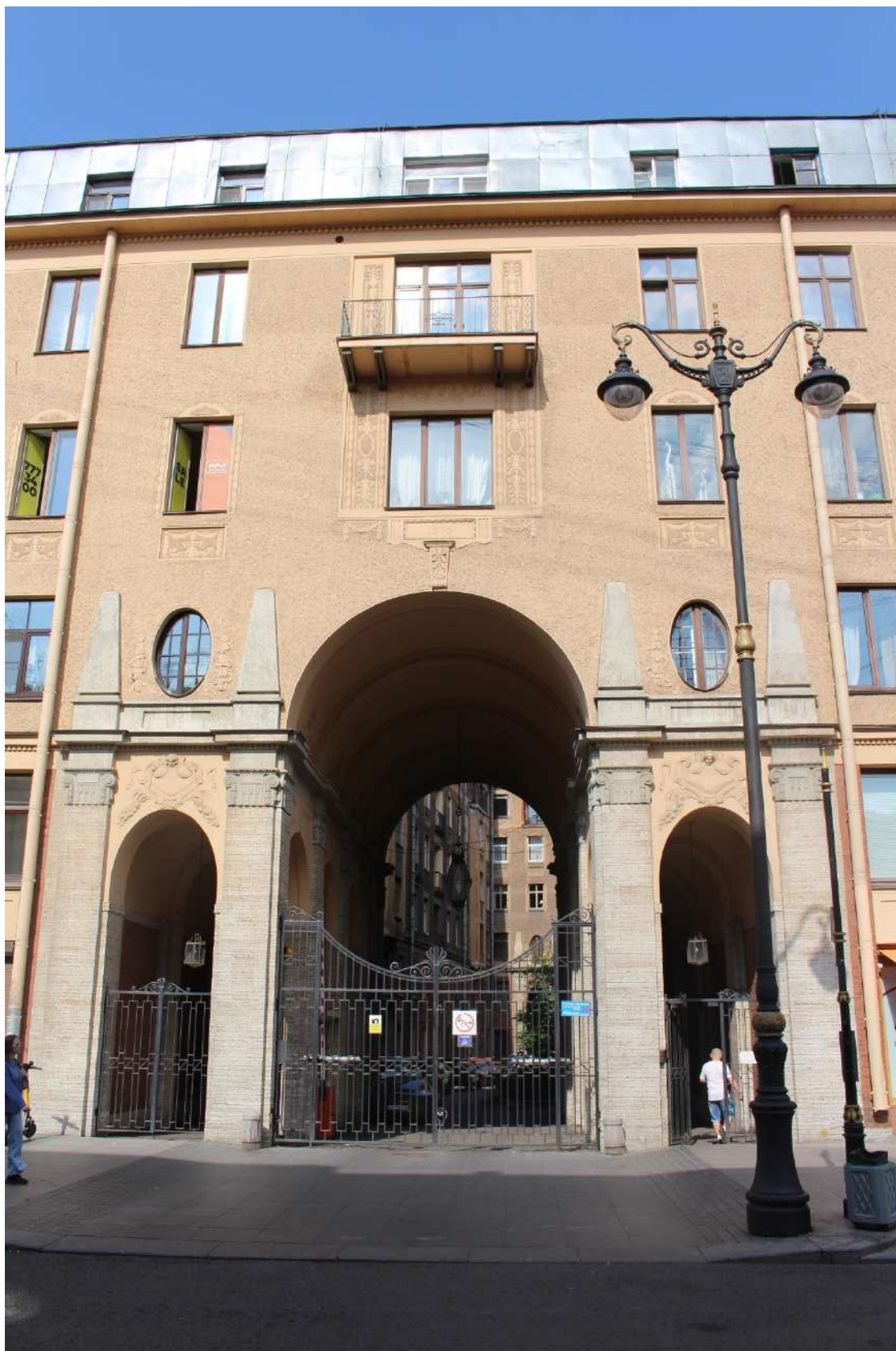
Фото 3. Вид на арку воротного проезда объекта культурного наследия регионального значения «Бывший дом Толстого (фасады)» по ул. Рубинштейна.
