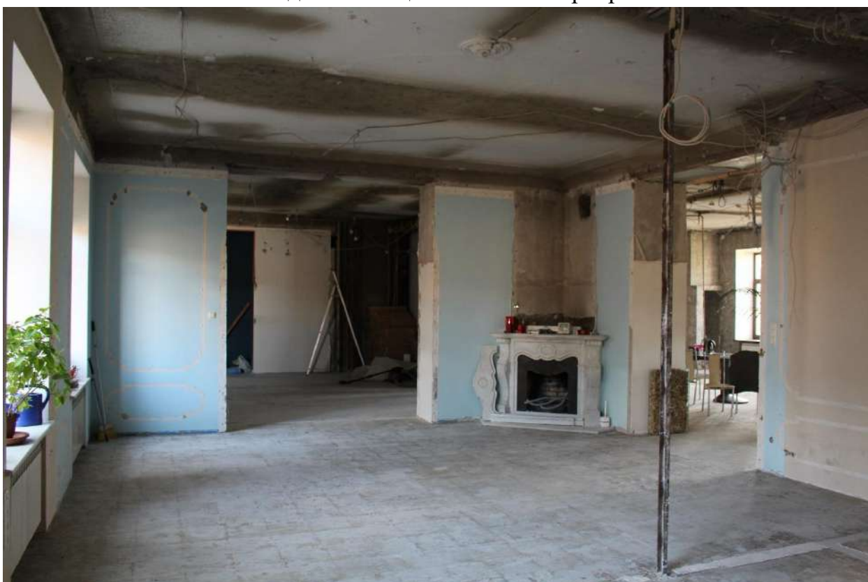
Фото 28. Вид на помещения № 1-4 квартиры № 557.
