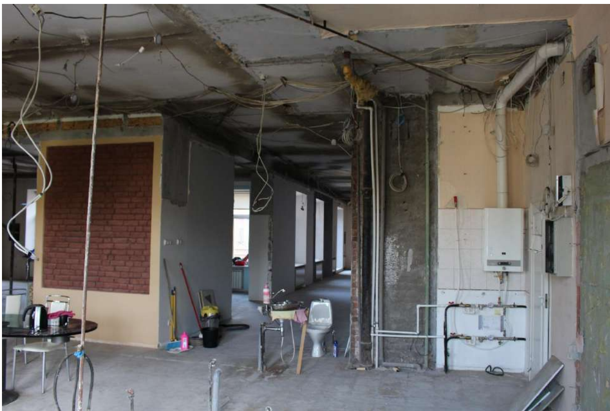
Фото 33. Вид на помещения № 11-18 квартиры № 557.
