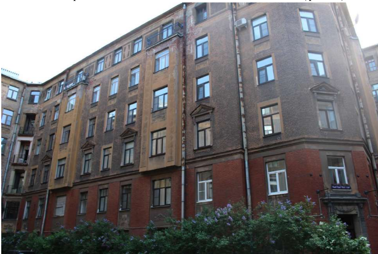
Фото 14. Вид на дворовый фасад в северной части объекта культурного наследия регионального значения «Бывший дом Толстого (фасады)».
