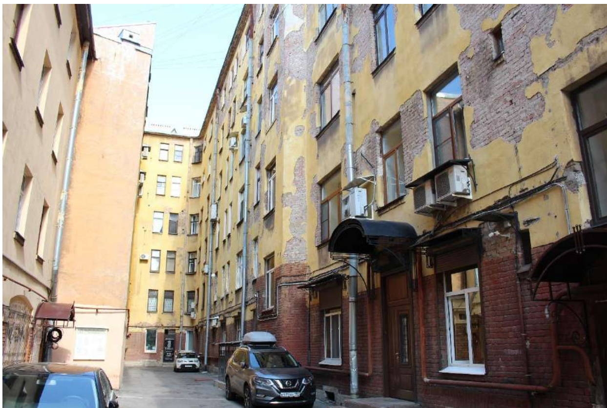
Фото 18. Вид на западную часть юго-западного дворового фасада объекта культурного наследия регионального значения «Бывший дом Толстого (фасады)».
