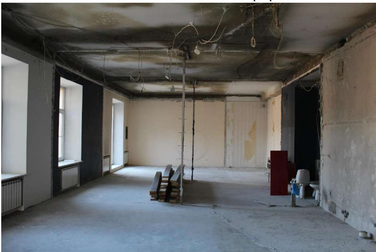
Фото 34. Вид на помещения № 5-10 квартиры № 557.
