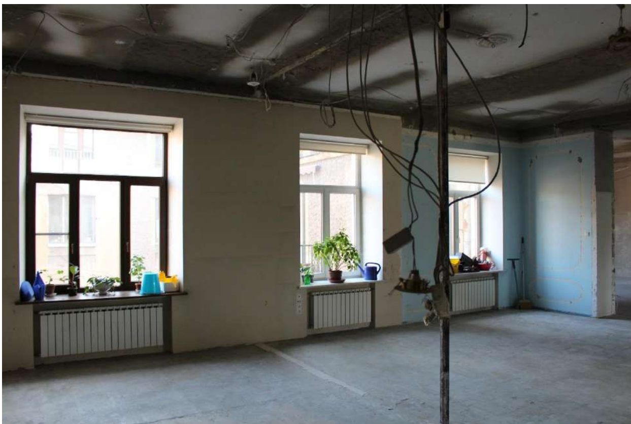
Фото 27. Вид на помещения № 1-4 квартиры № 557.
