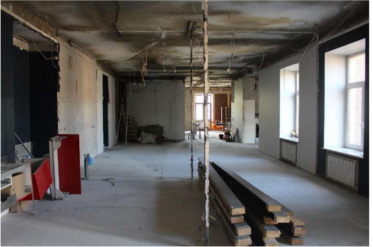
Фото 35. Вид на помещения № 5-10 квартиры № 557.
