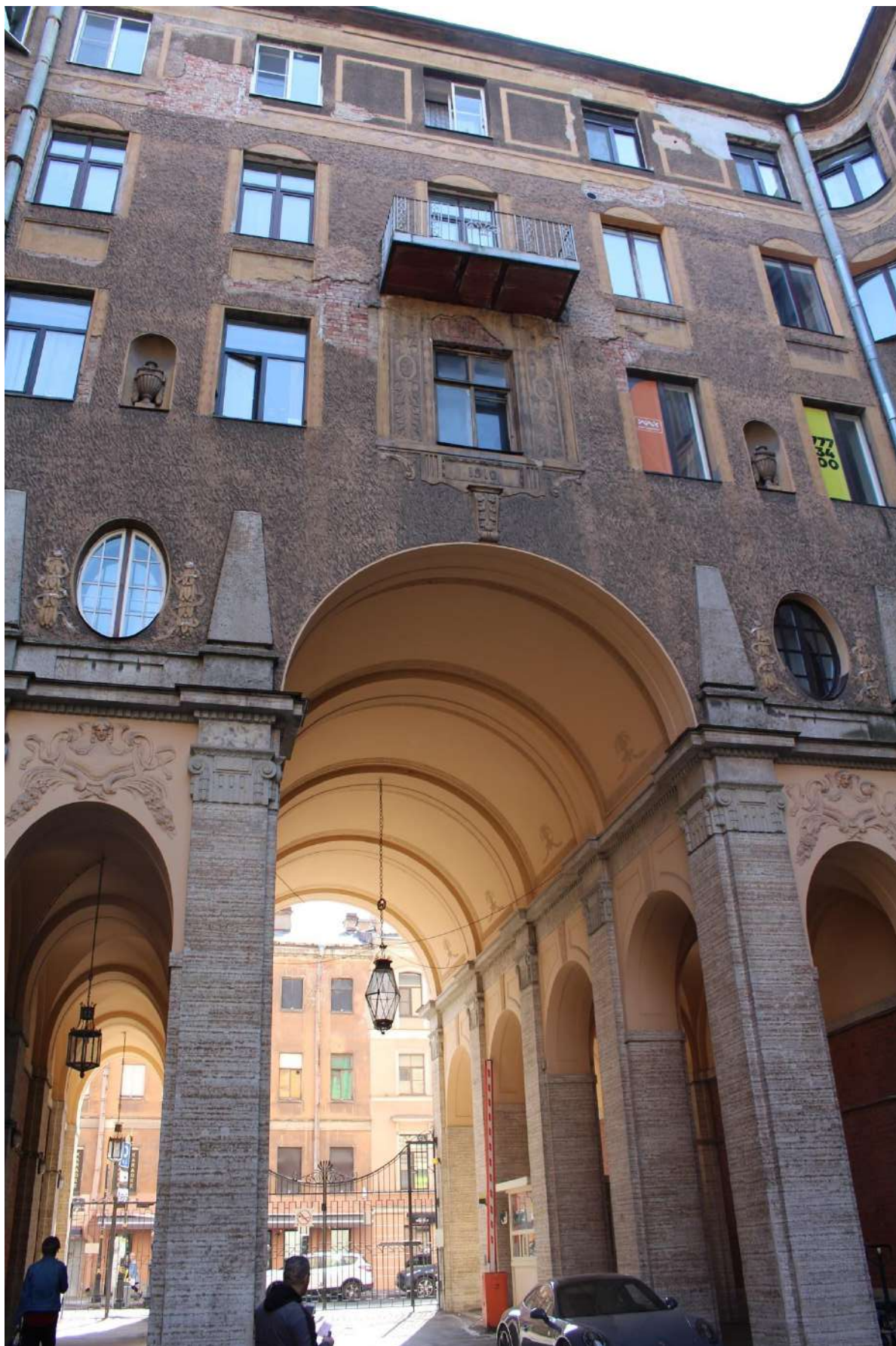
Фото 6. Вид на арку воротного проезда объекта культурного наследия регионального значения «Бывший дом Толстого (фасады)» по ул. Рубинштейна со стороны двора.
