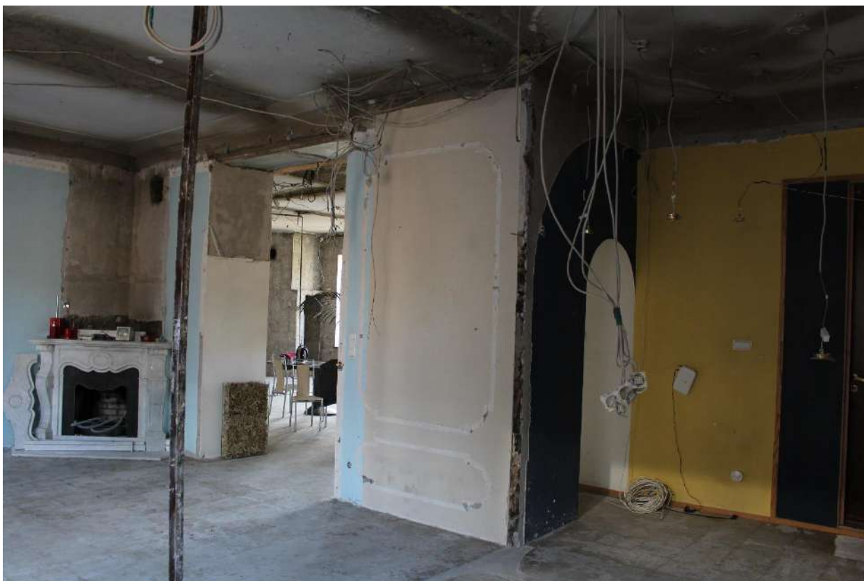
Фото 29. Вид на помещения № 1-4 квартиры № 557.
