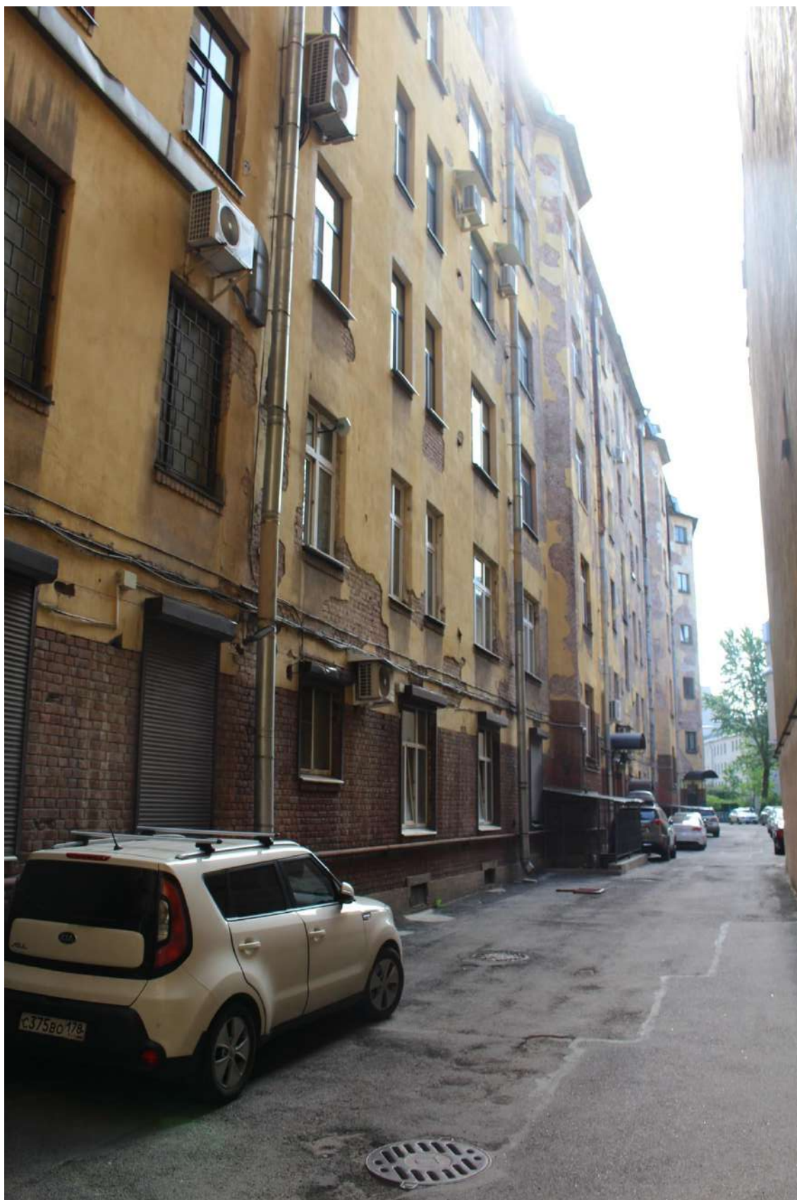
Фото 17. Вид на западную часть юго-западного дворового фасада объекта культурного наследия регионального значения «Бывший дом Толстого (фасады)».
