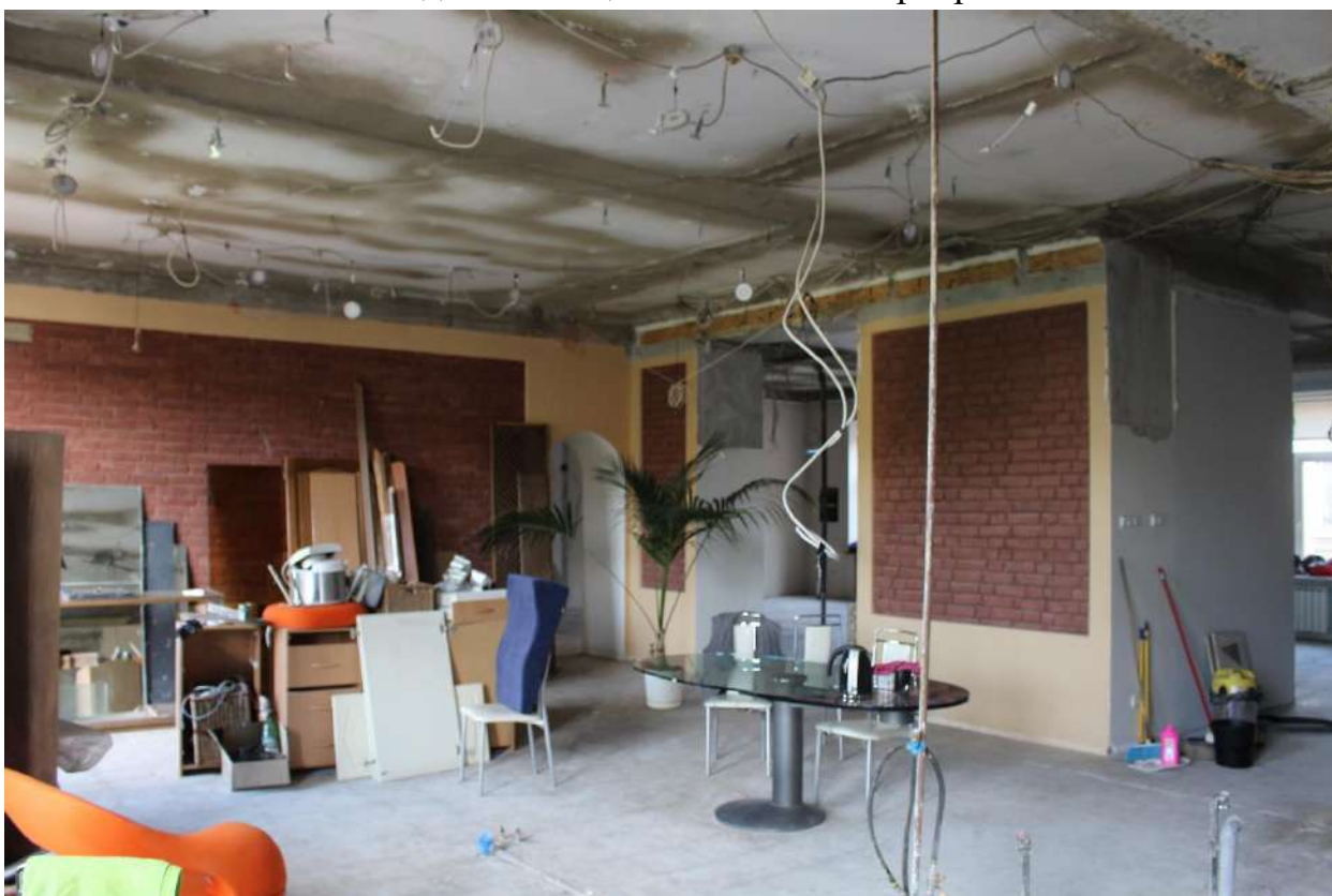
Фото 32. Вид на помещения № 11-18 квартиры № 557.
