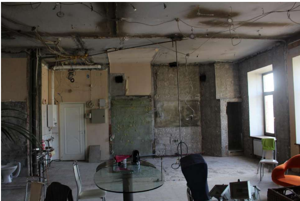
Фото 31. Вид на помещения № 11-18 квартиры № 557.
