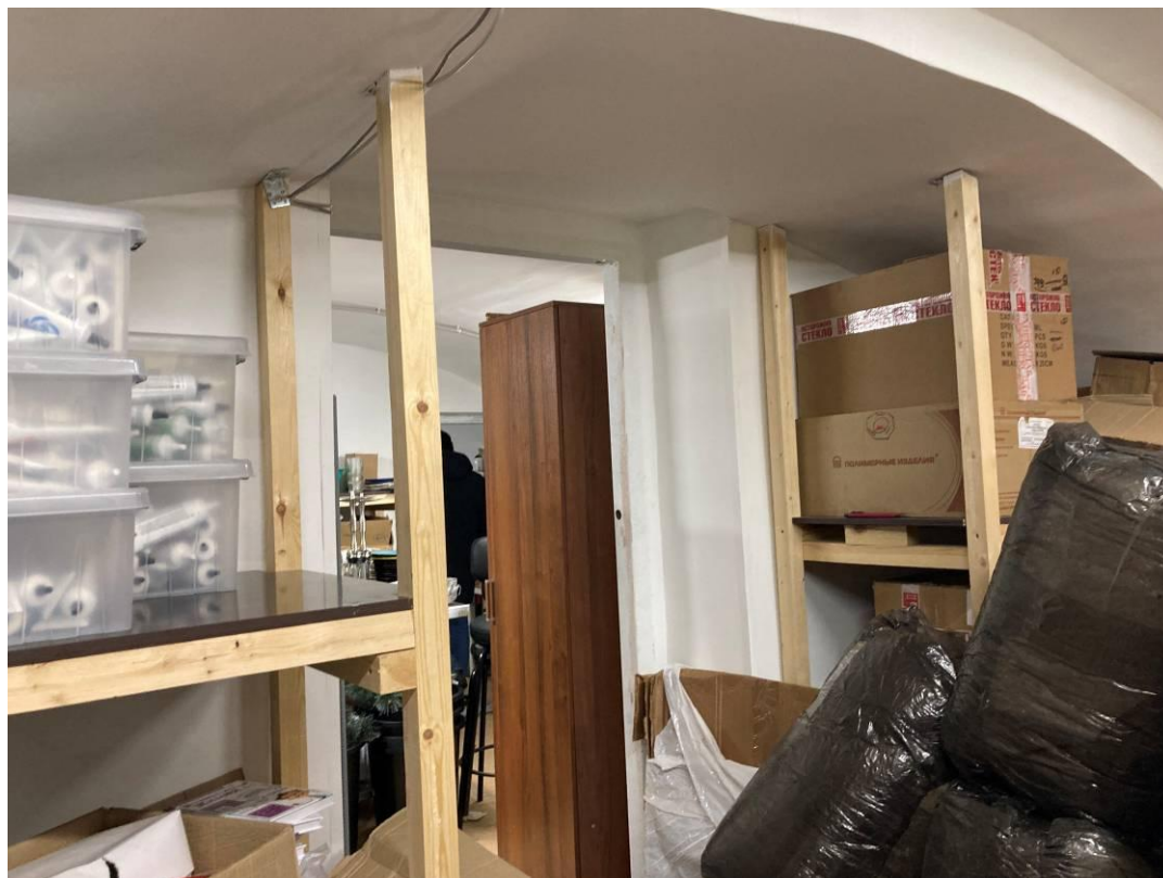
Фото 6. Интерьер помещений выявленного объекта культурного наследия «Железо-Красочные ряды», входящего в состав выявленного объекта культурного наследия «Малый Гостиный двор», подвальный этаж
