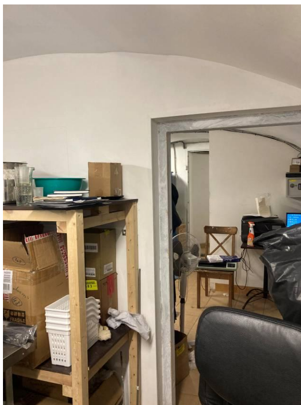
Фото 9. Интерьер помещений выявленного объекта культурного наследия «Железо-Красочные ряды», входящего в состав выявленного объекта культурного наследия «Малый Гостиный двор», подвальный этаж
