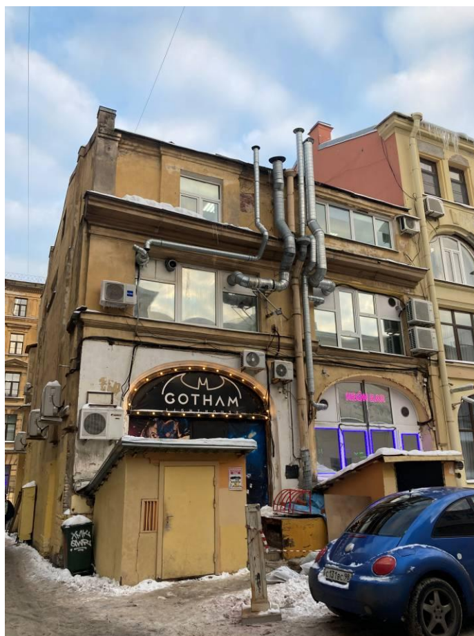
Фото 3. Дворовой фасад выявленного объекта культурного наследия «Железо-Красочные ряды», входящего в состав выявленного объекта культурного наследия «Малый Гостиный двор»
