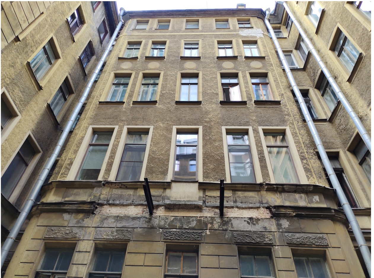
5. Объект культурного наследия регионального значения «Доходный дом А.П. Мещерского» (г. Санкт-Петербург, Кирочная ул., д. 22, лит. А). Фрагмент дворового фасада.
