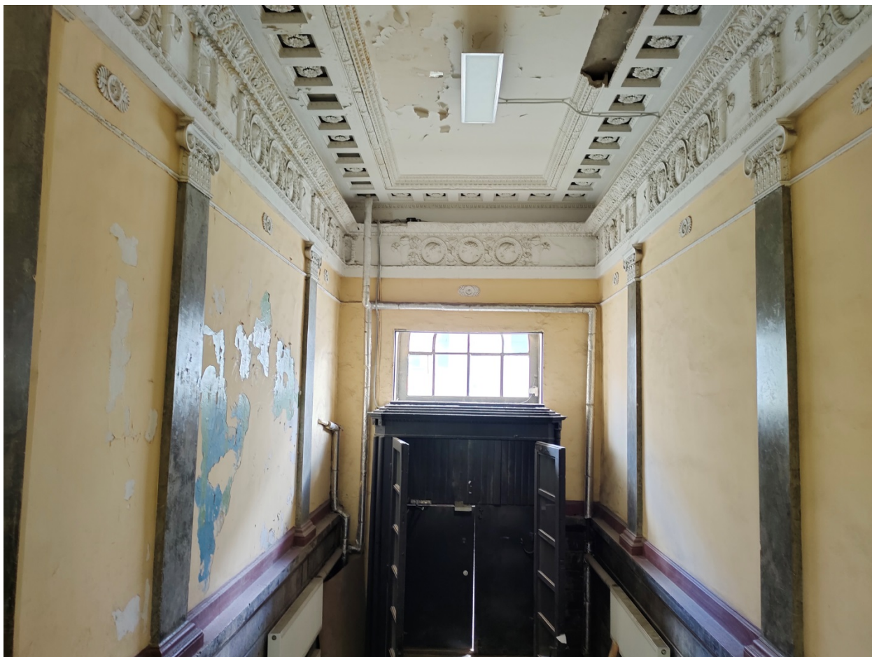
8. Объект культурного наследия регионального значения «Доходный дом А.П. Мещерского» (г. Санкт-Петербург, Кирочная ул., д. 22, лит. А). Парадная лестница.
