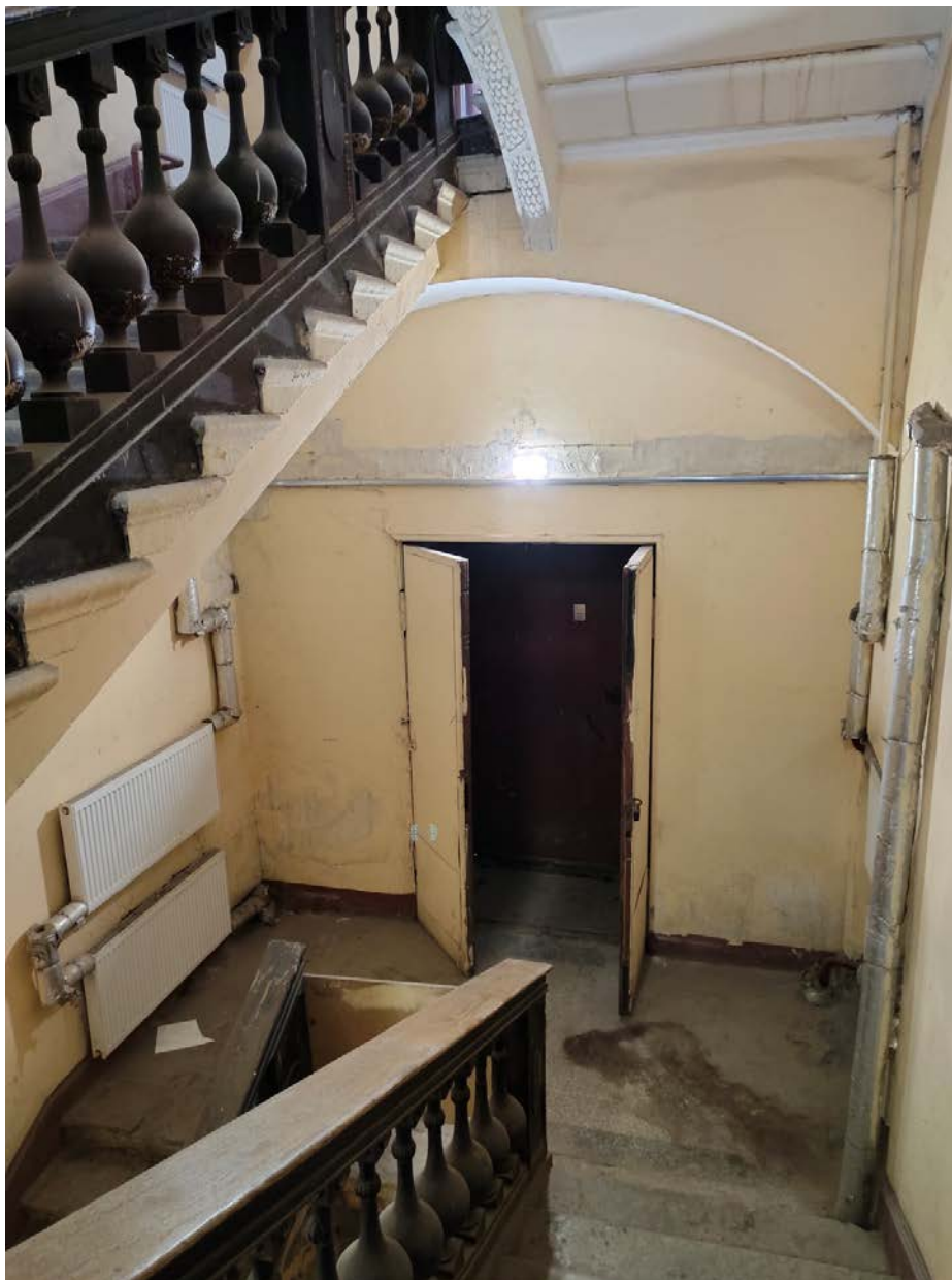
6. Объект культурного наследия регионального значения «Доходный дом А.П. Мещерского» (г. Санкт-Петербург, Кирочная ул., д. 22, лит. А). Парадная лестница.
