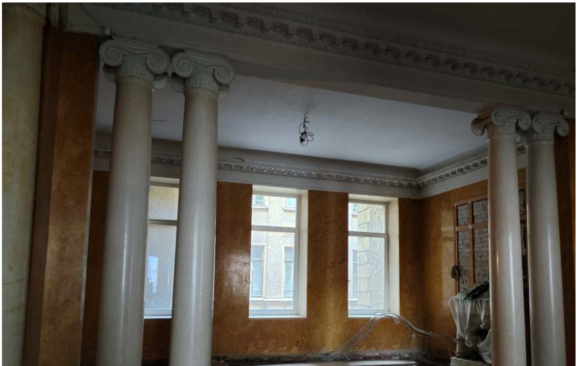
37. Объект культурного наследия регионального значения «Доходный дом А.П. Мещерского» (г. Санкт-Петербург, Киришная ул., д. 22, лит. А). Помещение кв. №2.
