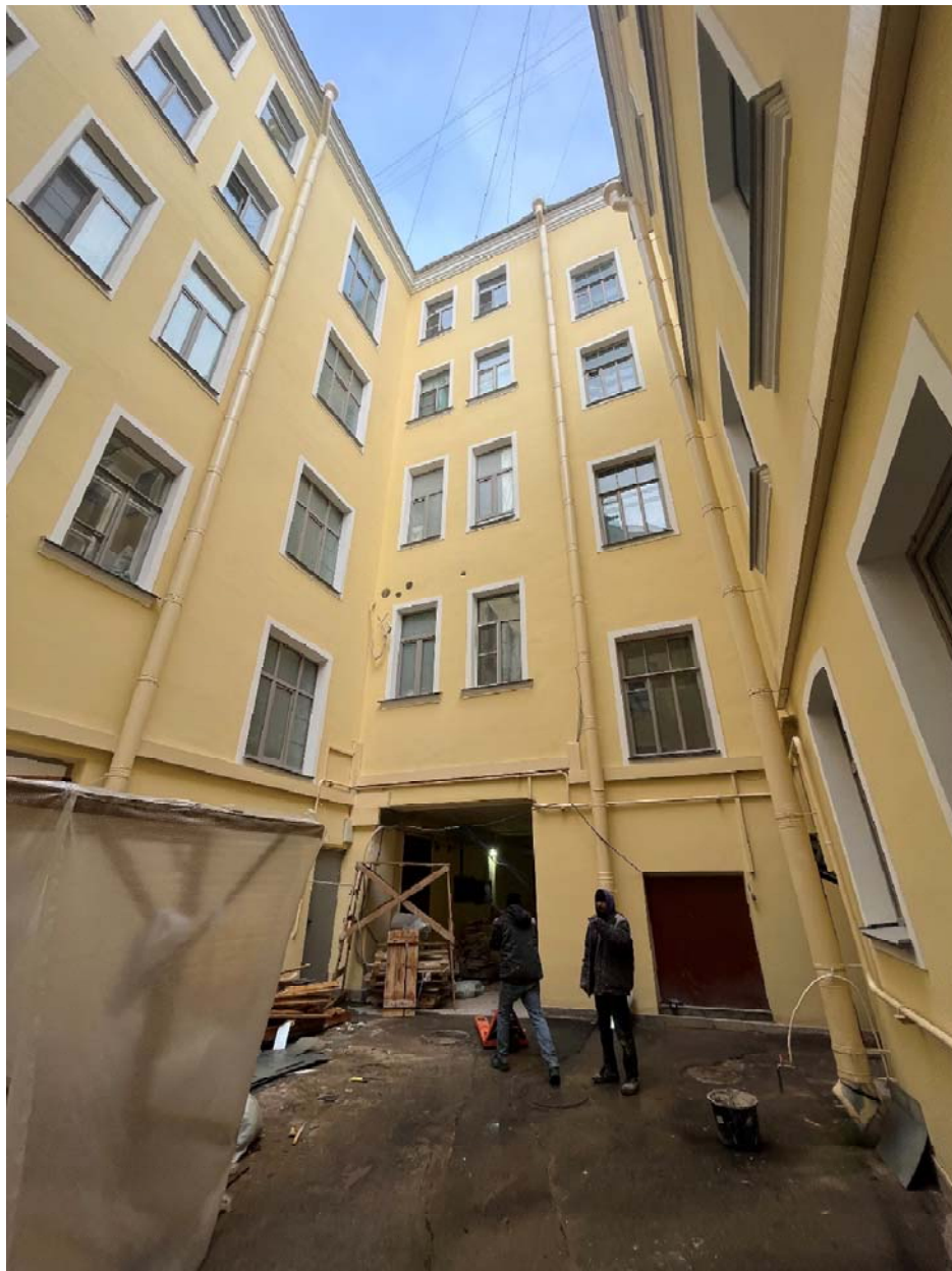
Фото №3. Южный дворовый фасад.
