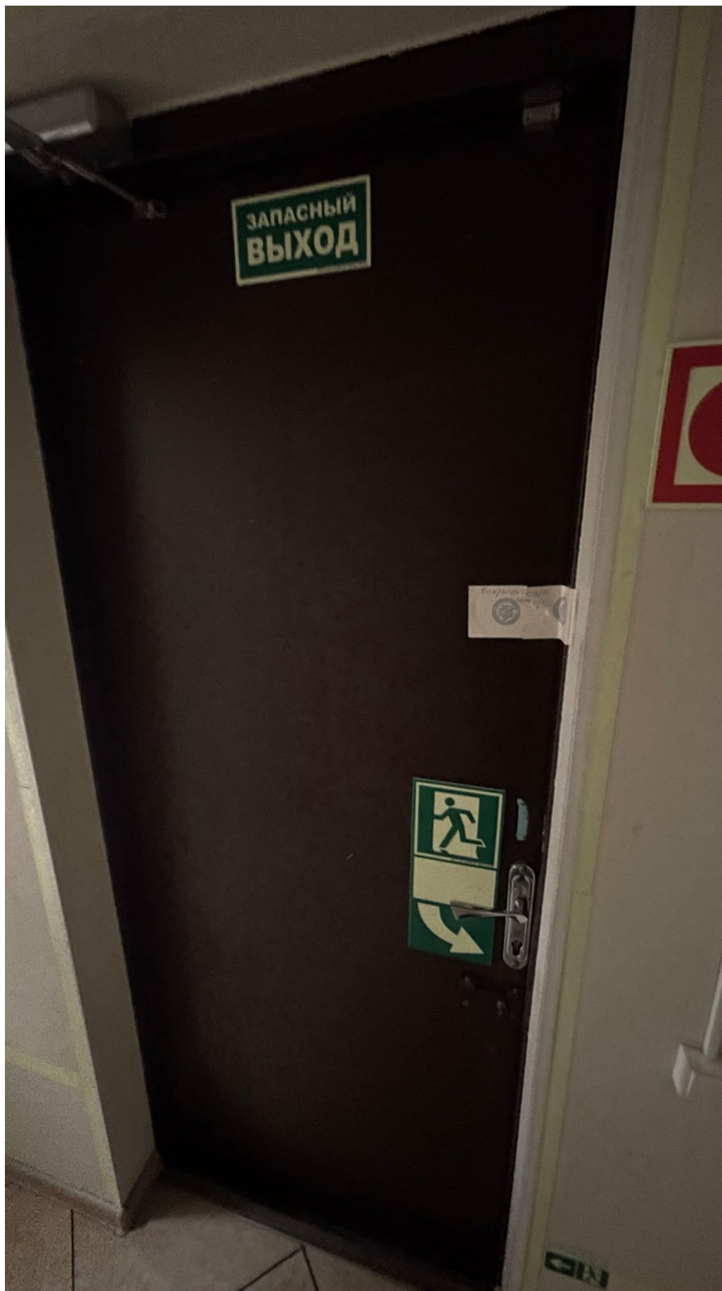
41. Вид на входную дверь в помещении;
