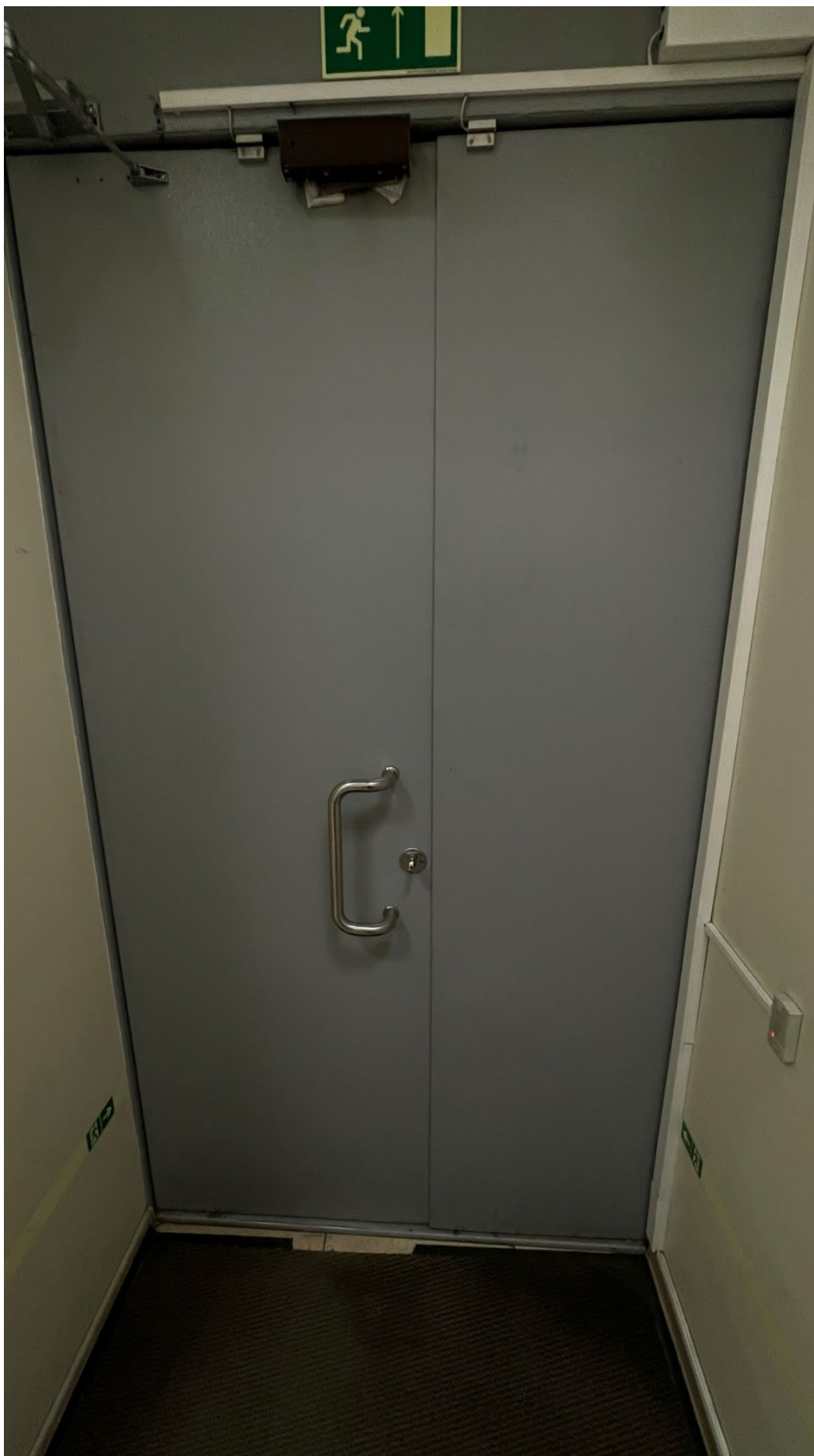
1. Вид на входную дверь в помещение;
