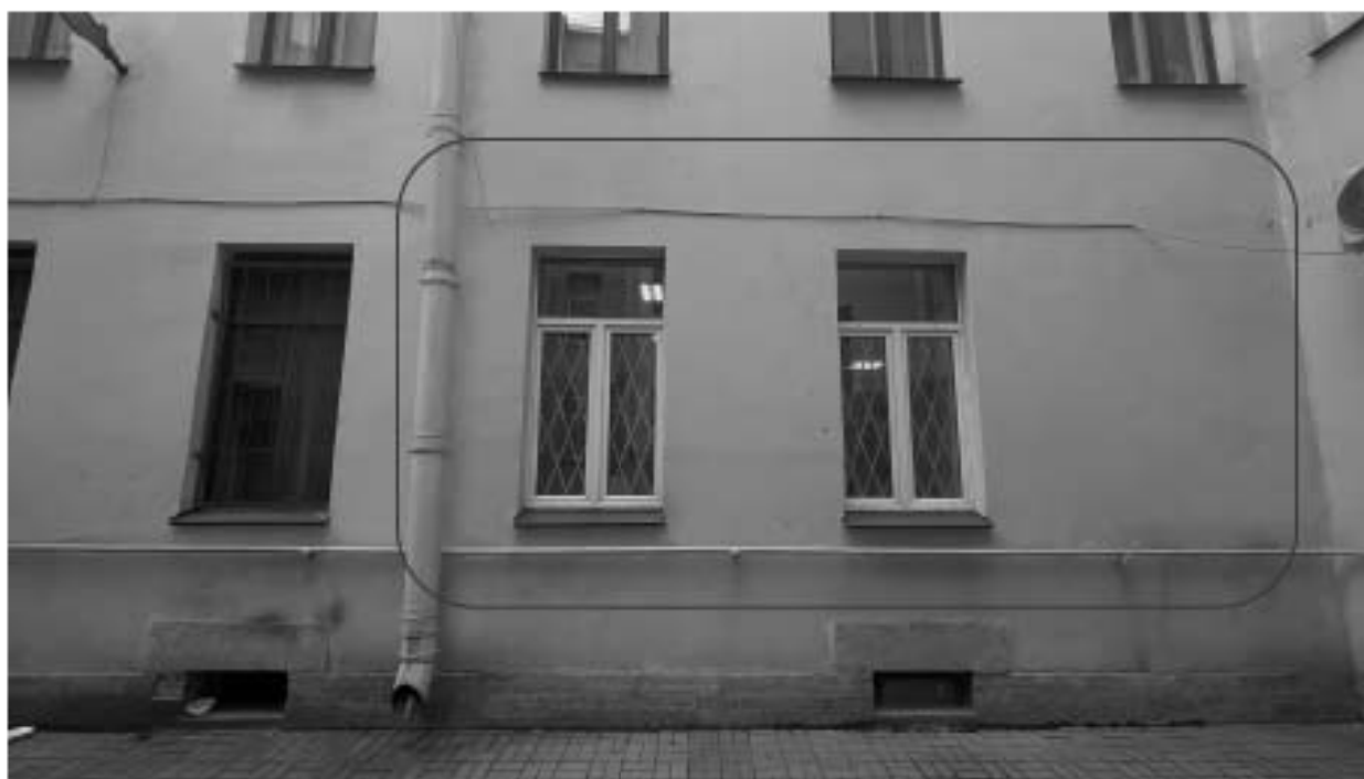
6. Вид на дворовой фасад выявленного объекта культурного наследия «Дом Н.В. Печаткина», расположенного по адресу: г. Санкт-Петербург, Лермонтовский проспект, дом 7/12, литера А (Лермонтовский пр., 7/12, лит.А) и окна помещения;
