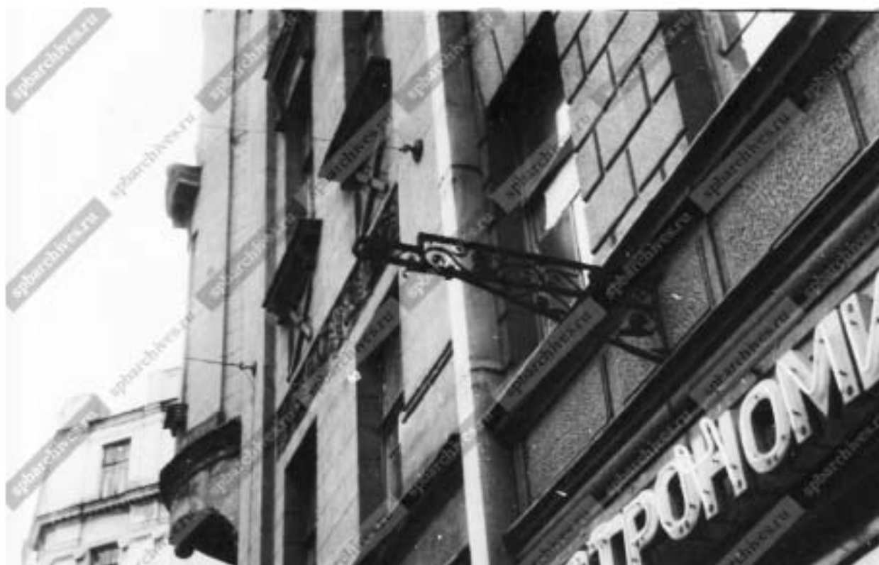
51. Вид декоративного кронштейна для фонаря на фасаде дома № 12/7 по улице Союза Печатников ( бывший доходный дом Н.В.Печаткина, архитектор П.М.Мульханов, 1912-1915 гг.). ЦГАКФФД СПб. Фотодокумент Ар 225284. 06 сентября 1986 г.
