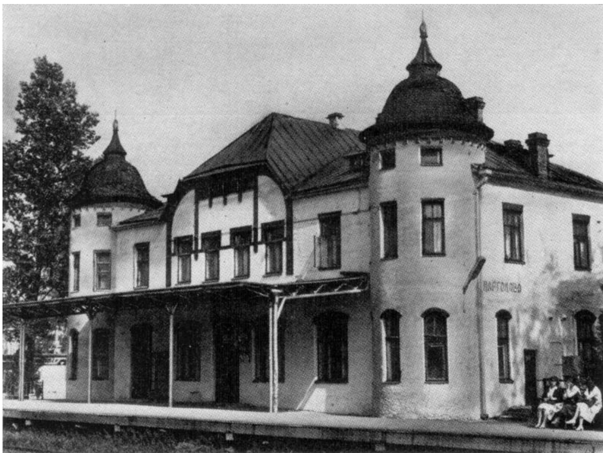
33. Финляндская железная дорога. Вокзал станции Парголово. Вид со стороны путей. Арх. Бруно Гренхольм. 1902. Фото. Середина XX в.
