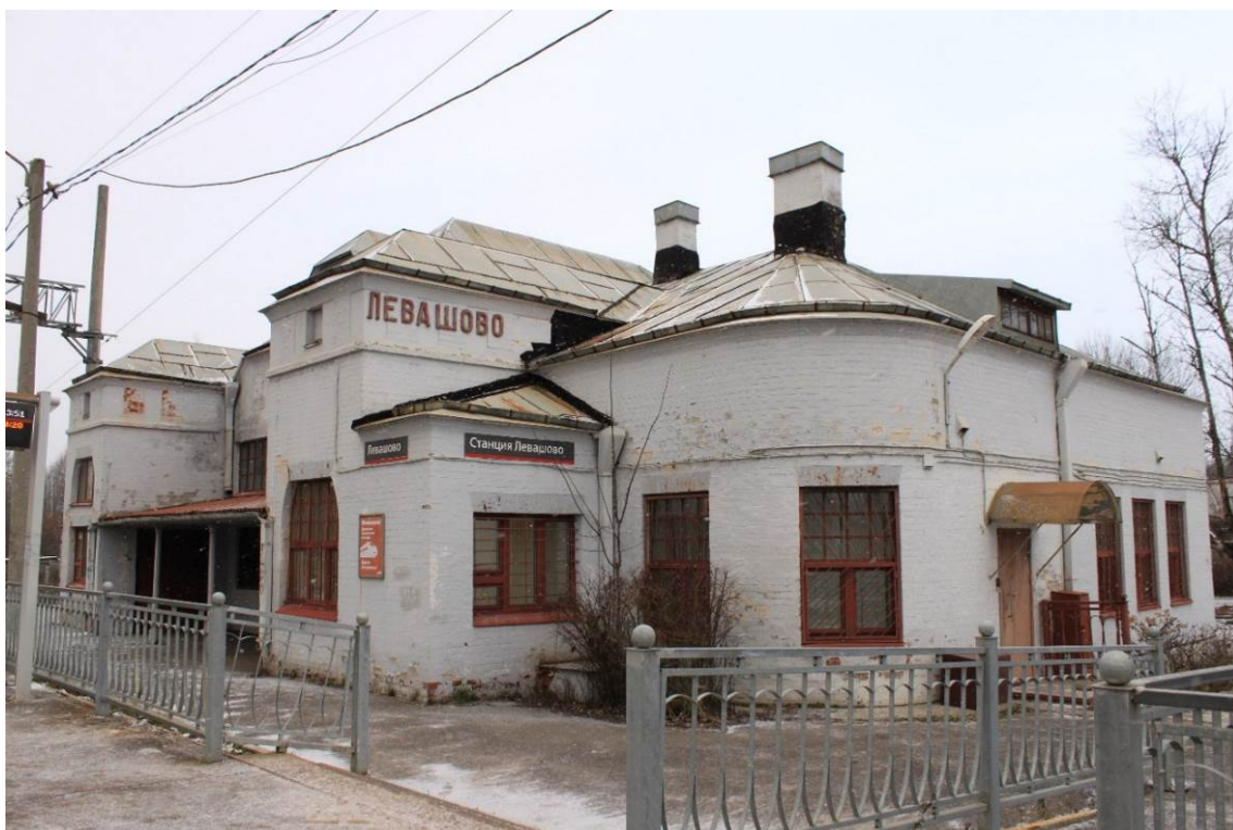
Фото 7. Объект культурного наследия регионального значения «Железнодорожная станция Левашово: вокзал» по адресу: г. Санкт-Петербург, п. Левашово, Железнодорожная ул., д. 7, лит. А (Левашово, железнодорожная станция. Вокзальное шоссе, 43). Общий вид станции Левашово. Дата: 28.11.2022 г.
