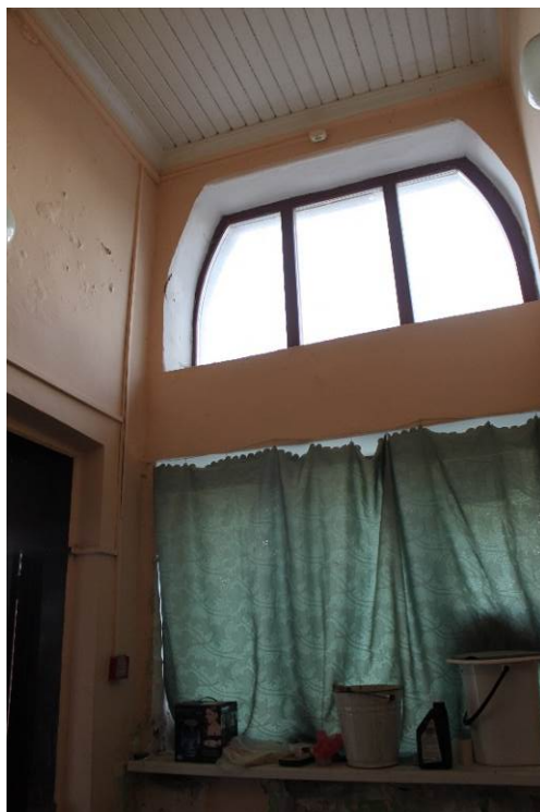
Фото 35. Объект культурного наследия регионального значения «Железнодорожная станция Левашово: вокзал» по адресу: г. Санкт-Петербург, п. Левашово, Железнодорожная ул., д. 7, лит. А (Левашово, железнодорожная станция. Вокзальное шоссе, 43). Общий вид помещения №1. Дата: 28.11.2022 г.
