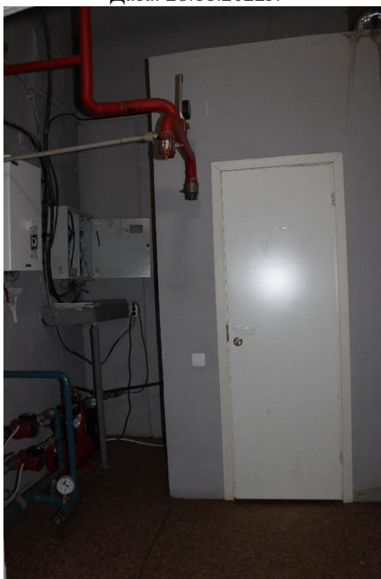
Фото 30. Объект культурного наследия регионального значения «Железнодорожная станция Левашово: вокзал» по адресу: г. Санкт-Петербург, п. Левашово, Железнодорожная ул., д. 7, лит. А (Левашово, железнодорожная станция. Вокзальное шоссе, 43). Общий вид помещения №6. Дата: 28.11.2022г.
