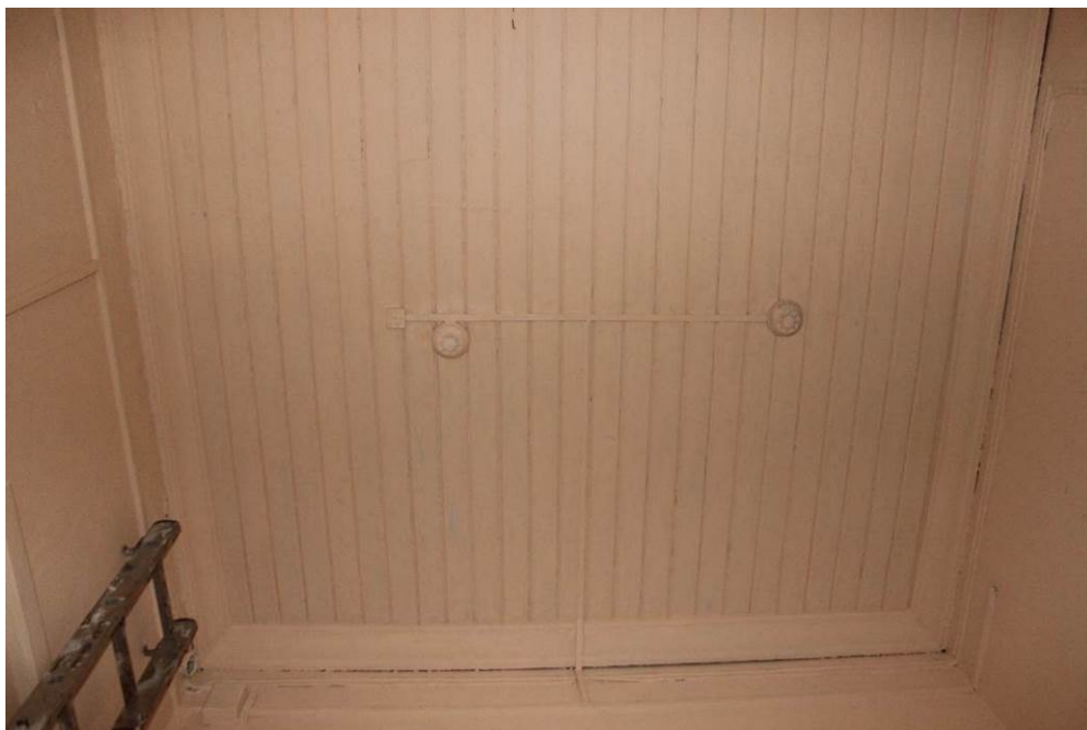
Фото 29. Объект культурного наследия регионального значения «Железнодорожная станция Левашово: вокзал» по адресу: г. Санкт-Петербург, п. Левашово, Железнодорожная ул., д. 7, лит. А (Левашово, железнодорожная станция. Вокзальное шоссе, 43). Вид на обшивку потолка в помещении №4, являющуюся предметом охраны. Дата: 28.11.2022г.
