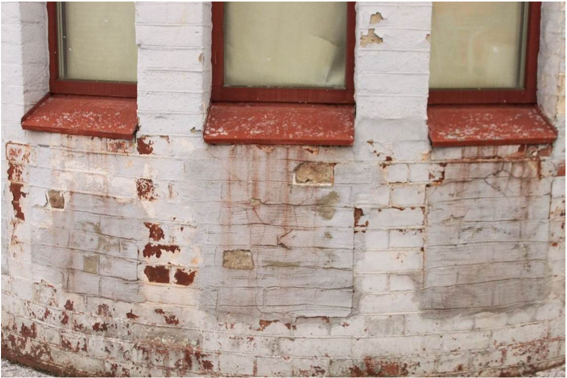
Фото 23. Объект культурного наследия регионального значения «Железнодорожная станция Левашово: вокзал» по адресу: г. Санкт-Петербург, п. Левашово, Железнодорожная ул., д. 7, лит. А (Левашово, железнодорожная станция. Вокзальное шоссе, 43). Вид на замененную кирпичную кладку (западный фасад). Дата: 28.11.2022 г.
