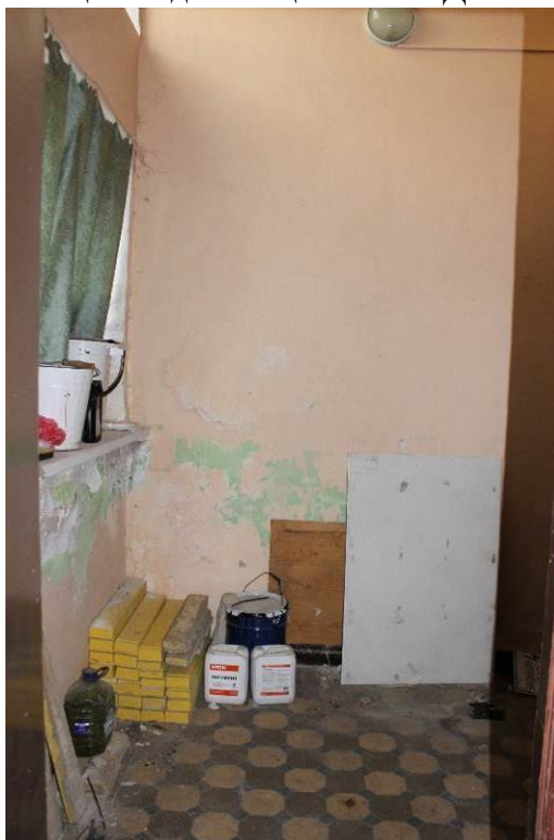
Фото 36. Объект культурного наследия регионального значения «Железнодорожная станция Левашово: вокзал» по адресу: г. Санкт-Петербург, п. Левашово, Железнодорожная ул., д. 7, лит. А (Левашово, железнодорожная станция. Вокзальное шоссе, 43). Общий вид помещения №1. Дата: 28.11.2022 г.
