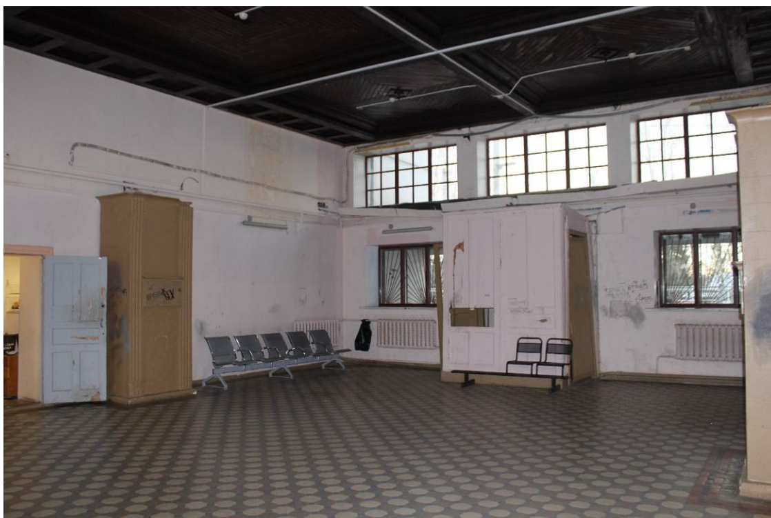
Фото 19. Объект культурного наследия регионального значения «Железнодорожная станция Левашово» по адресу: г. Санкт-Петербург, п. Левашово, Железнодорожная ул., д. 7, литера А Общий вид помещения №2 Дата: 28.11.2022г.
