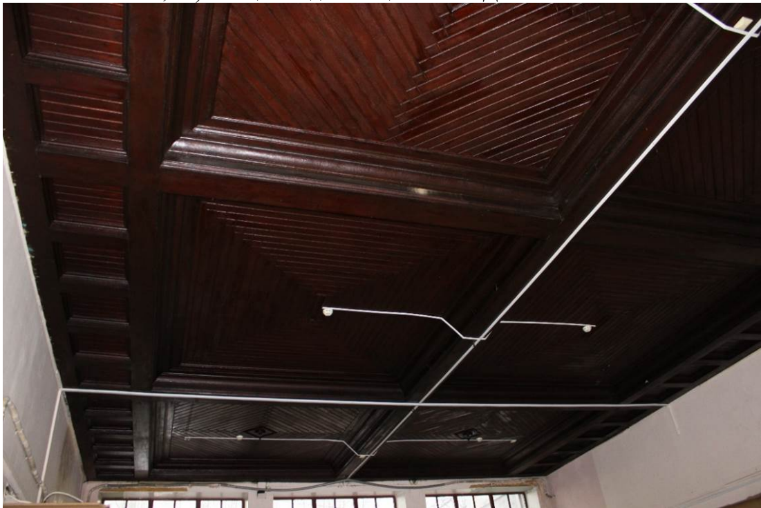
Фото 22. Объект культурного наследия регионального значения «Железнодорожная станция Левашово: вокзал» по адресу: г. Санкт-Петербург, п. Левашово, Железнодорожная ул., д. 7, лит. А (Левашово, железнодорожная станция. Вокзальное шоссе, 43). Вид на плафоны подшивные кессонированные в помещениях №2, являющиеся предметом охраны. Дата: 28.11.2022г.
