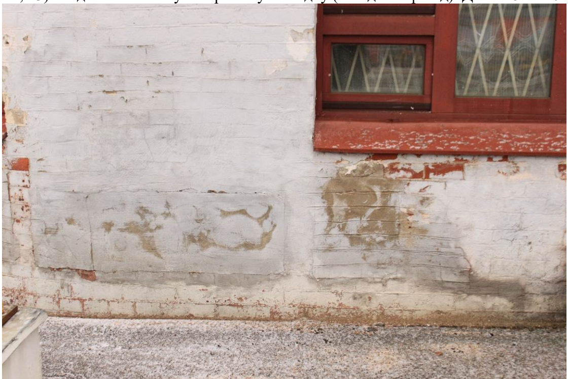
Фото 24. Объект культурного наследия регионального значения «Железнодорожная станция Левашово: вокзал» по адресу: г. Санкт-Петербург, п. Левашово, Железнодорожная ул., д. 7, лит. А (Левашово, железнодорожная станция. Вокзальное шоссе, 43). Вид на замененную кирпичную кладку (южный фасад). Дата: 28.11.2022 г.
