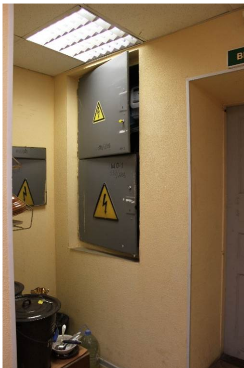
Фото 15. Объект культурного наследия регионального значения «Железнодорожная станция Левашово: вокзал» по адресу: г. Санкт-Петербург, п. Левашово, Железнодорожная ул., д. 7, лит. А (Левашово, железнодорожная станция. Вокзальное шоссе, 43). Общий вид помещения №8. Дата: 28.11.2022 г.
