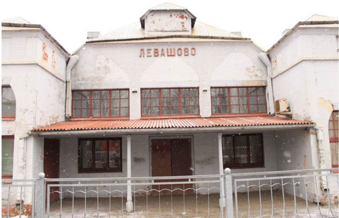
Фото 4. Объект культурного наследия регионального значения «Железнодорожная станция Левашово: вокзал» по адресу: г. Санкт-Петербург, п. Левашово, Железнодорожная ул., д. 7, лит. А (Левашово, железнодорожная станция. Вокзальное шоссе, 43). Общий вид станции Левашово (южный фасад). Дата: 28.11.2022 г.
