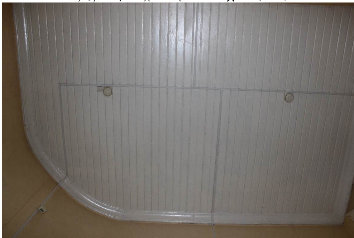
Фото 6. Объект культурного наследия регионального значения «Железнодорожная станция Левашово: вокзал» по адресу: г. Санкт-Петербург, п. Левашово, Железнодорожная ул., д. 7, лит. А (Левашово, железнодорожная станция. Вокзальное шоссе, 43). Вид на обшивку потолка в помещении №14, являющуюся предметом охраны. Дата: 28.11.2022г.
