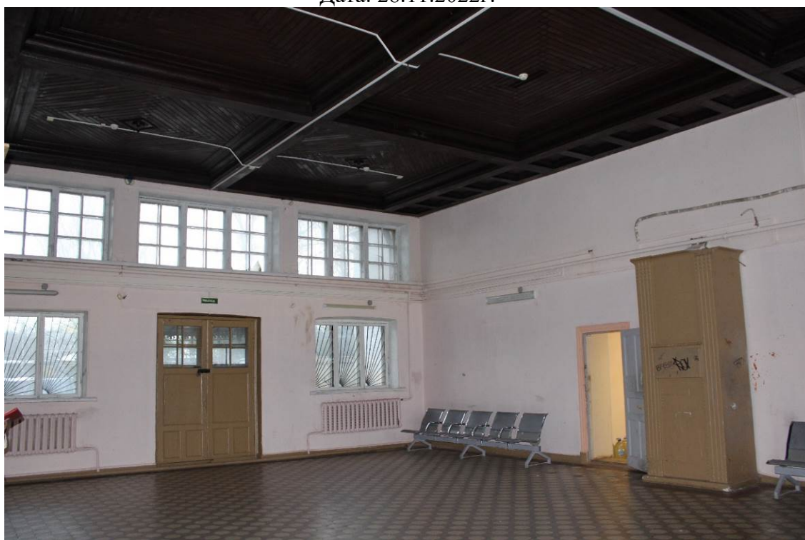
Фото 20. Объект культурного наследия регионального значения «Железнодорожная станция Левашово: вокзал» по адресу: г. Санкт-Петербург, п. Левашово, Железнодорожная ул., д. 7, лит. А (Левашово, железнодорожная станция. Вокзальное шоссе, 43). Общий вид помещения №2. Дата: 28.11.2022 г.
