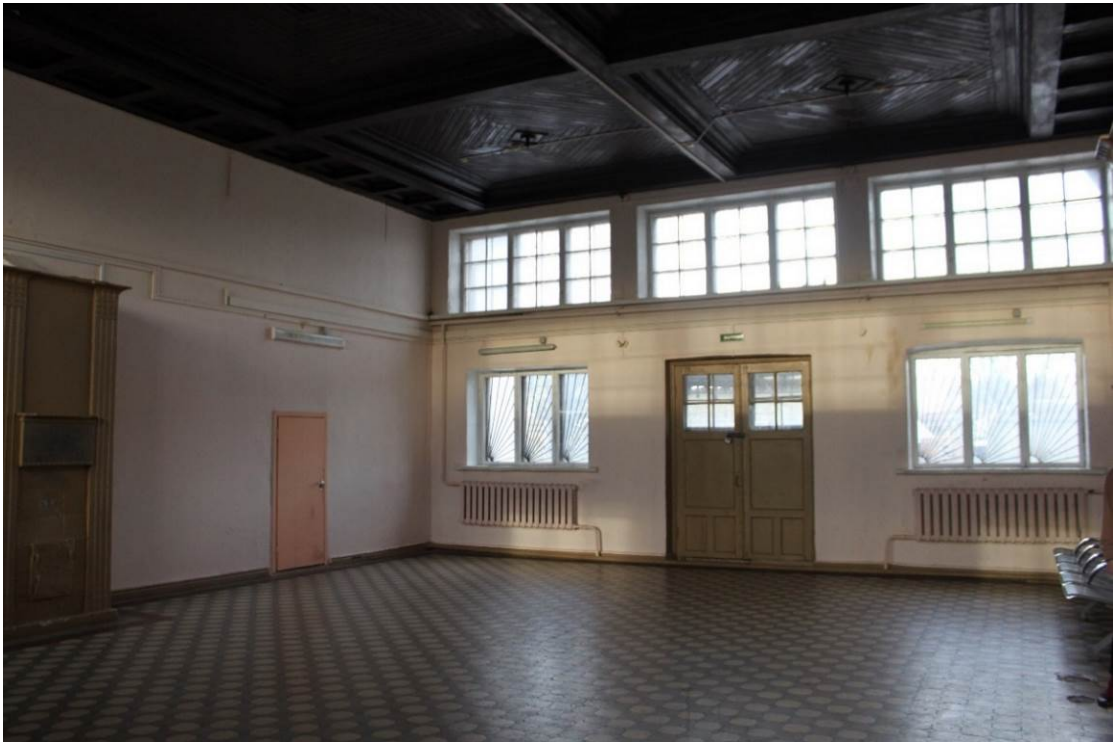
Фото 21. Объект культурного наследия регионального значения «Железнодорожная станция Левашово: вокзал» по адресу: г. Санкт-Петербург, п. Левашово, Железнодорожная ул., д. 7, лит. А (Левашово, железнодорожная станция. Вокзальное шоссе, 43). Общий вид помещения №2. Дата: 28.11.2022 г.
