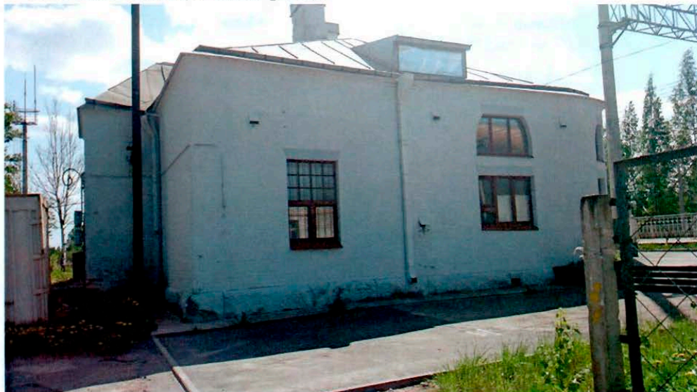
3. Здание вокзала (западный фасад).
