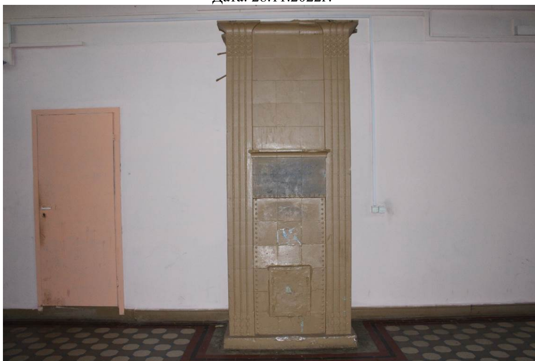
Фото 24. Объект культурного наследия регионального значения «Железнодорожная станция Левашово: вокзал» по адресу: г. Санкт-Петербург, п. Левашово, Железнодорожная ул., д. 7, лит. А (Левашово, железнодорожная станция. Вокзальное шоссе, 43). Вид на изразцовую печь в помещении №2, являющуюся предметом охраны. Дата: 28.11.2022 г.
