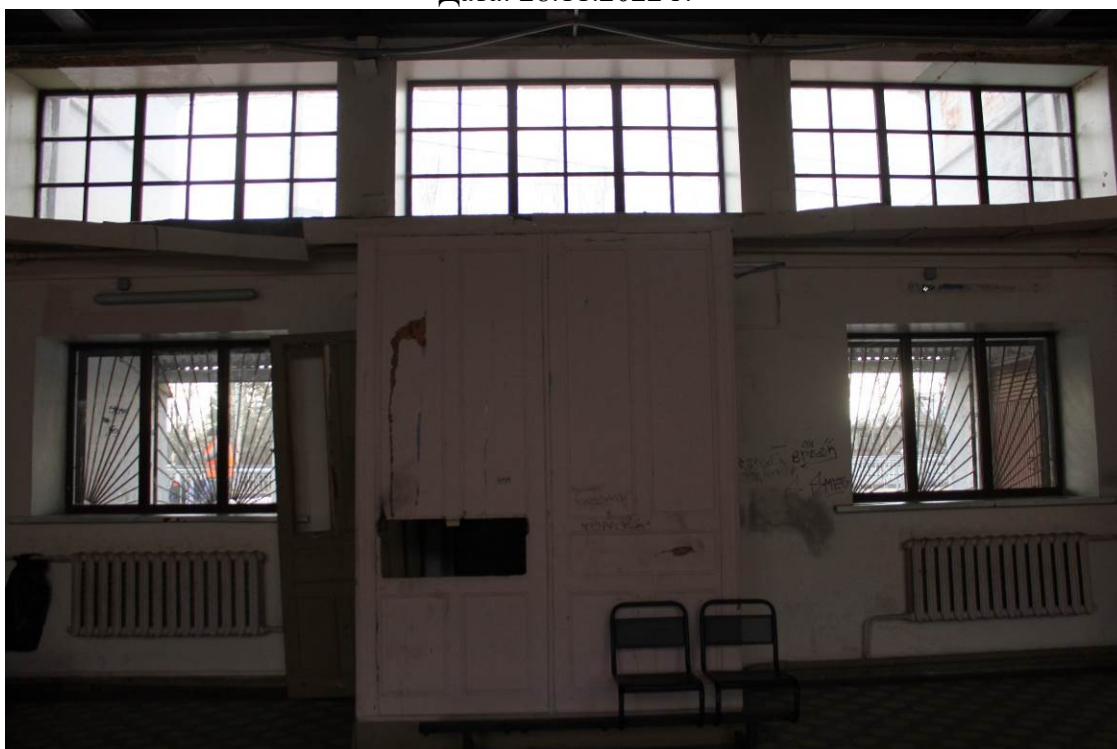
Фото 26. Объект культурного наследия регионального значения «Железнодорожная станция Левашово: вокзал» по адресу: г. Санкт-Петербург, п. Левашово, Железнодорожная ул., д. 7, лит. А (Левашово, железнодорожная станция. Вокзальное шоссе, 43). Вид на деревянный тамбур в помещении №2, являющийся предметом охраны. Дата: 28.11.2022 г.
