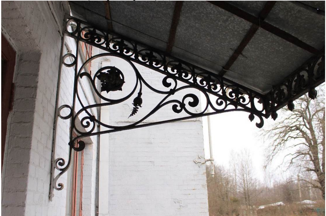
Фото 16. Объект культурного наследия регионального значения «Железнодорожная станция Левашово: вокзал» по адресу: г. Санкт-Петербург, п. Левашово, Железнодорожная ул., д. 7, лит. А (Левашово, железнодорожная станция. Вокзальное шоссе, 43). Вид на металлический фигурный кронштейн, являющийся предметом охраны (северный фасад). Дата: 28.11.2022 г.
