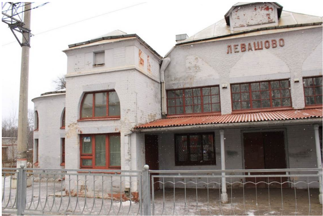
Фото 3. Объект культурного наследия регионального значения «Железнодорожная станция Левашово: вокзал» по адресу: г. Санкт-Петербург, п. Левашово, Железнодорожная ул., д. 7, лит. А (Левашово, железнодорожная станция. Вокзальное шоссе, 43). Общий вид станции Левашово (южный фасад). Дата: 28.11.2022 г.
