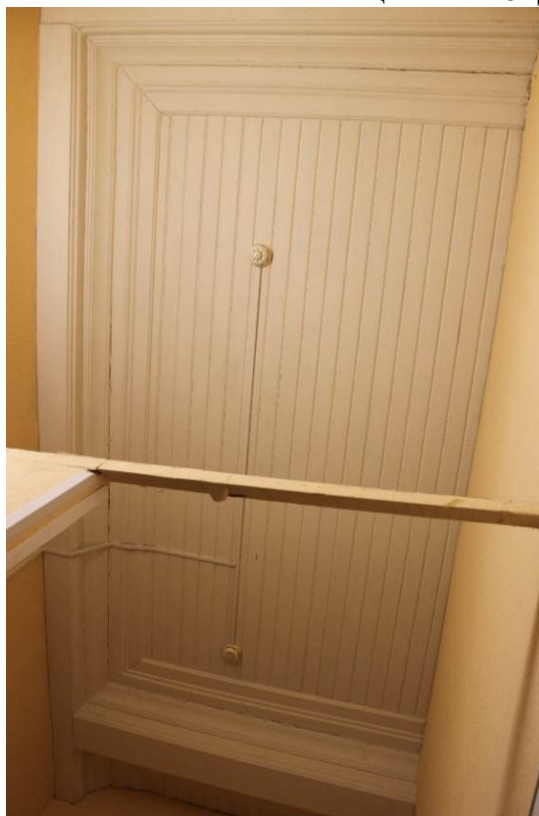
Фото 8. Объект культурного наследия регионального значения «Железнодорожная станция Левашово: вокзал» по адресу: г. Санкт-Петербург, п. Левашово, Железнодорожная ул., д. 7, лит. А (Левашово, железнодорожная станция. Вокзальное шоссе, 43). Вид на плафоны подшивные кессонированные в помещениях №11-12, являющимися предметом охраны Дата: 28.11.2022 г.
