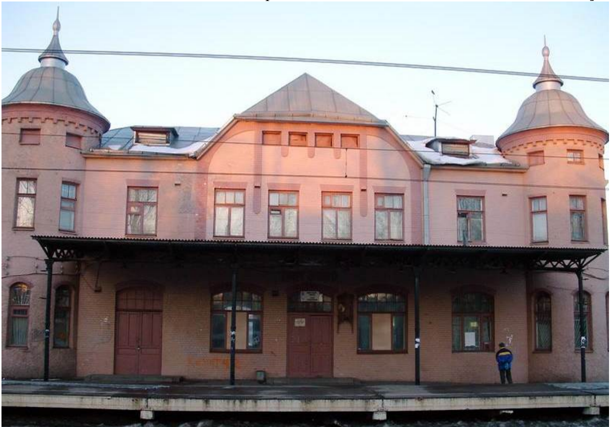
36. Финляндская железная дорога. Вокзал станции Парголово. Вид со стороны путей. Фото 2000-х гг.
