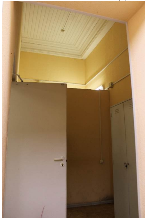
Фото 10. Объект культурного наследия регионального значения «Железнодорожная станция Левашово: вокзал» по адресу: г. Санкт-Петербург, п. Левашово, Железнодорожная ул., д. 7, лит. А (Левашово, железнодорожная станция. Вокзальное шоссе, 43). Общий вид помещения №11. Дата: 28.11.2022 г.
