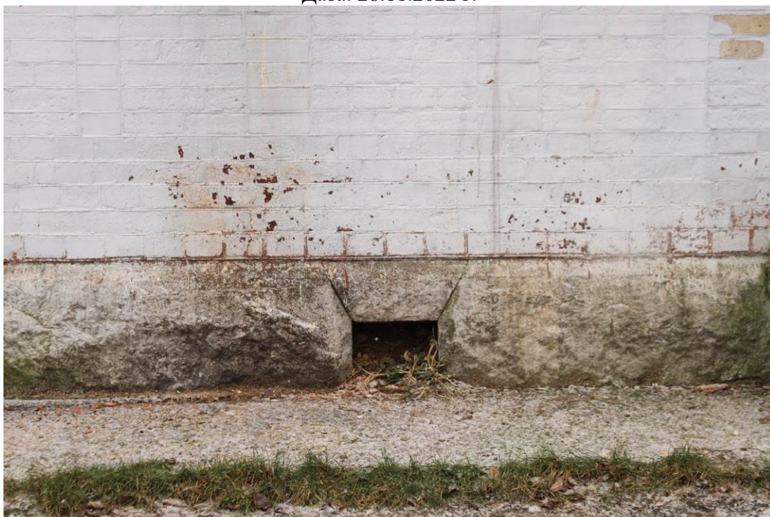
Фото 20. Объект культурного наследия регионального значения «Железнодорожная станция Левашово: вокзал» по адресу: г. Санкт-Петербург, п. Левашово, Железнодорожная ул., д. 7, лит. А (Левашово, железнодорожная станция. Вокзальное шоссе, 43). Вид на вентиляционное окно в уровне цоколя (западный фасад). Дата: 28.11.2022 г.
