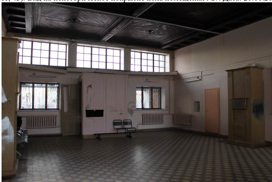
Фото 18. Объект культурного наследия регионального значения «Железнодорожная станция Левашово: вокзал» по адресу: г. Санкт-Петербург, п. Левашово, Железнодорожная ул., д. 7, лит. А (Левашово, железнодорожная станция. Вокзальное шоссе, 43). Общий вид помещения №2. Дата: 28.11.2022г.
