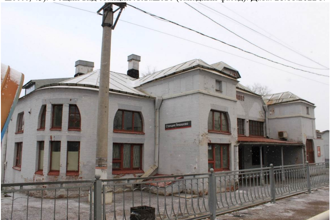
Фото 2. Объект культурного наследия регионального значения «Железнодорожная станция Левашово: вокзал» по адресу: г. Санкт-Петербург, п. Левашово, Железнодорожная ул., д. 7, лит. А (Левашово, железнодорожная станция. Вокзальное шоссе, 43). Общий вид станции Левашово Дата: 28.11.2022 г.
