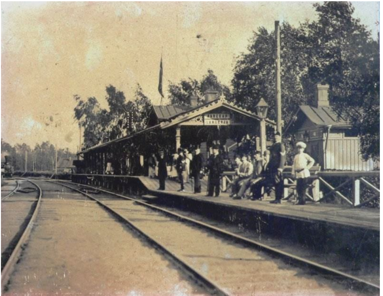
12. Финляндская железная дорога. Станция Ланская. Арх. Вольмар Вестлинг. 1870-е. Фото. Конец XIX в.
