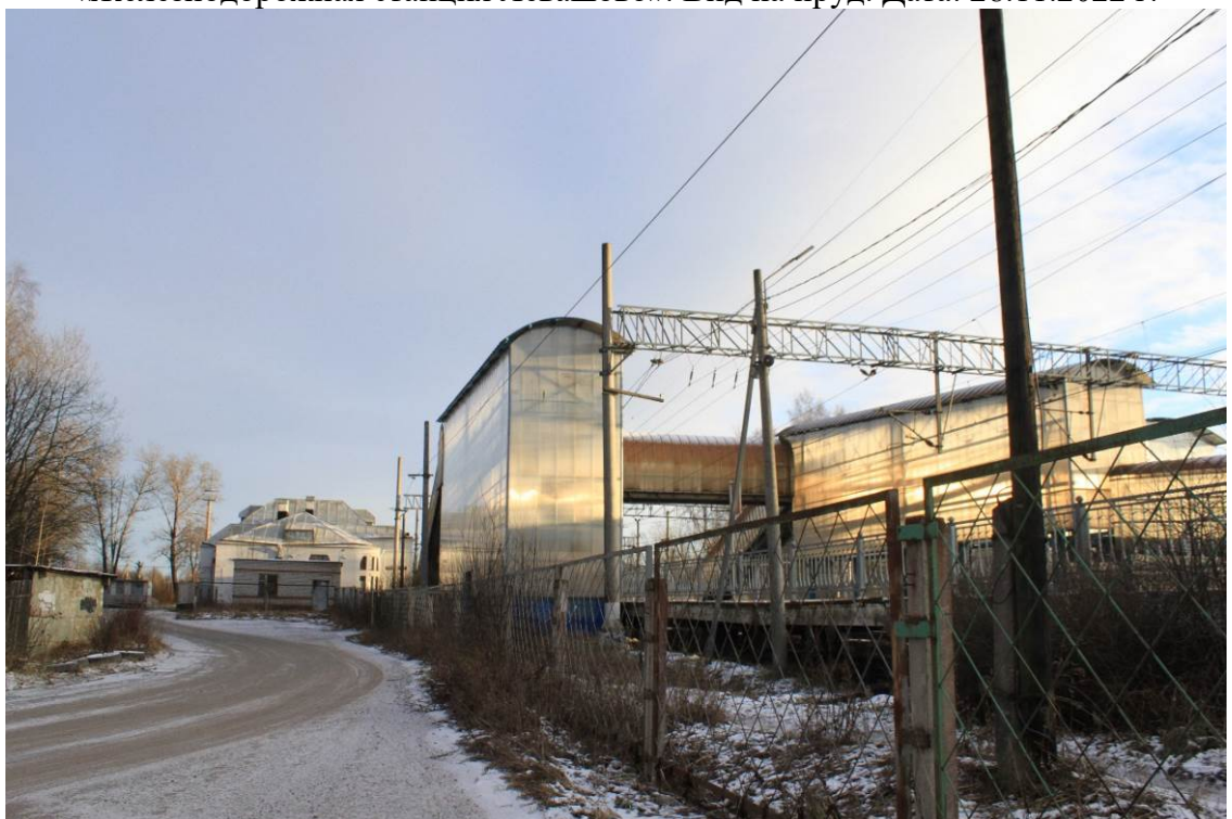
Фото 32. Территория объекта культурного наследия регионального значения «Железнодорожная станция Левашово». Общий вид территории. Дата: 28.11.2022 г.
