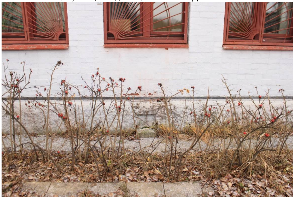
Фото 8. Объект культурного наследия регионального значения «Железнодорожная станция Левашово: вокзал» по адресу: г. Санкт-Петербург, п. Левашово, Железнодорожная ул., д. 7, лит. А (Левашово, железнодорожная станция. Вокзальное шоссе, 43). Вид на заложное вентиляционное окно в уровне цоколя (восточный фасад). Дата: 28.11.2022 г.
