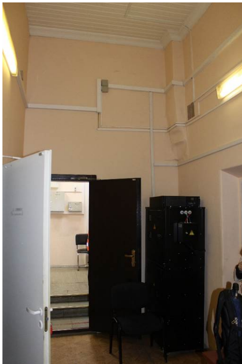
Фото 1. Объект культурного наследия регионального значения «Железнодорожная станция Левашово: вокзал» по адресу: г. Санкт-Петербург, п. Левашово, Железнодорожная ул., д. 7, лит. А (Левашово, железнодорожная станция. Вокзальное шоссе, 43). Общий вид помещения №13. Дата: 28.11.2022 г.
