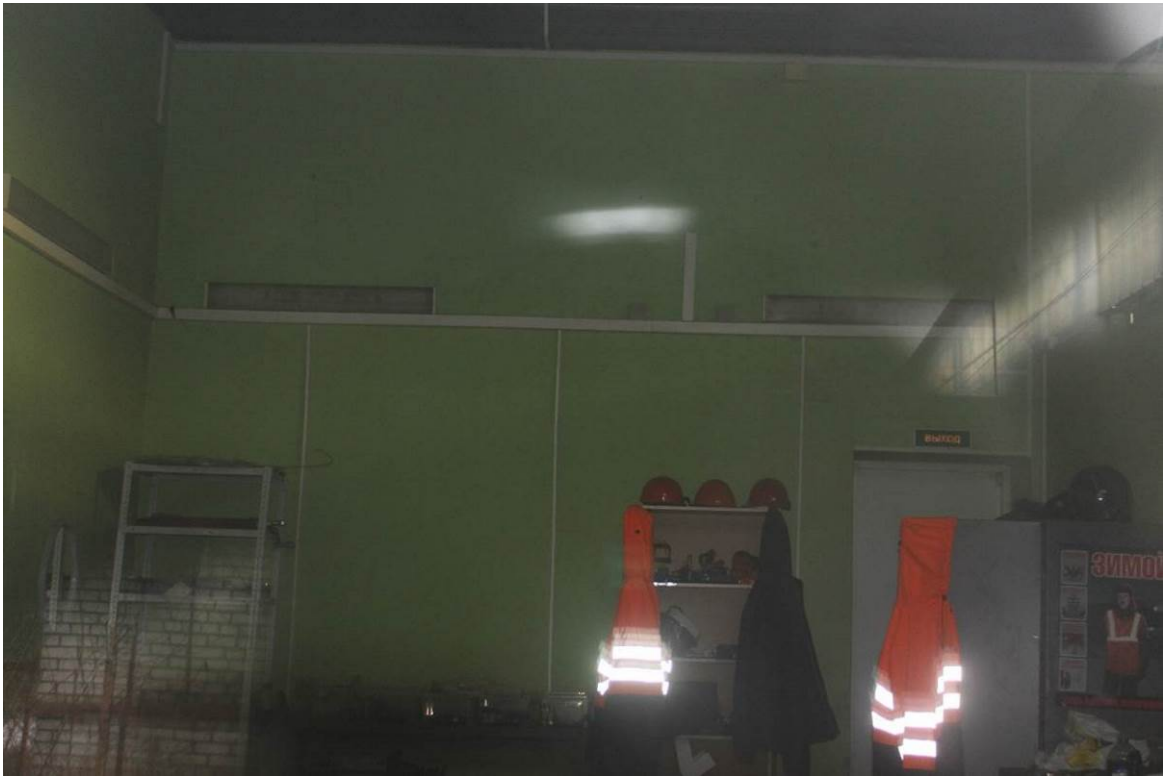
Фото 39. Объект культурного наследия регионального значения «Железнодорожная станция Левашово: вокзал» по адресу: г. Санкт-Петербург, п. Левашово, Железнодорожная ул., д. 7, лит. А (Левашово, железнодорожная станция. Вокзальное шоссе, 43). Общий вид помещения №3. Фотография сделана снаружи, со стороны окна (помещение с ограниченным доступом). Дата: 28.11.2022г.
