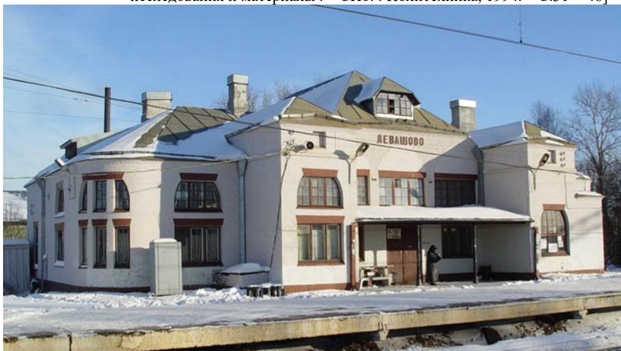
40. Финляндская железная дорога. Вокзал станции Левашово. Вид со стороны путей. Фото 2000-х гг.
