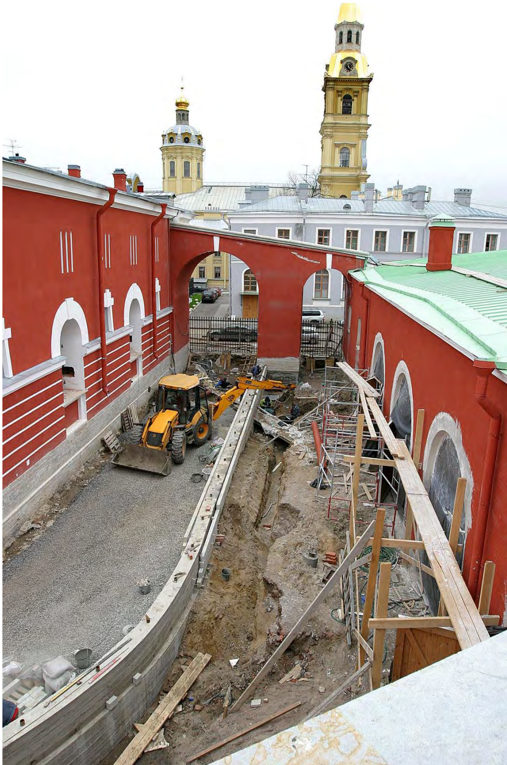
Илл.57. Фотография 2011 г. Работы по устройству подпорных стен музейфицированного канала вдоль кавальера Анны Иоанновны. КГИОП.
