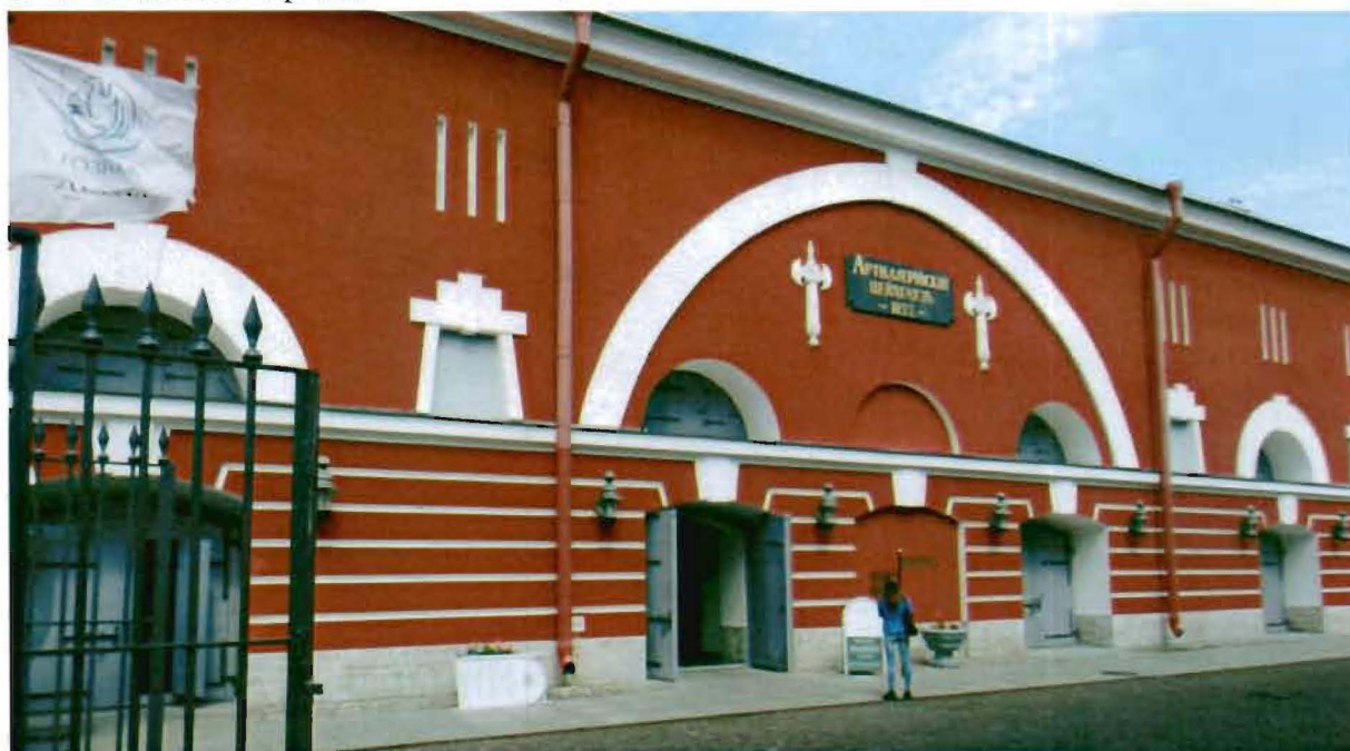
1. Вид на южный фасад.
