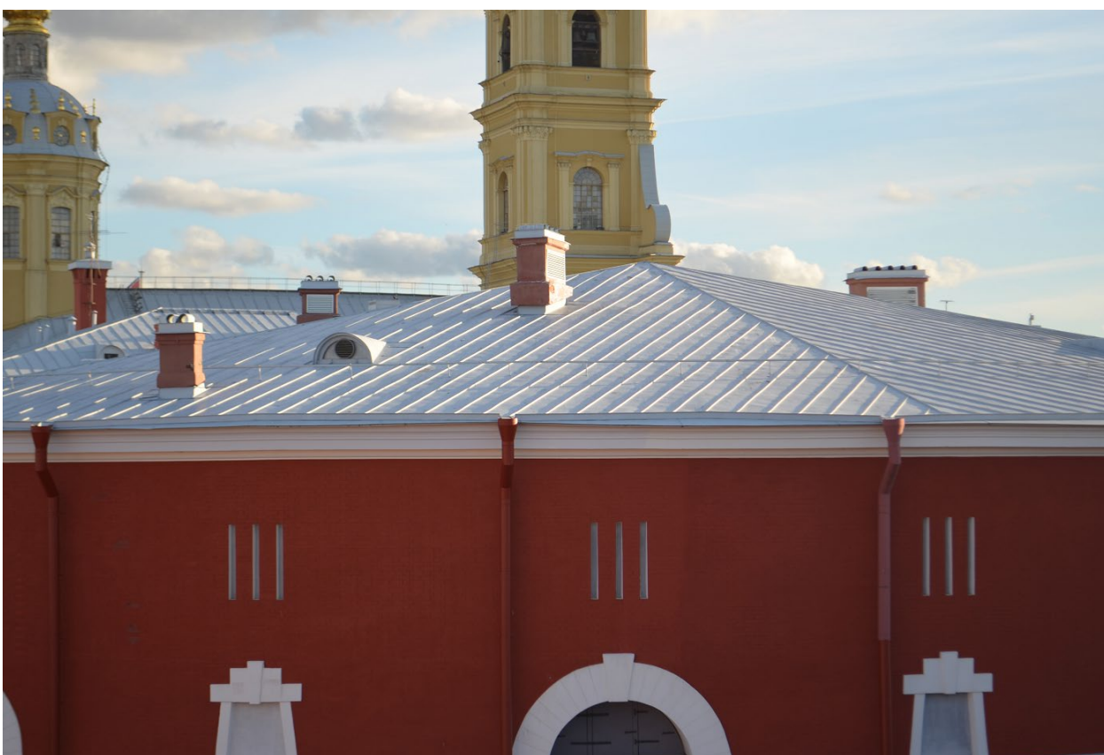
Фото 02. ОКН федерального значения «Кавальер Анны Иоанновны». Общий вид на крышу. Съёмка 24.07.2023 г.
