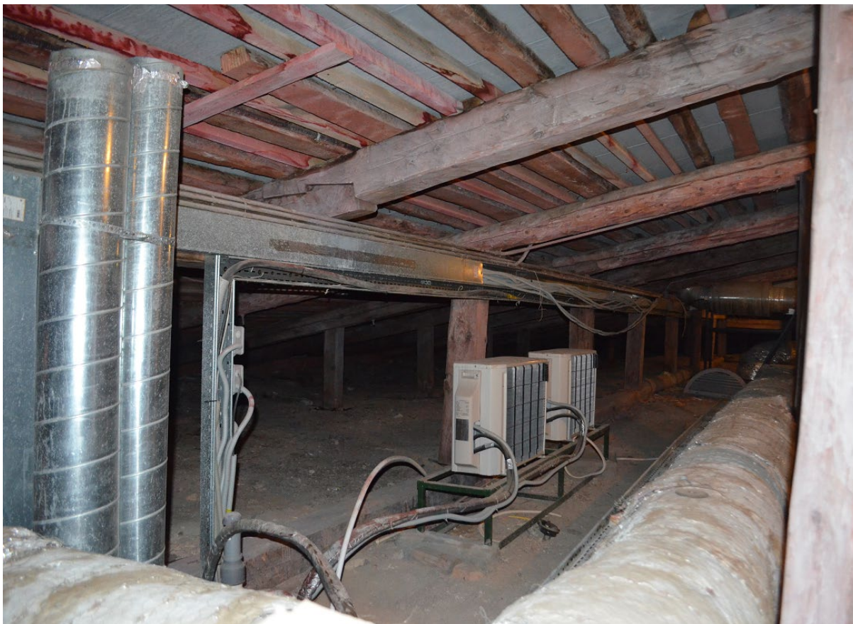
Фото 10. ОКН федерального значения «Кавальер Анны Иоанновны». Чердак. Стропильная система. Оборудование. Фрагмент. Съёмка 24.07.2023 г.
