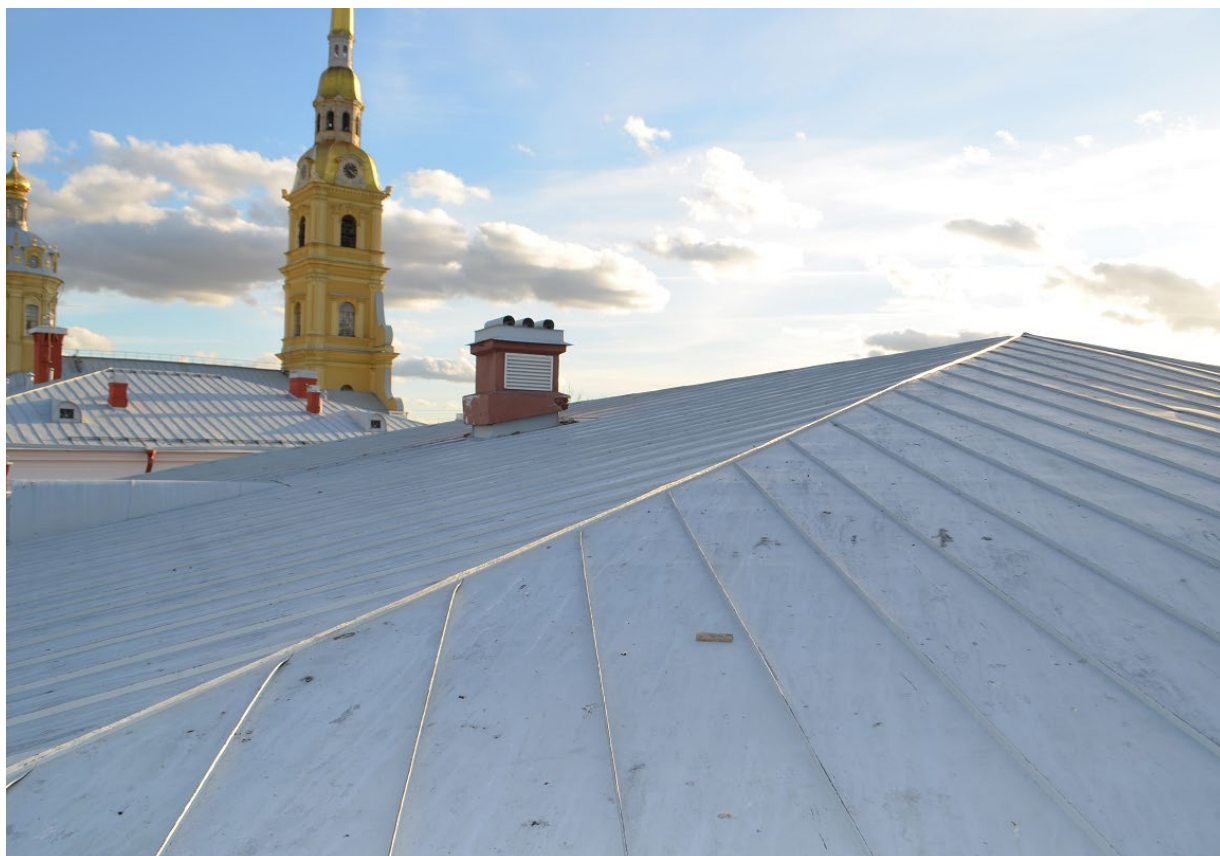
Фото 05. ОКН федерального значения «Кавальер Анны Иоанновны». Крыша. Фрагмент. Дымовые трубы. Съёмка 24.07.2023 г.
