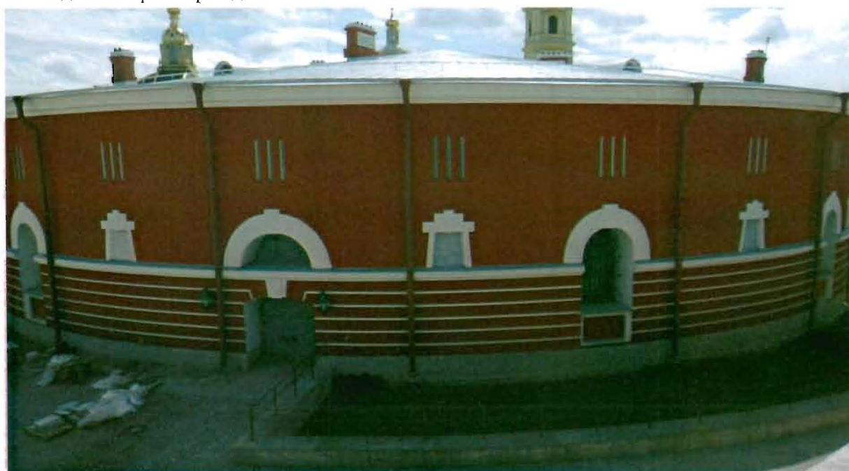
2. Вид на северный фасад.
