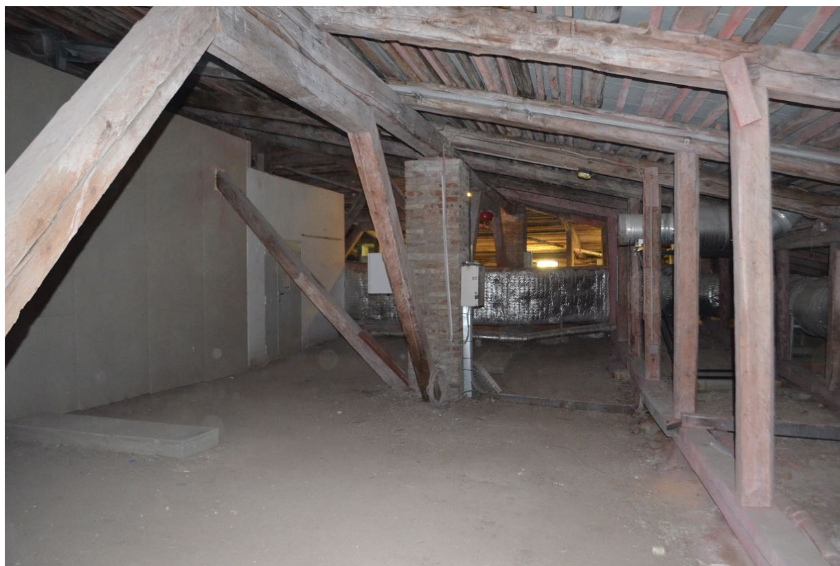
Фото 15. ОКН федерального значения «Кавальер Анны Иоанновны». Чердак. Стропильная система. Фрагмент. Съёмка 24.07.2023 г.
