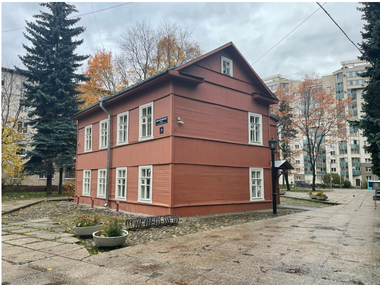
31. Объект культурного наследия регионального значения «Дом, где в 1894–1917 гг. проводились собрания рабочих-марксистов», 1894-1917 гг., г. Санкт-Петербург, Ново-Александровская улица, дом 23.
