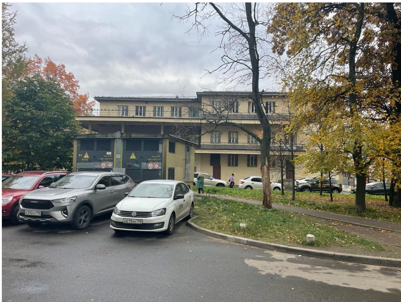
18. Выявленный объект культурного наследия «Дом культуры им. В. И. Ленина завода «Большевик», 1927–1929 гг., г. Санкт-Петербург, проспект Обуховской Обороны, 223, литера А.
