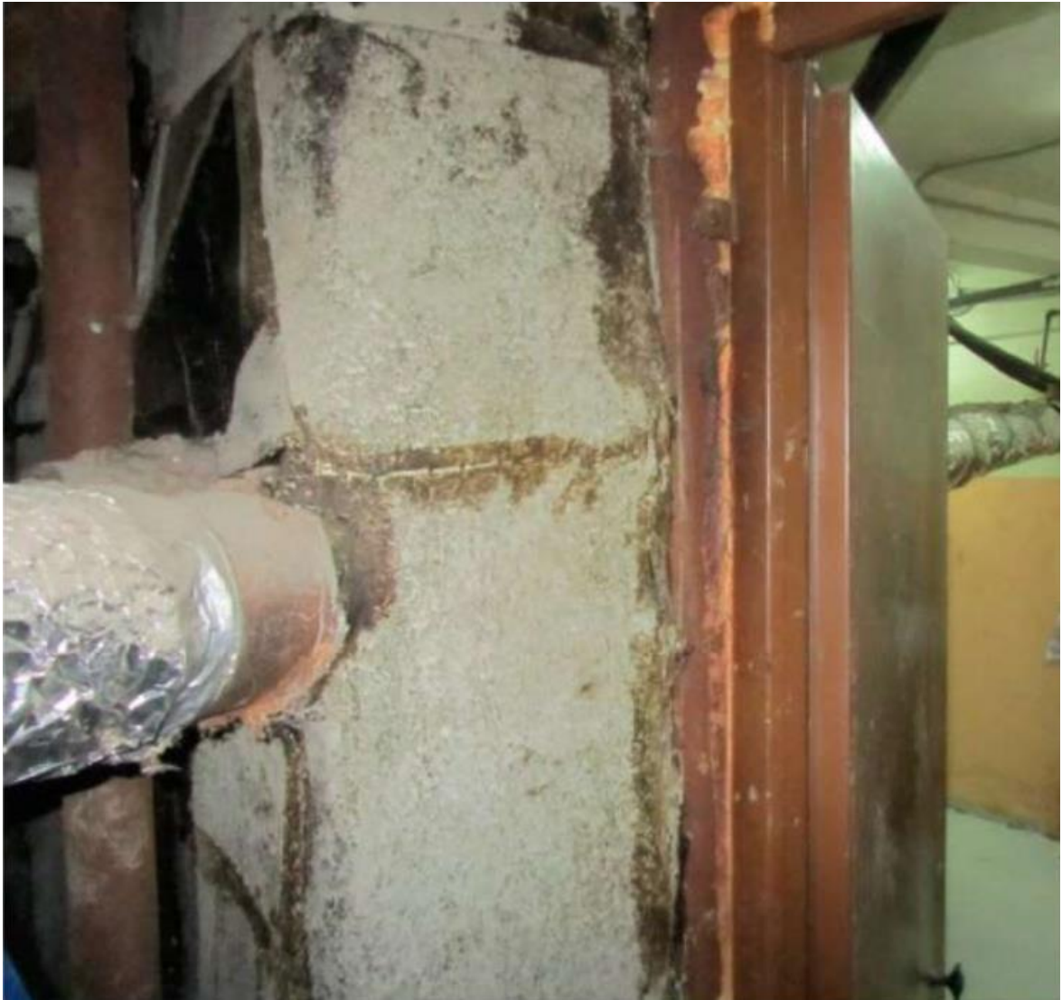
24. Выявленный объект культурного наследия «Дом культуры им. В. И. Ленина завода «Большевик», 1927–1929 гг., г. Санкт-Петербург, проспект Обуховской Обороны, 223, литера А. Подвальное помещение.
