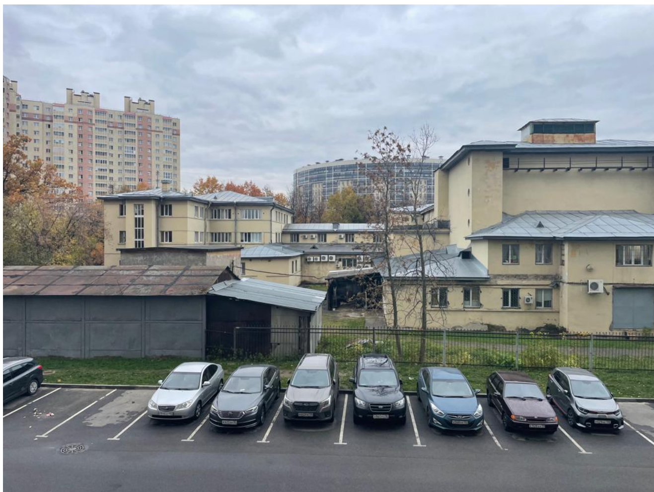
14. Выявленный объект культурного наследия «Дом культуры им. В. И. Ленина завода «Большевик», 1927–1929 гг., г. Санкт-Петербург, проспект Обуховской Обороны, 223, литера А.
