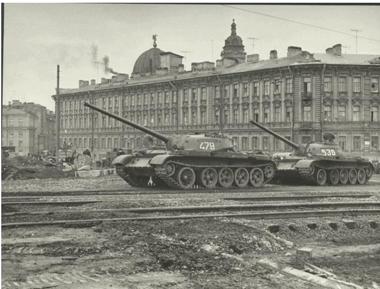
21. Испытание Тучкова моста на прочность. 1965 г. — «PastVu» – ретро-фотографии стран и городов [Электронный ресурс]. URL: https://pastvu.com/p/1578954 .
