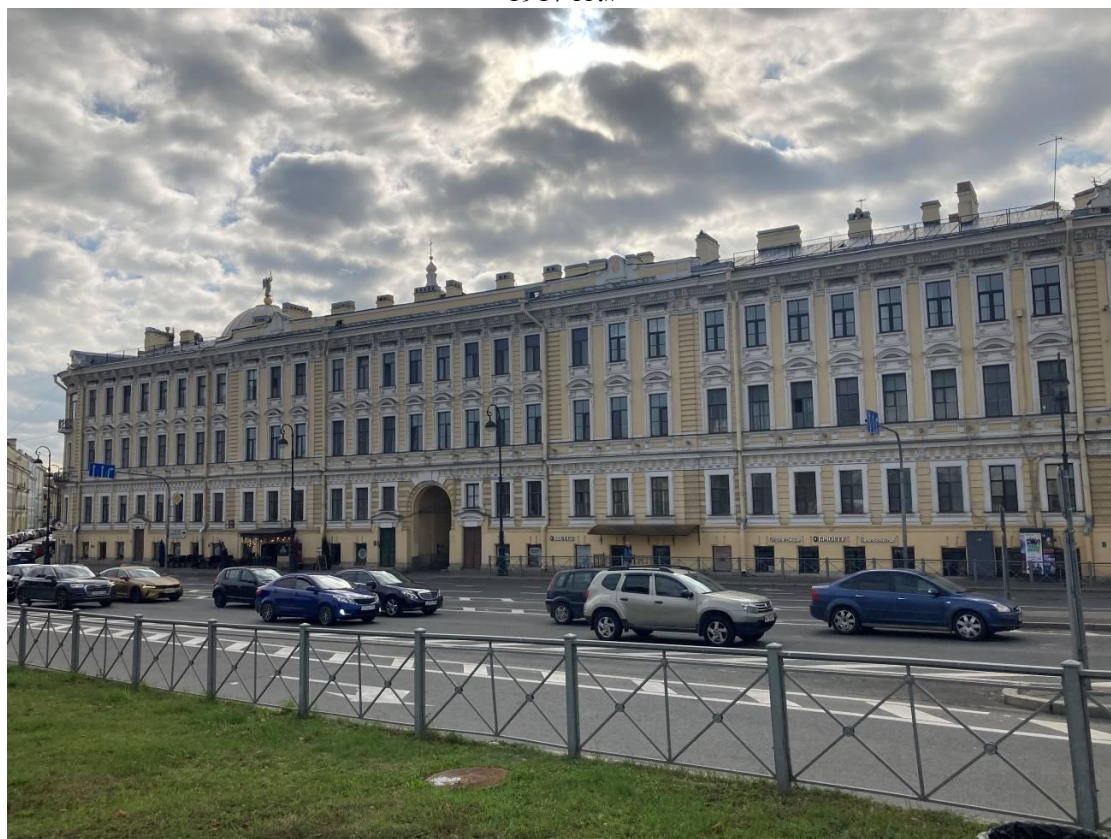
Фото 2. Лицевой фасад объекта культурного наследия регионального значения «Дом, в котором жили: Попов Александр Степанович в 1901-1902 гг., Козлов Петр Кузьмич в 1903-1905 гг., Дубовской Николай Никонорович в 1894- 1896 гг. и Введенский Николай Евгеньевич в 1915-1917 гг.» (по наб. Макарова)
