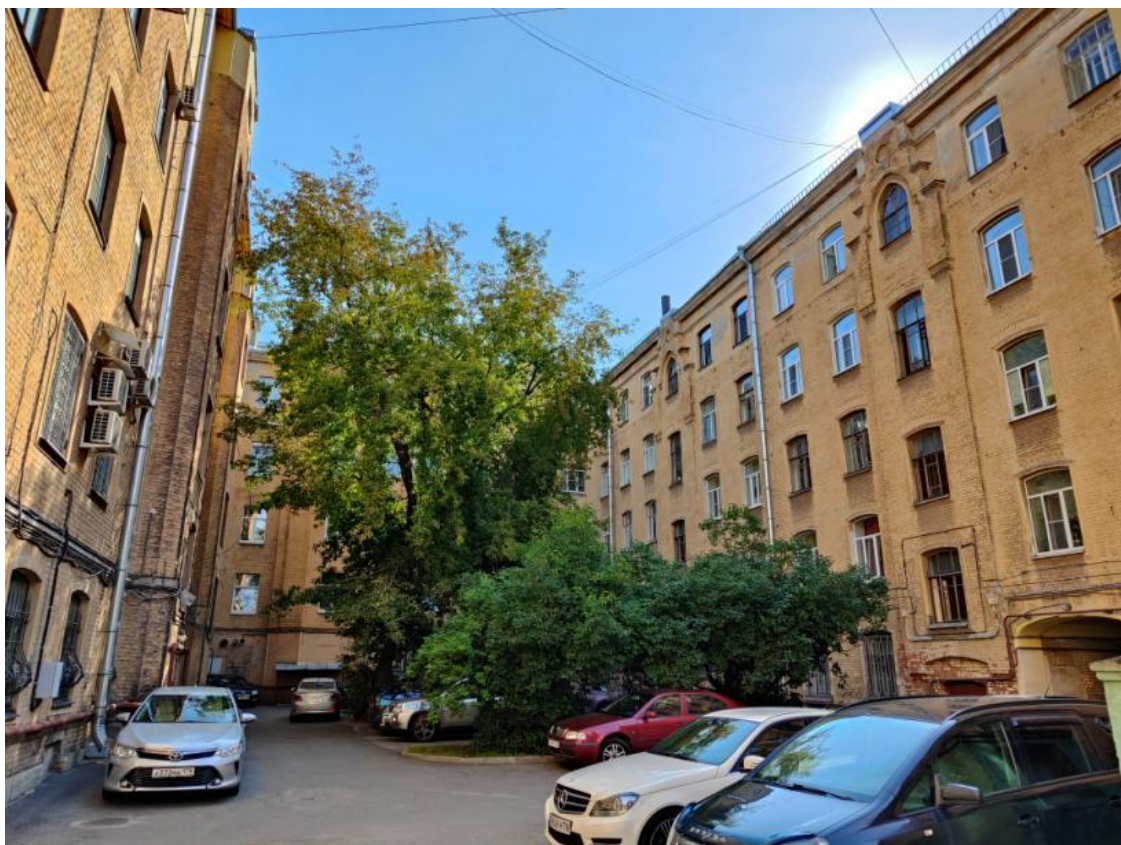
Фото 3 Фрагмент дворового фасада выявленного объекта культурного наследия «Дом Б.Е. Фурмана»
