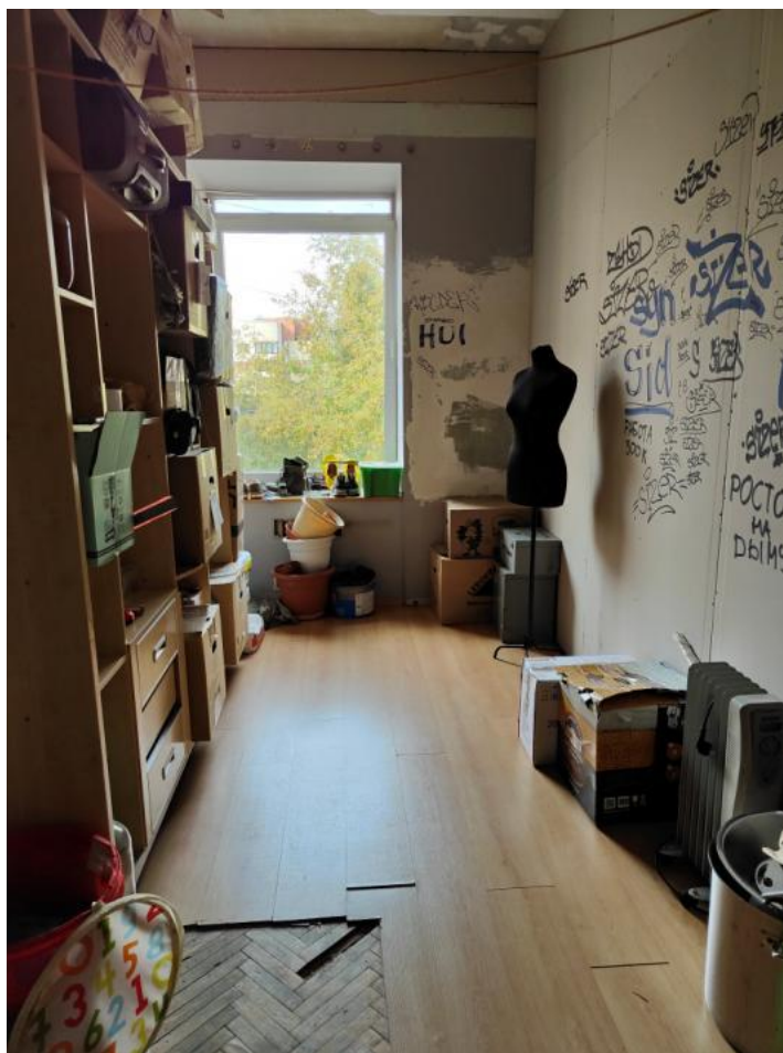
Фото 9 Интерьер квартиры № 81 выявленного объекта культурного наследия «Дом Б.Е. Фурмана»
