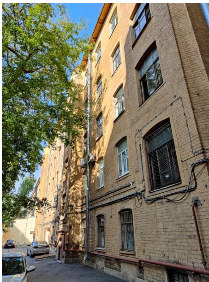
Фото 4 Фрагмент дворового фасада выявленного объекта культурного наследия «Дом Б.Е. Фурмана»
