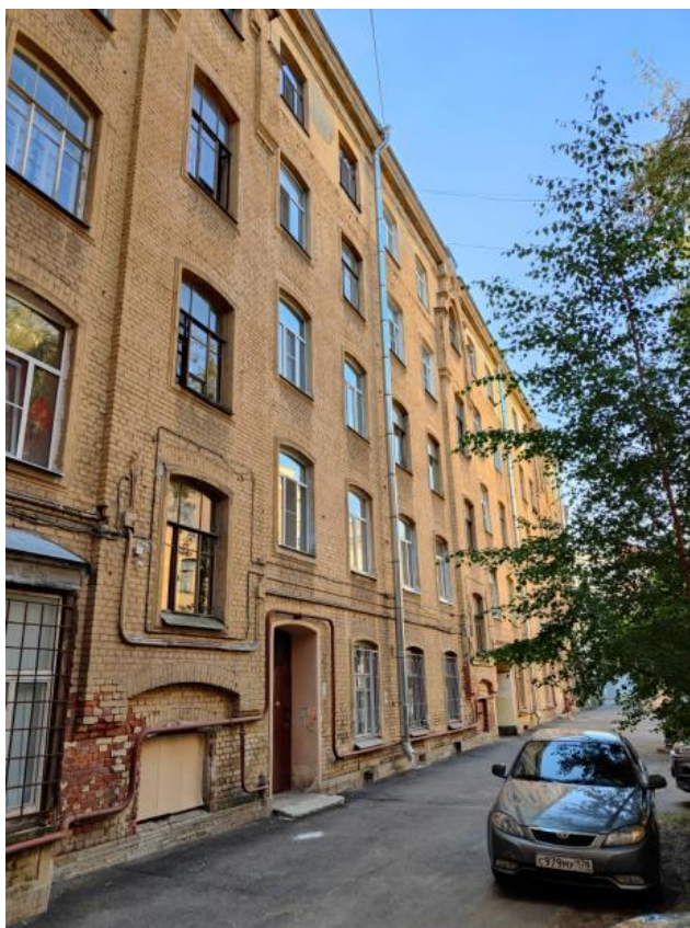
Фото 5 Фрагмент дворового фасада выявленного объекта культурного наследия «Дом Б.Е. Фурмана»
