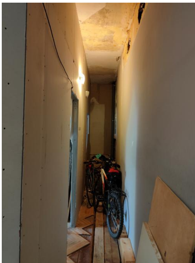
Фото 10 Интерьер квартиры № 81 выявленного объекта культурного наследия «Дом Б.Е. Фурмана»
