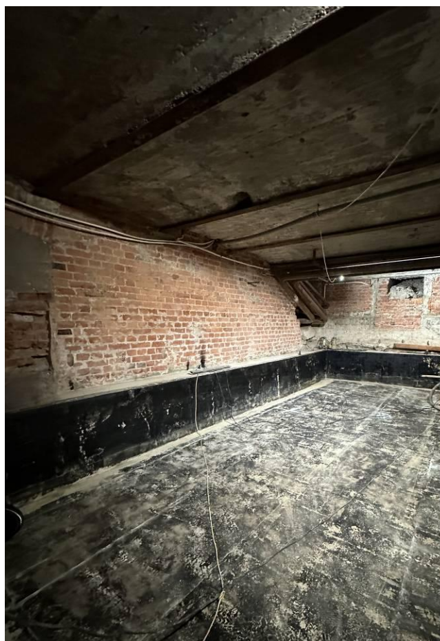
Фото 12. Интерьер пом. 11-Н объекта культурного наследия регионального значения «Дом М.М. Горбова»
