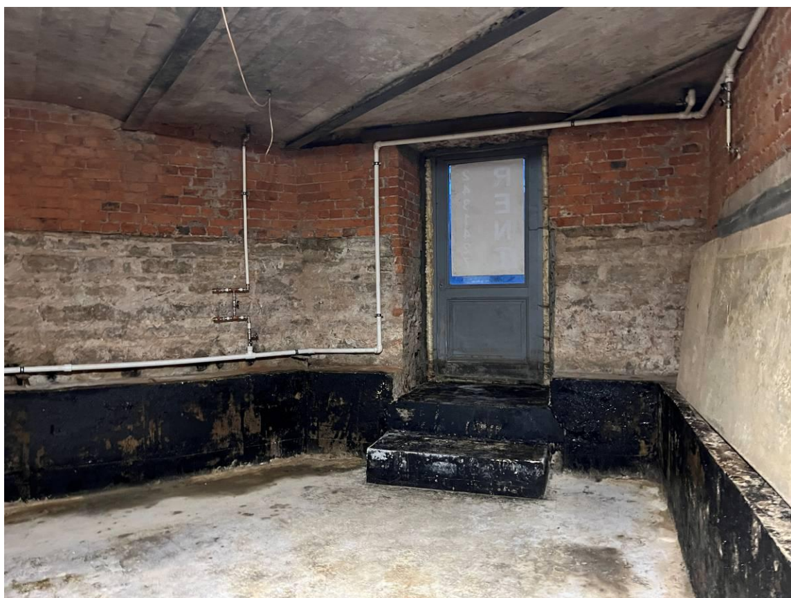
Фото 8. Интерьер пом. 11-Н объекта культурного наследия регионального значения «Дом М.М. Горбова»
