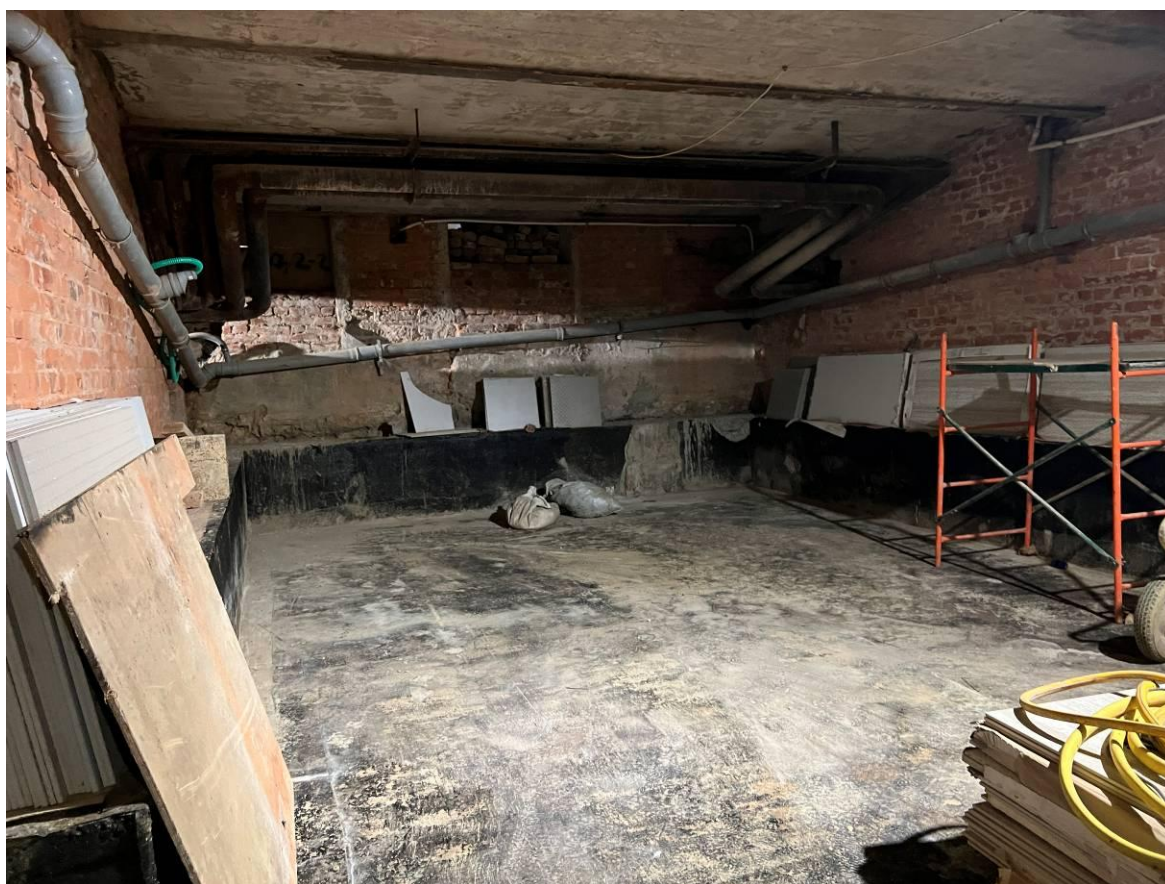
Фото 14. Интерьер пом. 11-Н объекта культурного наследия регионального значения «Дом М.М. Горбова»
