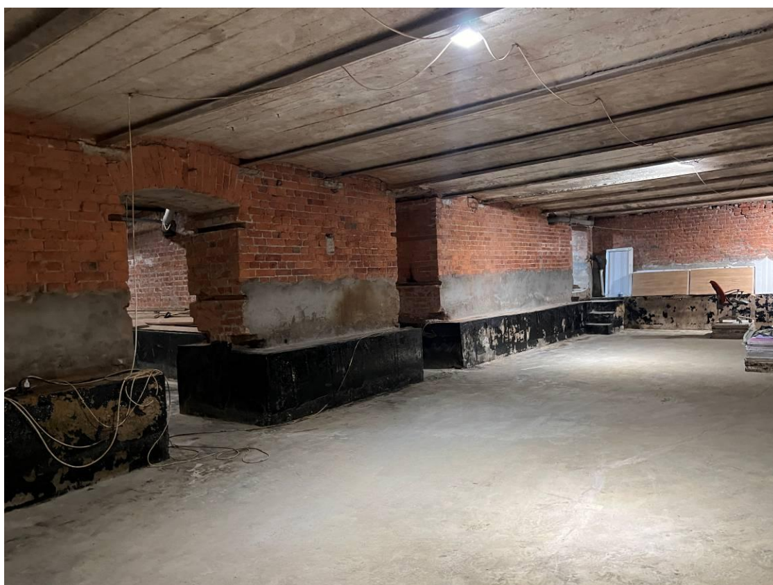
Фото 10. Интерьер пом. 11-Н объекта культурного наследия регионального значения «Дом М.М. Горбова»
