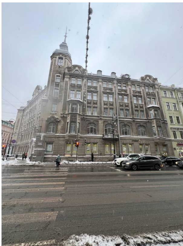
Фото 1. Лицевой фасад объекта культурного наследия регионального значения «Дом М.М. Горбова»
