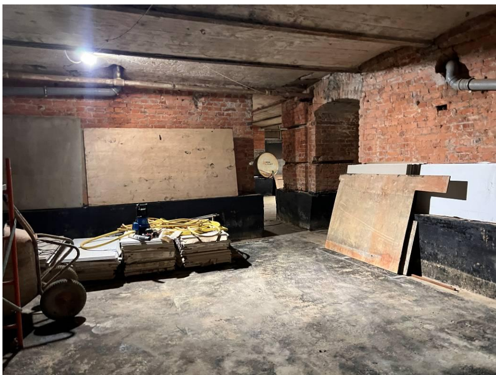
Фото 13. Интерьер пом. 11-Н объекта культурного наследия регионального значения «Дом М.М. Горбова»
