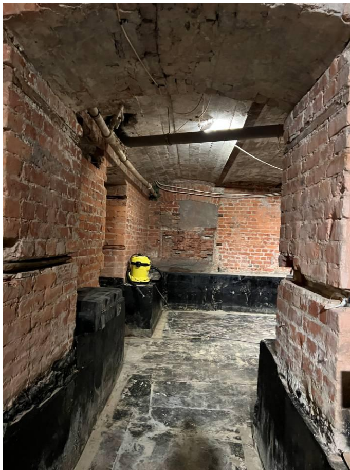
Фото 15. Интерьер пом. 11-Н объекта культурного наследия регионального значения «Дом М.М. Горбова»
