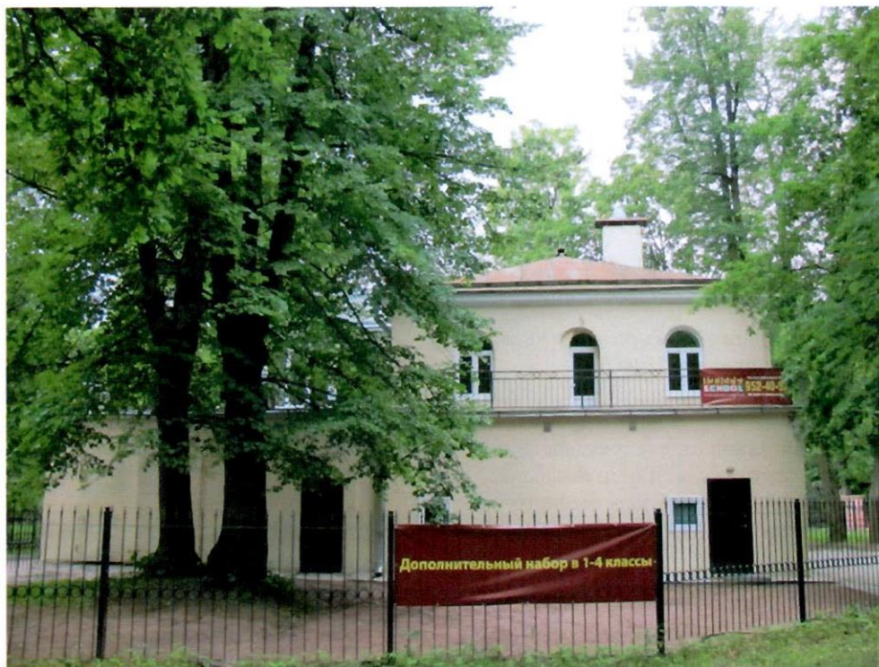
4. «Кухонный корпус». Северо-восточный фасад.
