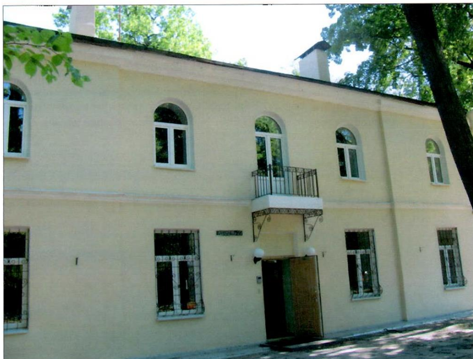
2. «Кухонный корпус». Северо-западный фасад. Фрагмент.
