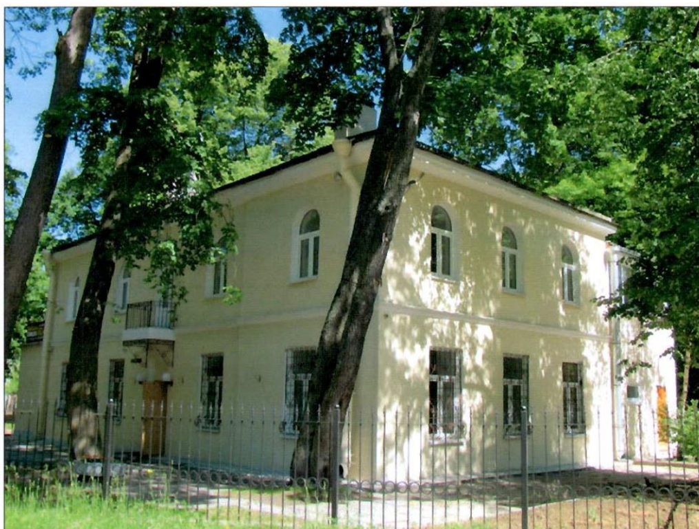
1. «Кухонный корпус». Общий вид с запада.
