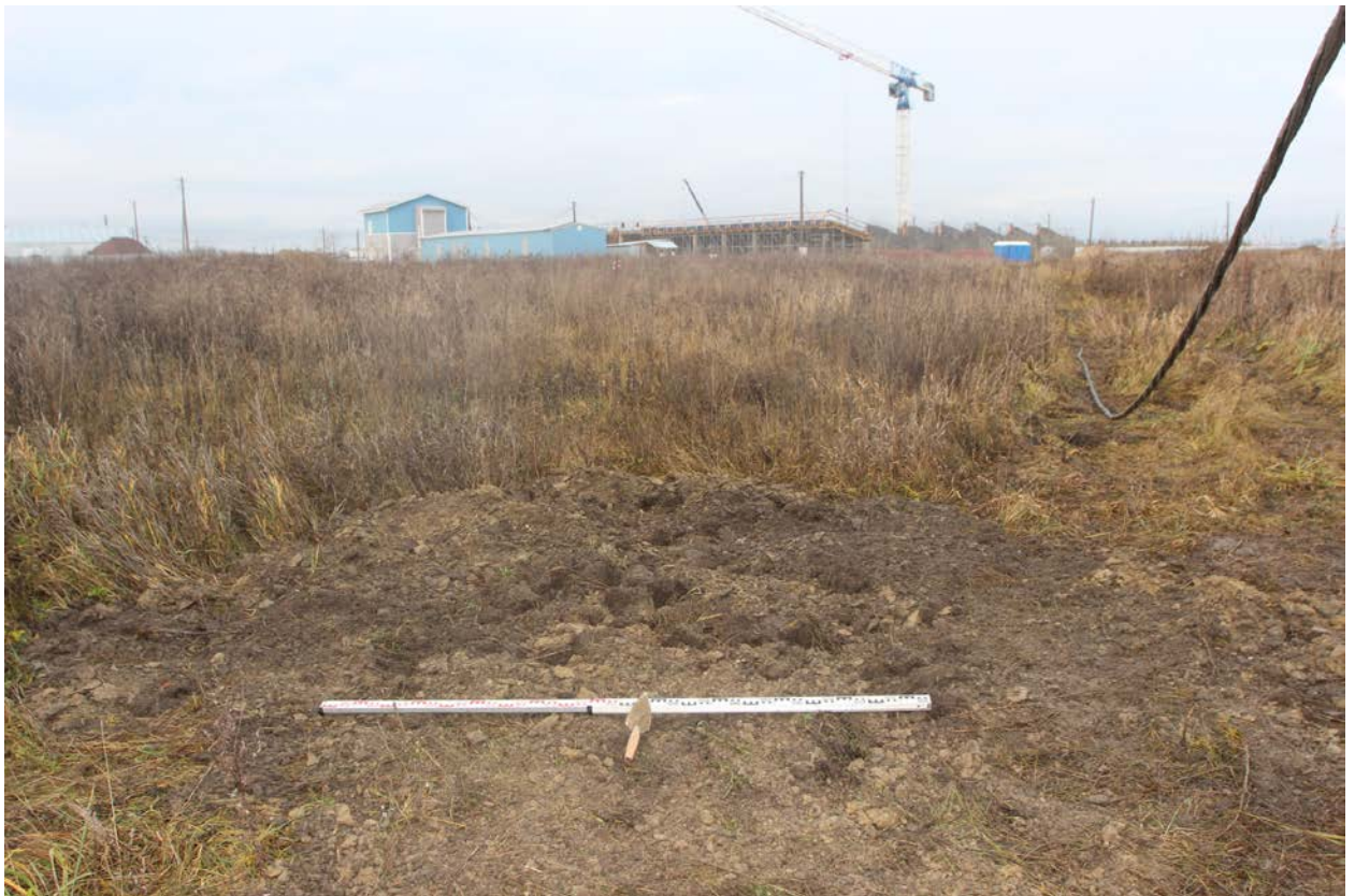
Рис. 50. Шушары, Ленсоветовский, КН:78:42:0015109:34. Шурф 2, после рекультивации, вид на север.
