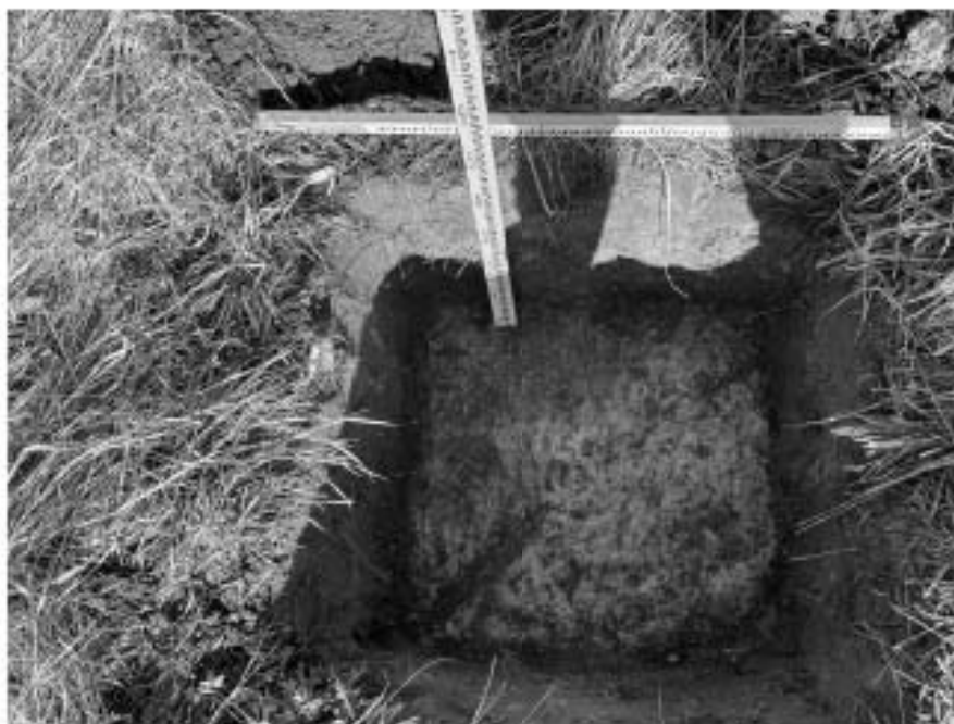
Илл. 48. г. Пушкин. Территория обследования. Шурф 3 по завершении земляных работ. Вид с юга сверху.
