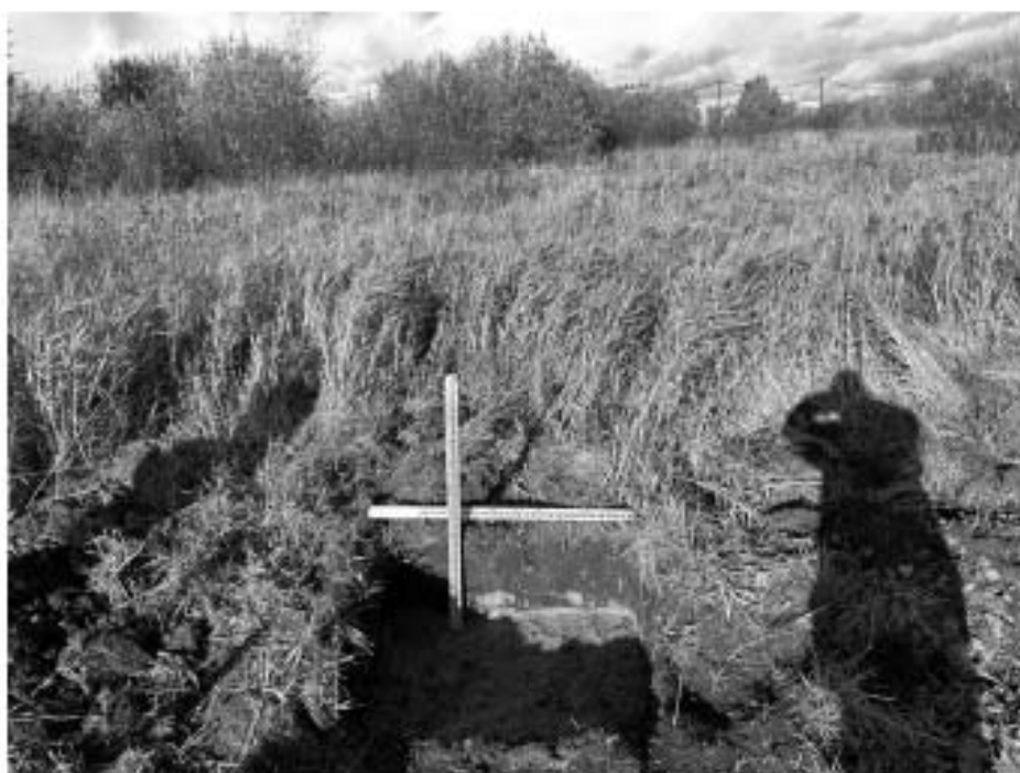
Илл. 88. г. Пушкин. Территория обследования. Шурф 10 по завершении земляных работ. Вид с юга.
