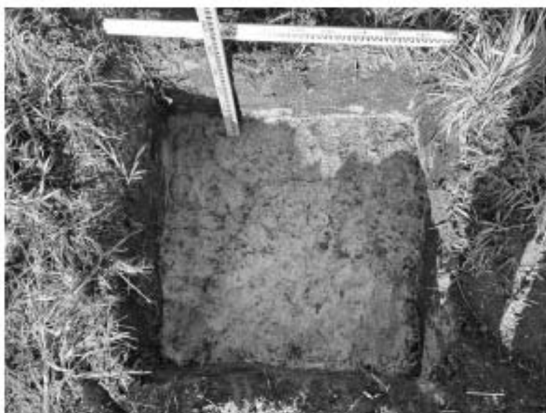
Илл. 89. г. Пушкин. Территория обследования. Шурф 10 по завершении земляных работ. Вид с юга сверху.
