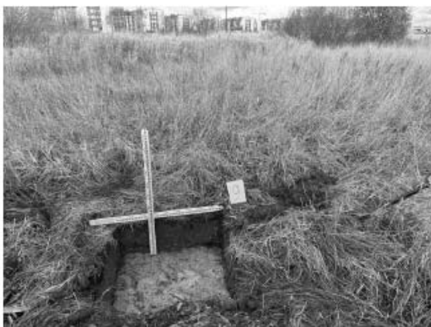
Илл. 82. г. Пушкин. Территория обследования. Шурф 9 по завершении земляных работ. Вид с юга.
