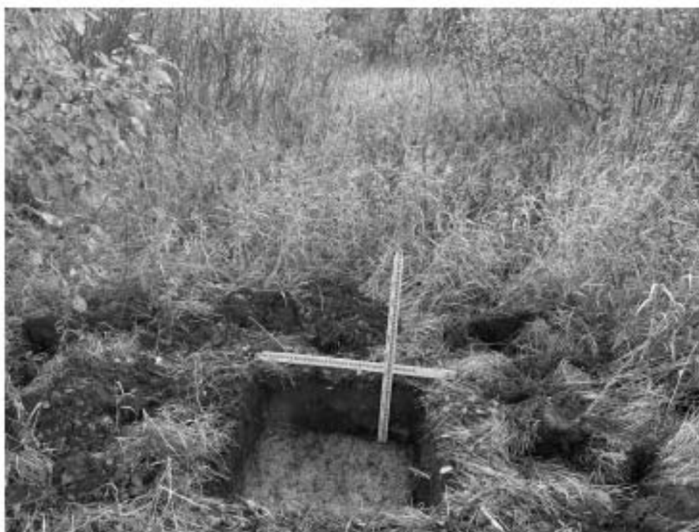
Илл. 117. г. Пушкин. Территория обследования. Шурф 15 по завершении земляных работ. Вид с юга.
