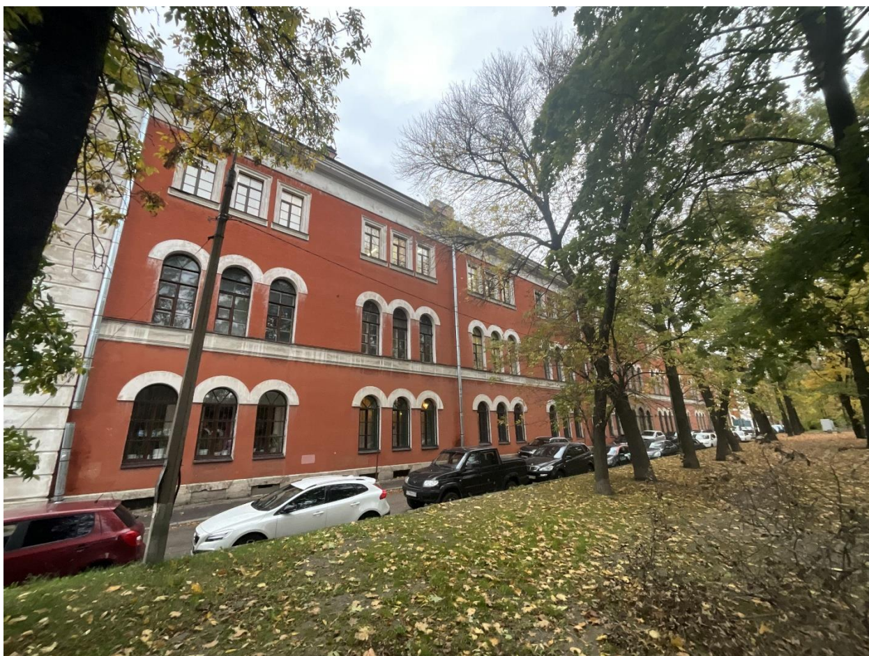
Фото 5. Лицевой фасад. Направление съемки – юго-запад.
