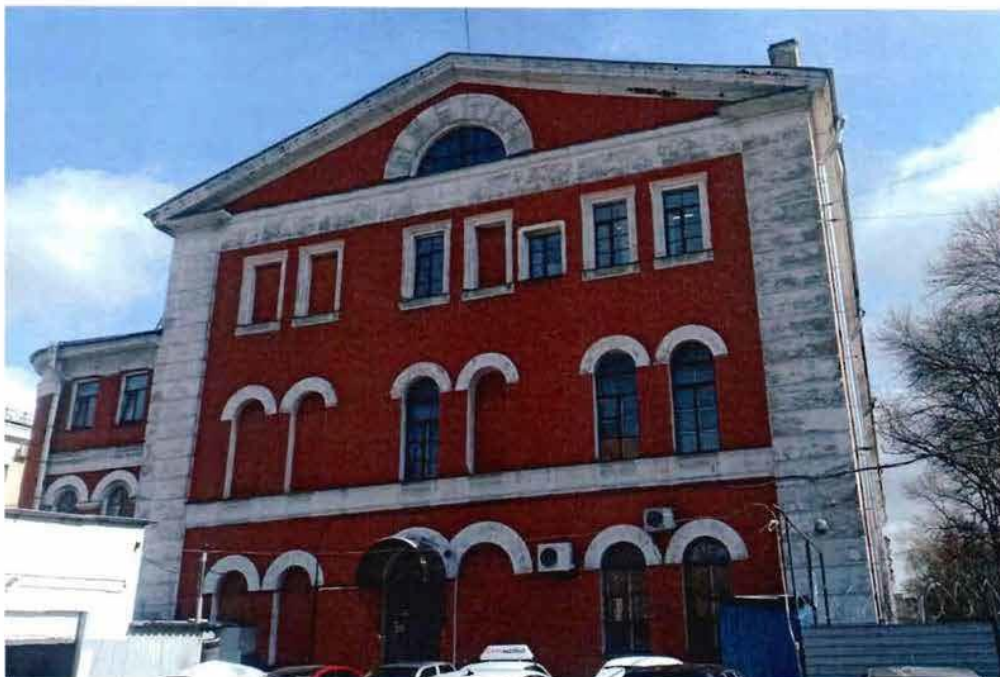
2. Вид на западный фасад объекта культурного наследия.
