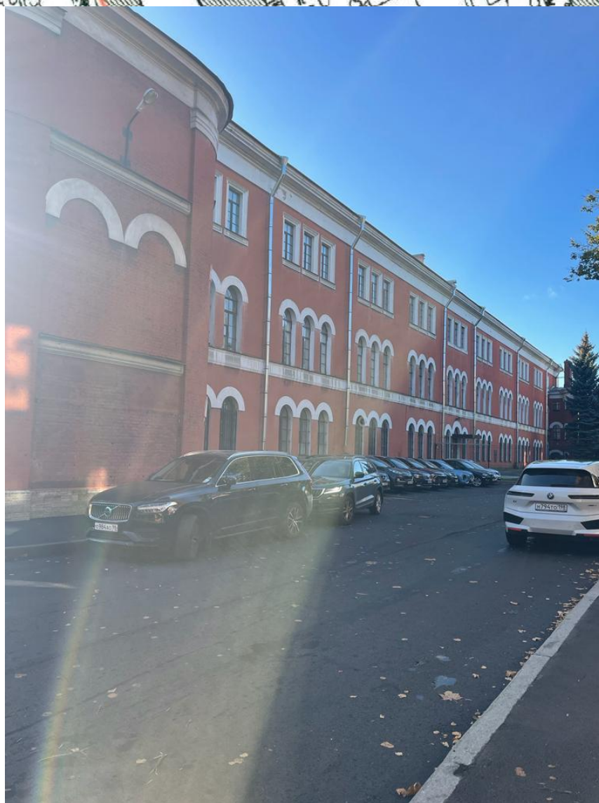
Фото 1. Дворовый фасад. Направление съемки – юго-запад.
