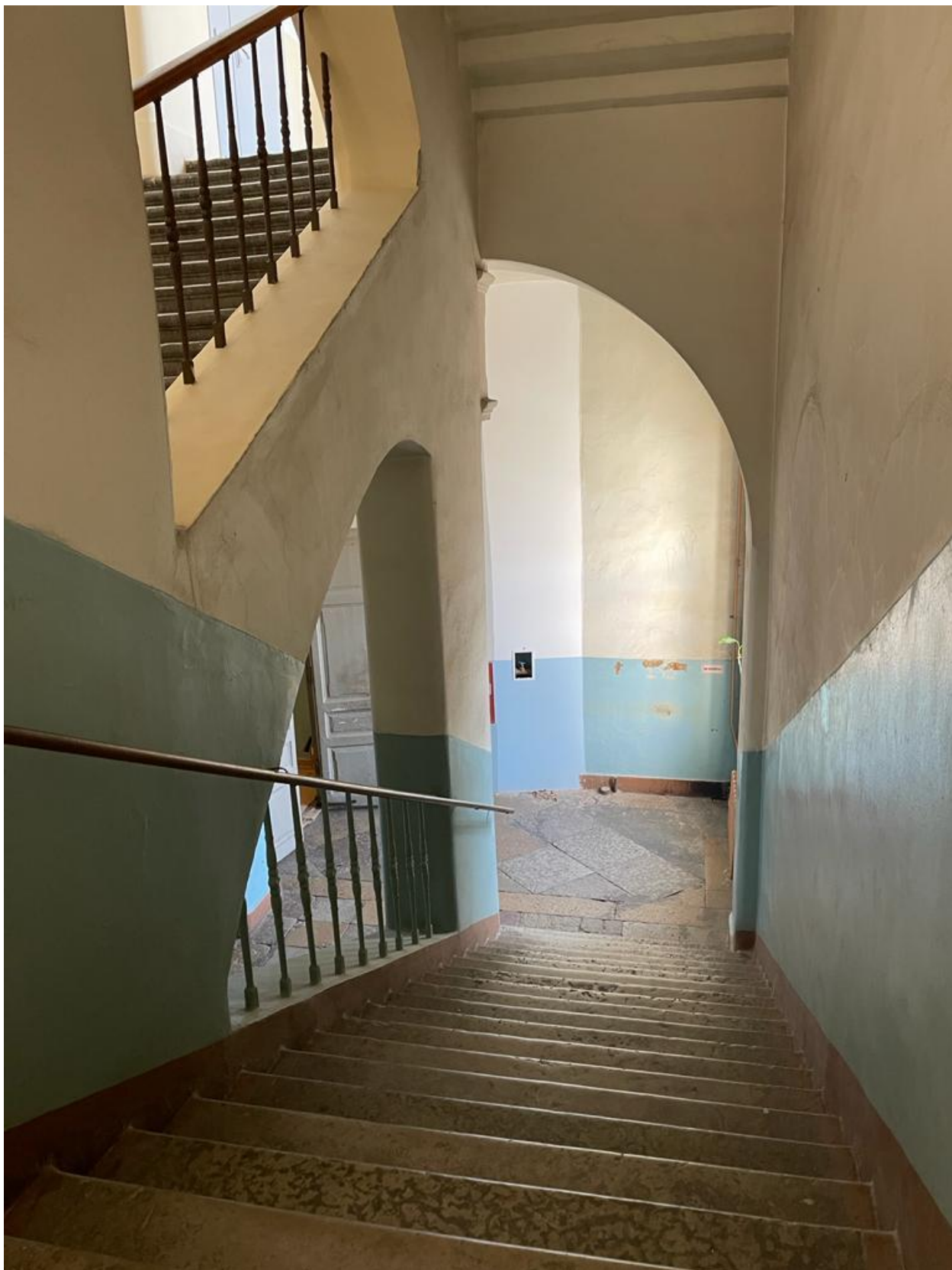
Фото 8. Вид на площадку 2 этажа
