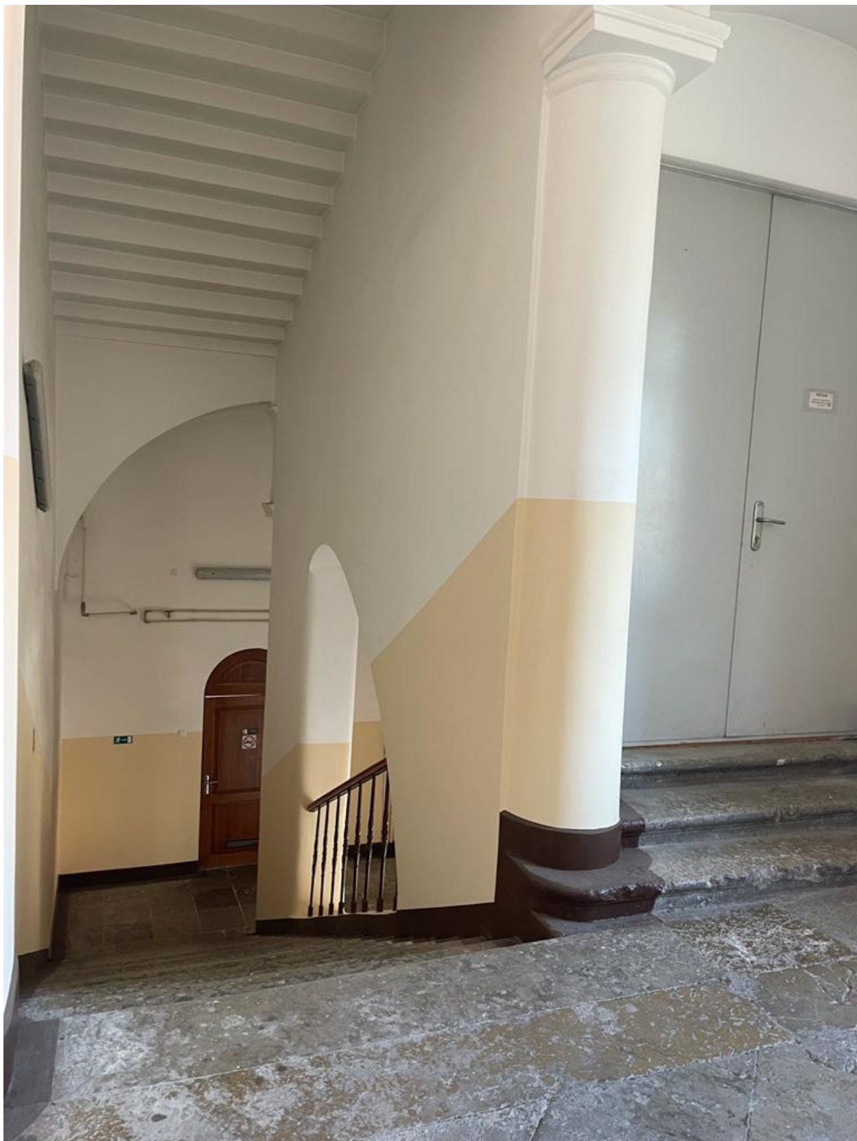
Фото 14. Вид с площадки 3 этажа.
