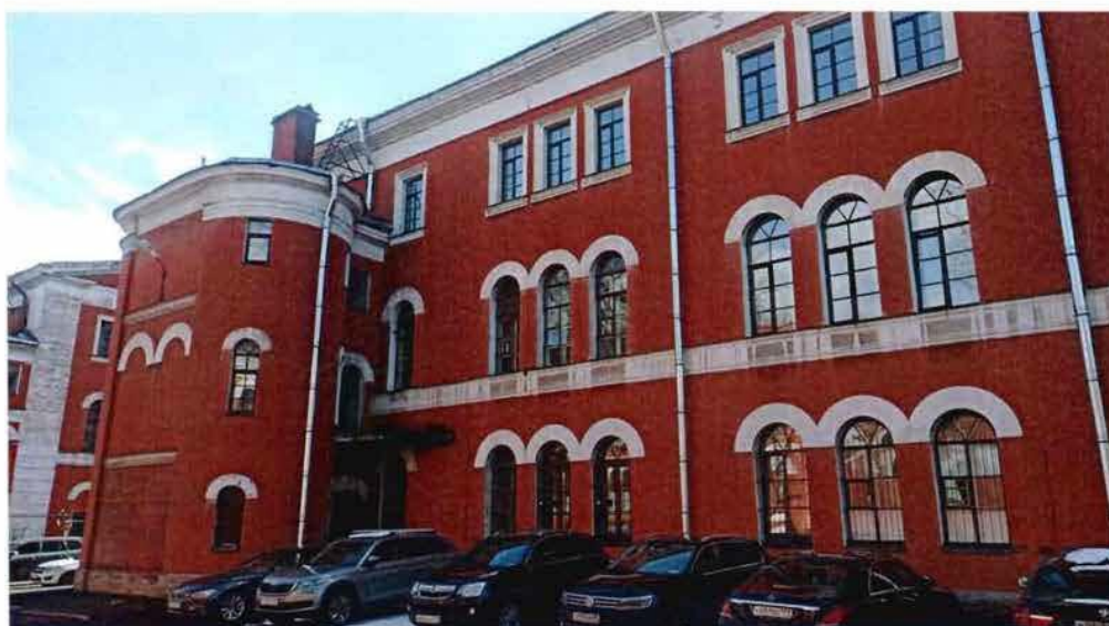
3. Вид на северный фасад объекта культурного наследия.
