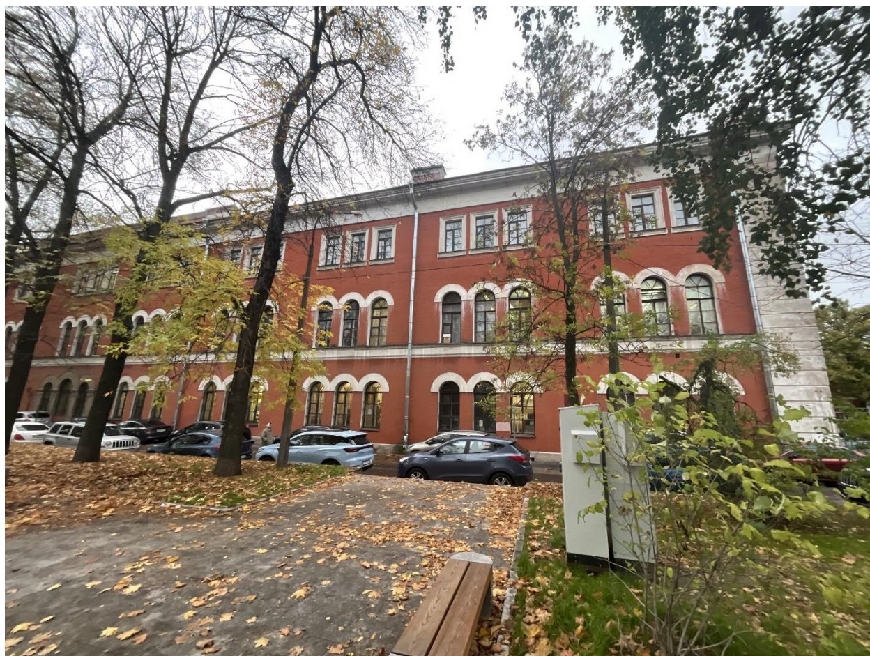
Фото 6. Лицевой фасад. Направление съемки – юго-восток.
