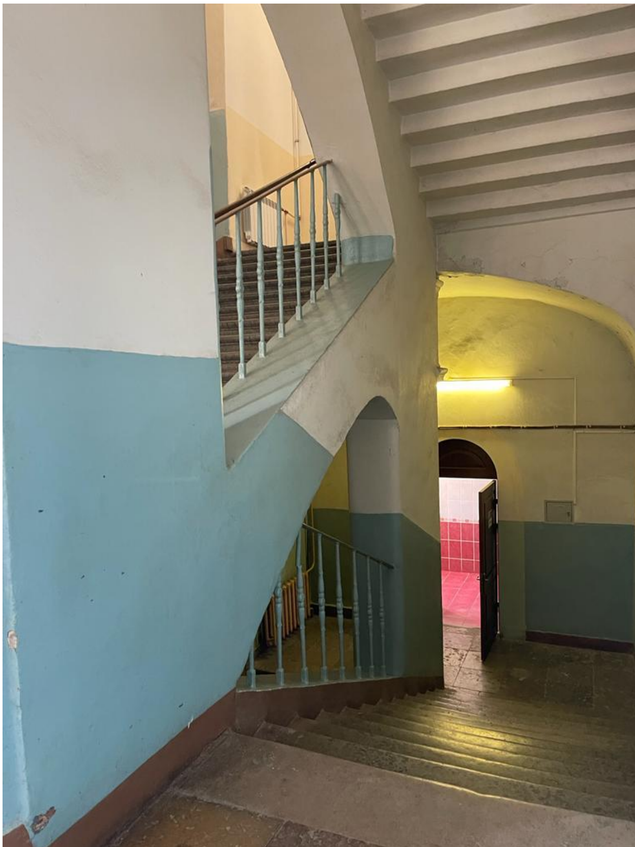
Фото 10. Вид с площадки 2 этажа
