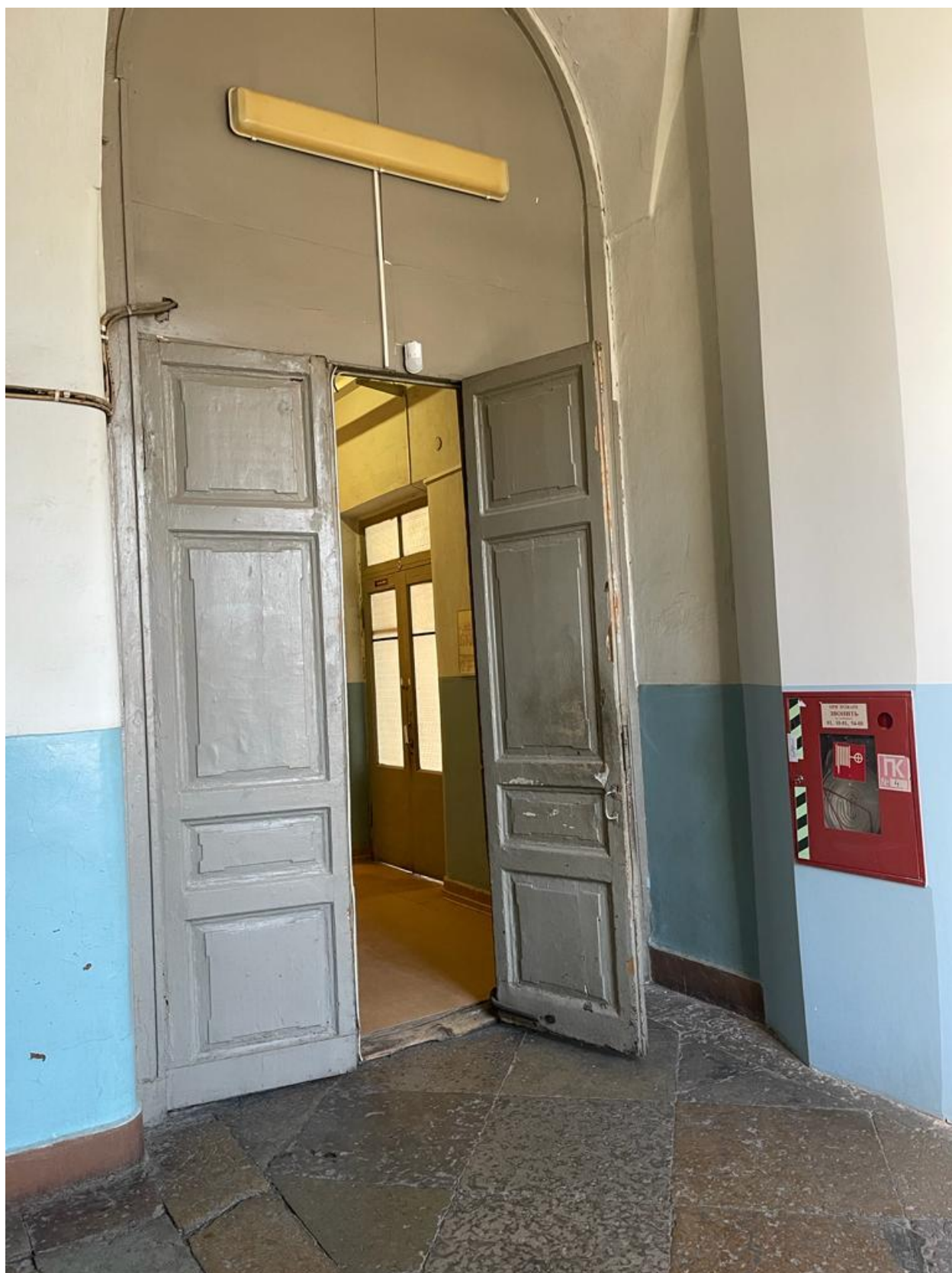
Фото 9. Дверное заполнение 2 этажа со стороны лестницы
