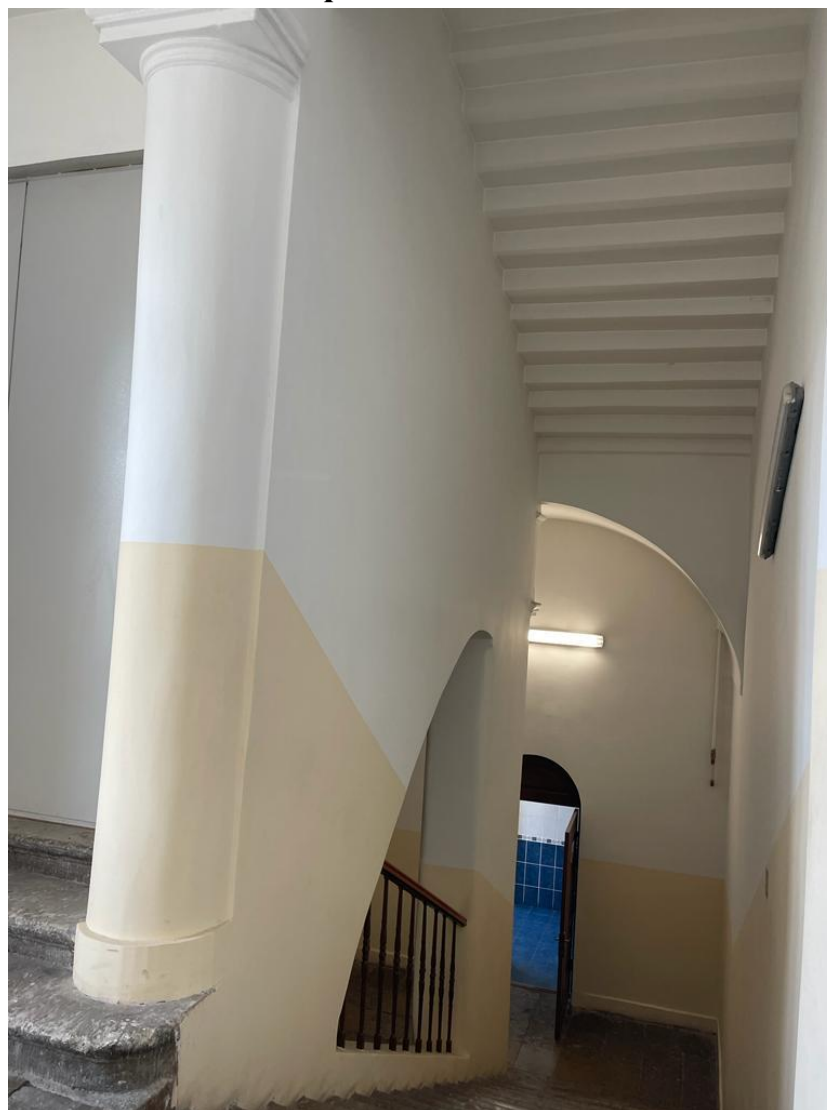
Фото 7. Вид с площадки 3 этажа
