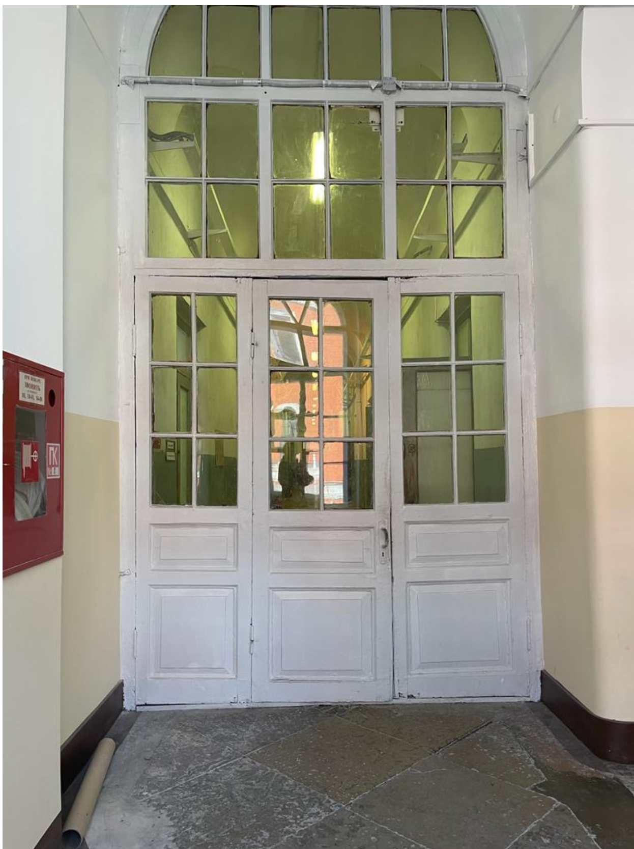
Фото 12. Дверное заполнение 2 этажа, вид со стороны лестницы
