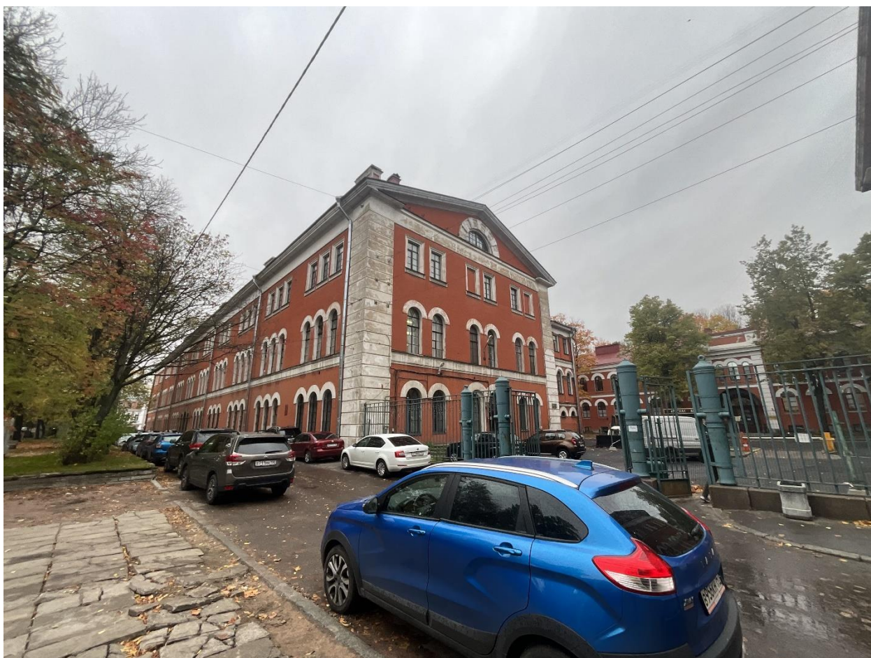
Фото 2. Лицевой и торцевой фасады. Направление съемки – северо-запад.
