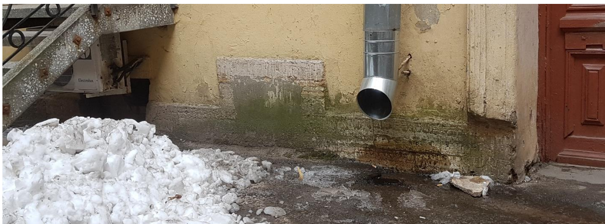
Фото 29. Цоколь. Дворовой восточный фасад.
