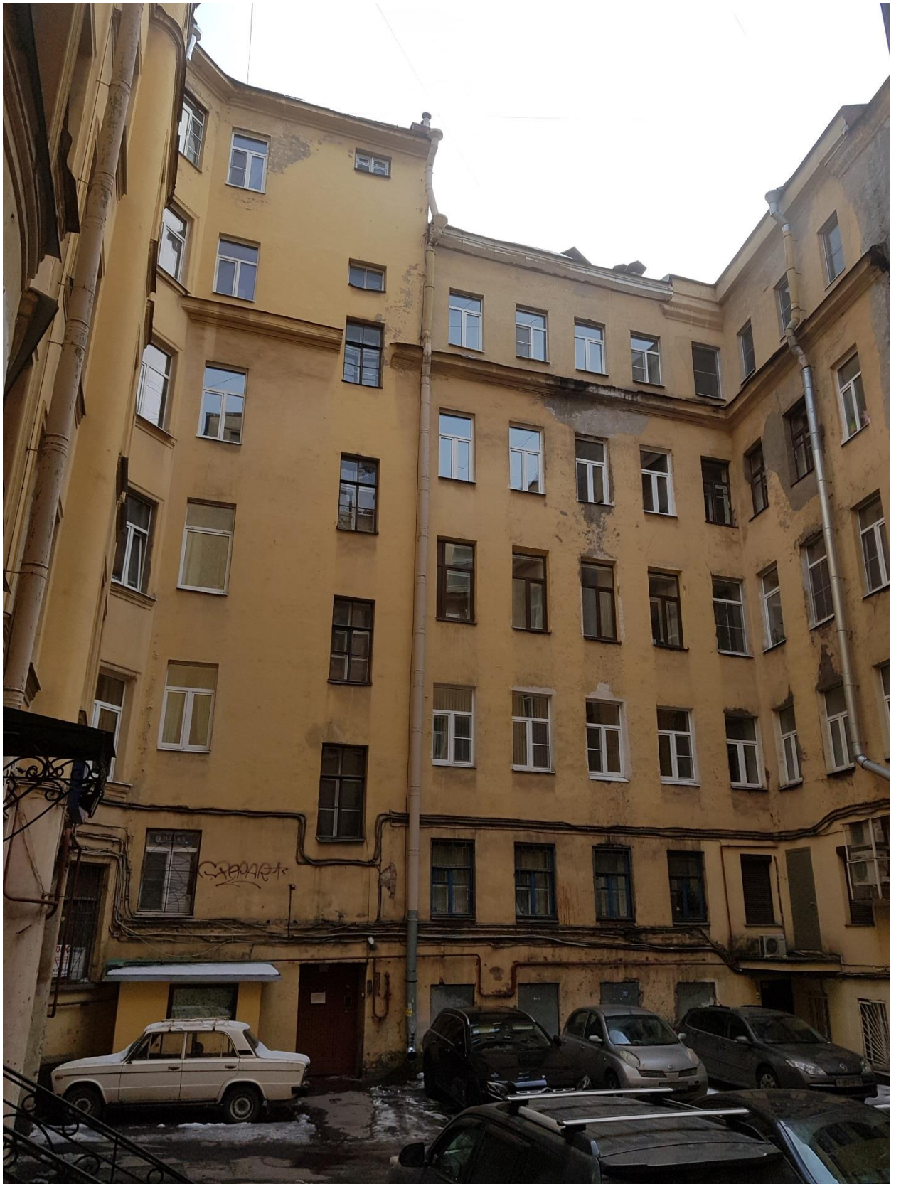
Фото 30. Дворовой южный фасад.
