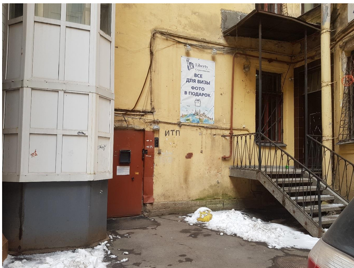
Фото 26. Уровень 1-го этажа. Дворовой северный фасад.
