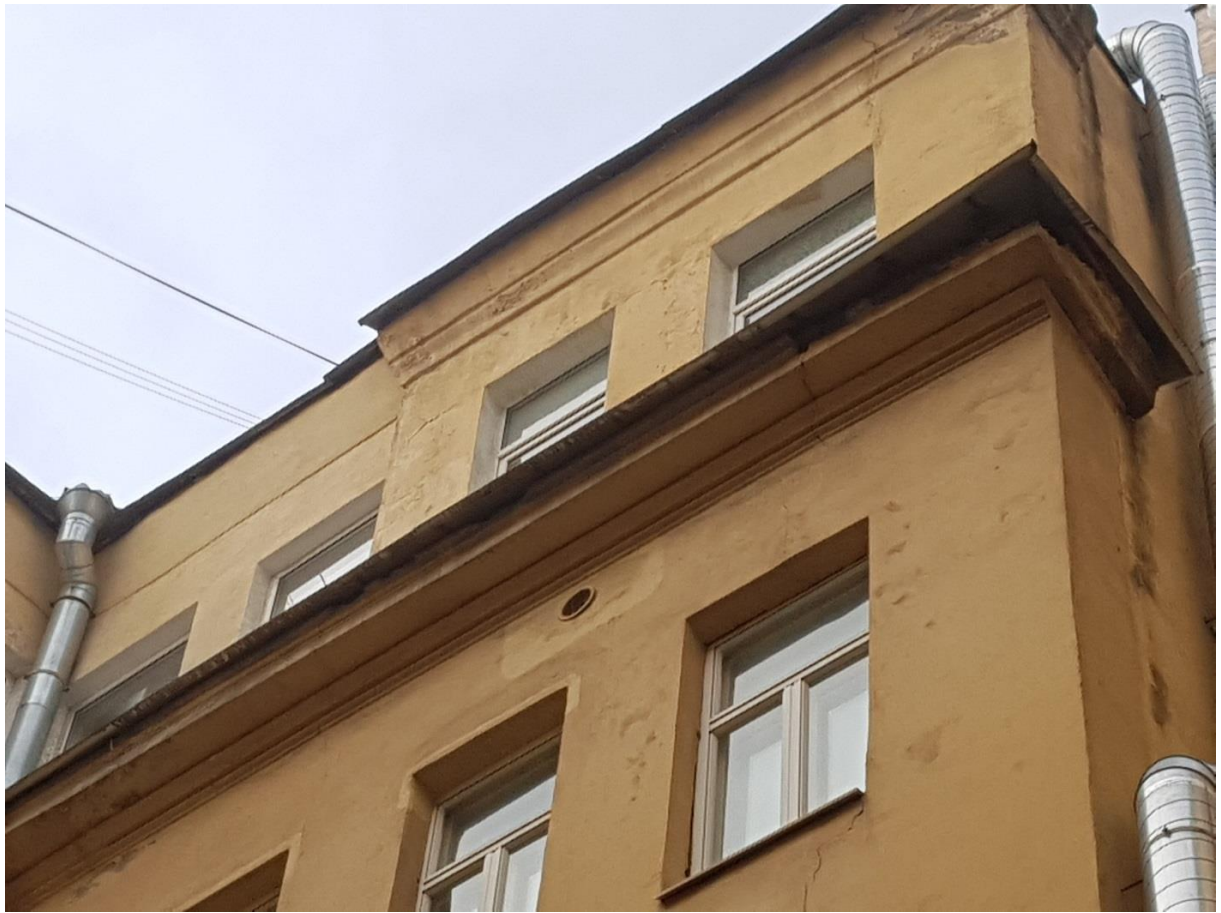
Фото 23. Карнизы. Дворовой северный фасад.
