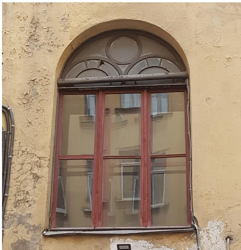
Фото 20. Расстекловка окон в уровне 2-го этажа.
