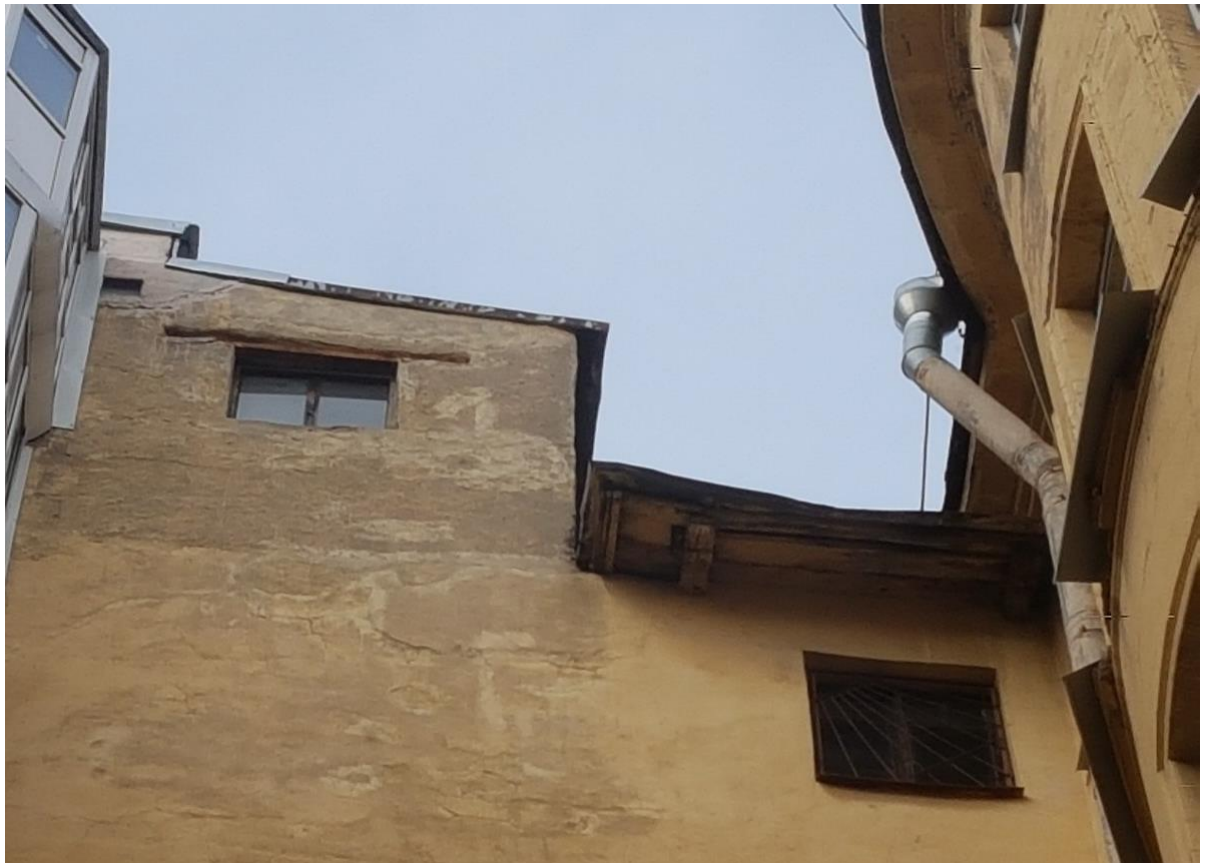
Фото 24. Карниз. Дворовой северный фасад.
