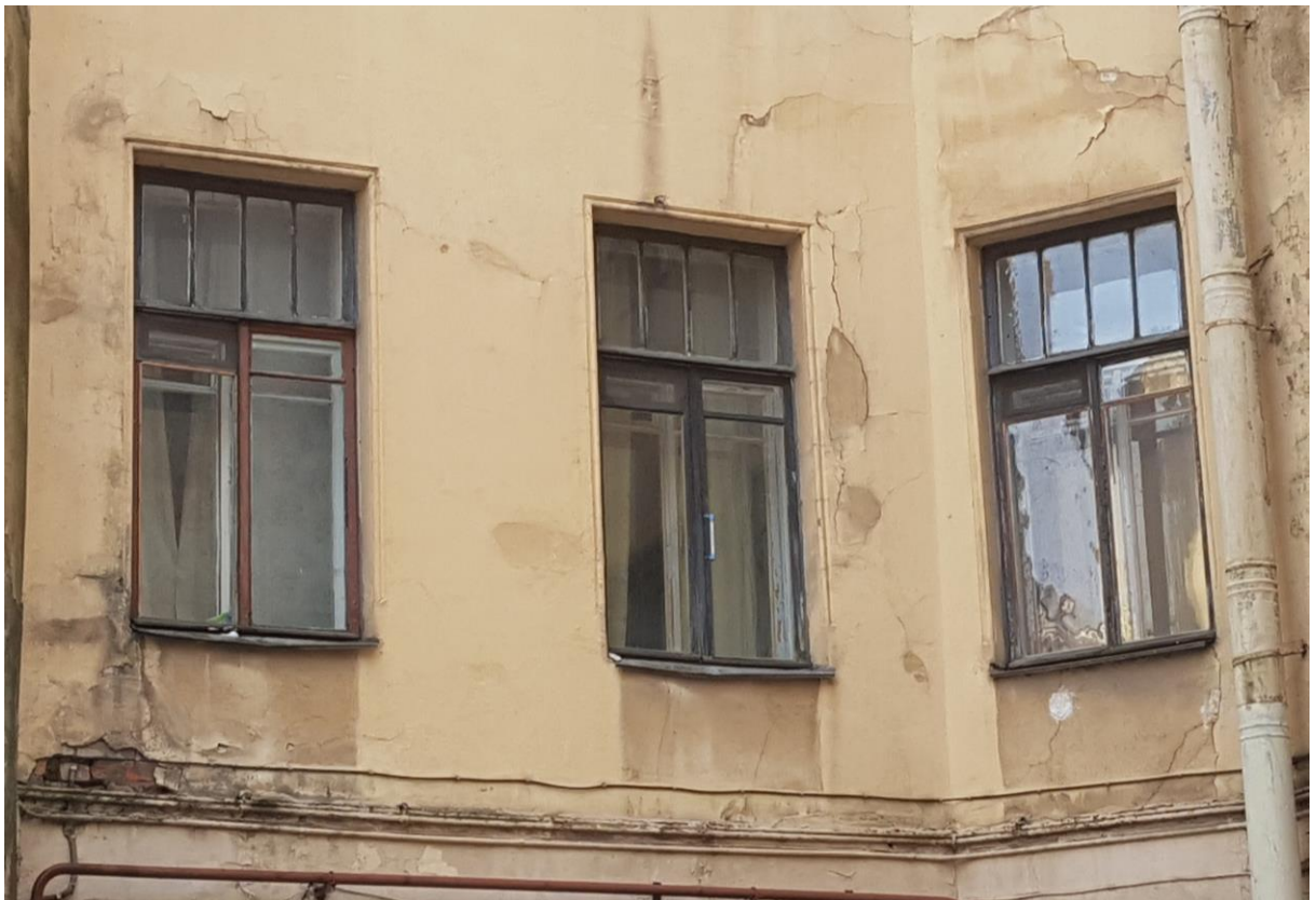
Фото 41. Оконные проемы в уровне 2-го этажа. Второй двор.
