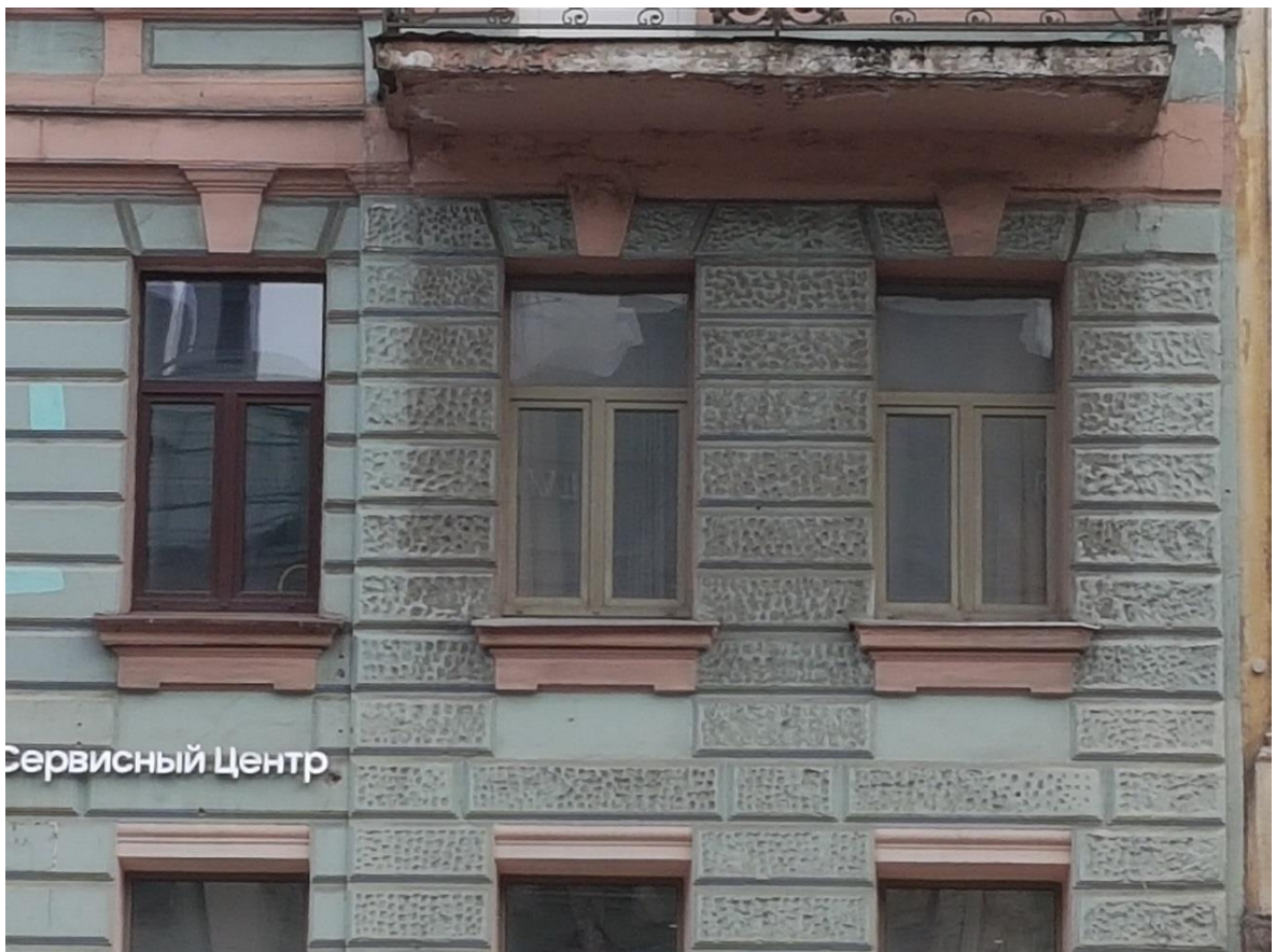
Фото 6. Оформление оконных проемов в уровне 3-го этажа
