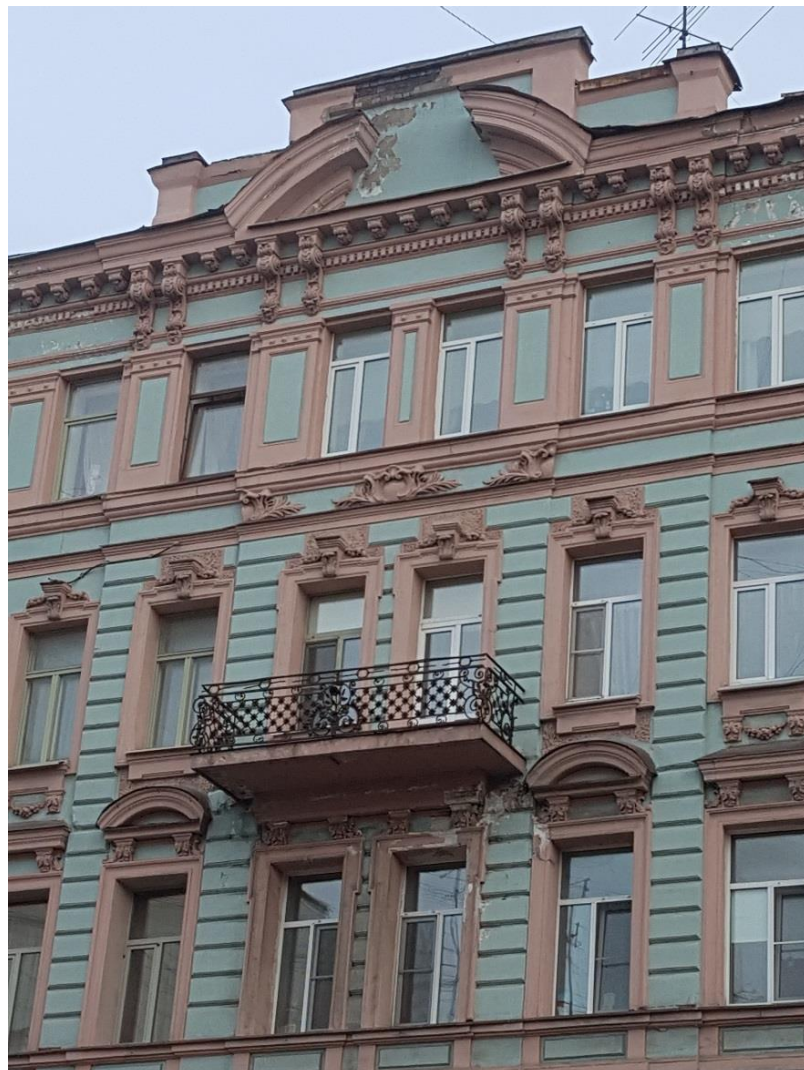
Фото 2. Аттик. Балкон в уровне 5-го этажа. Лицевой фасад.
