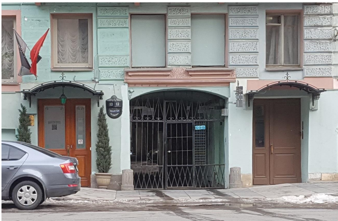
Фото 11. Дверные проемы и арочный проход в первый двор по центральной оси фасада.
