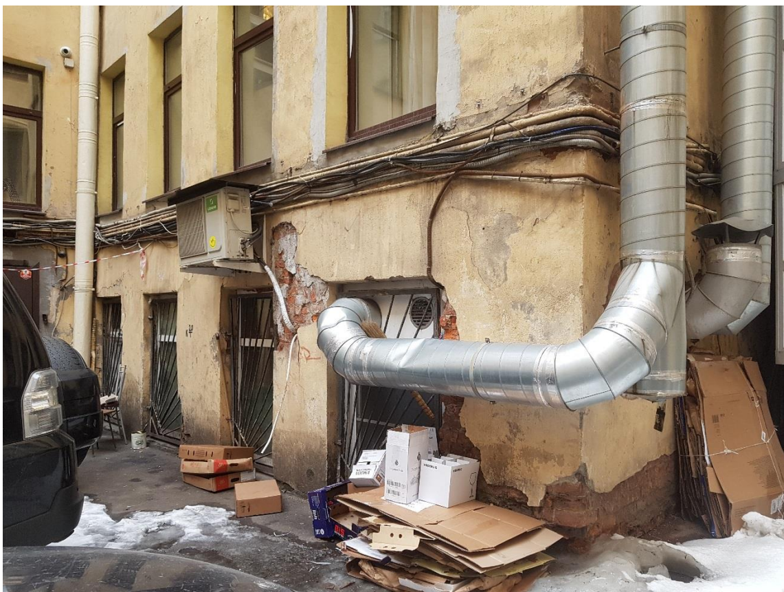
Фото 25. Уровень 1-го этажа. Дворовой северный фасад.
