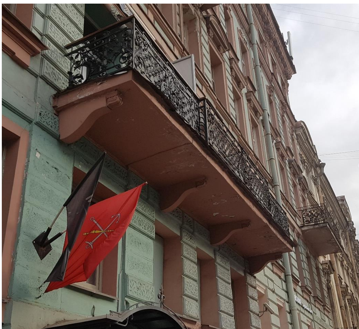
Фото 10. Балкон в уровне 3-го этажа по центральной оси фасада. Вид снизу.
