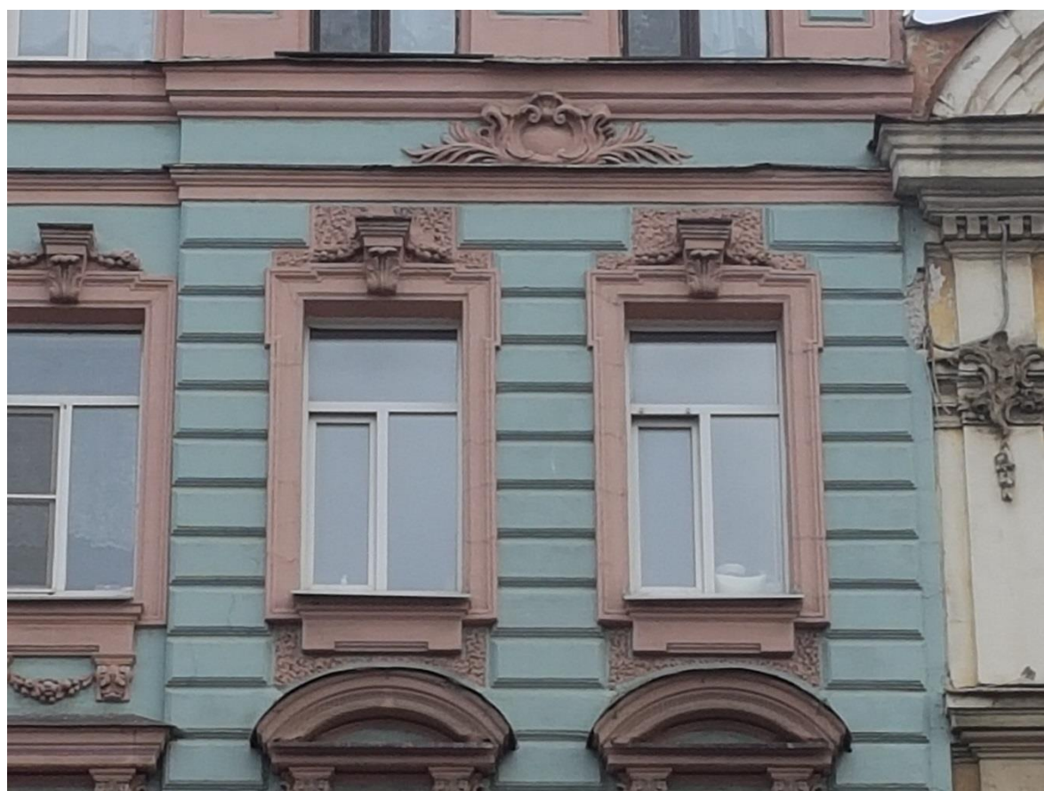
Фото 4. Оформление оконных проемов в уровне 5-го этажа.
