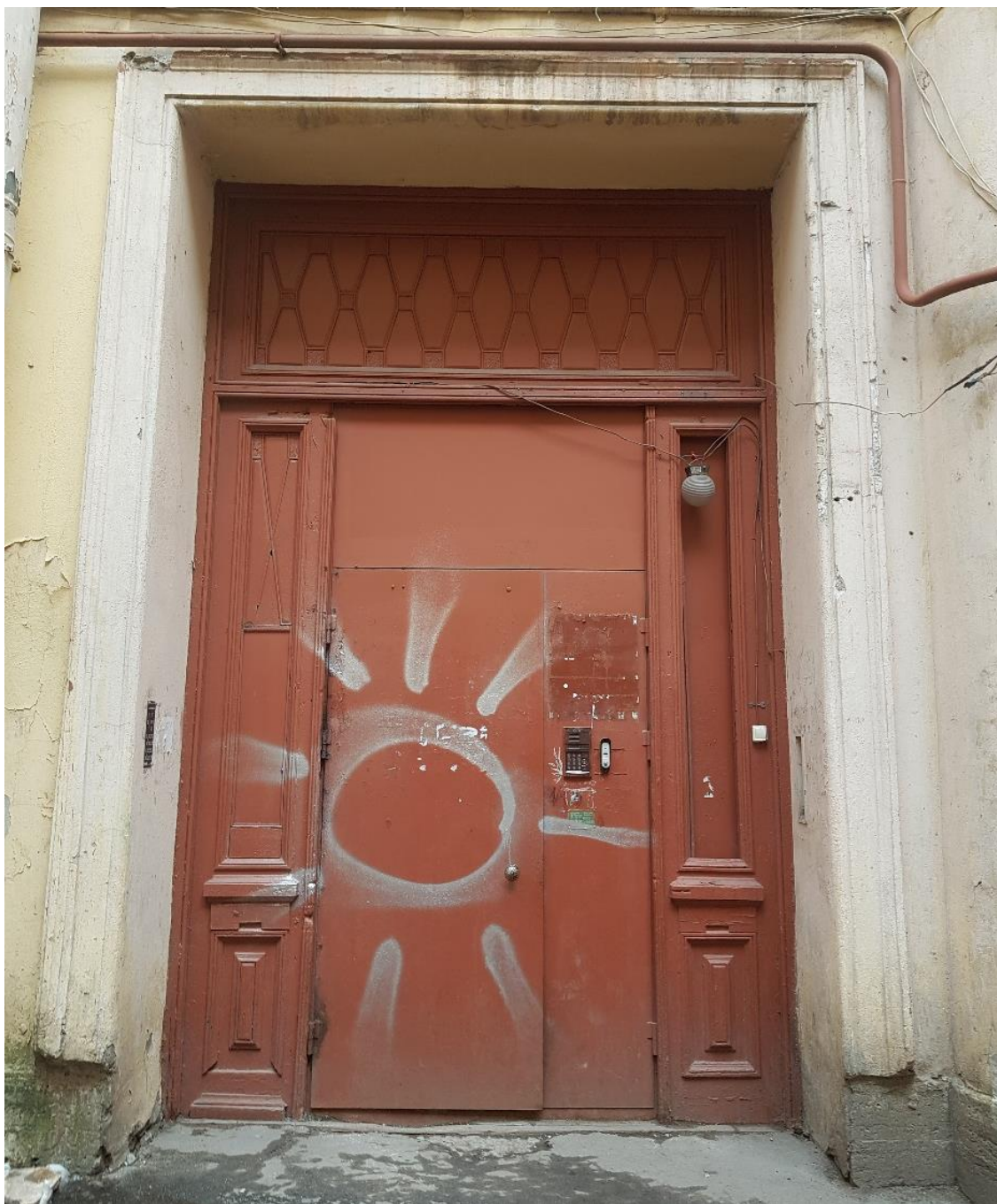
Фото 28. Дверной проем Л-3. Дворовой восточный фасад.
