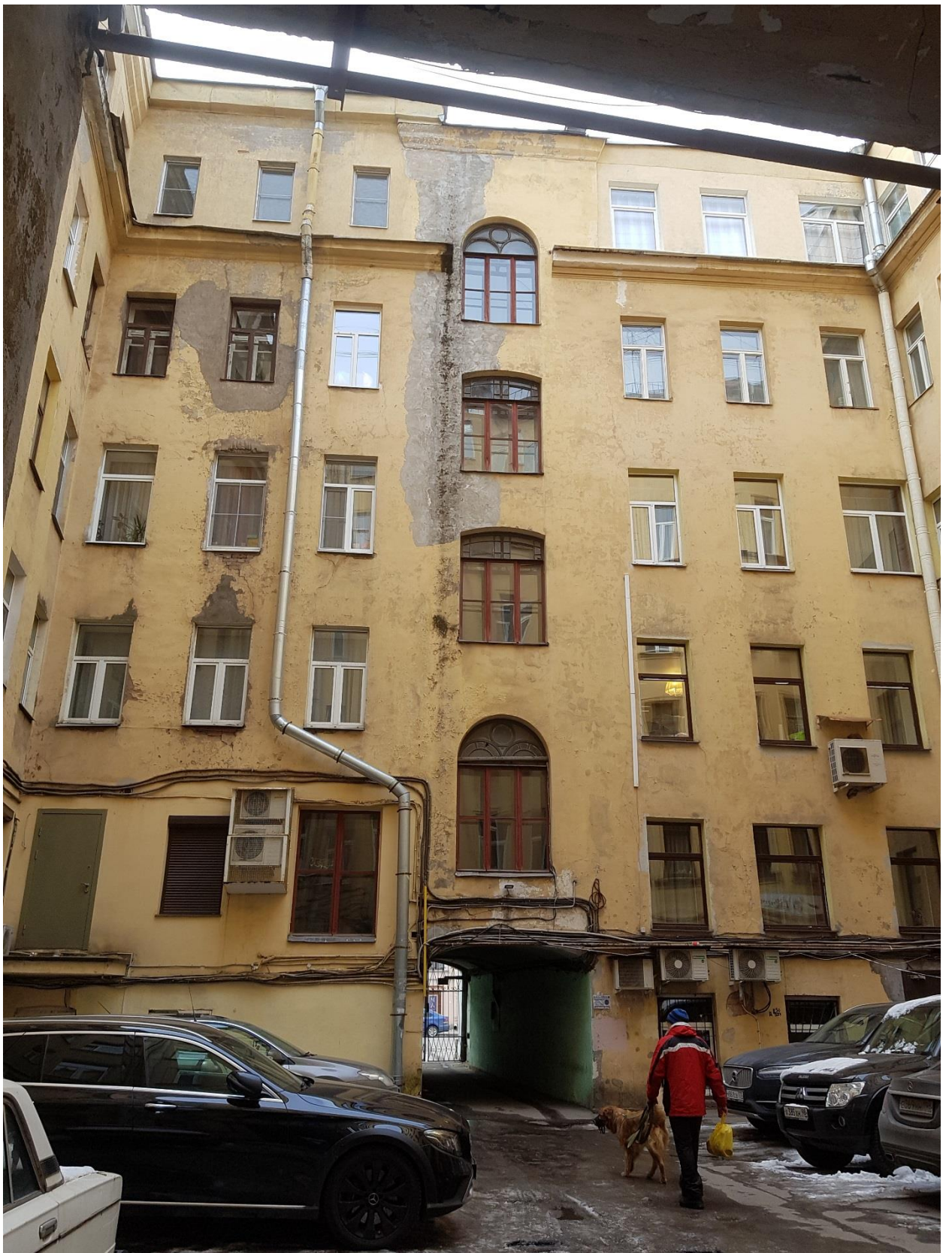
Фото 17. Дворовой фасад лицевого корпуса.
