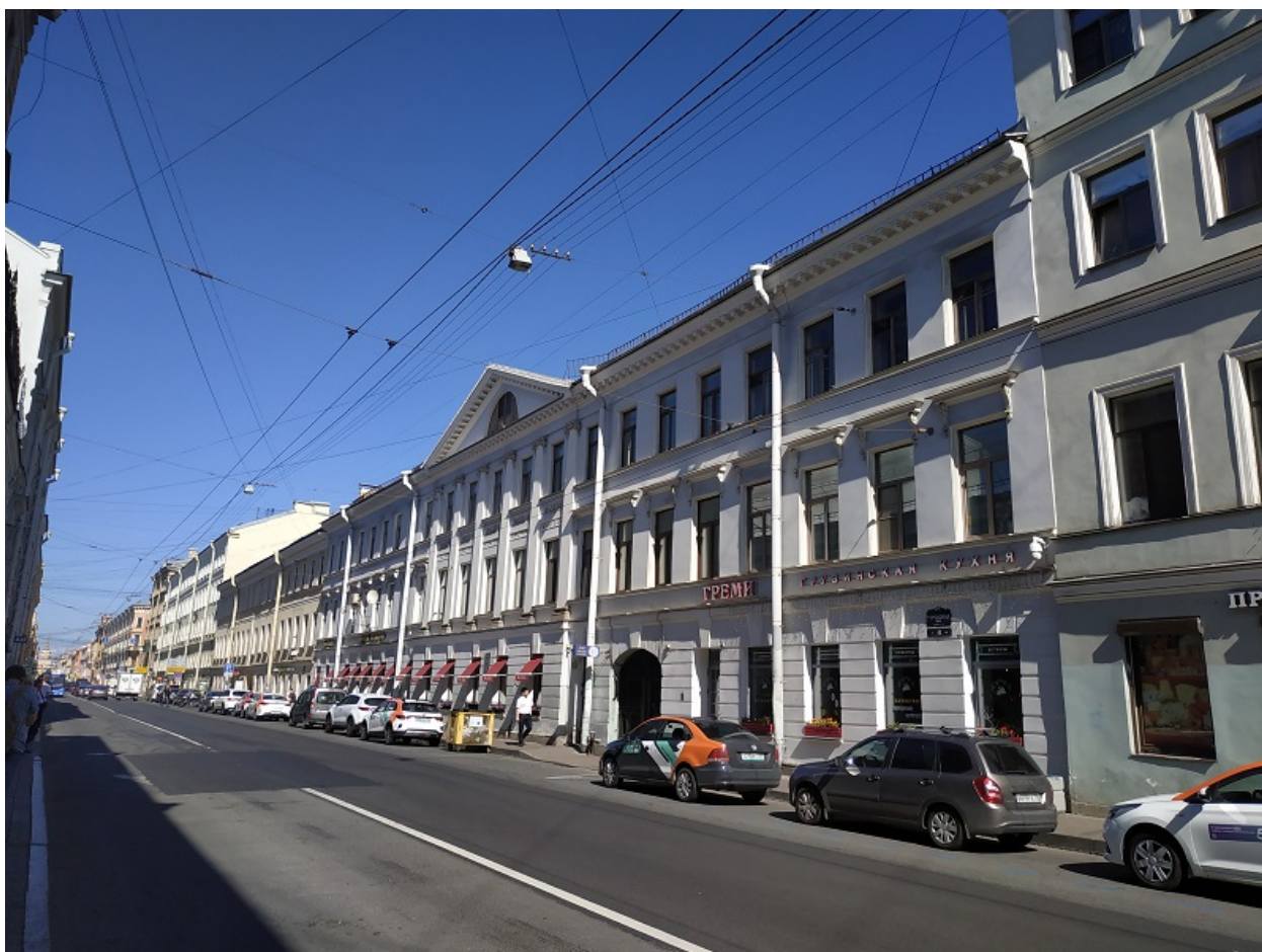
7. Вид здания по адресу: Санкт-Петербург, Гороховая ул., д. 40, Лит. А с Гороховой улицы в направлении к Садовой улицы.
