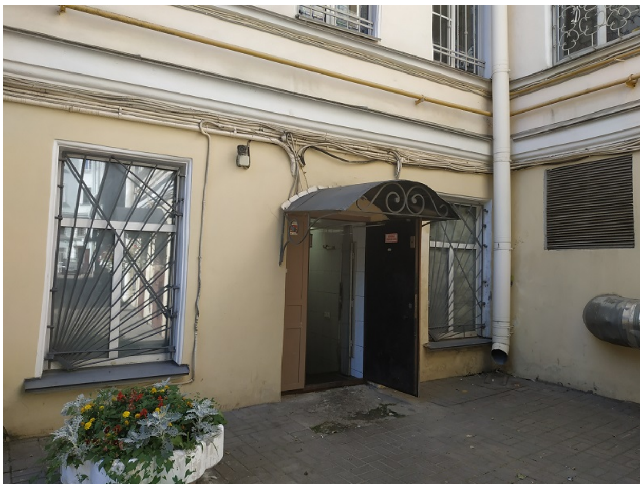
16. Вид фрагмента дворового фасада здания по адресу: Санкт-Петербург, Гороховая ул., д. 40, Лит. А в направлении восток –запад.
