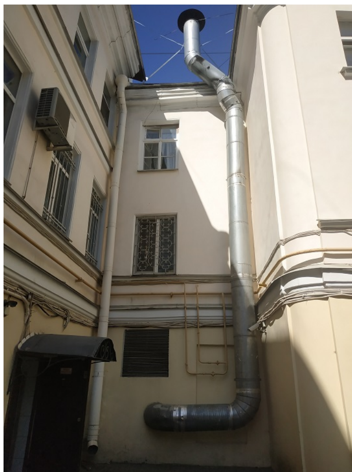
15. Вид фрагмента дворового фасада здания по адресу: Санкт-Петербург, Гороховая ул., д. 40, Лит. А в направлении юго-восток – северо-запад.
