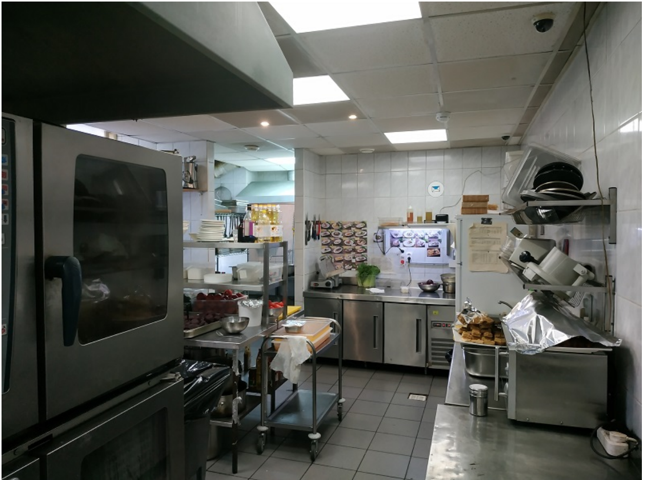
49. Вид интерьеров пом. 1-Н, находящегося на первом этаже в здании по адресу: Санкт-Петербург, Гороховая ул., д. 40, Лит. А.
