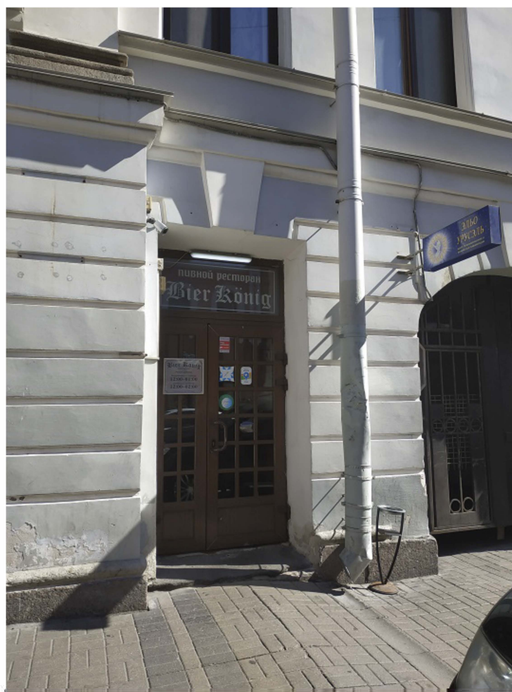
8. Вид входа в пом. 1-Н в здании по адресу: Санкт-Петербург, Гороховая ул., д. 40, Лит. А с Гороховой улицы.
