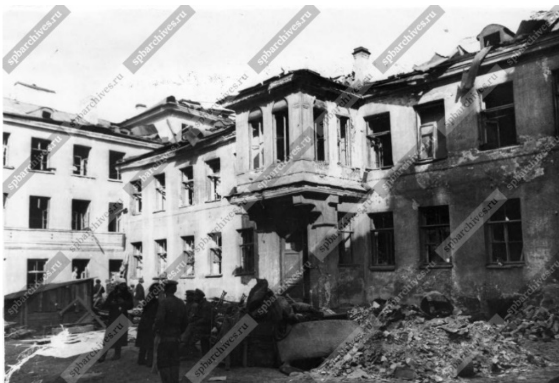
37. Разрушенный жилой дом №40 на улице Дзержинского. 28 сентября 1941 г. ЦГАКФФД СПб. Ар10340.
