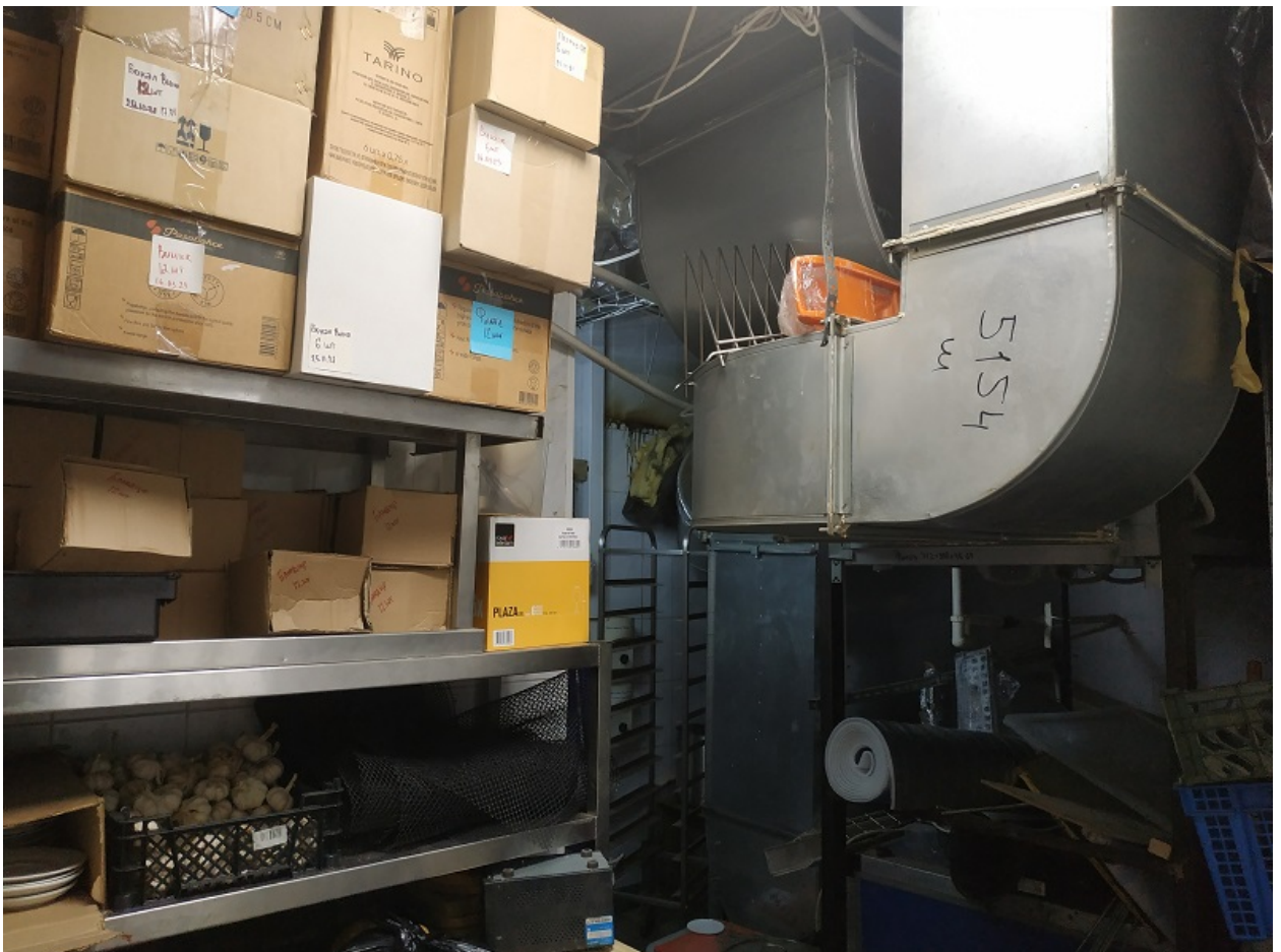
42. Вид интерьеров пом. 1-Н, находящегося на первом этаже в здании по адресу: Санкт-Петербург, Гороховая ул., д. 40, Лит. А.
