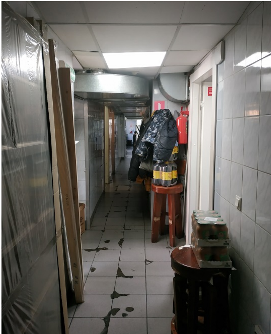
40. Вид интерьеров пом. 1-Н, находящегося на первом этаже в здании по адресу: Санкт-Петербург, Гороховая ул., д. 40, Лит. А.
