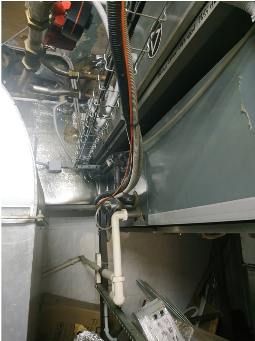
43. Вид интерьеров пом. 1-Н, находящегося на первом этаже в здании по адресу: Санкт-Петербург, Гороховая ул., д. 40, Лит. А.
