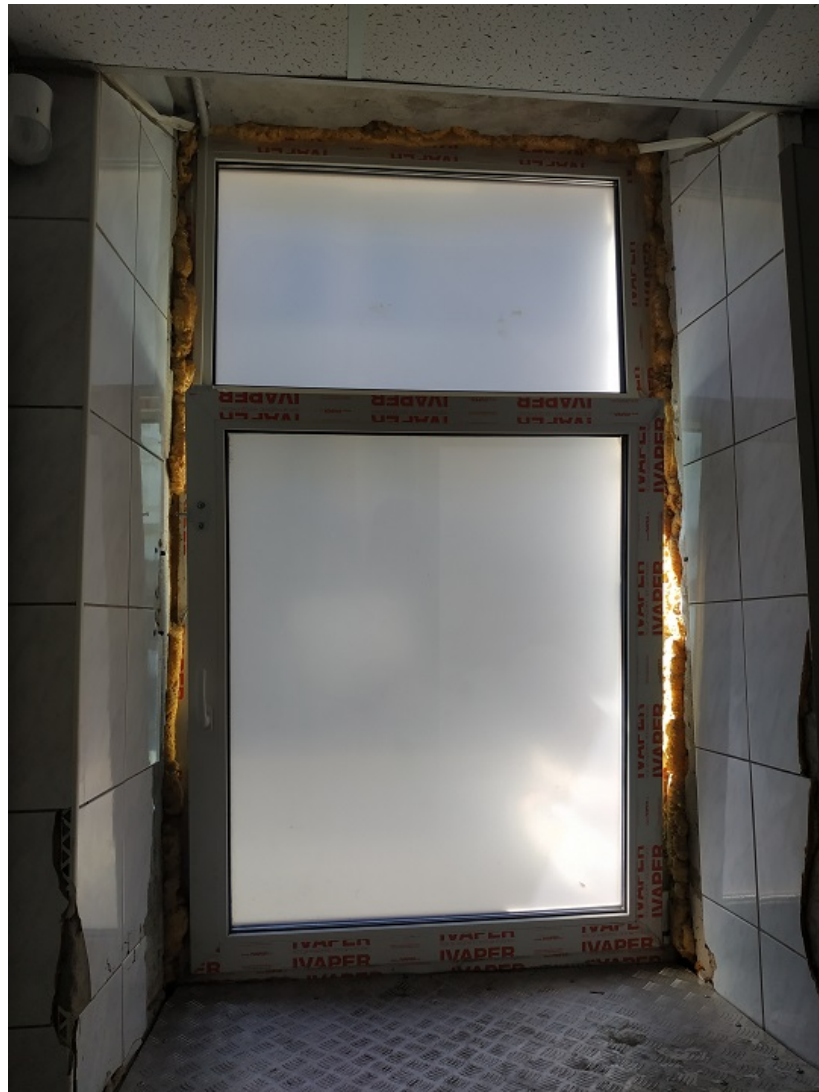
36. Вид интерьеров пом. 1-Н, находящегося на первом этаже в здании по адресу: Санкт-Петербург, Гороховая ул., д. 40, Лит. А.
