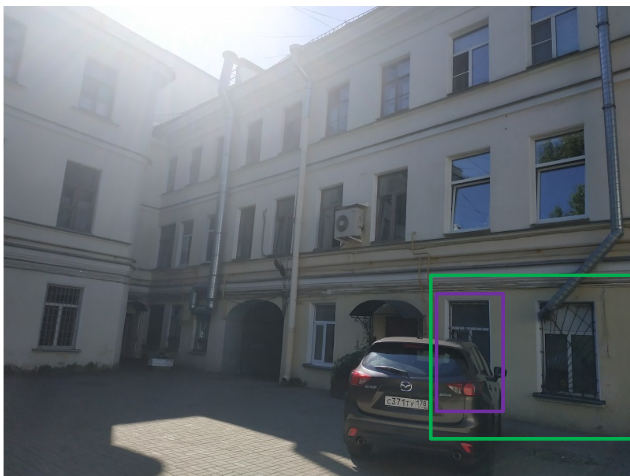
13. Вид фрагмента дворового фасада здания по адресу: Санкт-Петербург, Гороховая ул., д. 40, Лит. А в направлении север – юг.
