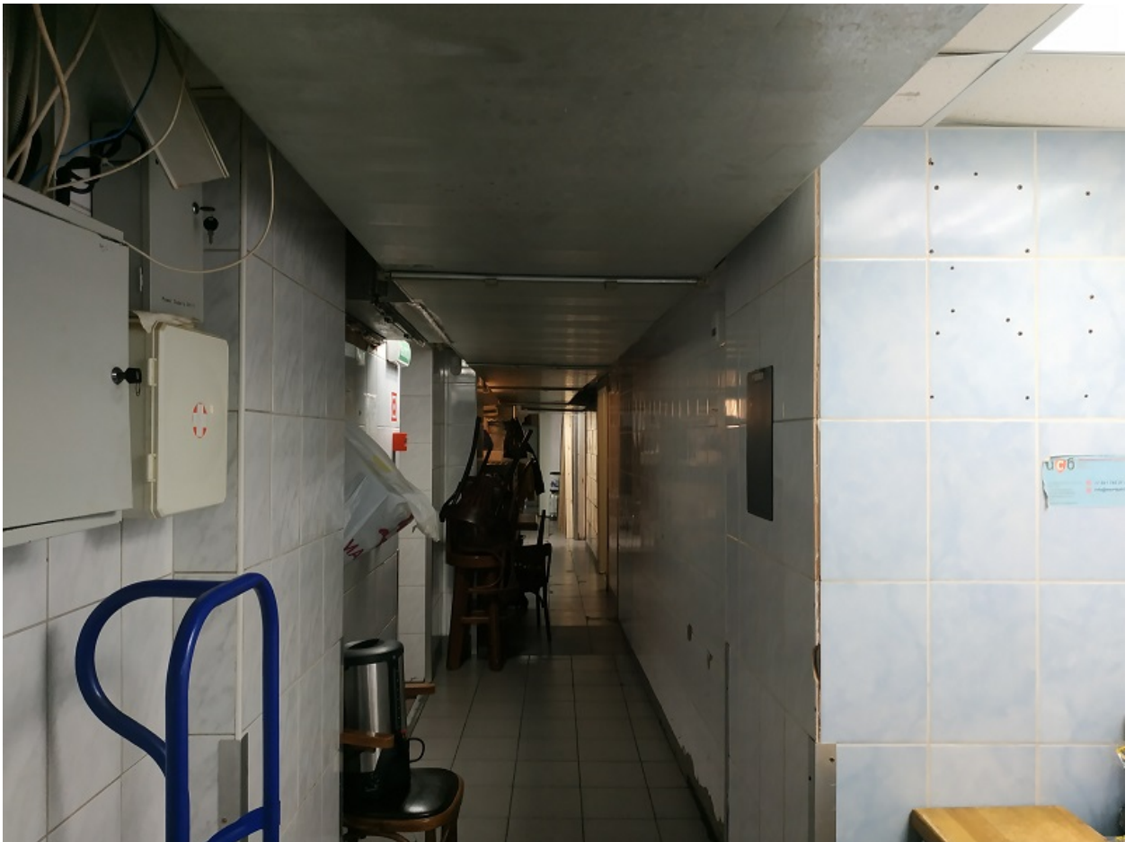
32. Вид интерьеров пом. 1-Н, находящегося на первом этаже в здании по адресу: Санкт-Петербург, Гороховая ул., д. 40, Лит. А.
