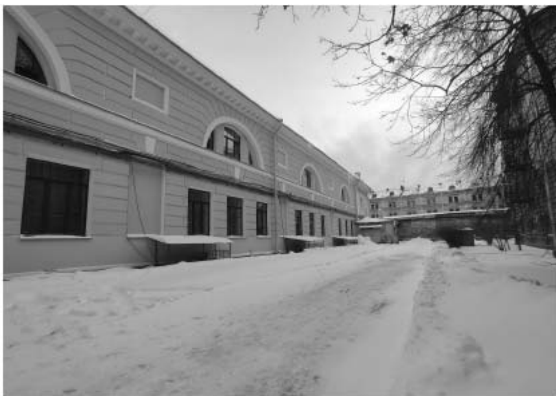
10. Объект культурного наследия федерального значения «Банк», расположенный по адресу: г. Санкт-Петербург, наб. кан. Грибоедова, д. 30-32, лит. А, входящий в состав объекта культурного наследия федерального значения «Банк Ассигнационный». Фрагмент юго-западного фасада юго-западного флигеля по Саловой ул.
