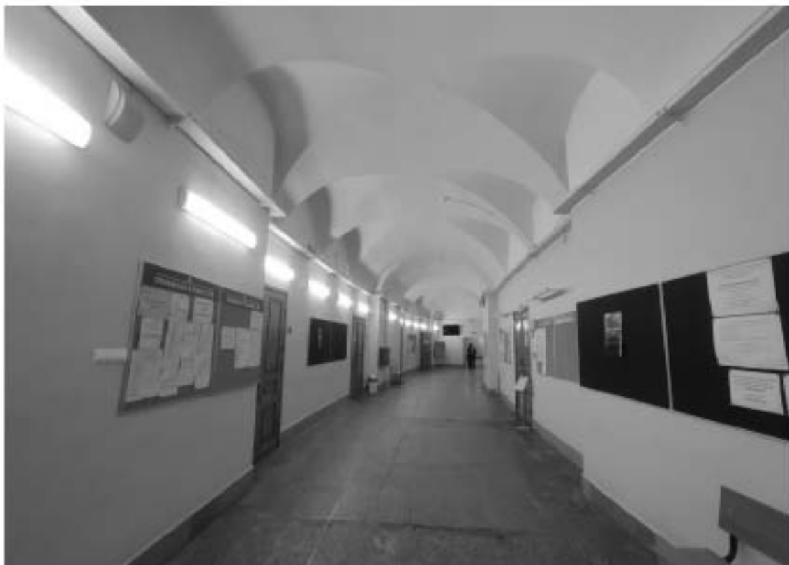
22. Объект культурного наследия федерального значения «Банк», расположенный по адресу: г. Санкт-Петербург, наб. кан. Грибоедова, д. 30-32, лит. А, входящий в состав объекта культурного наследия федерального значения «Банк Ассигнационный». Общий вид пом. 6-Н (48) в уровне 1-го этажа.
