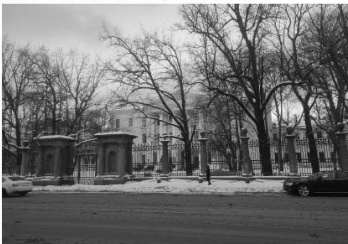
2. Объект культурного наследия федерального значения «Банк», расположенный по адресу: г. Санкт-Петербург, наб. кан. Грибоедова, д. 30-32, лит. А, входящий в состав объекта культурного наследия федерального значения «Банк Ассигнационный». Общий вид юго-восточного лицевого фасада центрального корпуса по Садовой ул.
