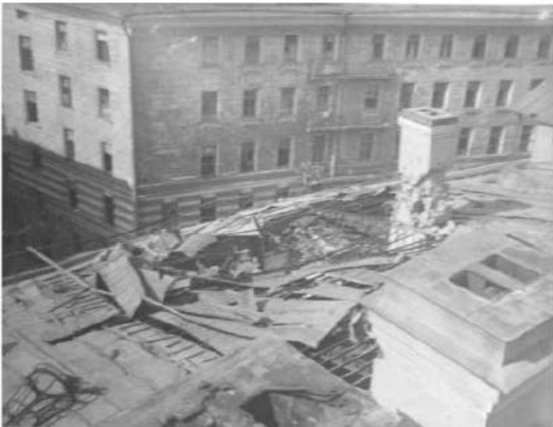
25. Разрушение крыши полуциркульной части памятника. Октябрь 1943 г. Следы разрушений. Акт обследования здания б. Госбанка. Ленинград. Архив КТИОП.
