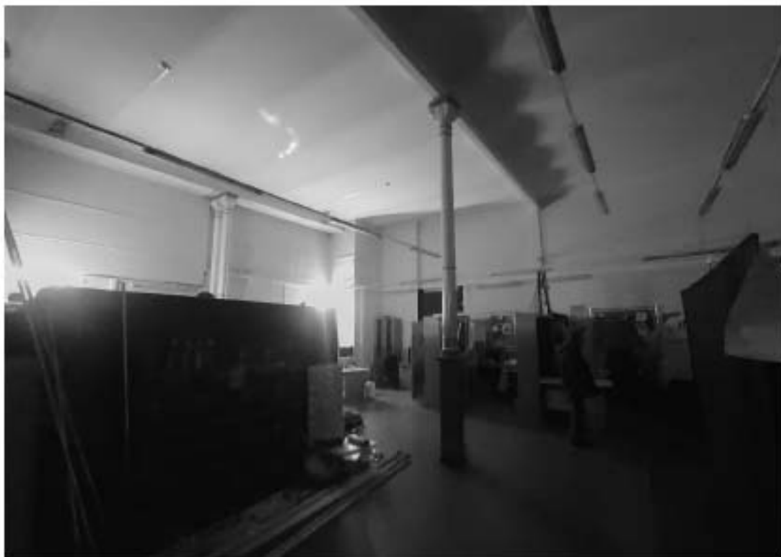
42. Объект культурного наследия федерального значения «Банк», расположенный по адресу: г. Санкт-Петербург, наб. кан. Грибоедова, д. 30-32, лит. А, входящий в состав объекта культурного наследия федерального значения «Банк Ассигнационный». Общий вид пом. 60-Н (7) в уровне 1-го этажа.
