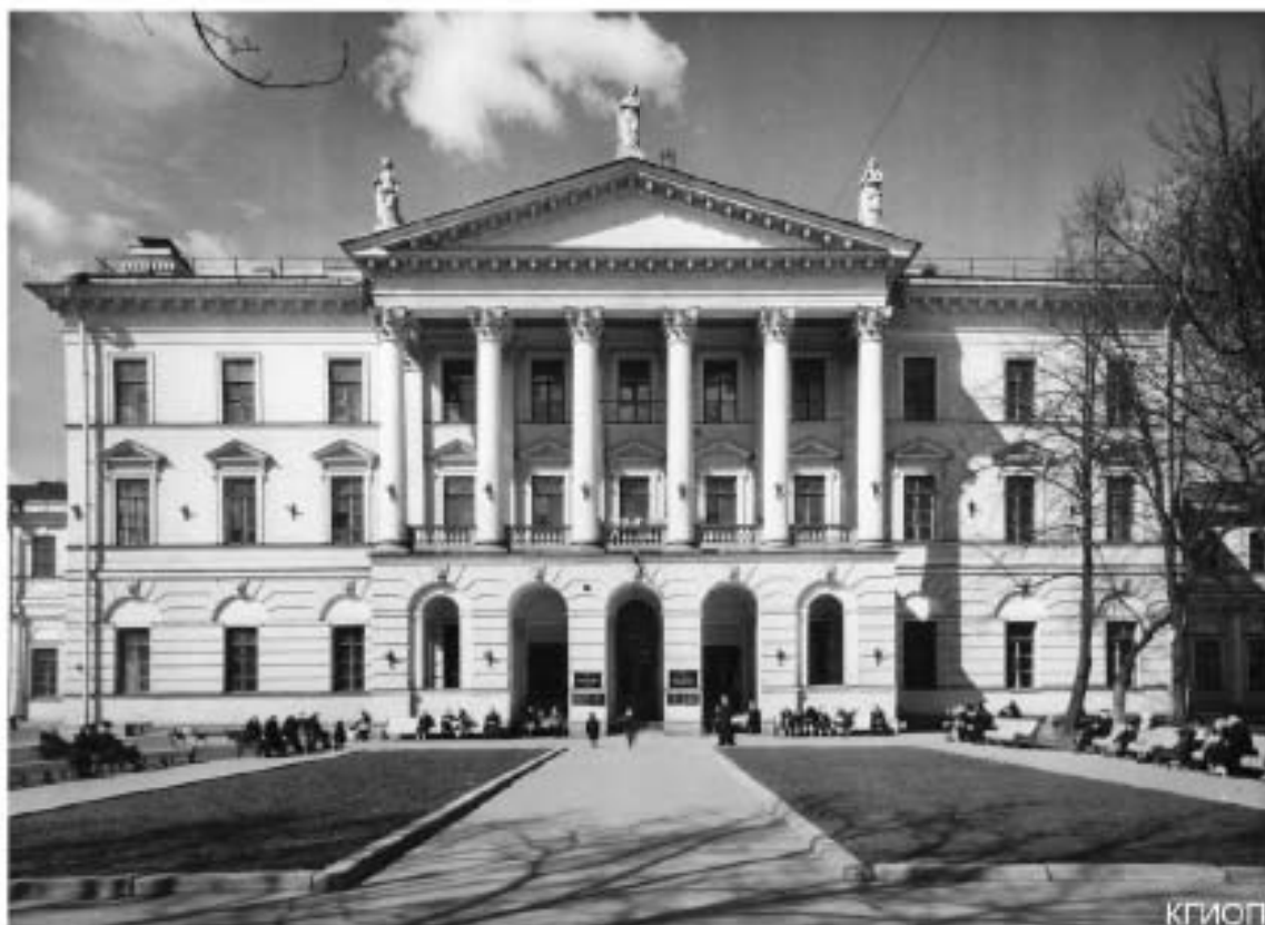
26. Главный фасад. Ленинградский финансово-экономический институт (здание Ассигнационного банка). Григорьев А.А. 1953 г. Архив КГИОП.
