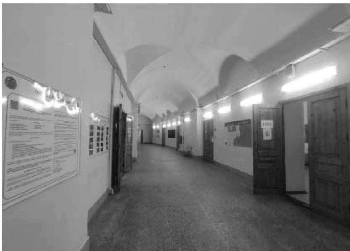
23. Объект культурного наследия федерального значения «Банк», расположенный по адресу: г. Санкт-Петербург, наб. кан. Грибоедова, д. 30-32, лит. А, входящий в состав объекта культурного наследия федерального значения «Банк Ассигнационный». Общий вид пом. 6-Н (48) в уровне 1-го этажа.
