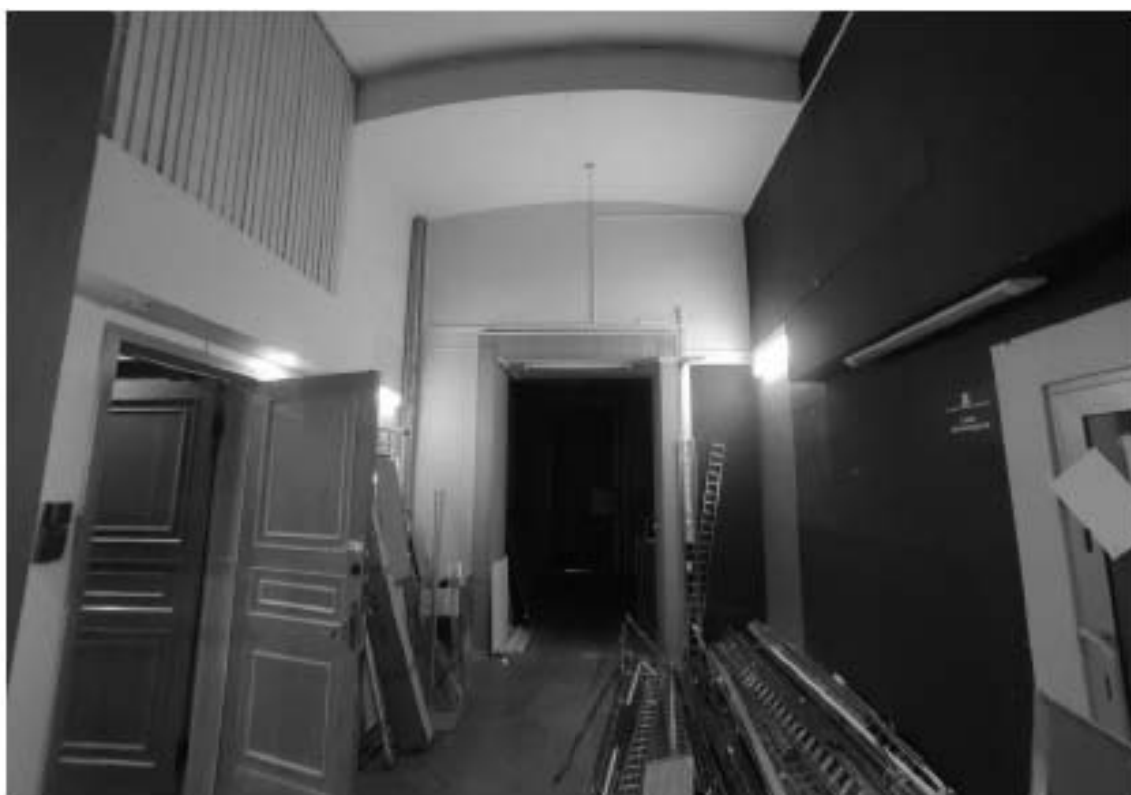
37. Объект культурного наследия федерального значения «Банк», расположенный по адресу: г. Санкт-Петербург, наб. кан. Грибоедова, д. 30-32, лит. А, входящий в состав объекта культурного наследия федерального значения «Банк Ассигнационный». Общий вид пом. 60-Н (14) в уровне 1-го этажа.
