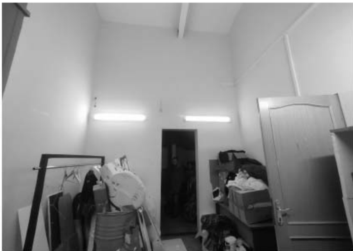
44. Объект культурного наследия федерального значения «Банк», расположенный по адресу: г. Санкт-Петербург, наб. кан. Грибоедова, д. 30-32, лит. А, входящий в состав объекта культурного наследия федерального значения «Банк Ассигнационный». Общий вид пом. 60-Н (9) в уровне 1-го этажа.
