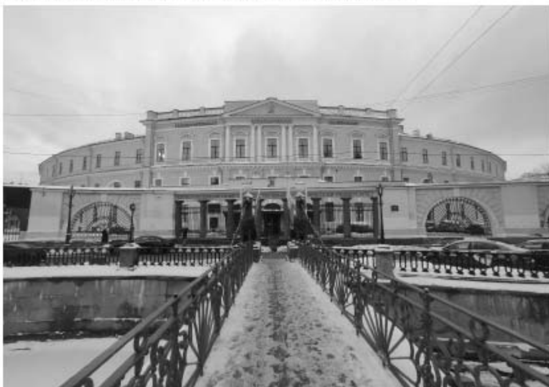
4. Объект культурного наследия федерального значения «Банк», расположенный по адресу: г. Санкт-Петербург, наб. кан. Грибоедова, д. 30-32, лит. А, входящий в состав объекта культурного наследия федерального значения «Банк Ассигнационный». Общий вид северо-западного лицевого фасада по наб. канала Грибоедова.
