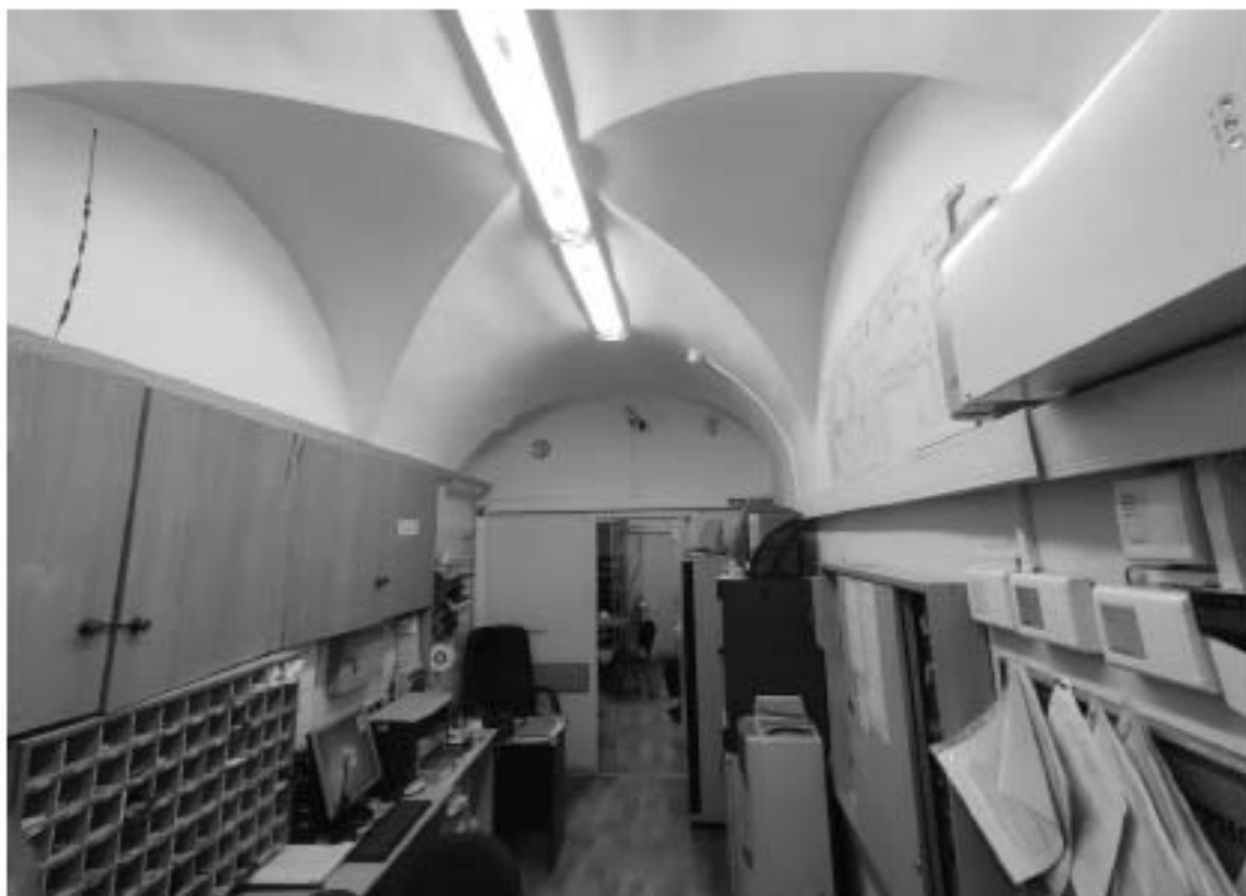
14. Объект культурного наследия федерального значения «Банк», расположенный по адресу: г. Санкт-Петербург, наб. кан. Грибоедова, д. 30-32, лит. А, входящий в состав объекта культурного наследия федерального значения «Банк Ассигнационный». Общий вид пом. 6-Н (114) в уровне 1-го этажа.
