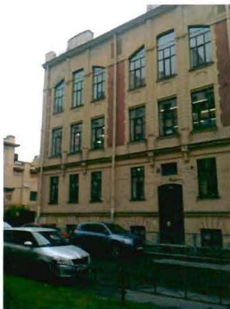
5. Фрагмент северного фасада.
