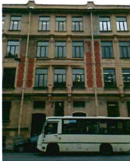
2. Фрагмент западного фасада.
