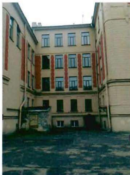
6. Фрагмент дворового (восточного) фасада.
