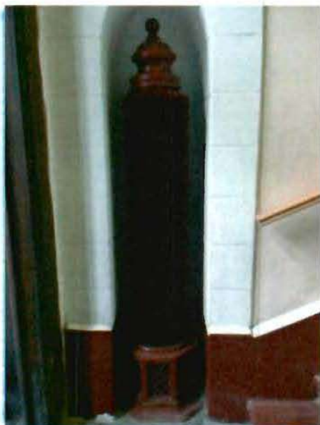
11. Внутренняя планировочная структура. Калорифер в нише вестибюля главного входа.
