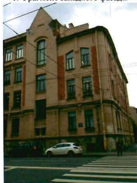
3. Фрагмент западного фасада.
