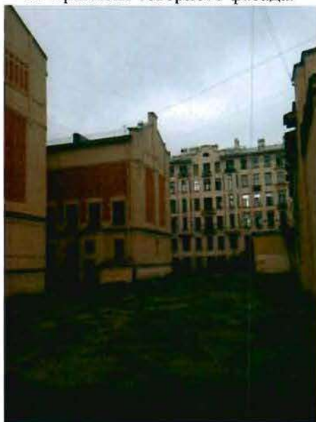
7. Фрагмент дворового (восточного) фасада.
