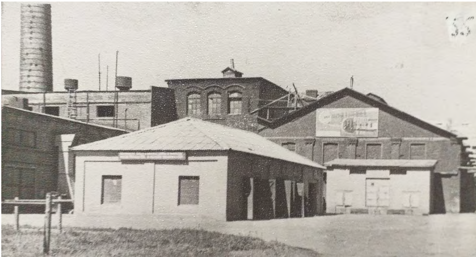
37. Вид фасада здания красочного отделения Ультрамаринового цеха. 1967 г. ЦГАКФФД СПб, Ар 85262.
