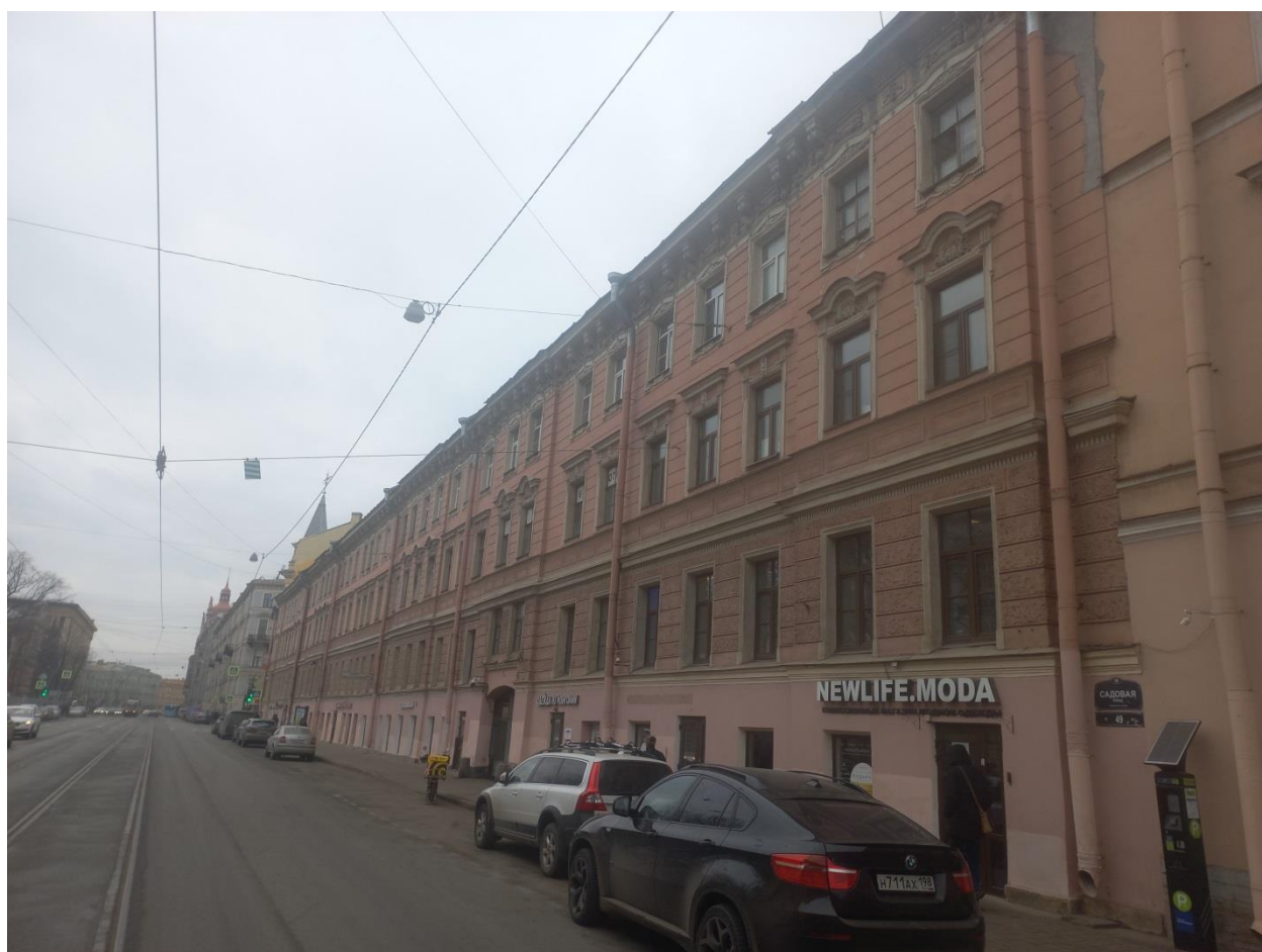
Фото 3. Лицевой фасад по ул. Садовая. Общий вид.
