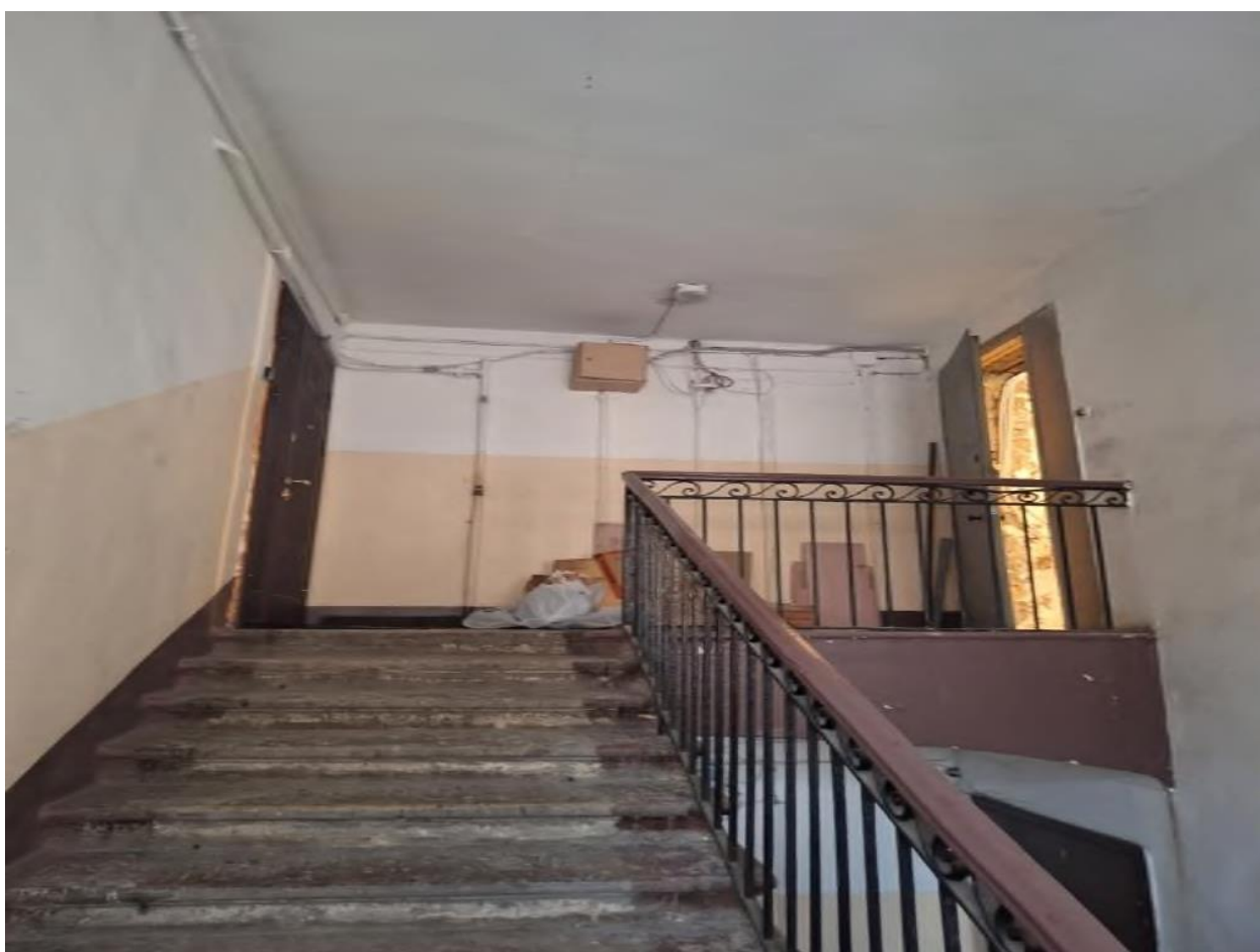
Фото 7. Лестничная клетка. Вход в кв. №25.
