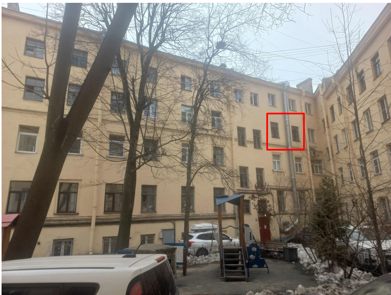
Фото 6. Внутренний двор. Вход на лестничную клетку, где расположена квартира №25. Оконные проемы квартиры, ориентированные во двор.
