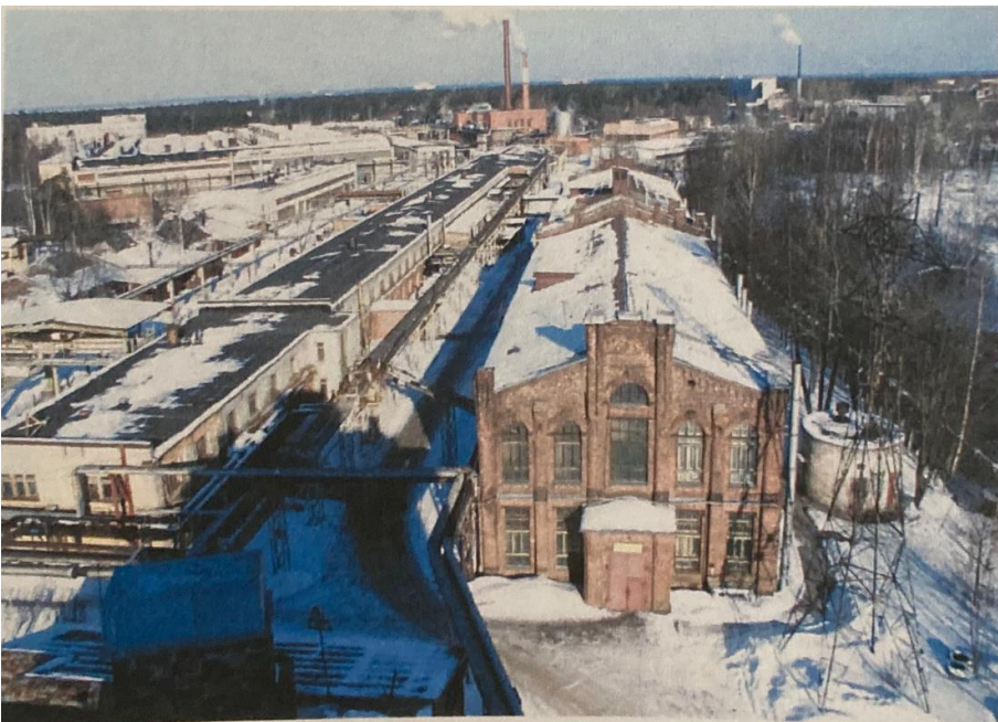
26. Вид с водонапорной башни на север. Фото 2004 г. Сектор хранения документированной информации Управления организационного обеспечения и контроля КГИОП.
