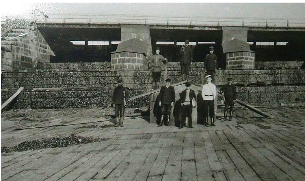
18. Работы по ремонту водосливной плотины Гаусмана. Фото нач. XX в. Источник - https://pastvu.com/p/209196 .
