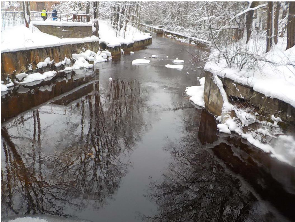
12. «Соляной канал», в составе объекта культурного наследия регионального значения «Ансамбль Сестрорецкого оружейного завода», г. Санкт-Петербург, г. Сестрорецк, ул. Воскова, д. 2, лит. А, сооружение 3. Фрагмент канала. Фото 01.02.2024г.
