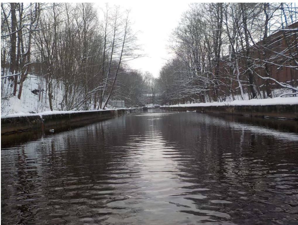
2. «Соляной канал», в составе объекта культурного наследия регионального значения «Ансамбль Сестрорецкого оружейного завода», г. Санкт-Петербург, г. Сестрорецк, ул. Воскова, д. 2, лит. А, сооружение 3. Общий вид канала. Фото 01.02.2024г.
