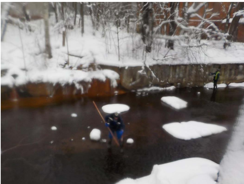
13. «Соляной канал», в составе объекта культурного наследия регионального значения «Ансамбль Сестрорецкого оружейного завода», г. Санкт-Петербург, г. Сестрорецк, ул. Воскова, д. 2, лит. А, сооружение 3. Фрагмент канала. Фото 01.02.2024г.
