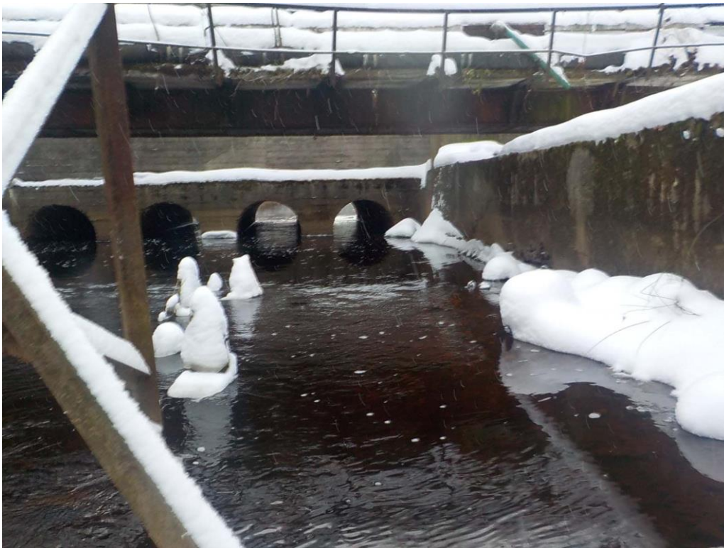
5. «Соляной канал», в составе объекта культурного наследия регионального значения «Ансамбль Сестрорецкого оружейного завода», г. Санкт-Петербург, г. Сестрорецк, ул. Воскова, д. 2, лит. А, сооружение 3. Фрагмент канала. Фото 01.02.2024г.
