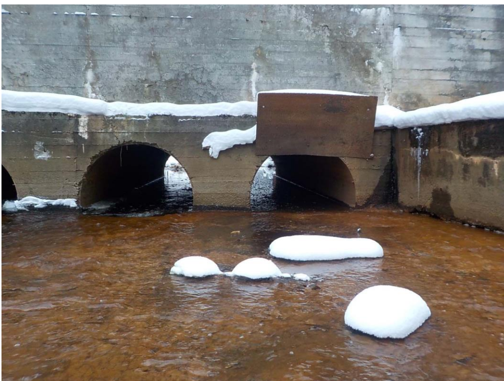
4. «Соляной канал», в составе объекта культурного наследия регионального значения «Ансамбль Сестрорецкого оружейного завода», г. Санкт-Петербург, г. Сестрорецк, ул. Воскова, д. 2, лит. А, сооружение 3. Фрагмент канала. Фото 01.02.2024г.
