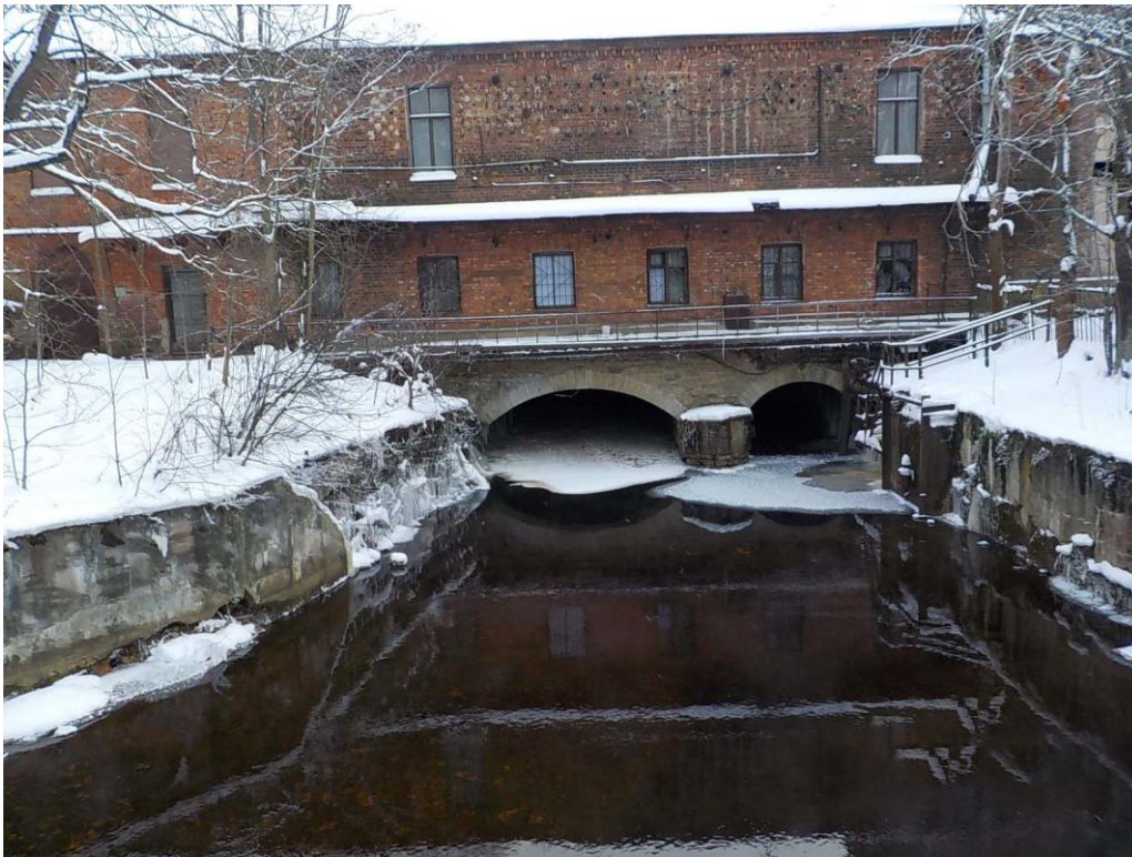
11. «Соляной канал», в составе объекта культурного наследия регионального значения «Ансамбль Сестрорецкого оружейного завода», г. Санкт-Петербург, г. Сестрорецк, ул. Воскова, д. 2, лит. А, сооружение 3. Фрагмент канала. Фото 01.02.2024г.
