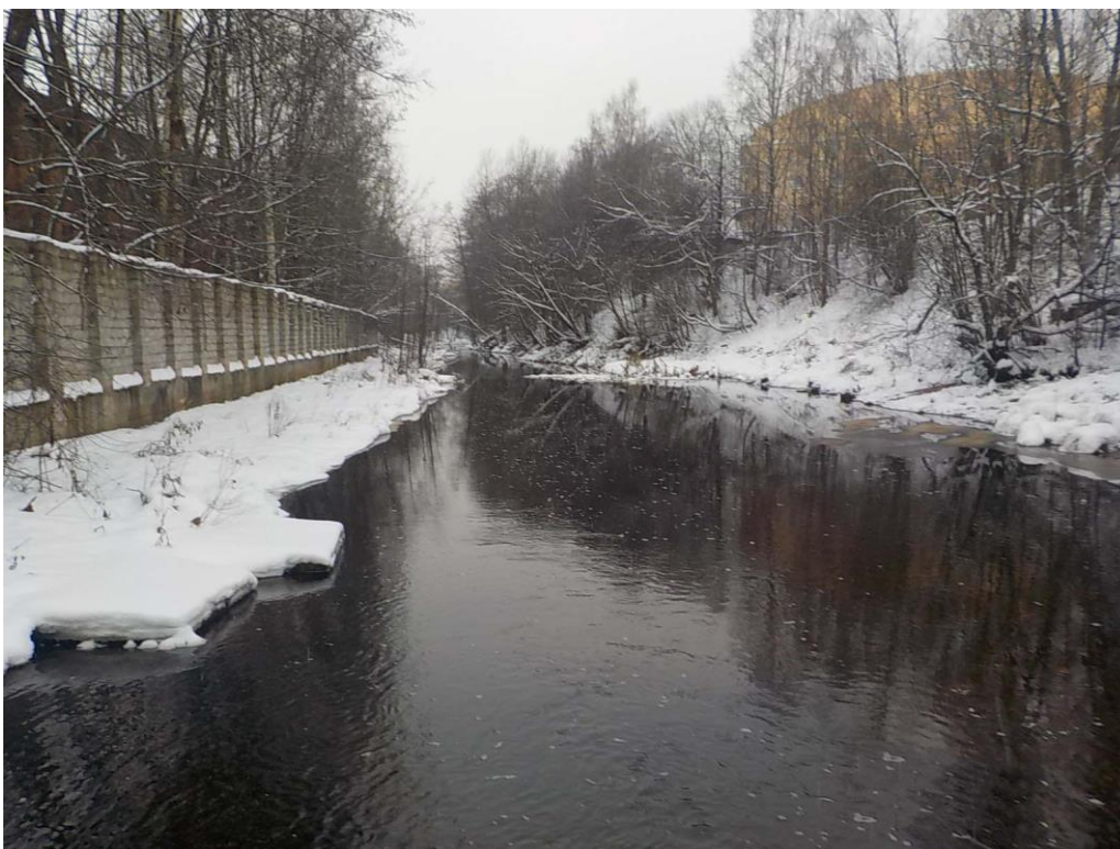
1. «Соляной канал», в составе объекта культурного наследия регионального значения «Ансамбль Сестрорецкого оружейного завода», г. Санкт-Петербург, г. Сестрорецк, ул. Воскова, д. 2, лит. А, сооружение 3. Общий вид канала. Фото 01.02.2024г.
