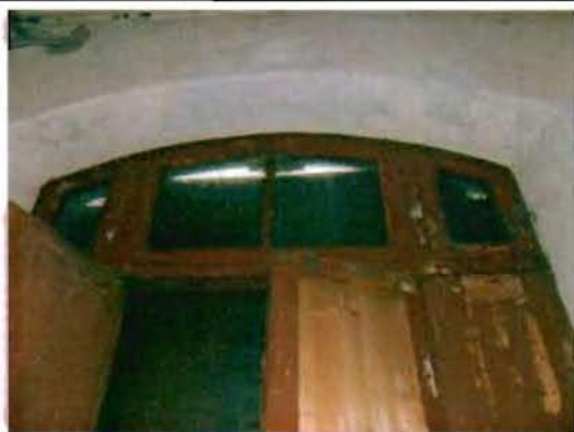
Фото 126. Дверное заполнение центральной части лестницы. Фрагмент.
