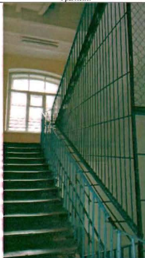
Фото 61. Интерьер. Лестница в южной части здания. Фрагмент.
