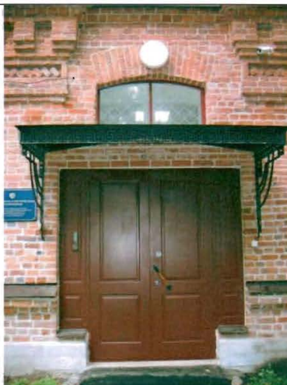
Фото 41. Дверной проем восточного фасада. Общий вид.
