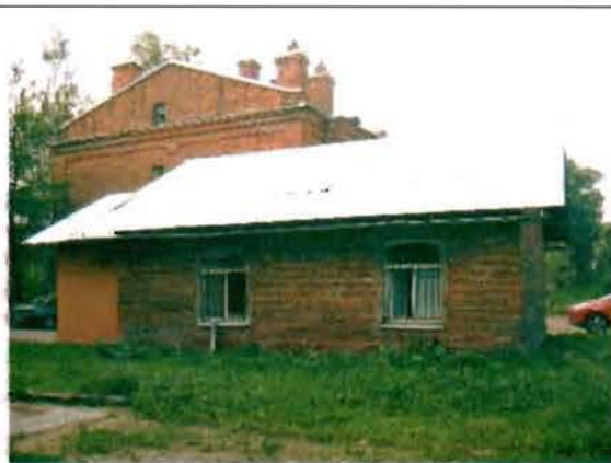
Фото 156. Западный фасад. Общий вид.
