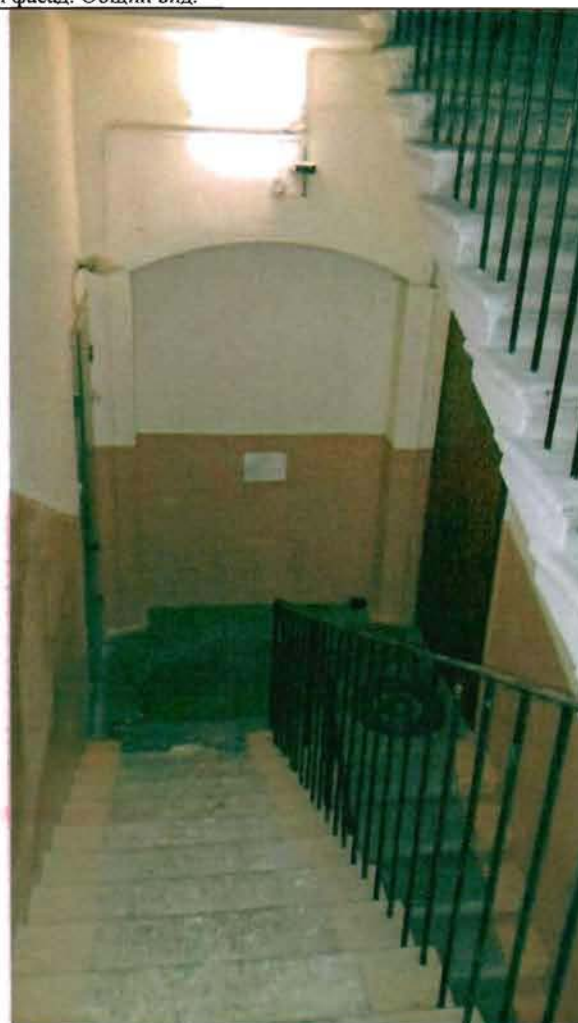
Фото 173. Лестница № 1 в северной части здания. Фрагмент.
