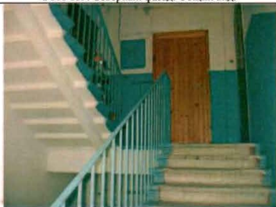
Фото 161. Лестница № 1 в южной части здания. Фрагмент.
