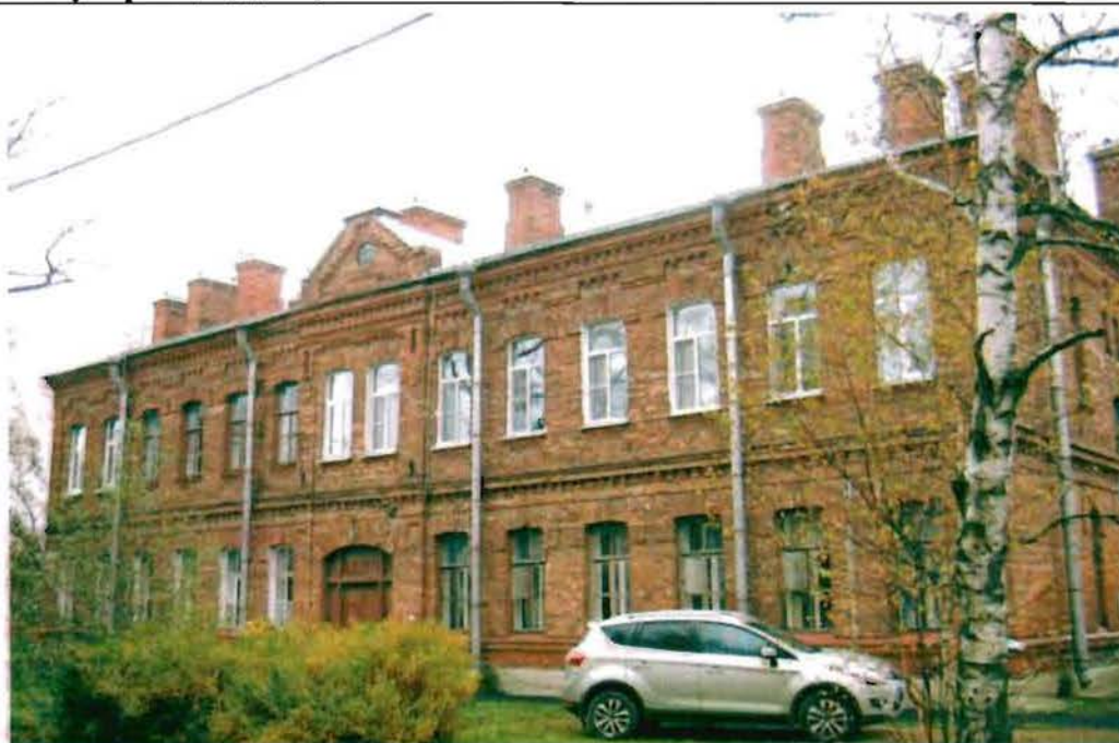
Фото 128. Восточный фасад. Общий вид.
