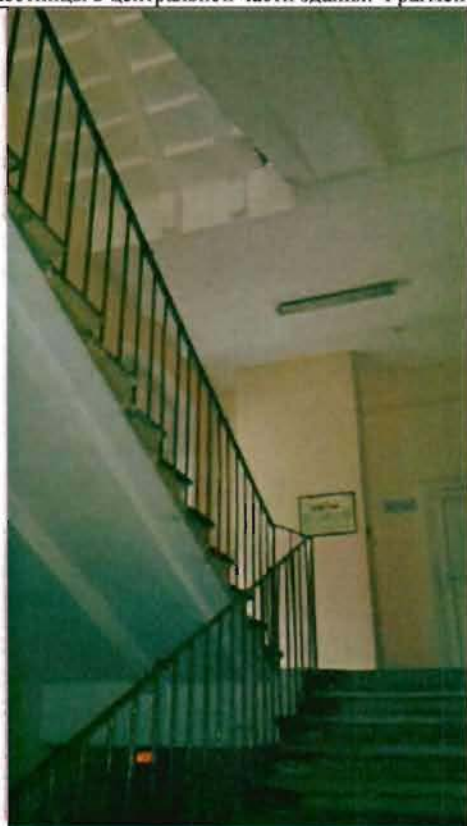
Фото 60. Интерьер. Лестница в южной части здания. Фрагмент.
