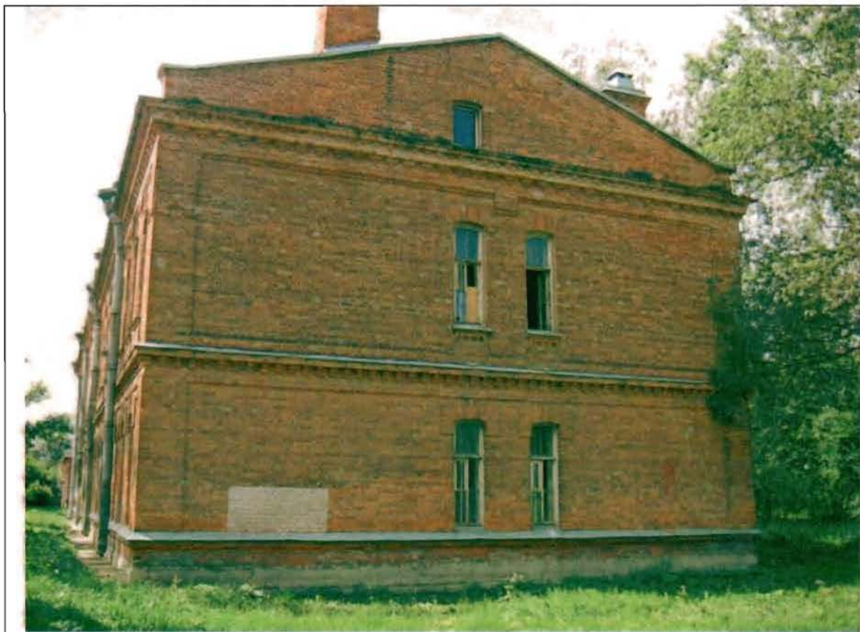
Фото 180. Северный фасад. Общий вид.
