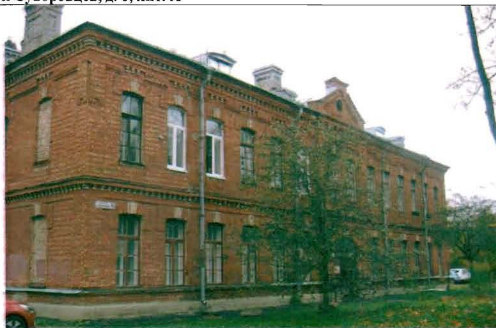
Фото 103. Восточный фасад. Общий вид.
