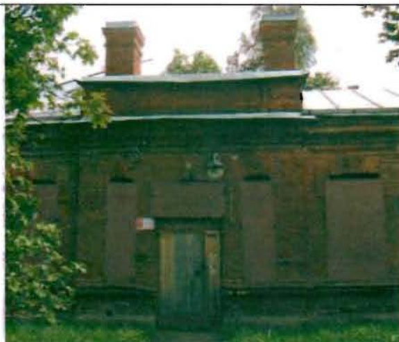
Фото 99. Западный фасад. Центральная часть. Общий вид.
