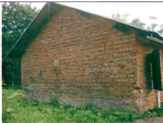
Фото 155. Северный фасад. Общий вид.
