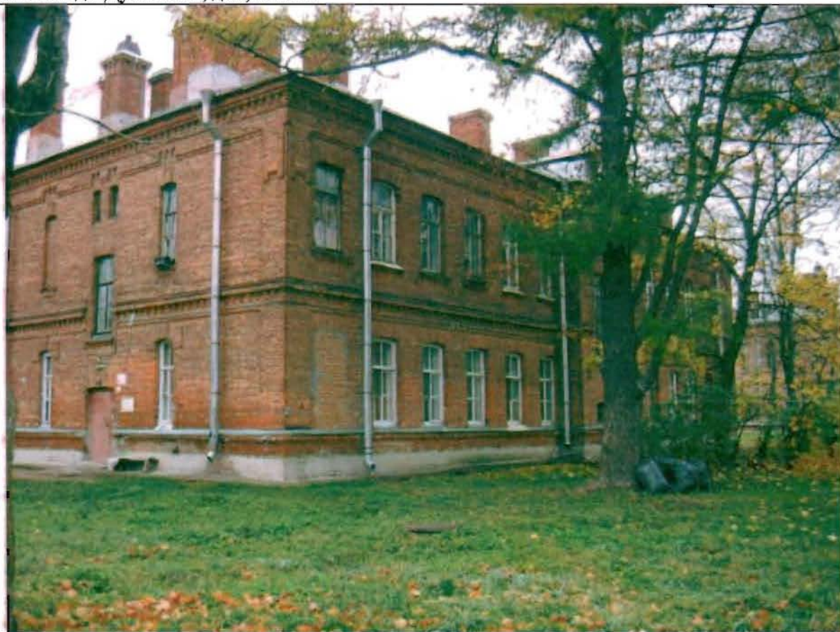
Фото 145. Восточный фасад. Общий вид.
