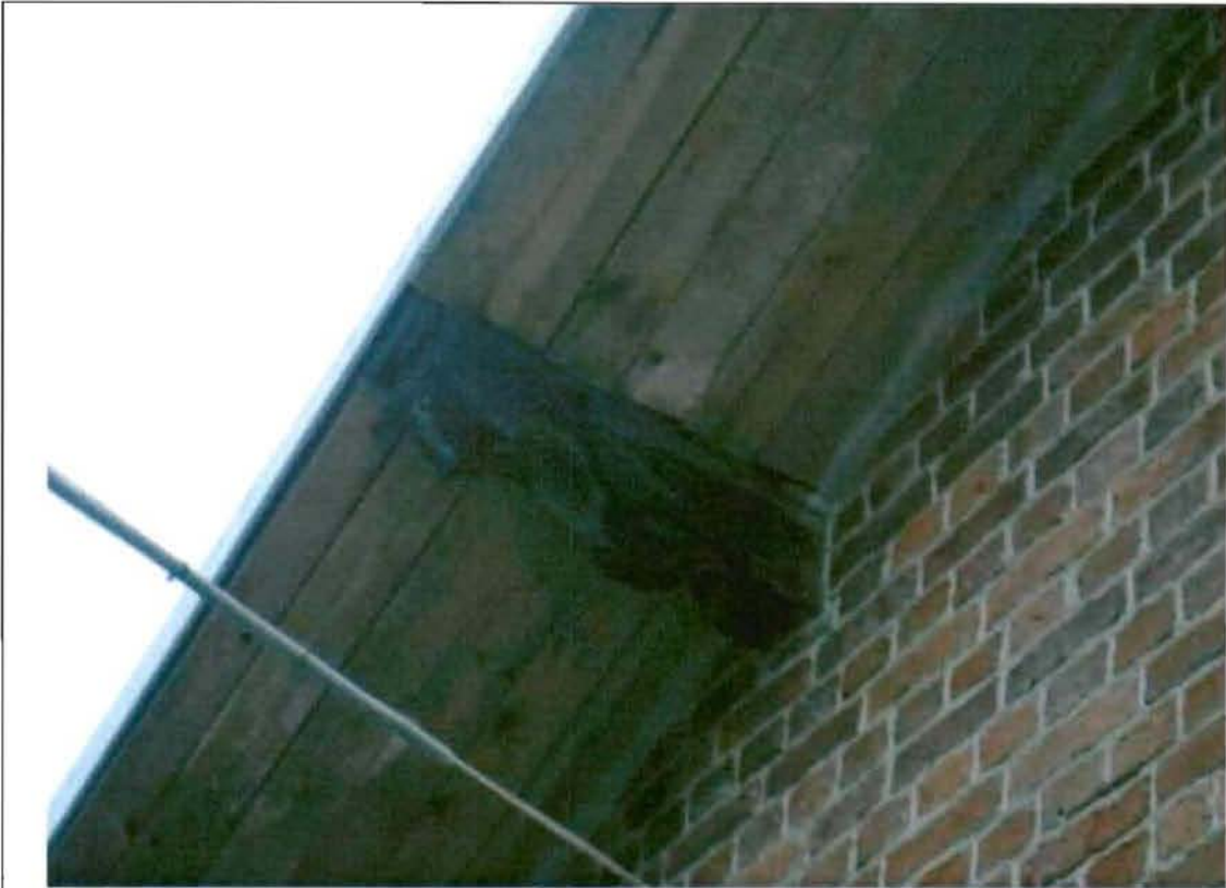
Деревянные кобылки. Съёмка 20.11.2012, Воронина Н.В.
