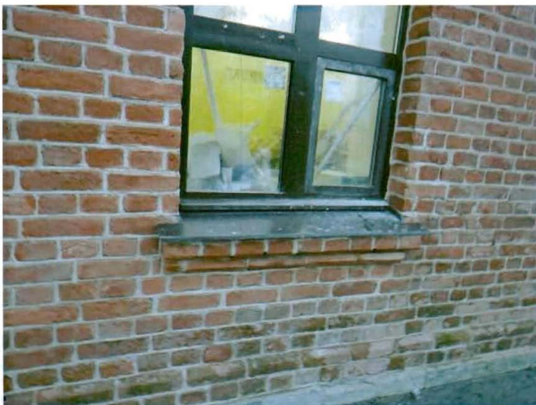
Ступенчатые подоконные доски. Съемка 20.11.2012, Воронина Н.В.
