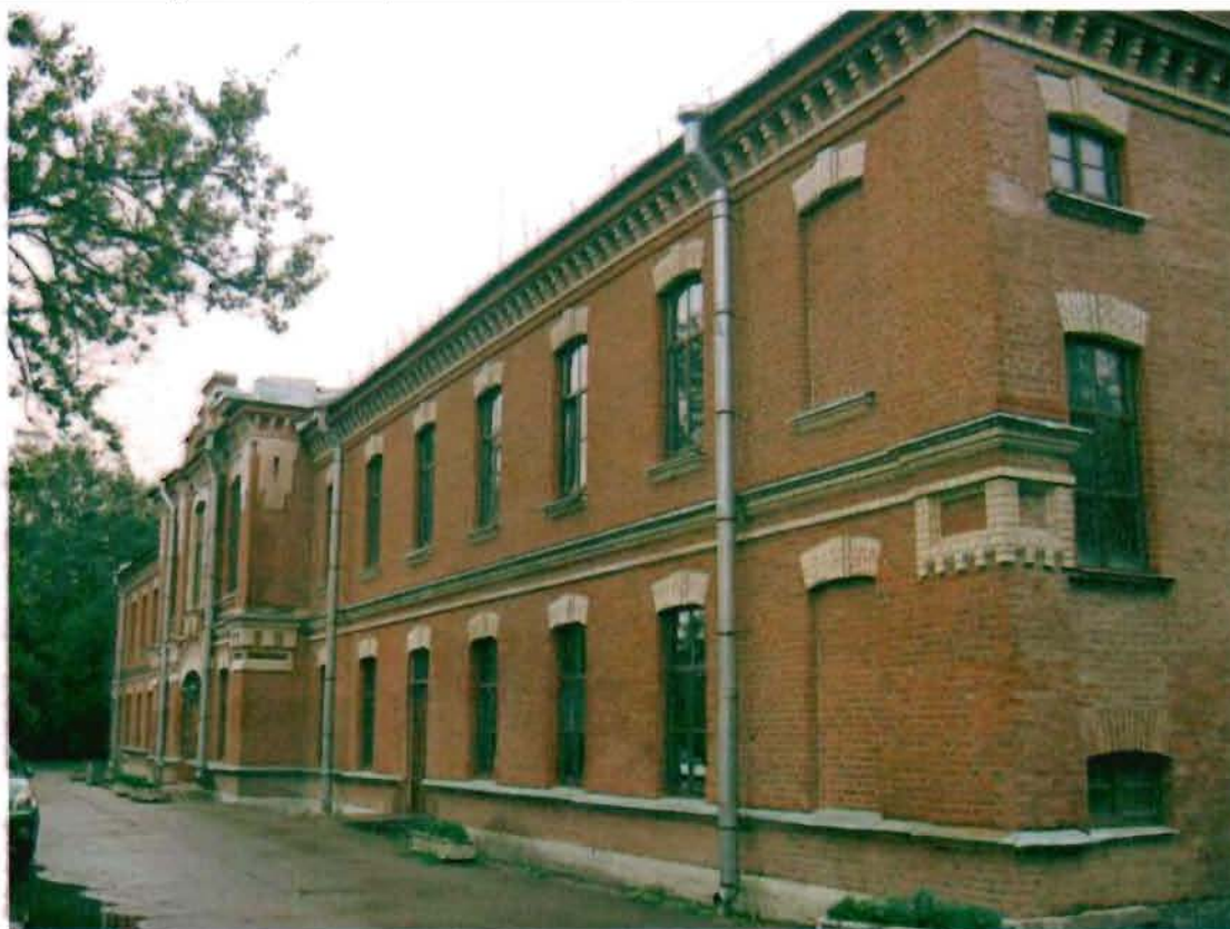
Фото 64. Северный фасад. Общий вид.
