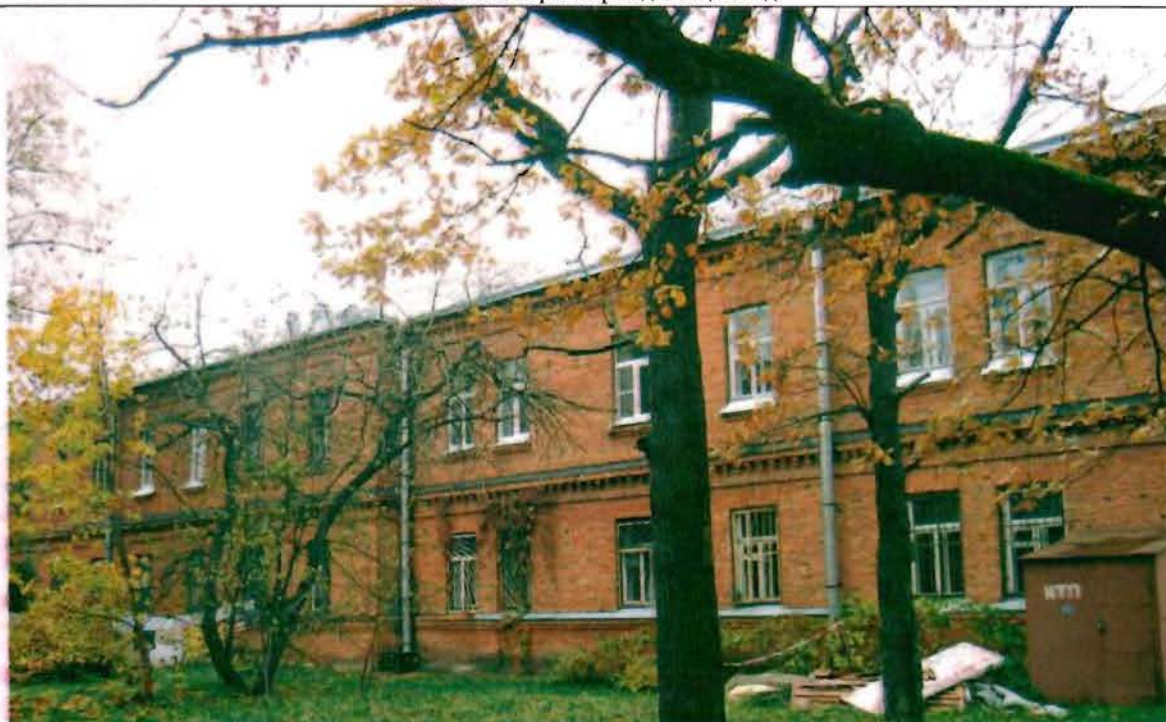
Фото 84. Южный фасад. Общий вид.
