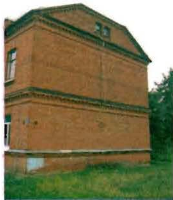
Фото 86. Западный фасад. Общий вид.
