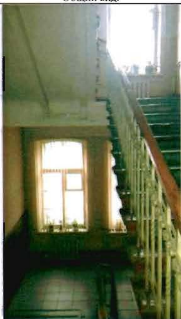
Фото 35. Интерьер. Лестница. Общий вид.
