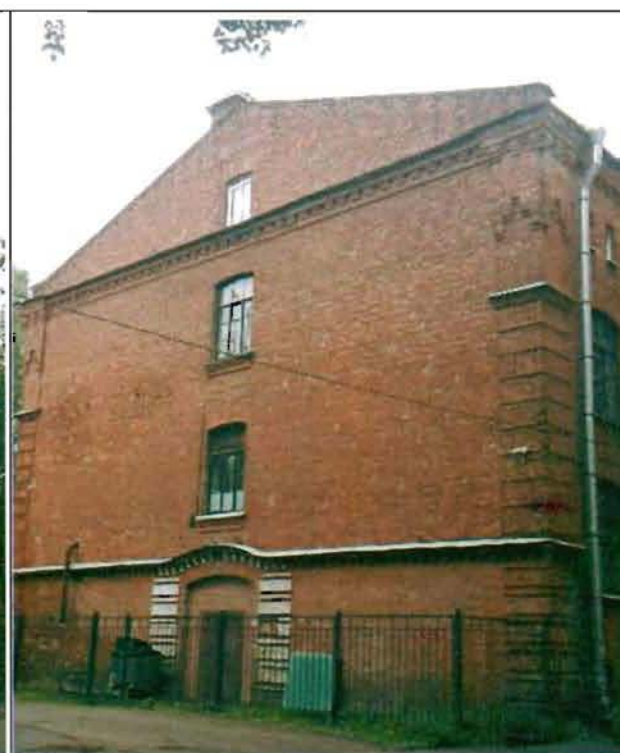
Фото 50. Южный фасад. Общий вид.
