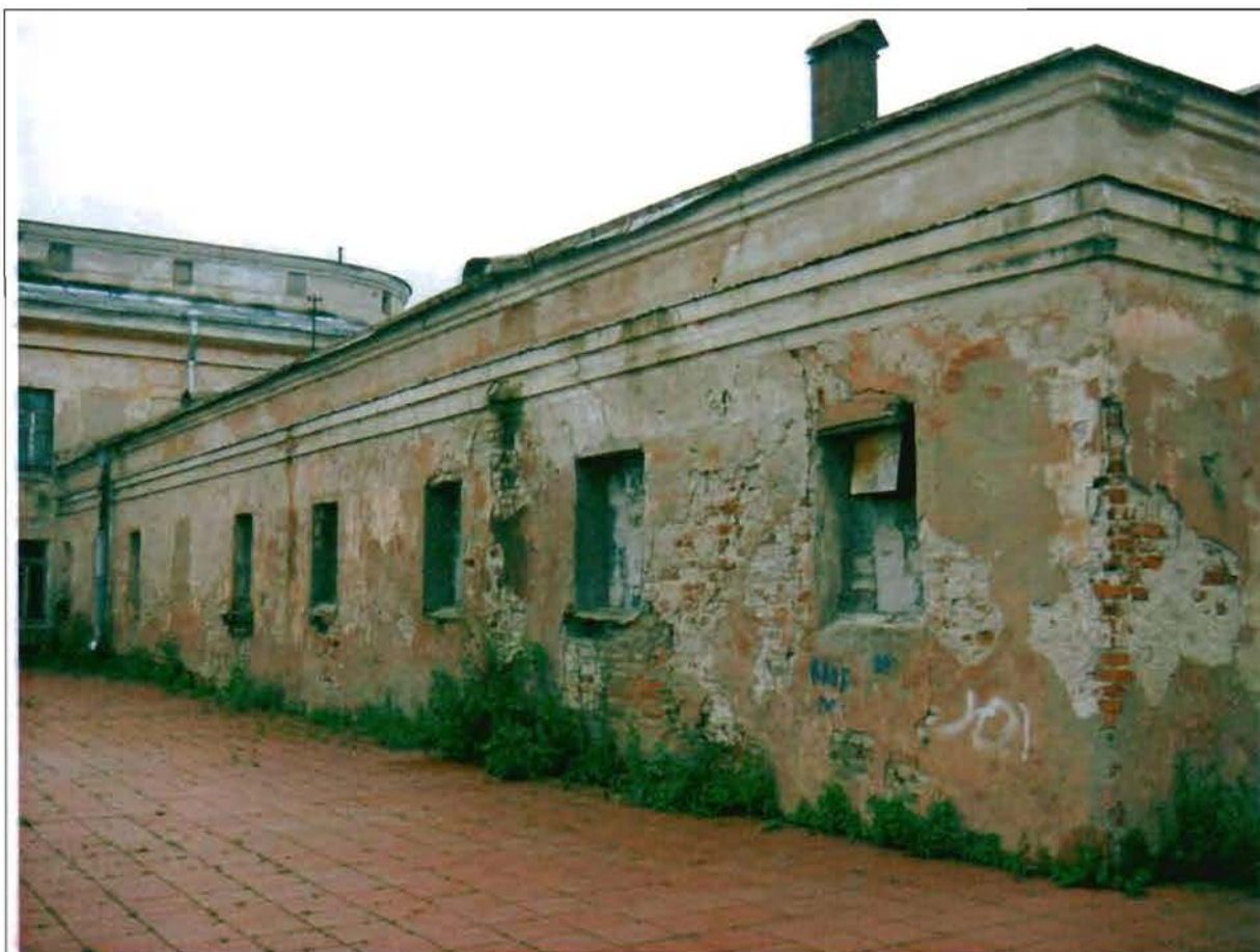
Фото 25. Восточный фасад. Общий вид.
