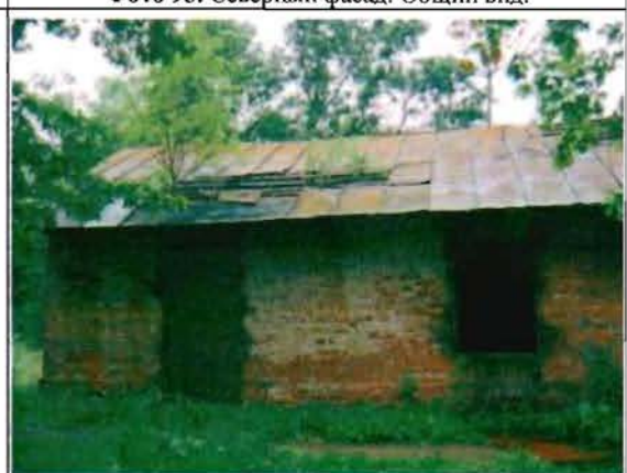
Фото 97. Южный фасад. Общий вид.
