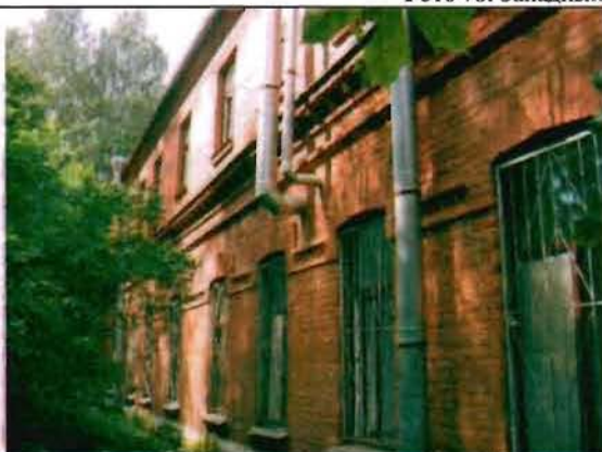
Фото 79. Восточный фасад. Общий вид.
