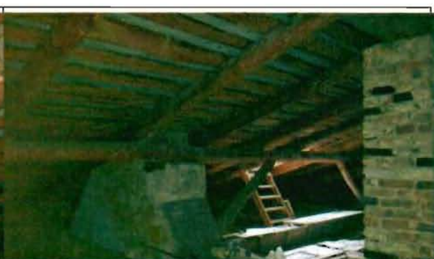
Фото 63. Конструкции крыши. Общий вид.
