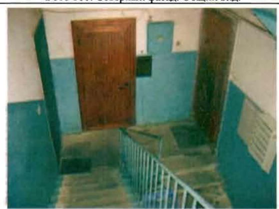
Фото 162. Лестница № 2 в северной части здания. Фрагмент.
