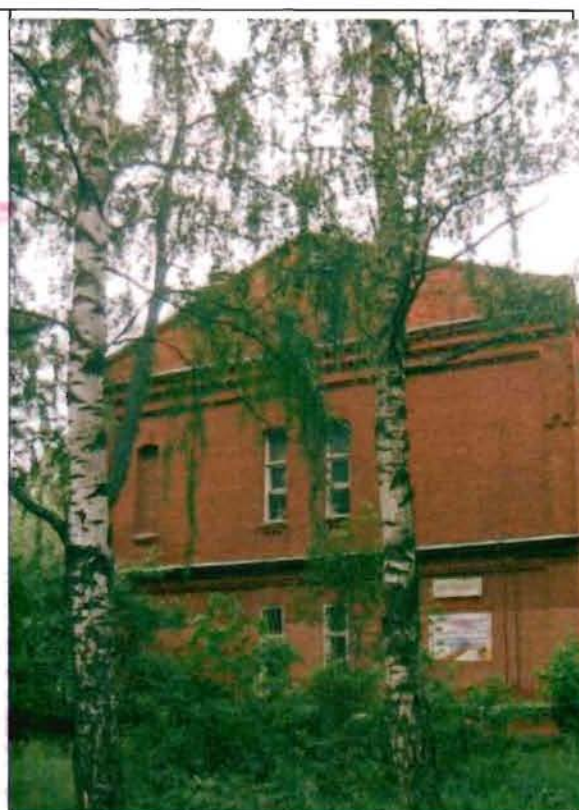
Фото 91. Северный фасад. Общий вид.
