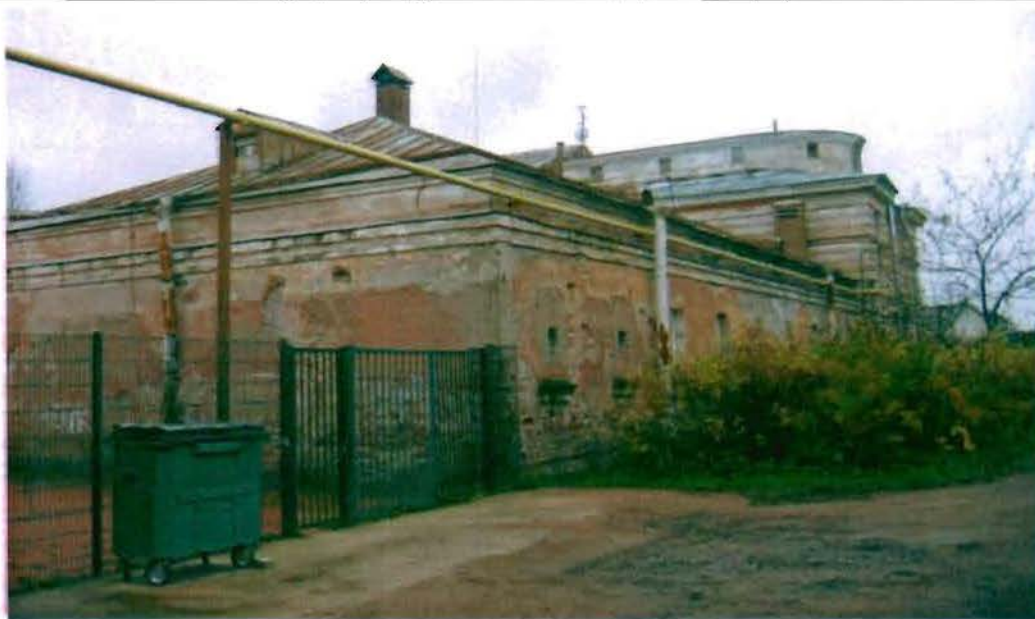
Фото 24. Западный, северный фасады. Общий вид.
