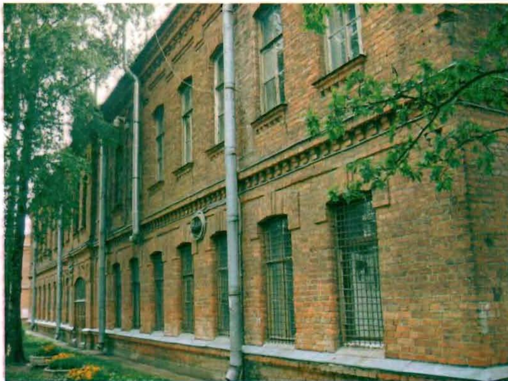
Фото 163. Восточный фасад. Общий вид.
