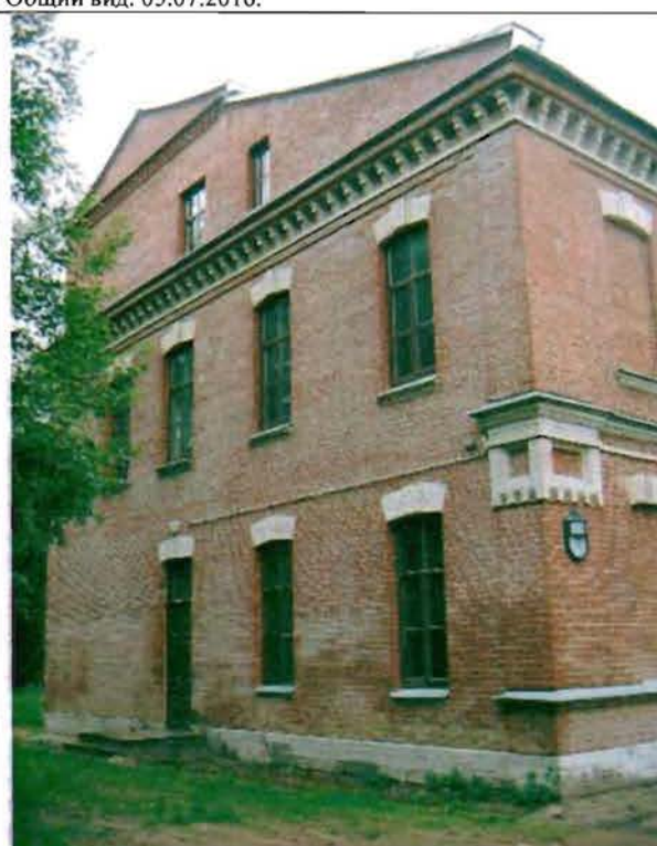
Фото 68. Восточный фасад. Общий вид.
