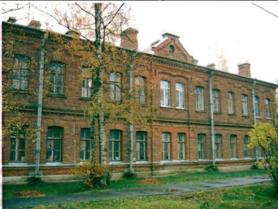
Фото 157. Западный фасад. Общий вид.
