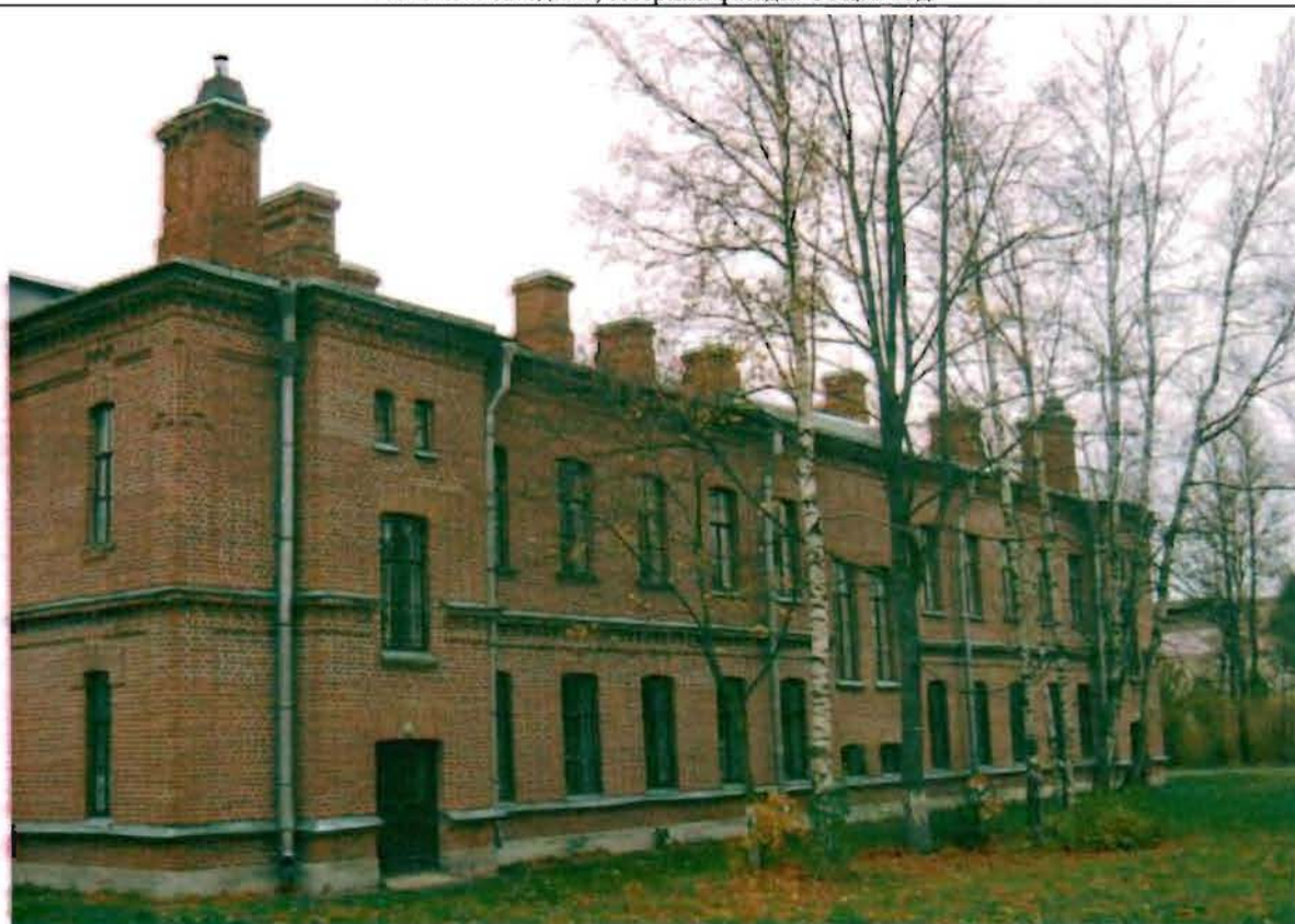
Фото 133. Восточный фасад. Общий вид.
