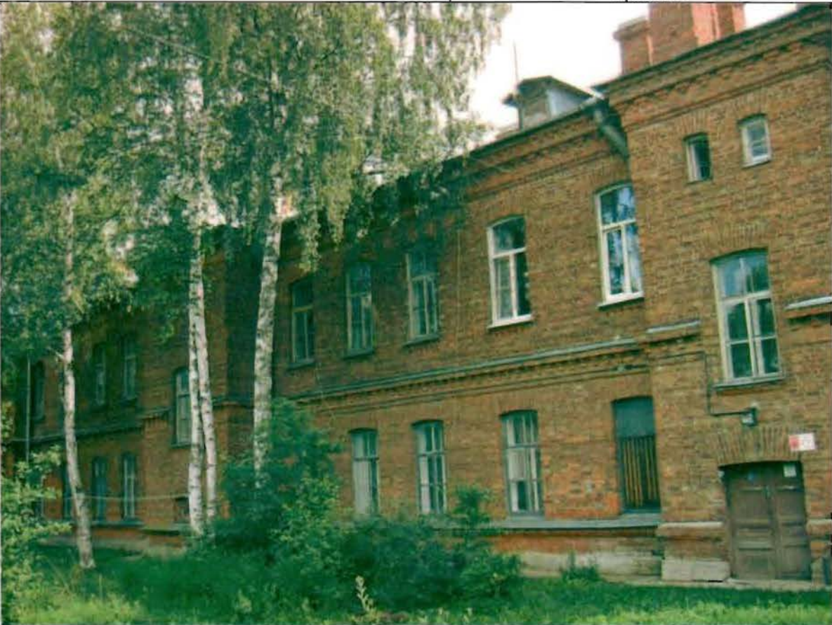
Фото 179. Западный фасад. Общий вид.
