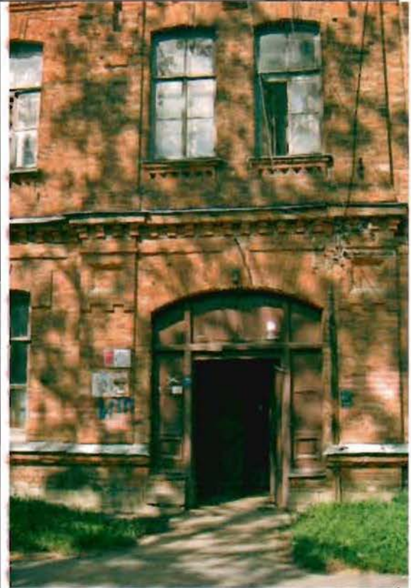
Фото 178. Восточный фасад. Центральная часть. Фрагмент.
