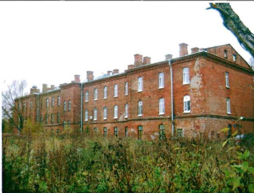
Фото 14. Восточный фасад. Общий вид.
