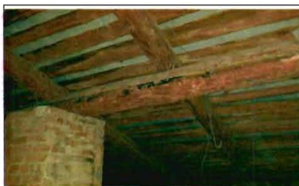
Фото 62. Конструкции крыши. Общий вид.
