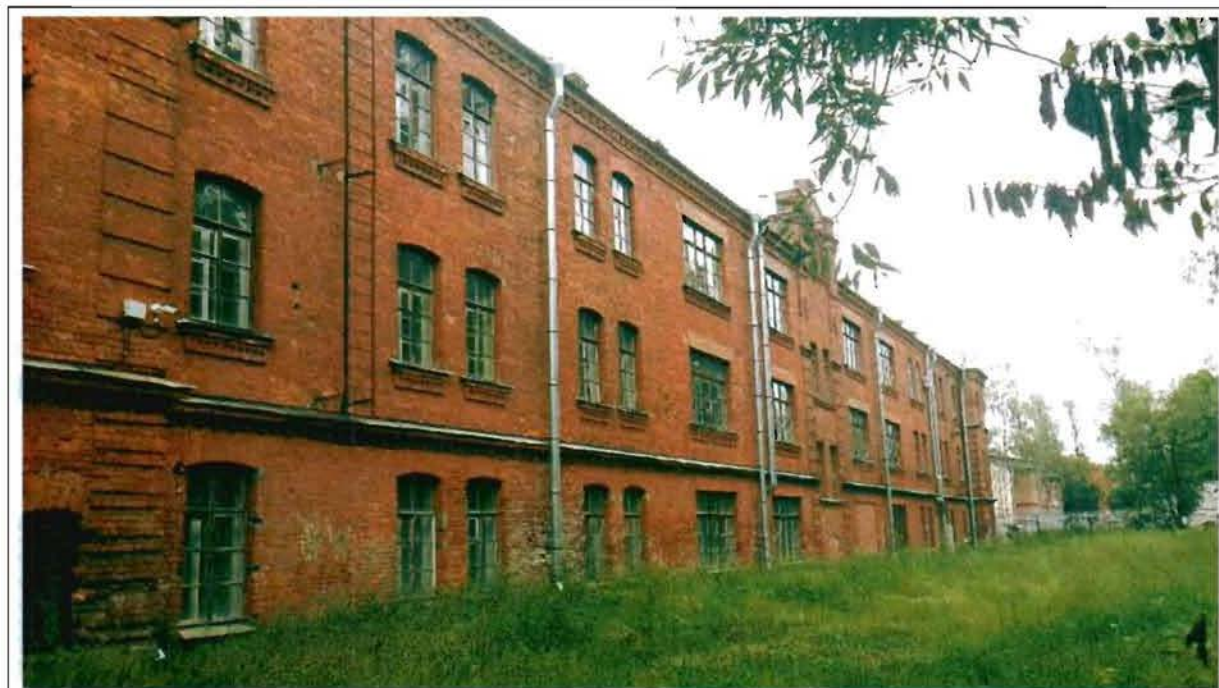
Фото 48. Западный фасад. Общий вид.
