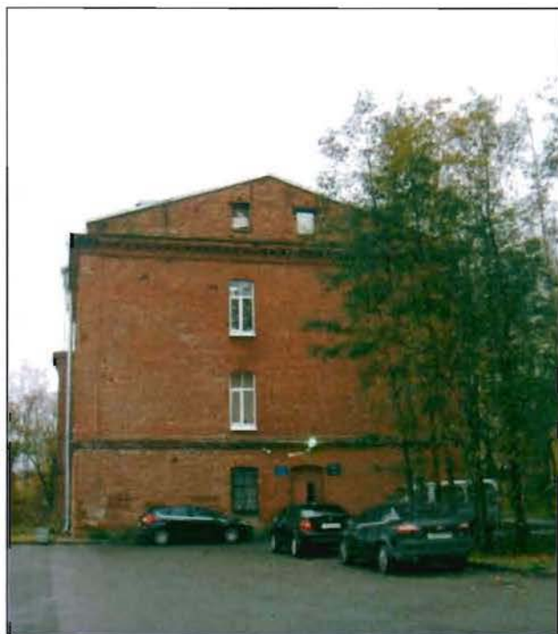
Фото 15. Северный фасад. Общий вид.
