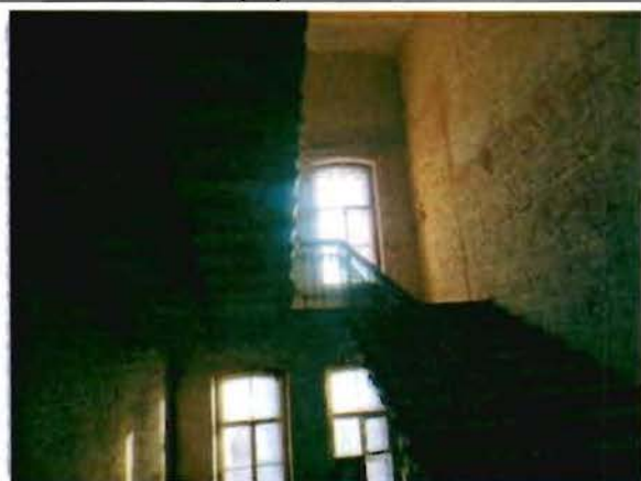
Фото 11. Интерьер. Лестница. Общий вид. 29.12.2015.
