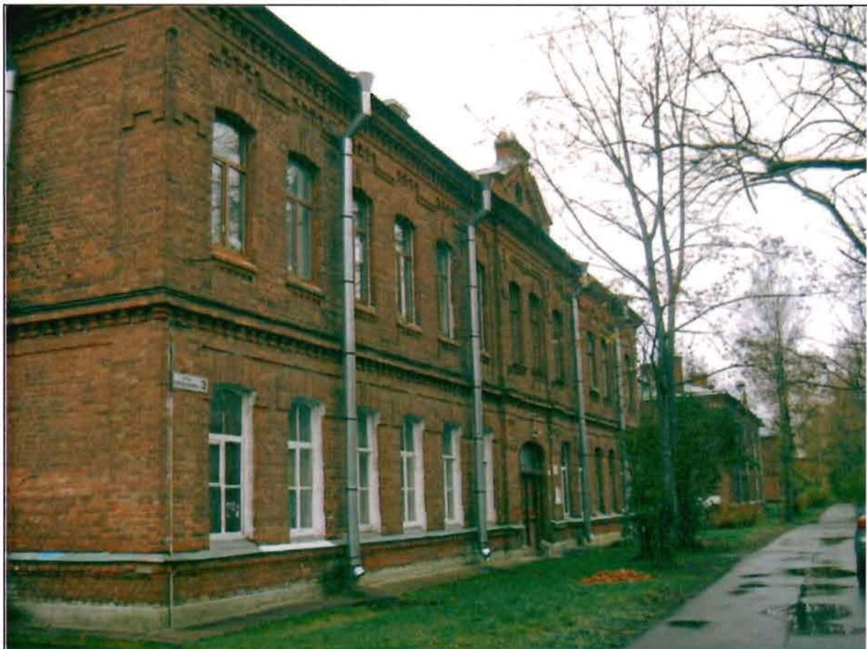
Фото 146. Западный фасад. Общий вид.
