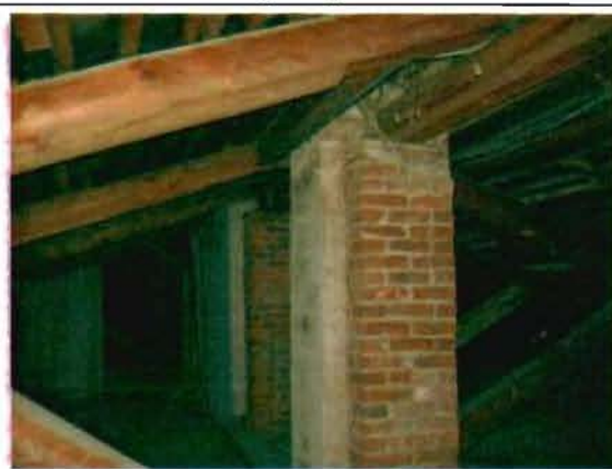
Фото 142. Конструкции крыши. Фрагмент.
