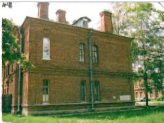
Фото 159. Северный фасад. Общий вид.
