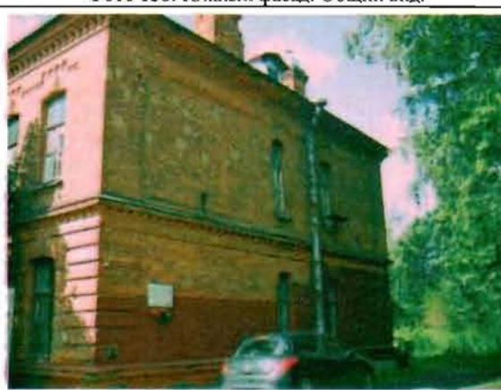
Фото 140. Северный фасад. Общий вид.
