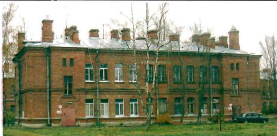
Фото 158. Восточный фасад. Общий вид.
