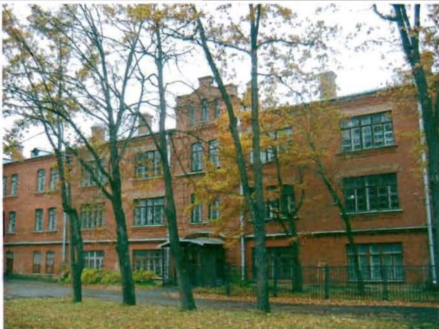
Фото 47. Восточный фасад. Общий вид.
