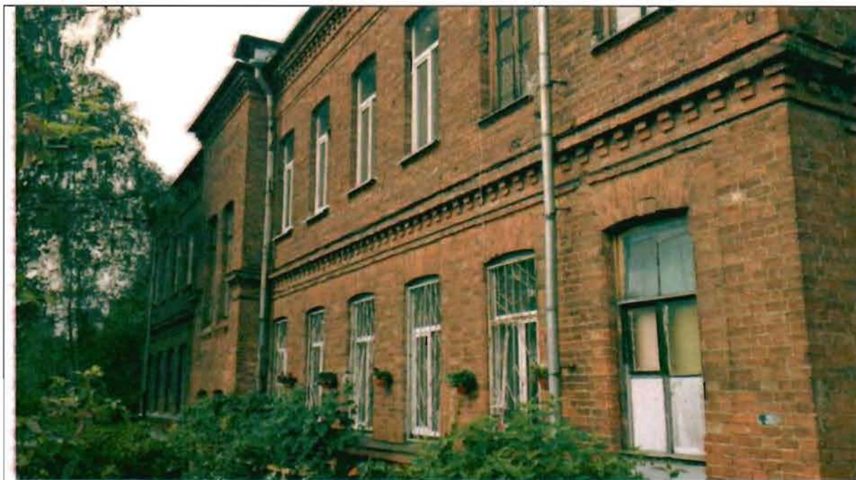
Фото 171. Восточный фасад. Общий вид.
