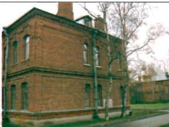
Фото 160. Северный фасад. Общий вид.
