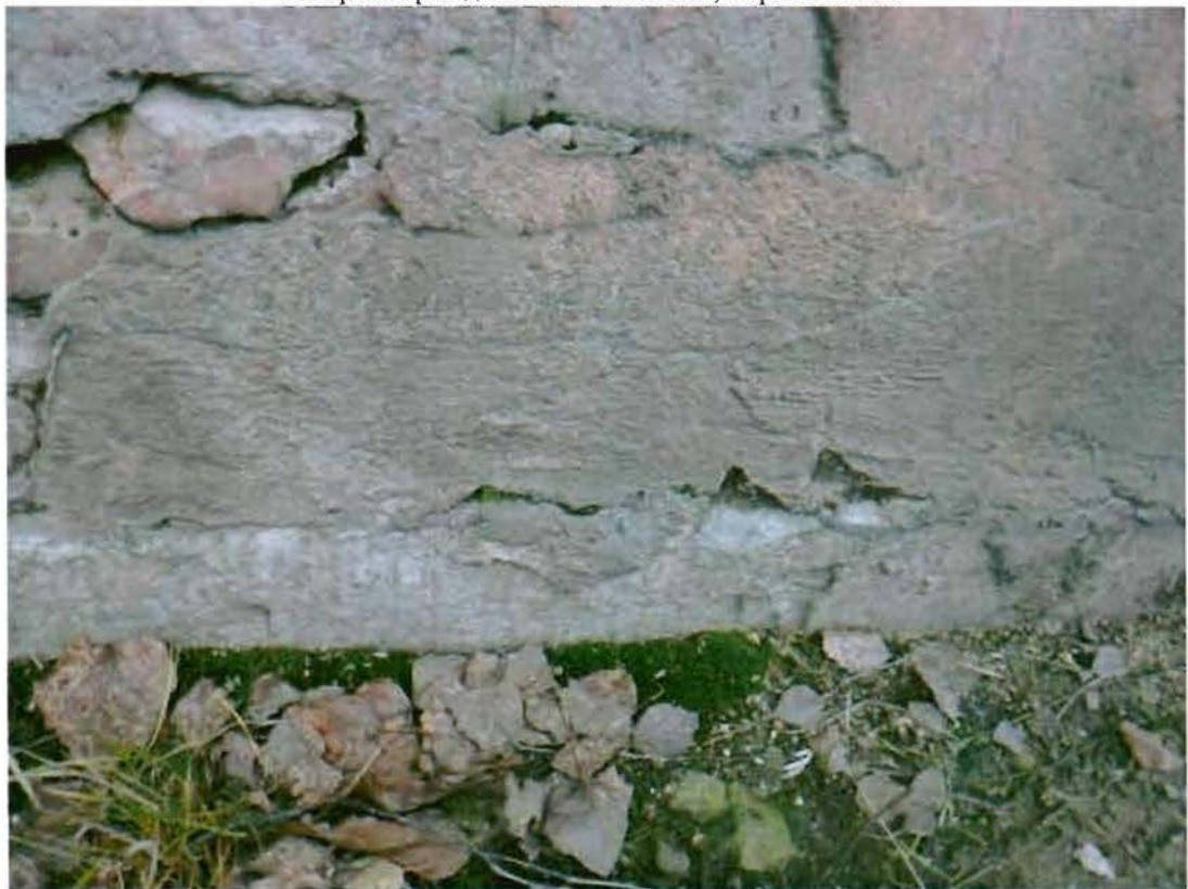
Цоколь, облицованный известняковой скобой. Съемка 27.11.2012, Воронина Н.В.
