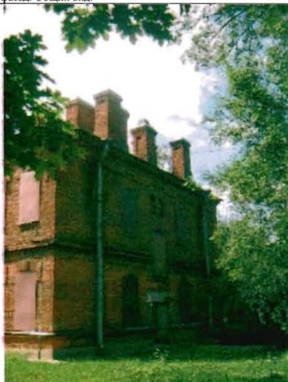
Фото 118. Северный фасад. Общий вид.
