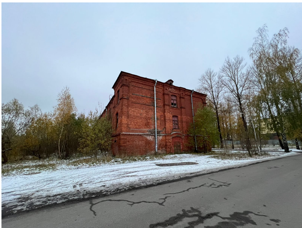
4. Вид на северо-восточный фасад в сторону объект культурного наследия регионального значения «Казармы 148-го пехотного Каспийского полка (с территорией). Казарма» по адресу: Санкт-Петербург, г. Петергоф, Суворовский городок, д. 1, литера А, от зоны производства работ.
