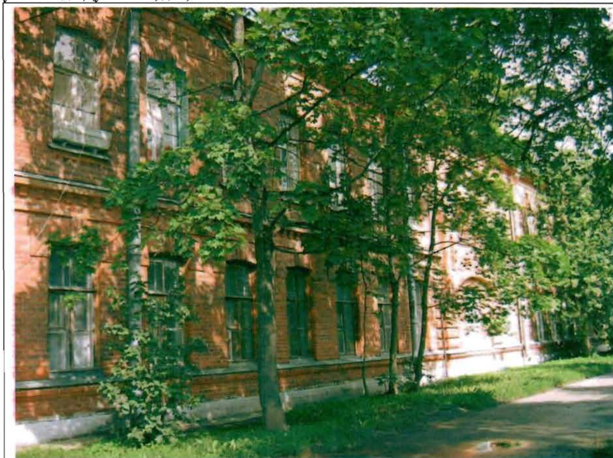
Фото 136. Восточный фасад. Общий вид.
