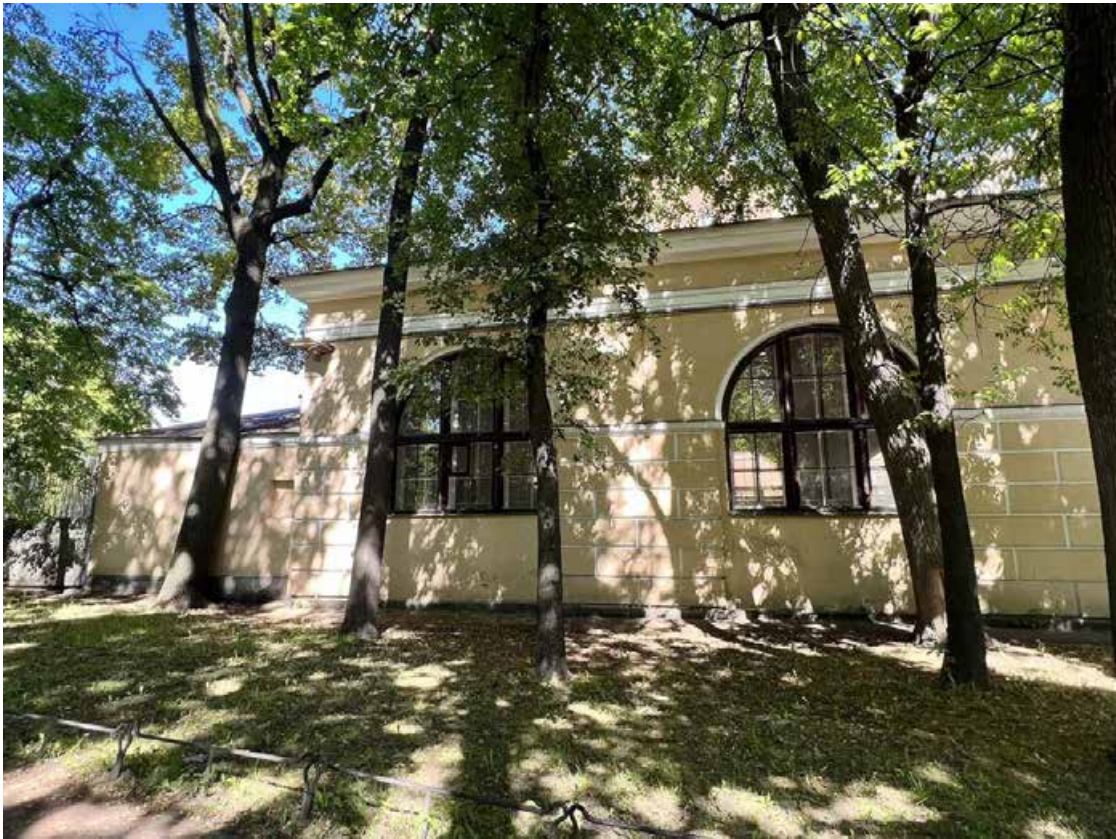
Фото 44. «Дворец Юсуповых», входящий в состав объекта культурного наследия федерального значения «Дворец с флигелями», Московский пр., д. 9, литера В. Фрагмент северо-западного фасада северного крыла дворца. Дата съемки: 26.07.2022 г. Автор съемки: Куваева Ю.П.
