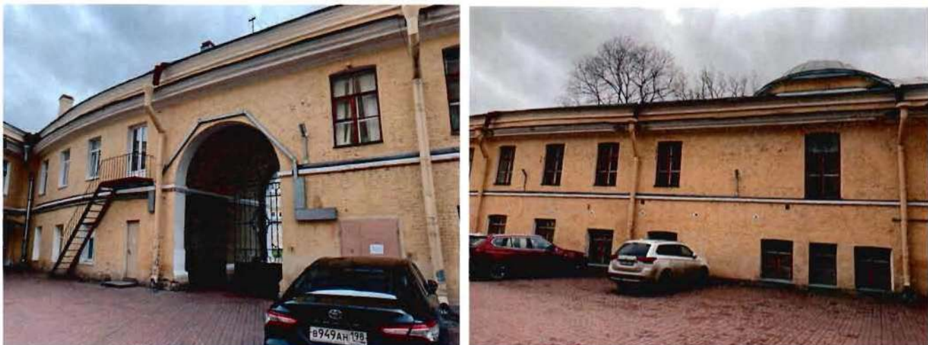
6. Общий вид северного флигеля.
