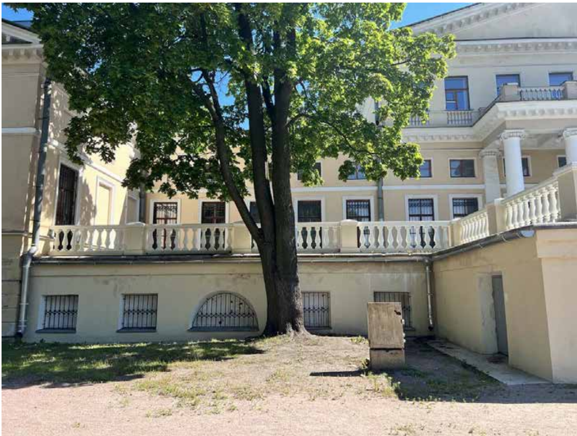
Фото 46. «Дворец Юсуповых», входящий в состав объекта культурного наследия федерального значения «Дворец с флигелями», Московский пр., д. 9, литера В. Левая часть северо-западного фасада главного здания дворца. Дата съемки: 26.07.2022 г. Автор съемки: Куваева Ю.П.
