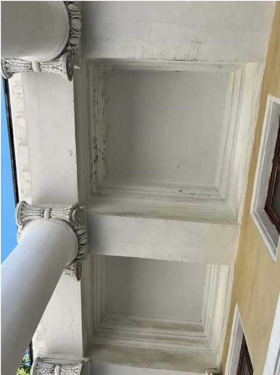
Фото 61. «Дворец Юсуповых», входящий в состав объекта культурного наследия федерального значения «Дворец с флигелями», Московский пр., д. 9, литера В. Перекрытие портика центральной части северо-западного фасада главного здания дворца. Фото с юго-запада. Дата съемки: 26.07.2022 г. Автор съемки: Куваева Ю.П.
