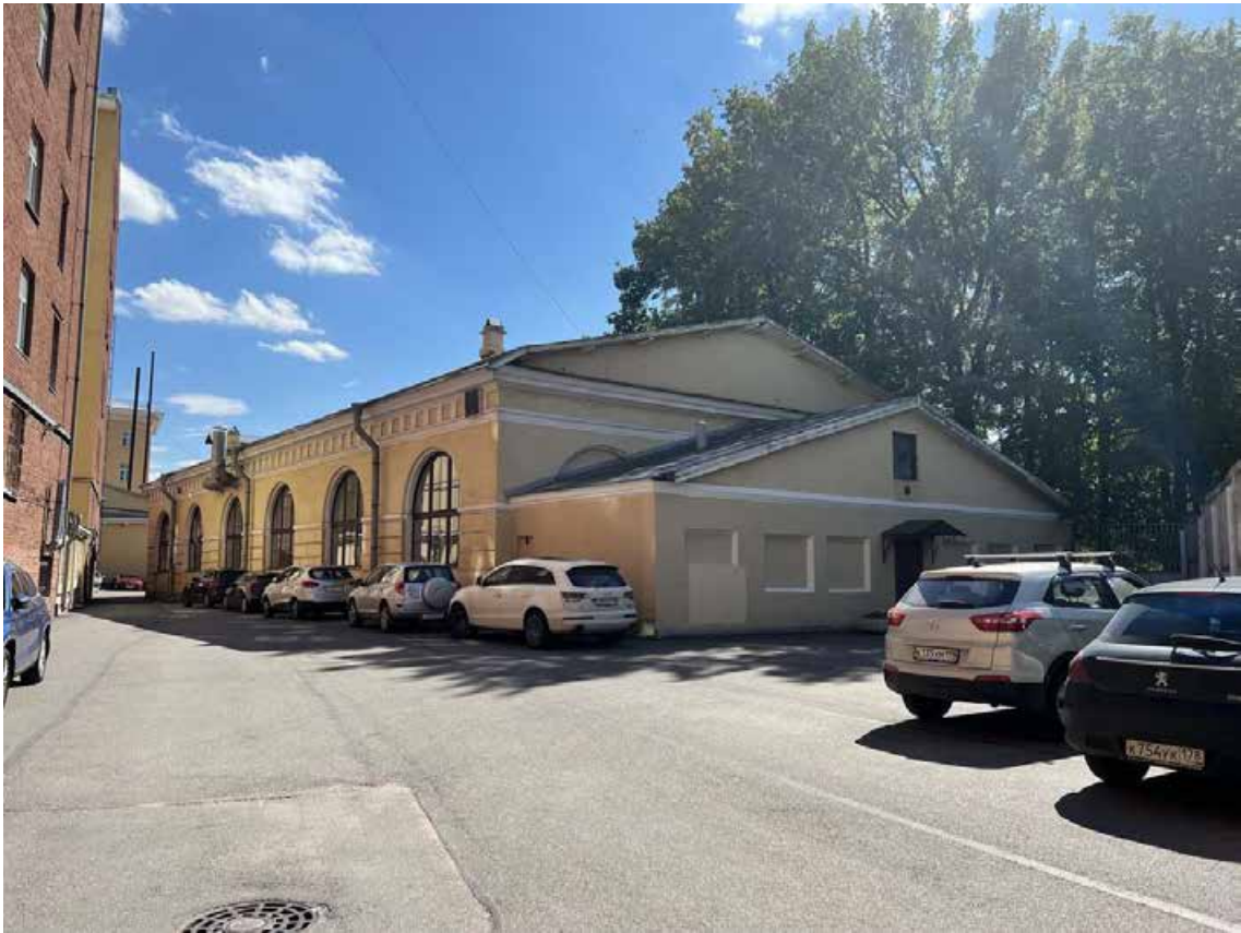
Фото 42. «Дворец Юсуповых», входящий в состав объекта культурного наследия федерального значения «Дворец с флигелями», Московский пр., д. 9, литера В. Общий вид северного флигеля дворца с пристройкой с севера. Дата съемки: 26.07.2022 г. Автор съемки: Куваева Ю.П.
