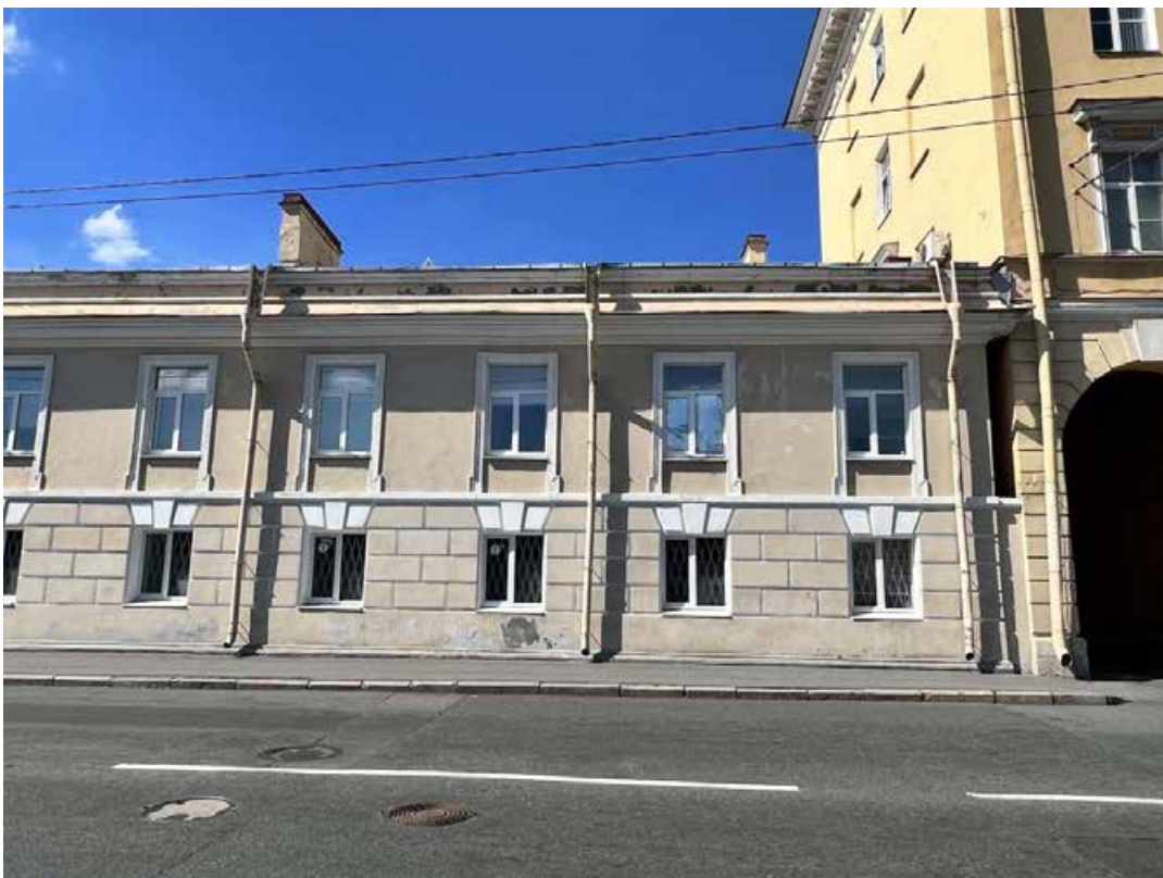
Фото 8. «Дворец Юсуповых», входящий в состав объекта культурного наследия федерального значения «Дворец с флигелями», Московский пр., д. 9, литера В. Фрагмент лицевого юго-восточного фасада восточного крыла здания. Фото с юго-востока. Дата съемки: 26.07.2022 г. Автор съемки: Куваева Ю.П.
