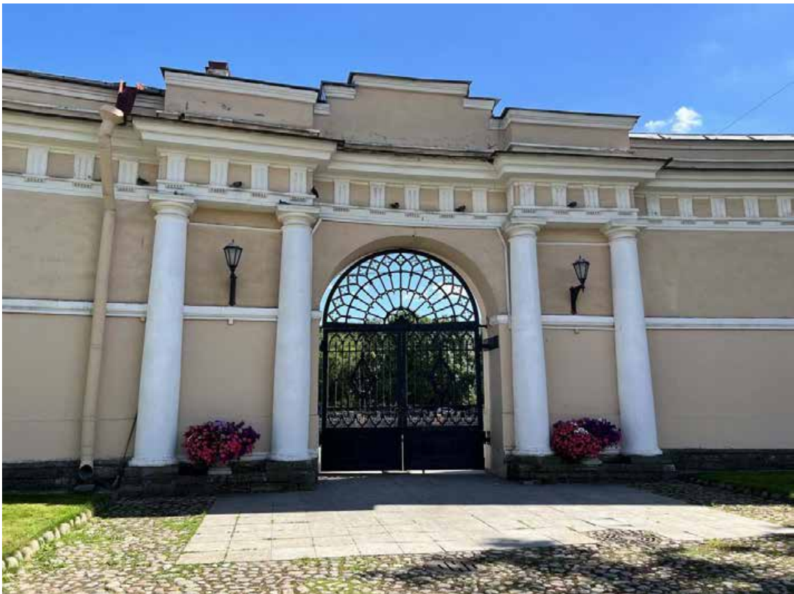
Фото 31. «Дворец Юсуповых», входящий в состав объекта культурного наследия федерального значения «Дворец с флигелями», Московский пр., д. 9, литера В. Центральные ворота. Фото с севера, со стороны парадного двора. Дата съемки: 26.07.2022 г. Автор съемки: Куваева Ю.П.
