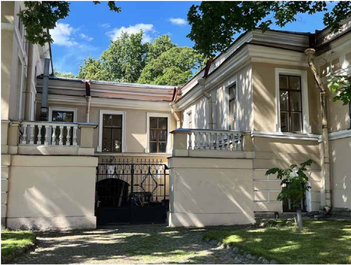
Фото 19. «Дворец Юсуповых», входящий в состав объекта культурного наследия федерального значения «Дворец с флигелями», Московский пр., д. 9, литера В. Общий вид пристройки между главным зданием дворца и восточного крыла. Фото с юго-востока. Дата съемки: 26.07.2022 г. Автор съемки: Куваева Ю.П.
