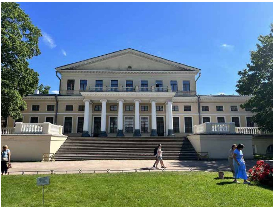
Фото 47. «Дворец Юсуповых», входящий в состав объекта культурного наследия федерального значения «Дворец с флигелями», Московский пр., д. 9, литера В. Центральная часть северо-западного фасада главного здания дворца. Дата съемки: 26.07.2022 г. Автор съемки: Куваева Ю.П.
