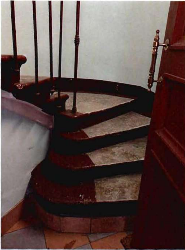
40, 41. Лестница западного флигеля.
