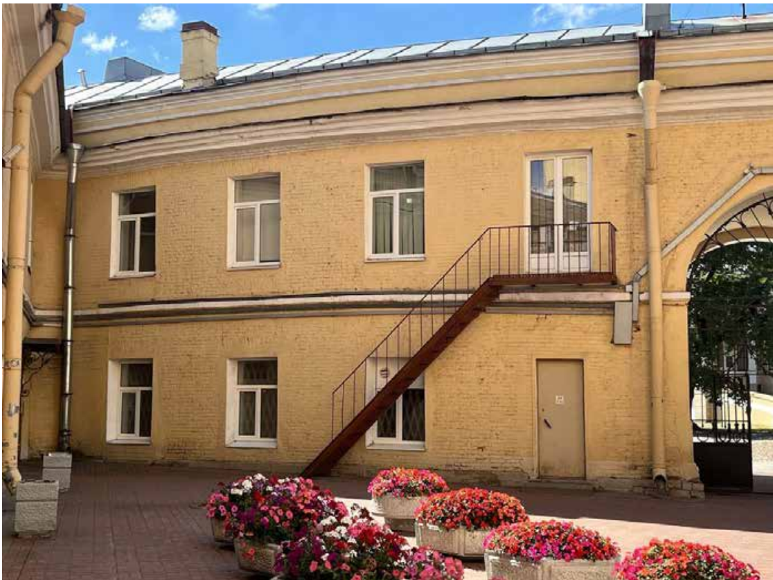
Фото 35. «Дворец Юсуповых», входящий в состав объекта культурного наследия федерального значения «Дворец с флигелями», Московский пр., д. 9, литера В. Левая часть северо-восточного фасада восточного крыла дворца. Фото с востока. Дата съемки: 26.07.2022 г. Автор съемки: Куваева Ю.П.
