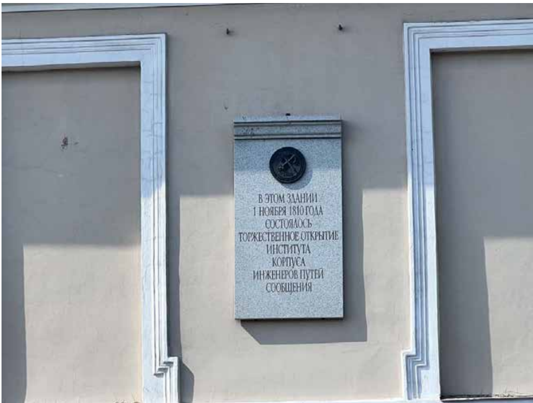
Фото 6. «Дворец Юсуповых», входящий в состав объекта культурного наследия федерального значения «Дворец с флигелями», Московский пр., д. 9, литера В. Фрагмент лицевого юго-восточного фасада юго-западного крыла здания. Фото с юго-востока. Гранитная мемориальная плита с надписью: «В ЭТОМ ЗДАНИИ 1 НОЯБРЯ 1810 ГОДА СОСТОЯЛОСЬ ТОРЖЕСТВЕННОЕ ОТКРЫТИЕ ИНСТИТУТА КОРПУСА ИНЖЕНЕРОВ ПУТЕЙ СООБЩЕНИЯ». Дата съемки: 26.07.2022 г. Автор съемки: Куваева Ю.П.
