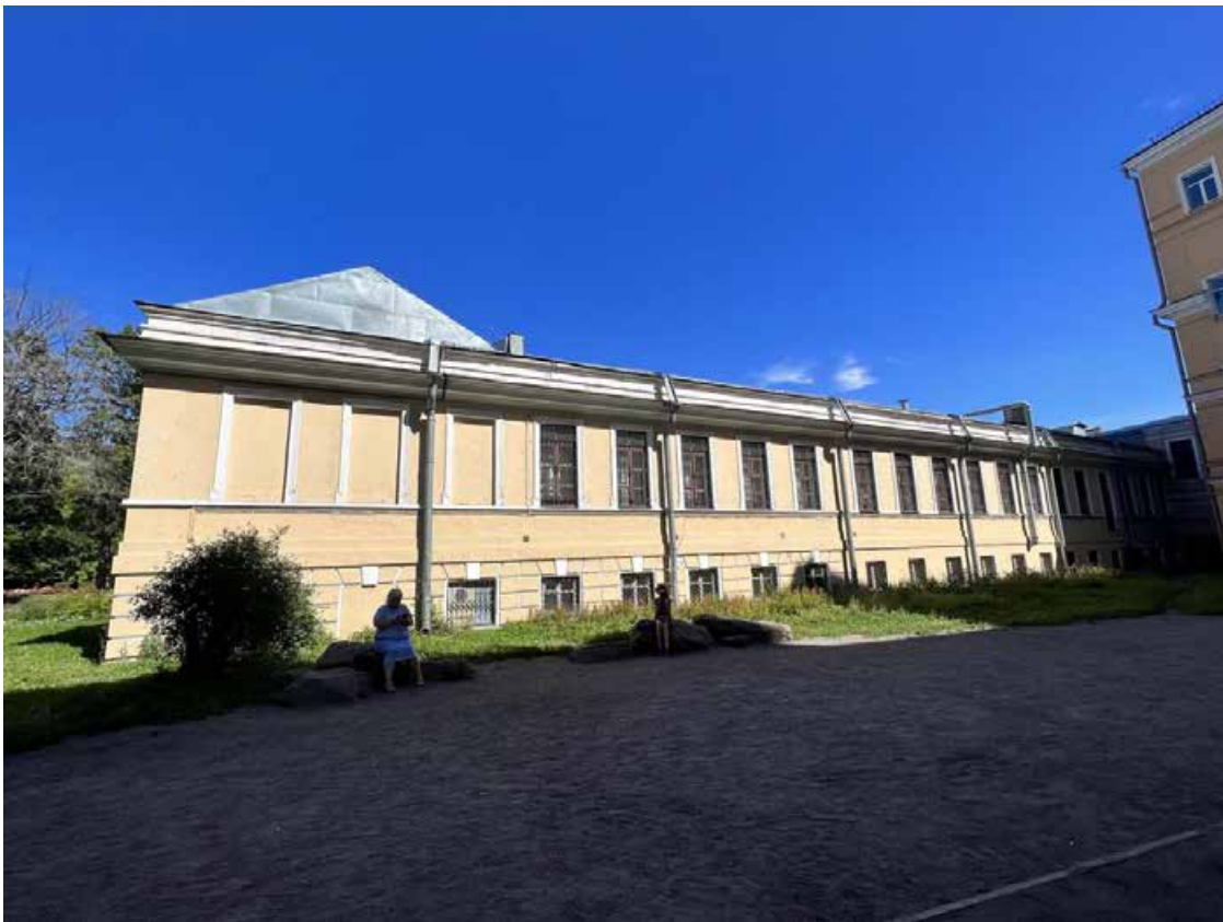
Фото 68. «Дворец Юсуповых», входящий в состав объекта культурного наследия федерального значения «Дворец с флигелями», Московский пр., д. 9, литера В. Общий вид юго-западного фасада западной пристройки с юго-запада. Дата съемки: 26.07.2022 г. Автор съемки: Куваева Ю.П.
