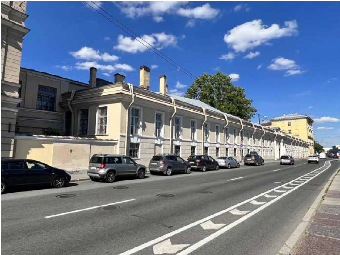
Фото 3. «Дворец Юсуповых», входящий в состав объекта культурного наследия федерального значения «Дворец с флигелями», Московский пр., д. 9, литера В. Общий вид уличных юго-восточных фасадов крыльев здания. Фото с юга, с наб. р. Фонтанки. Дата съемки: 26.07.2022 г. Автор съемки: Куваева Ю.П.
