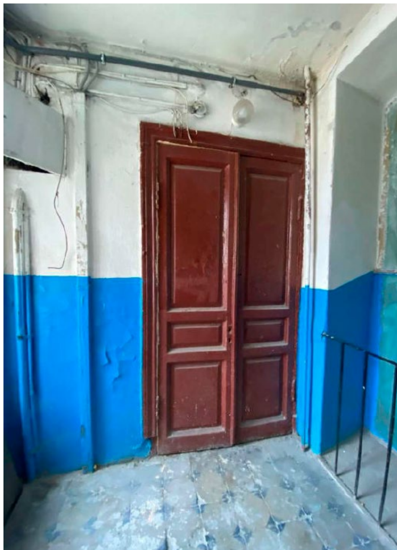
4. Входные дверные заполнения квартиры №10 в уровне мансардного этажа выявленного объекта культурного наследия «Дом М.Д. Корнилова», расположенного по адресу: г. Санкт-Петербург, Малый проспект П.С., д. 26-28, литера А. 24.11.2023.
