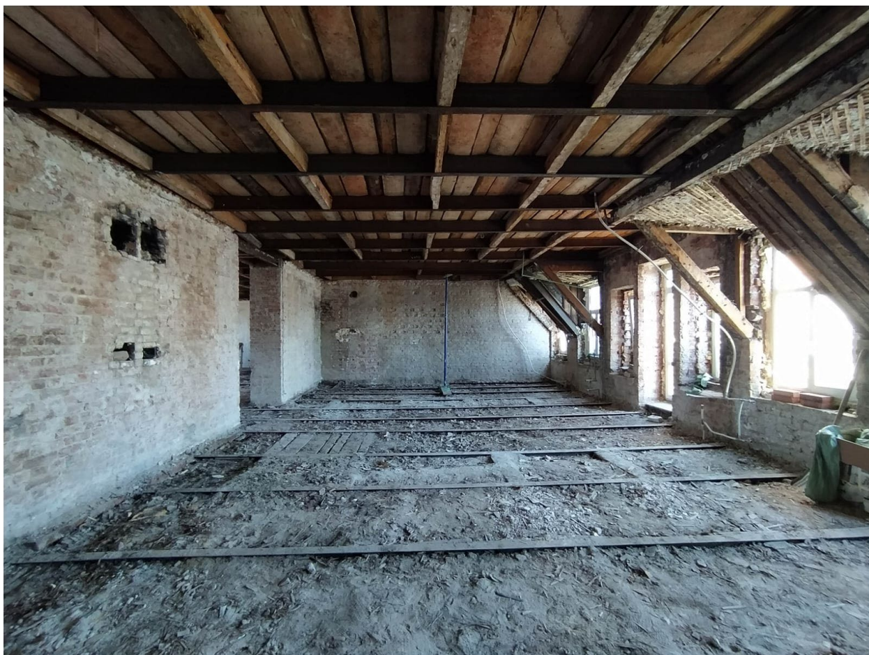
11. Помещения №№12-14 квартиры №10 в уровне мансардного этажа выявленного объекта культурного наследия «Дом М.Д. Корнилова», расположенного по адресу: г. Санкт-Петербург, Малый проспект П.С., д. 26-28, литера А. 24.11.2023.
