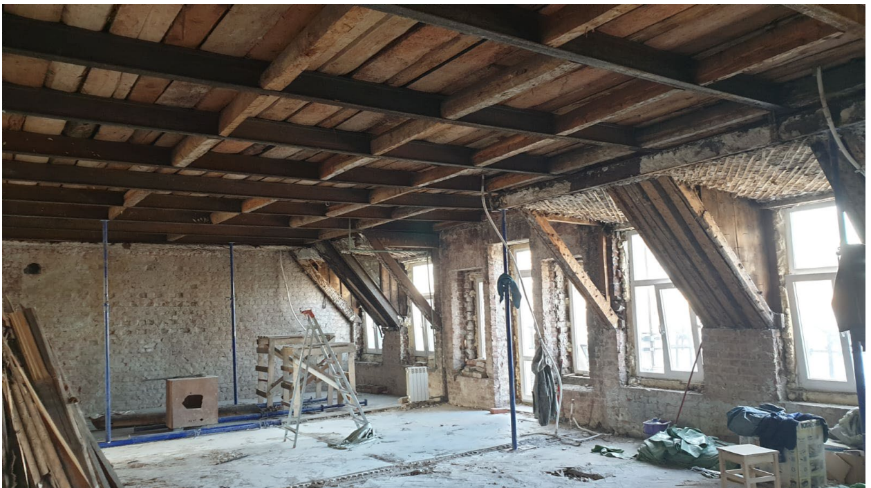
8. Помещения №№12-14 квартиры №10 в уровне мансардного этажа выявленного объекта культурного наследия «Дом М.Д. Корнилова», расположенного по адресу: г. Санкт-Петербург, Малый проспект П.С., д. 26-28, литера А. 24.11.2023.
