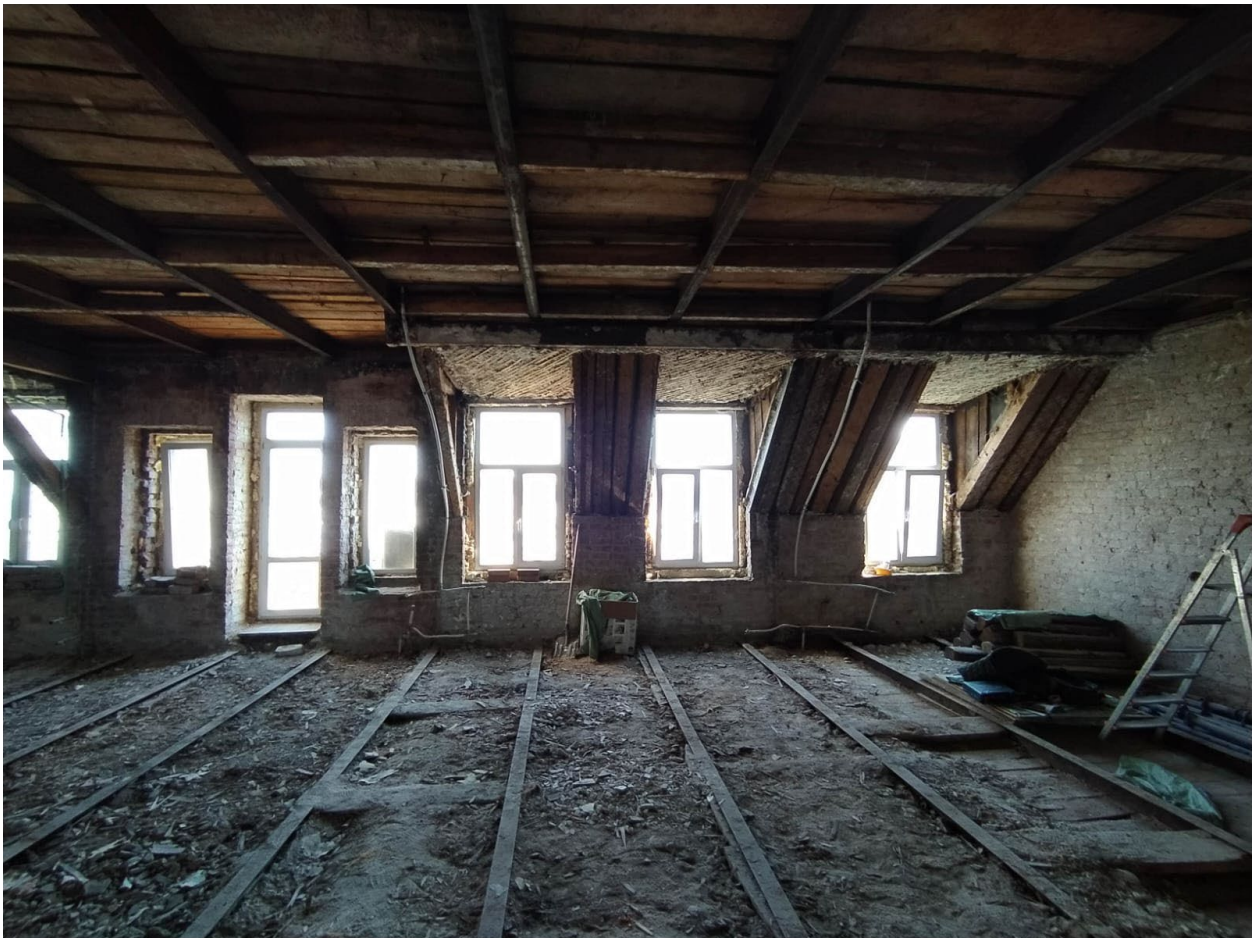
12. Помещения №№12-14 квартиры №10 в уровне мансардного этажа выявленного объекта культурного наследия «Дом М.Д. Корнилова», расположенного по адресу: г. Санкт-Петербург, Малый проспект П.С., д. 26-28, литера А. 24.11.2023.
