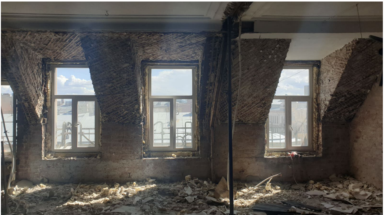
6. Помещения №№9,10 квартиры №10 в уровне мансардного этажа выявленного объекта культурного наследия «Дом М.Д. Корнилова», расположенного по адресу: г. Санкт-Петербург, Малый проспект П.С., д. 26-28, литера А. 24.11.2023.
