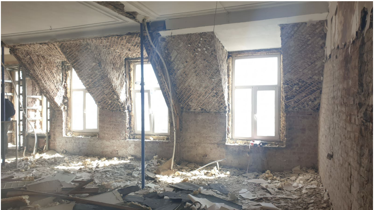
7. Помещения №№9,10 квартиры №10 в уровне мансардного этажа выявленного объекта культурного наследия «Дом М.Д. Корнилова», расположенного по адресу: г. Санкт-Петербург, Малый проспект П.С., д. 26-28, литера А. 24.11.2023.
