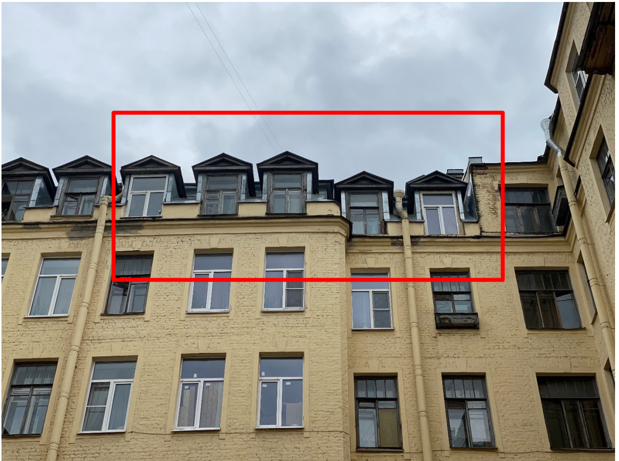
2. Оконные заполнения квартиры №10 в уровне мансардного этажа выявленного объекта культурного наследия «Дом М.Д. Корнилова», расположенного по адресу: г. Санкт-Петербург, Малый проспект П.С., д. 26-28, литера А. 24.11.2023.
