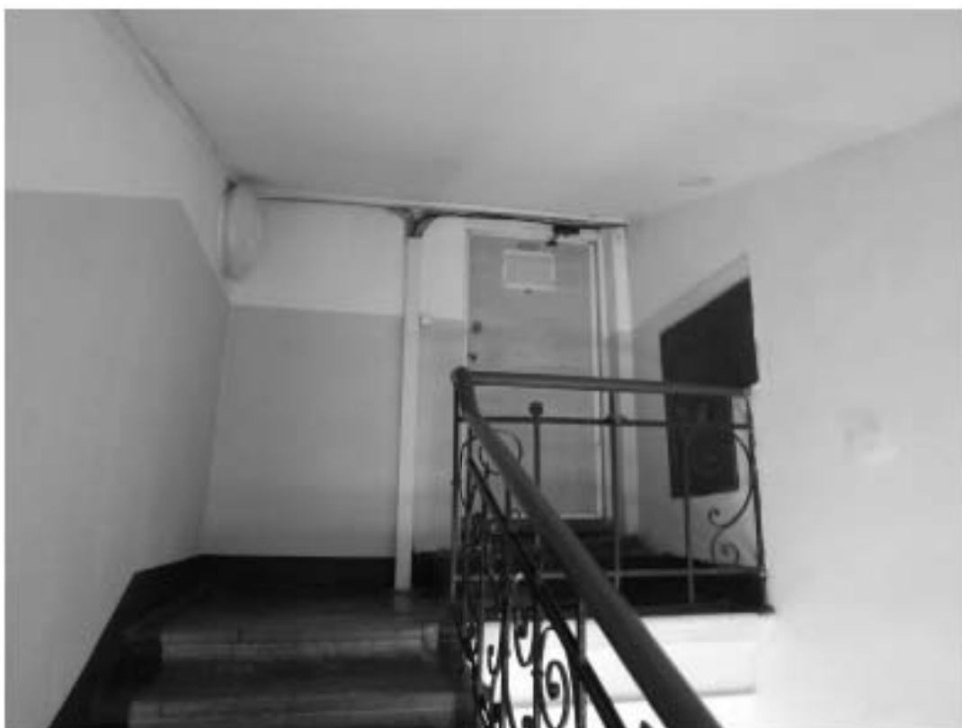
306. «Дом Н.Я. и Ф.Я. Колобовых». Санкт-Петербург, Большой пр. П.С., 16-18; Красного курсанта ул., д.1; Пионерская ул., д.6, литера А. Большой пр. П.С., 18. Мансардный этаж. Вход в помещение 11-Н. Фото: 21.03. 2023.
