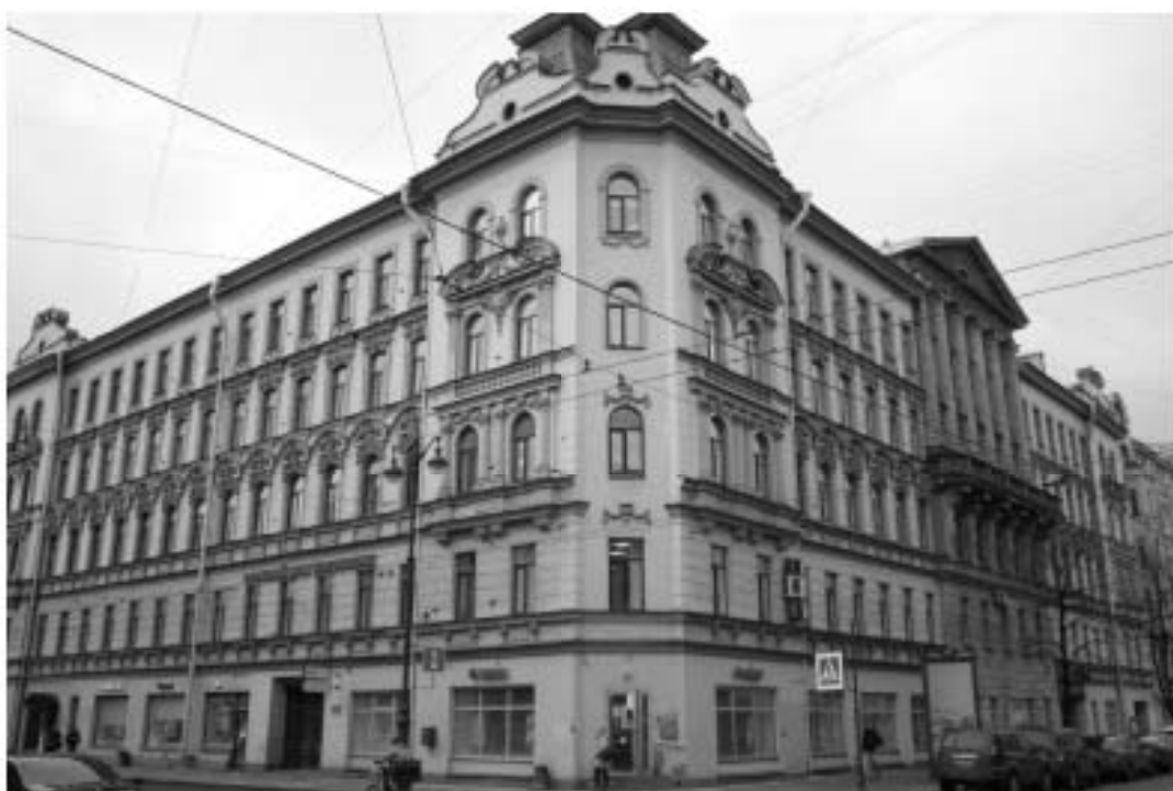
16. «Дом Н.Я. и Ф.Я. Колбовых». Санкт-Петербург; Большой пр. П.С., 16-18; Красно го курсанта ул., д.1; Пионерская ул., д.6, литера А. Лицевые фасады по Большому пр., П.С. и Пионерской ул. Фото: 21.03.2023.
