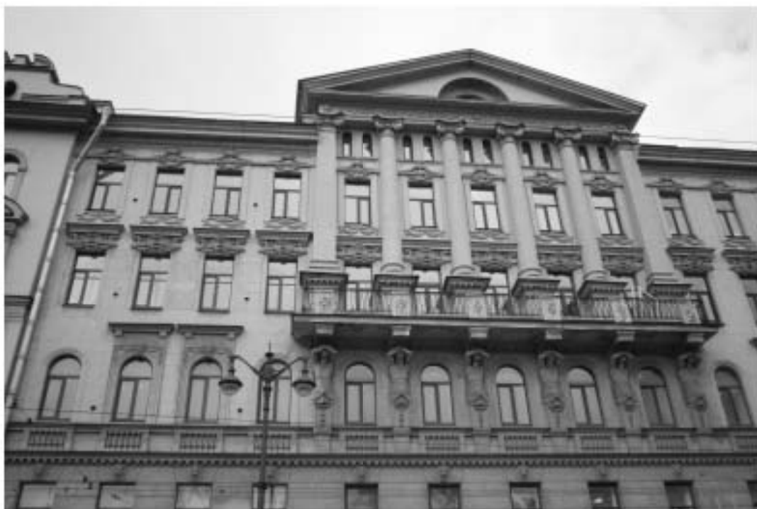
11. «Дом Н.Я. и Ф.Я. Колобовых». Санкт-Петербург, Большой пр. П.С., 16-18; Красно го курсанта ул., д.1; Пионерская ул., д.6, литера А. Лицевой фасад по Большому пр., П.С. Фрагмент. Фото: 21.03. 2023.
