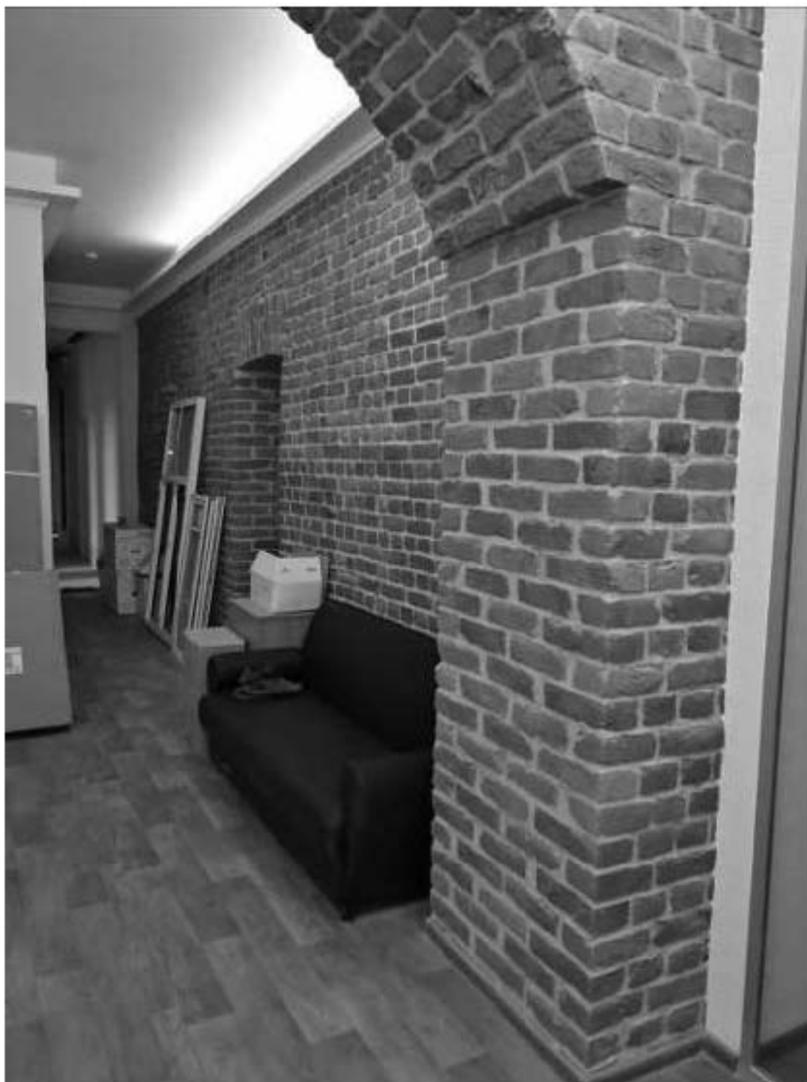
98. «Дом Н.Я. и Ф.Я. Колобовых». Санкт-Петербург, Большой пр. П.С., 16-18; Красного курсанта ул., д.1; Пионерская ул., д.6, литера А. Большой пр. П.С., 18. 3-й этаж. Фрагмент помещения 17-Н. Фото: 21.03. 2023.
