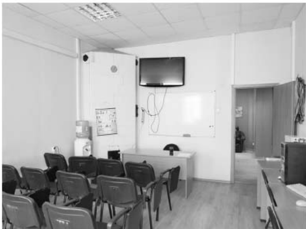
189. «Дом Н.Я. и Ф.Я. Колотовых». Санкт-Петербург; Большой пр. П.С., 16-18; Красного курсанта ул., д.1; Пионерская ул., д.6, литера А. Большой пр. П.С., 18. 4-й этаж. Фрагмент помещения 18-Н. Печь угловая. Фото: 21.03. 2023.
