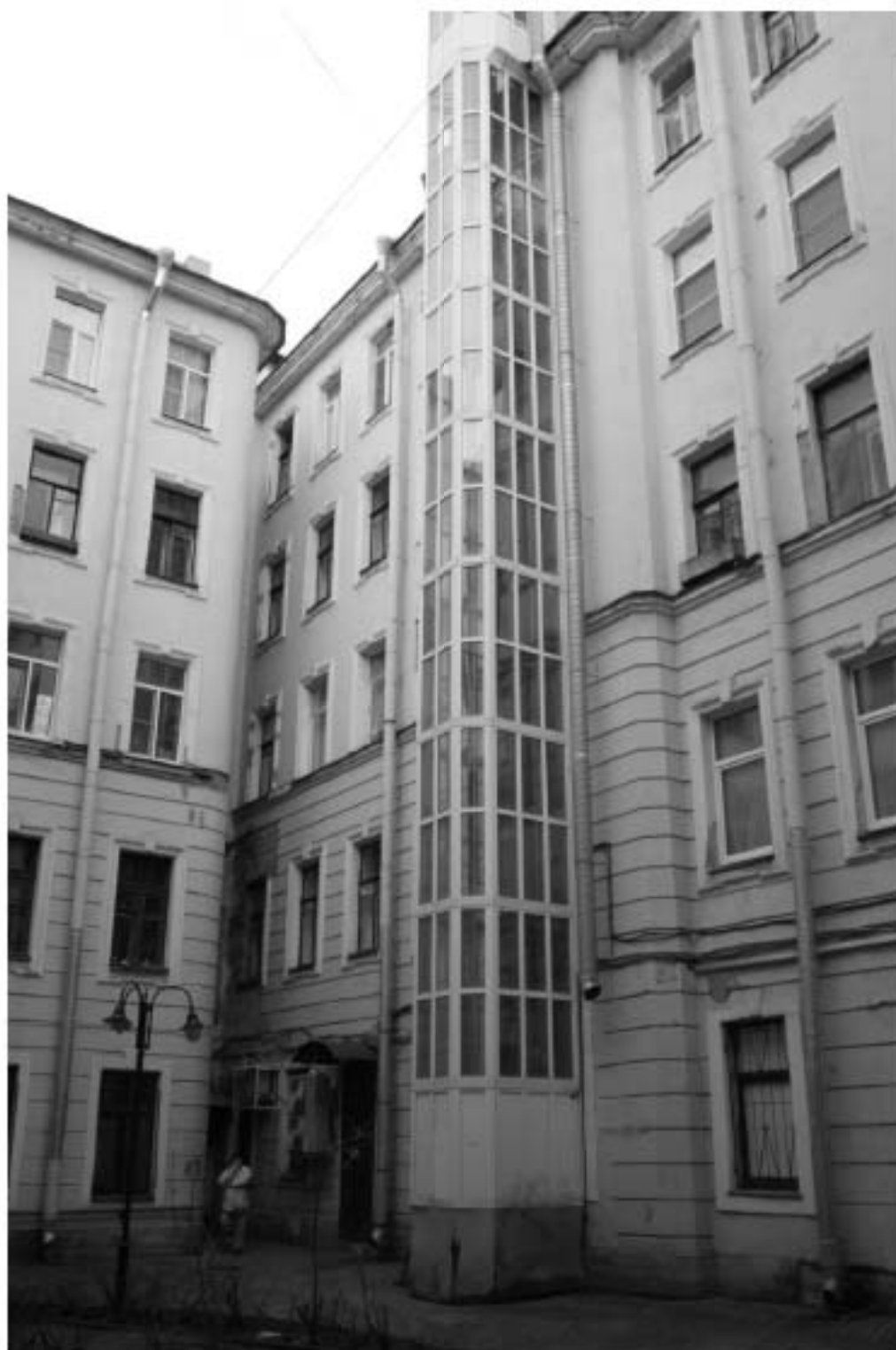
27. «Дом Н.Я. и Ф.Я. Колобовых». Санкт-Петербург, Большой пр. П.С., 16-18; Красного курсанта ул., д.1; Пионерская ул., д.6, литера А. Фрагмент лицевого корпуса ро Большому пр. П.С. со стороны двора. Фото: 21.03. 2023.
