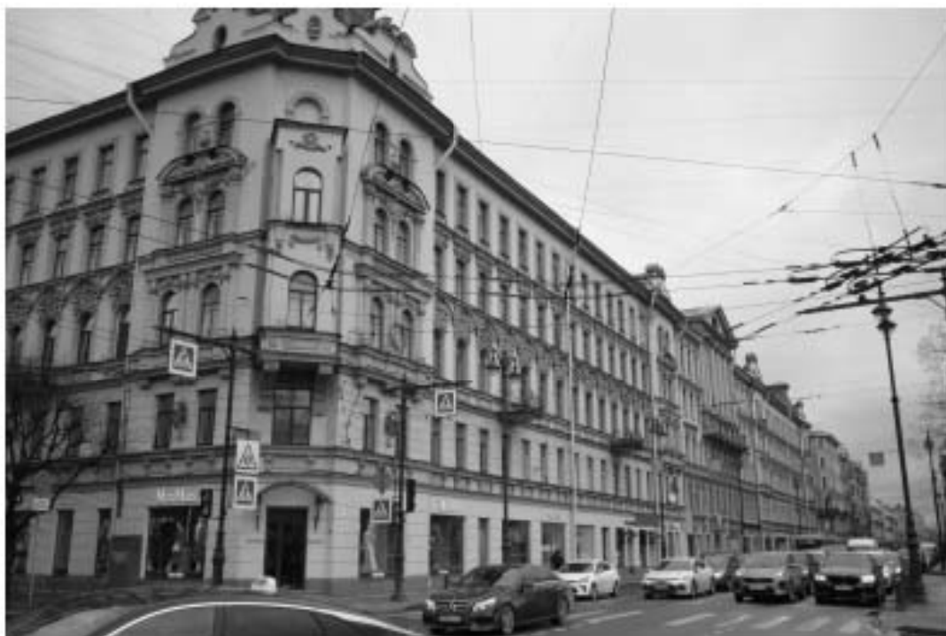
2. «Дом Н.Я. и Ф.Я. Колобовых». Санкт-Петербург, Большой пр. П.С., 16-18; Красного курсанта ул., д.1; Пионерская ул., д.6, литера А. Вид на лицевые фасады по Большому пр., П.С. и ул. Красного курсанта. Фото: 21.03.2023.
