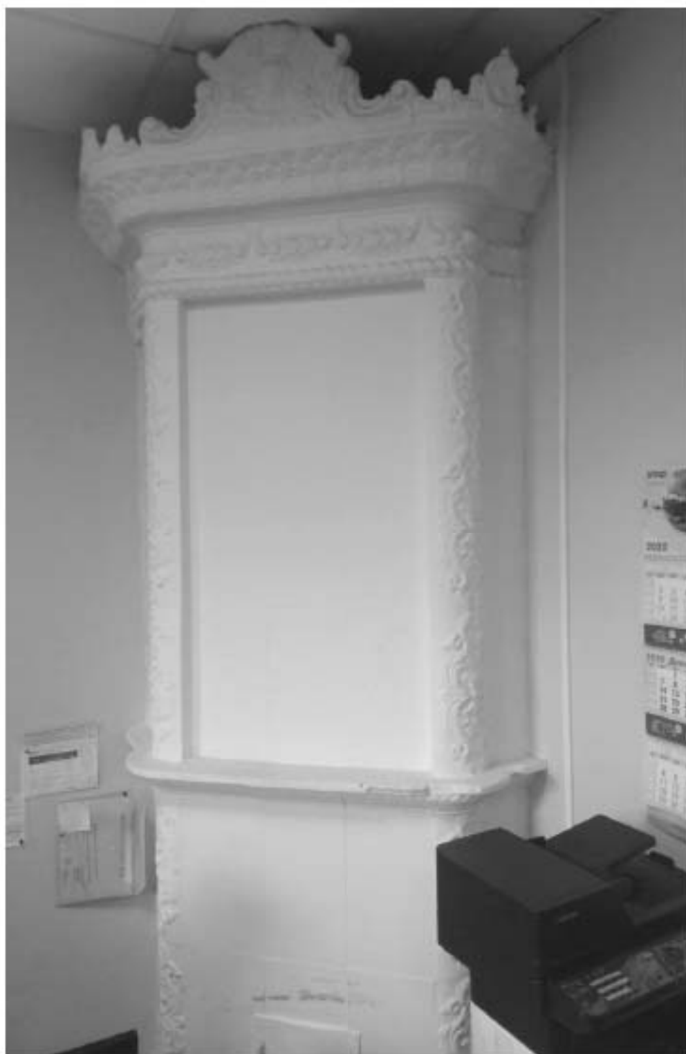
139. «Дом Н.Я. и Ф.Я. Колобовых». Санкт-Петербург, Большой пр. П.С., 16-18; Красного курсанта ул., д.1; Пионерская ул., д.6, литера А. Большой пр. П.С., 18. 4-й этаж. Фрагмент помещения 7-Н. Печь угловая двухъярусная. Фото: 21.03. 2023.
