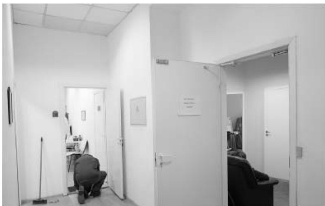
45. «Дом Н.Я. и Ф.Я. Колбозыло». Санкт-Петербург, Большой пр. П.С., 16-18; Красного курсанта ул., д.1; Пионерская ул., д.6, литера А. Большой пр. П.С., 18. 2-й этаж. Фрагмент помещения 6-Н. Фото: 21.03. 2023.
