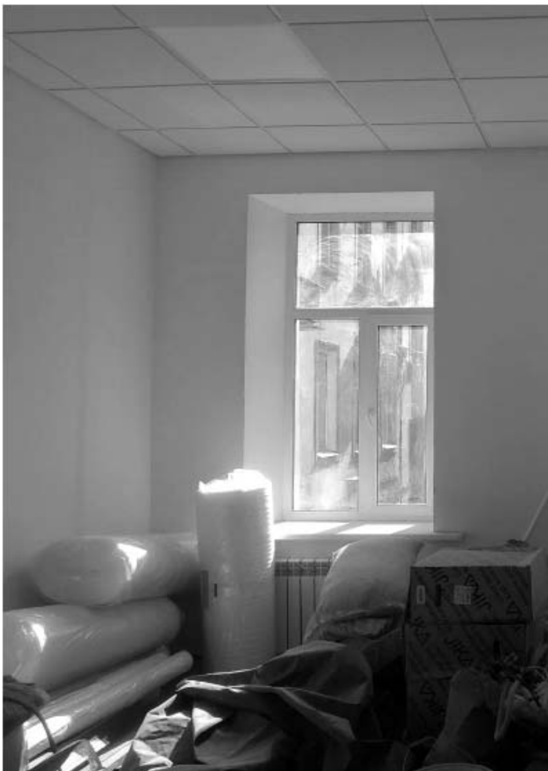
99. «Дом Н.Я. и Ф.Я. Колобовых». Санкт-Петербург, Большой пр. П.С., 16-18; Красного курсанта ул., д. 1; Пионерская ул., д.6, литера А. Большой пр. П.С., 18. 3-й этаж. Фрагмент помещения 17-Н. Фото: 21.03. 2023.
