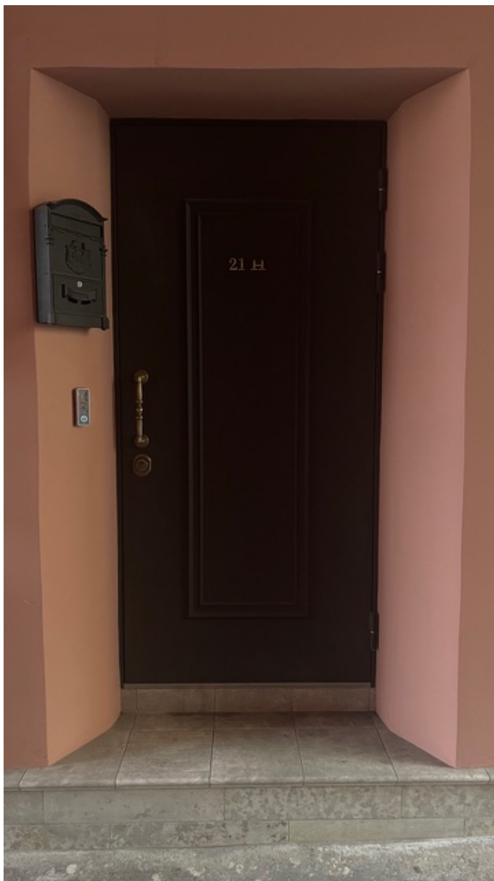
3. Вид на входную дверь в помещение;
