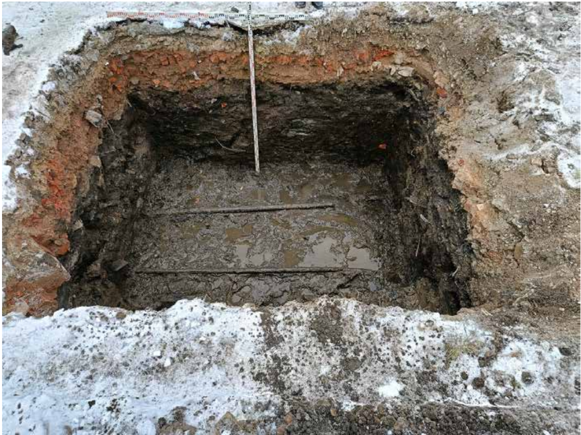
Рис. 82. СПб-2024. Октябрьская наб., 38. Шурфы 3-4, фиксация по уровню окончания работ, вид на юго-запад.
