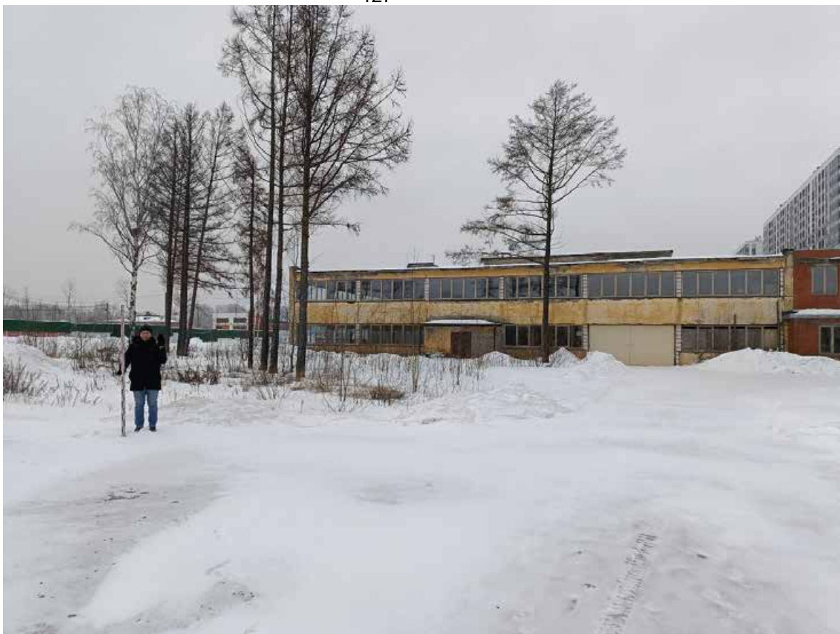
Рис. 34. СПб-2024. Октябрьская наб., 38. Точка фотофиксации 6, вид на север.
