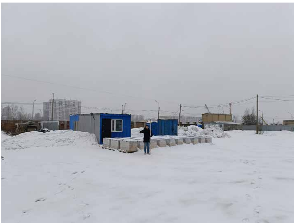
Рис. 39. СПб-2024. Октябрьская наб., 38. Точка фотофиксации 7, вид на запад.
