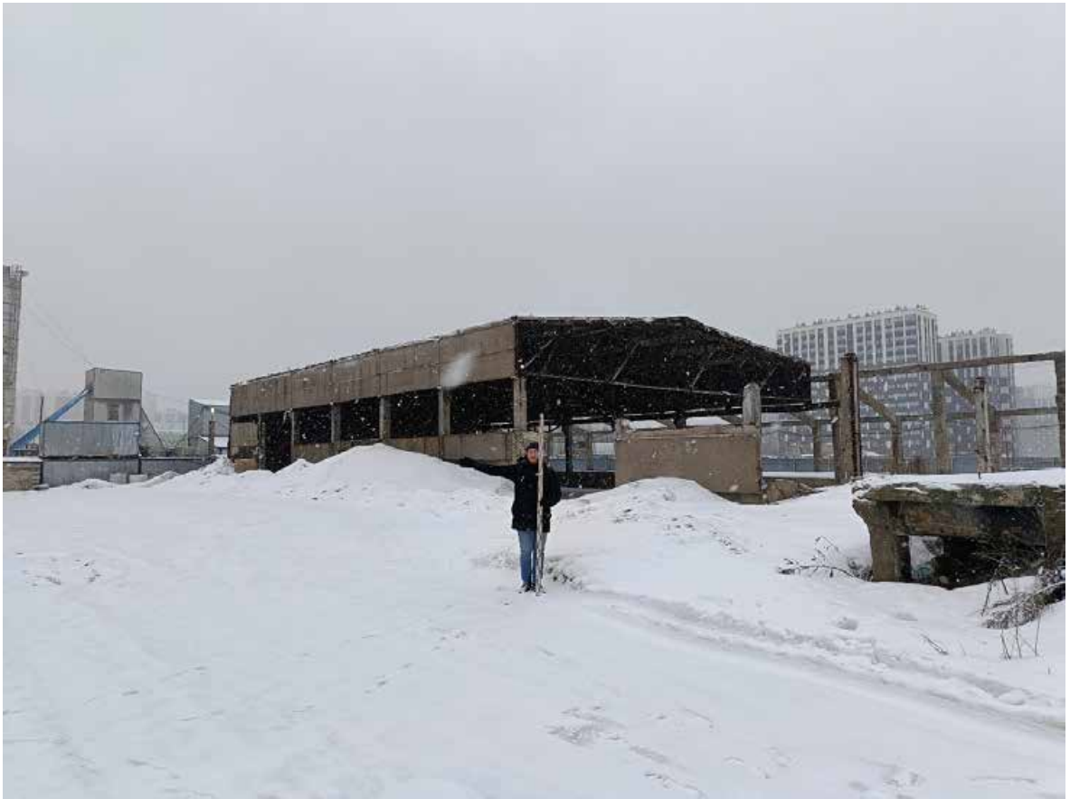
Рис. 54. СПб-2024. Октябрьская наб., 38. Точка фотофиксации 12, вид на восток.
