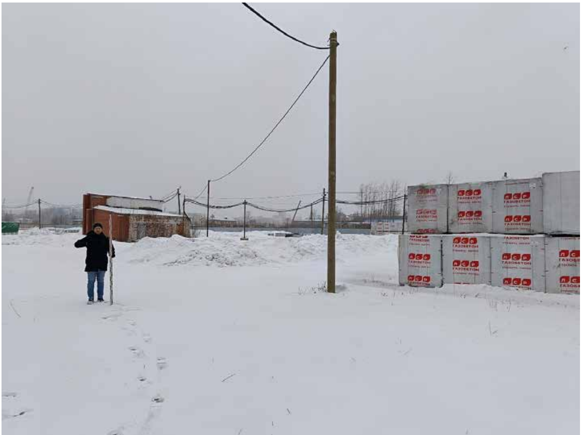
Рис. 31. СПб-2024. Октябрьская наб., 38. Точка фотофиксации 5, вид на запад.
