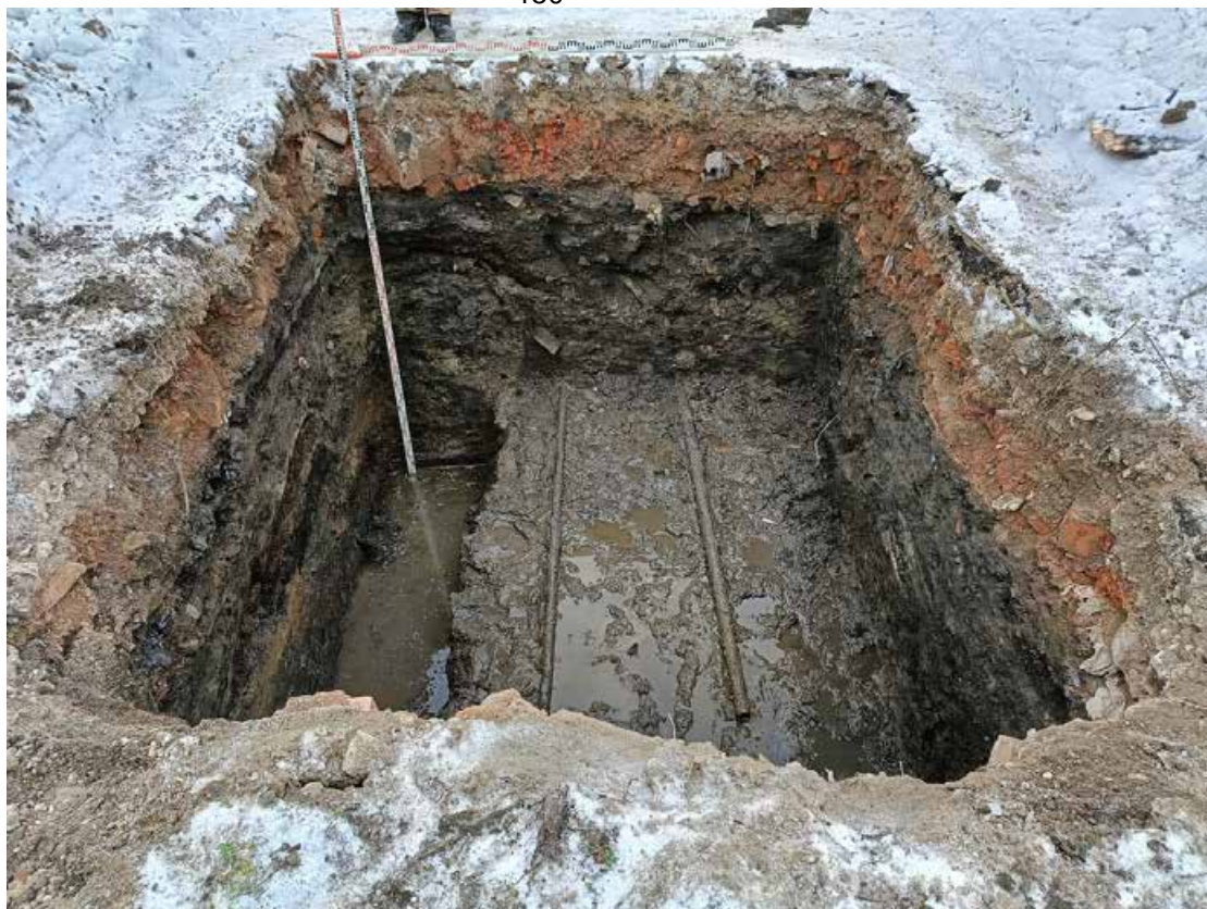
Рис. 80. СПб-2024. Октябрьская наб., 38. Шурфы 3-4, фиксация по уровню окончания работ, вид на юго-восток.
