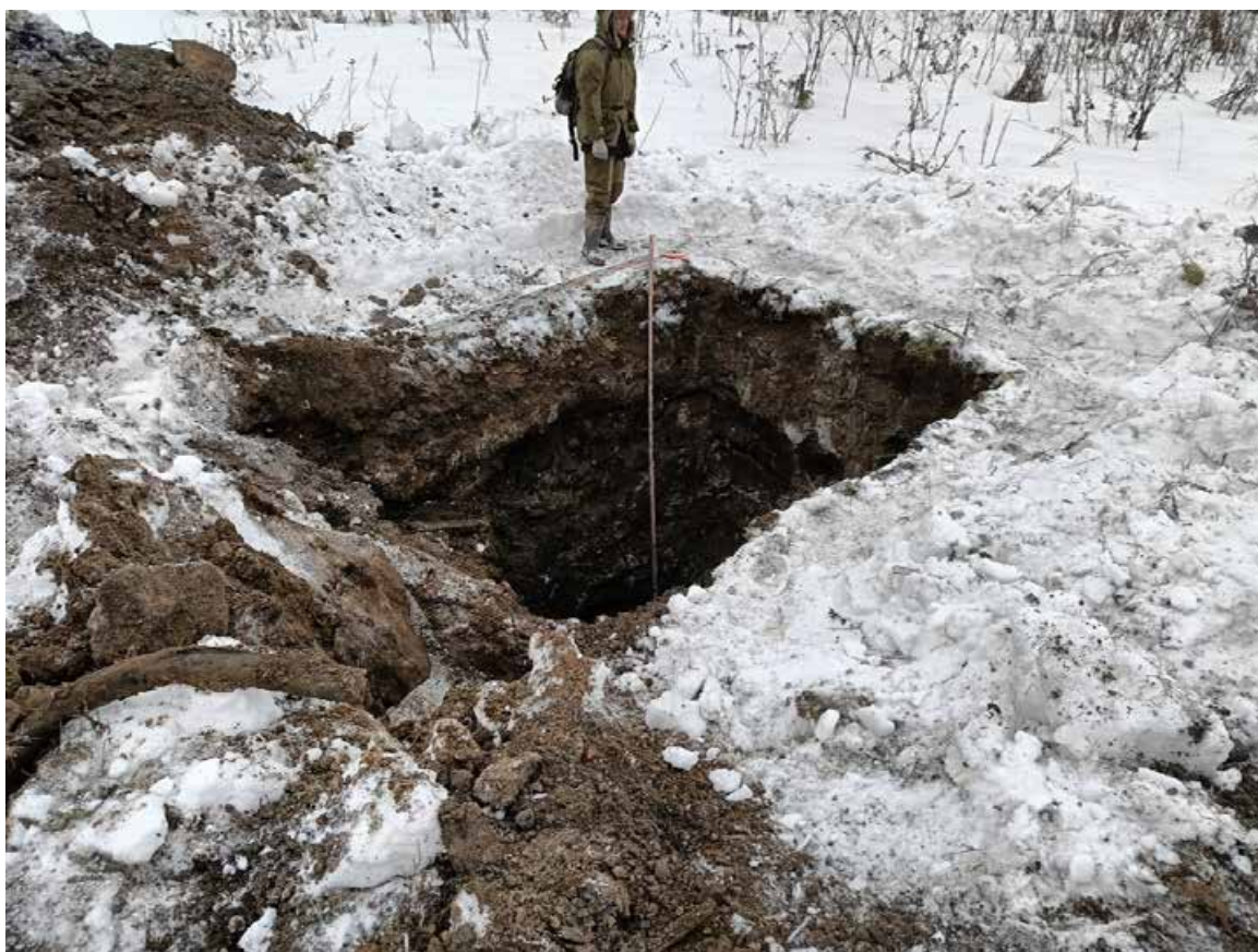
Рис. 87. СПб-2024. Октябрьская наб., 38. Шурф 5, фиксация по уровню окончания работ, вид на восток.
