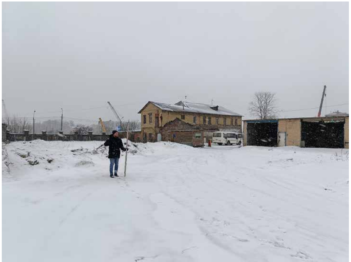
Рис. 49. СПб-2024. Октябрьская наб., 38. Точка фотофиксации 10, вид на запад.
