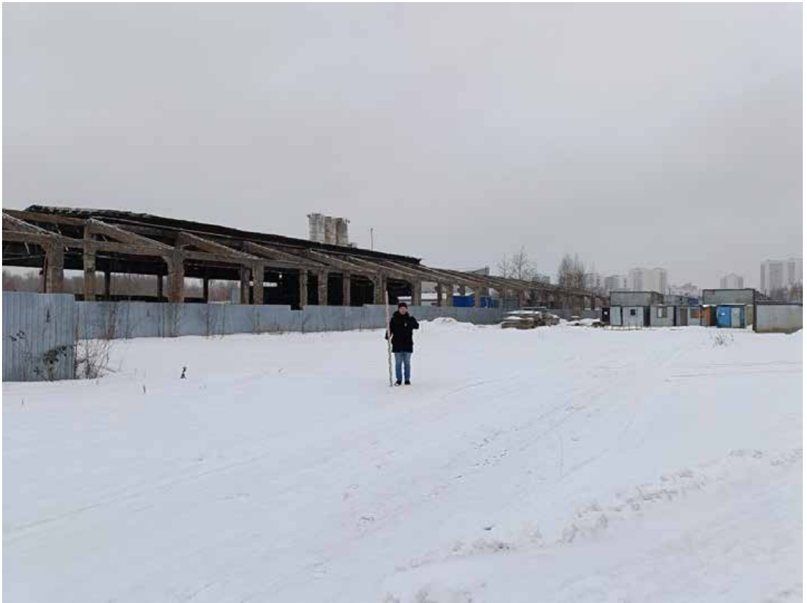
Рис. 24. СПб-2024. Октябрьская наб., 38. Точка фотофиксации 3, вид на север.
