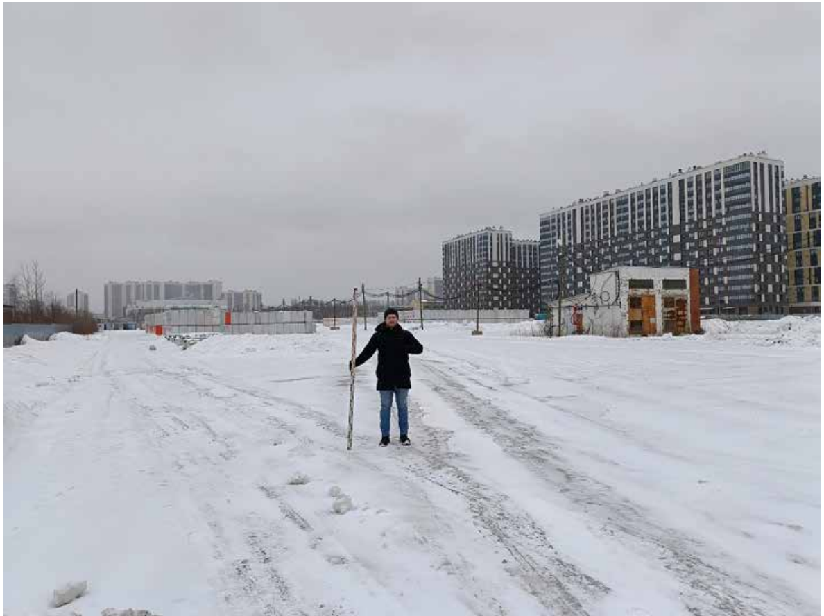
Рис. 18. СПб-2024. Октябрьская наб., 38. Точка фотофиксации 2, вид на восток.
