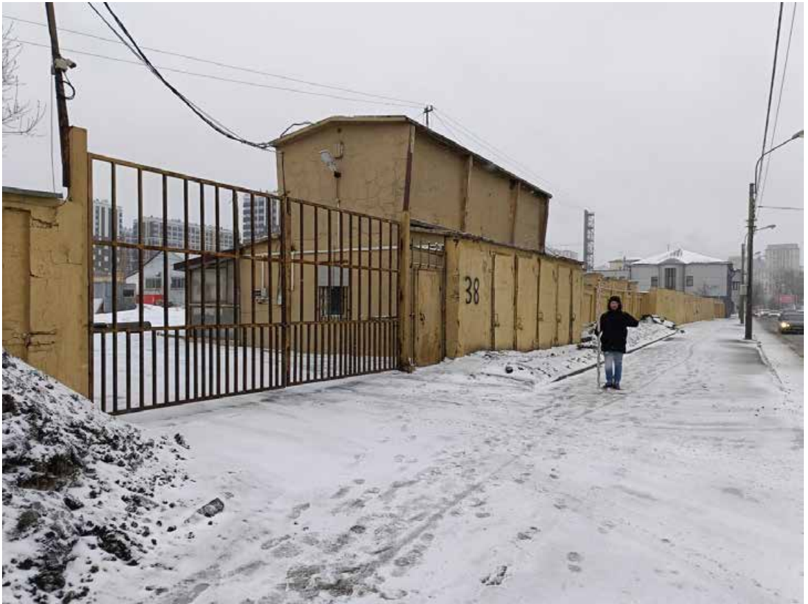
Рис. 44. СПб-2024. Октябрьская наб., 38. Точка фотофиксации 9, вид на восток.
