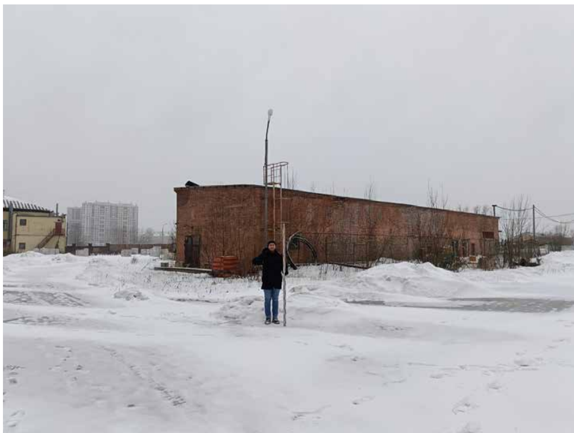
Рис. 35. СПб-2024. Октябрьская наб., 38. Точка фотофиксации 6, вид на запад.
