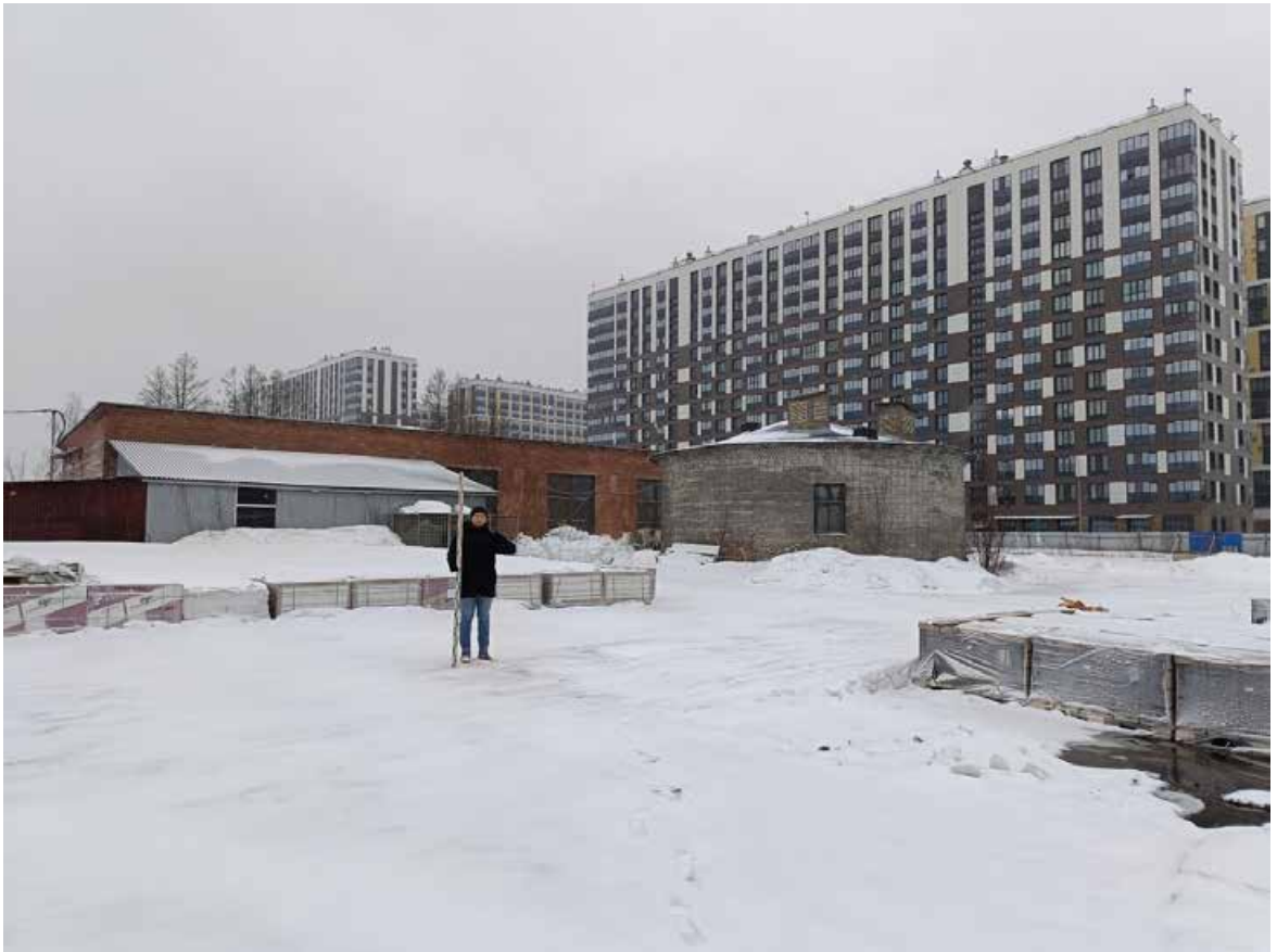
Рис. 36. СПб-2024. Октябрьская наб., 38. Точка фотофиксации 7, вид на восток.
