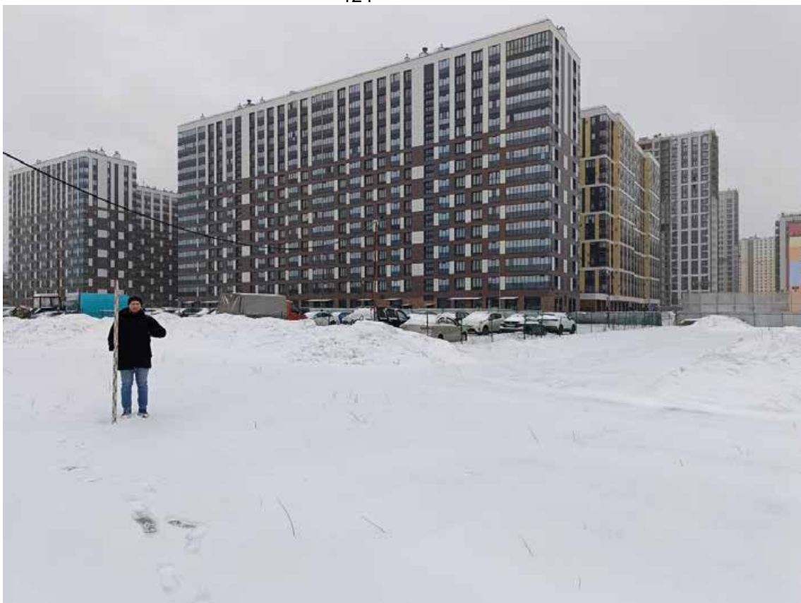
Рис. 28. СПб-2024. Октябрьская наб., 38. Точка фотофиксации 5, вид на восток.
