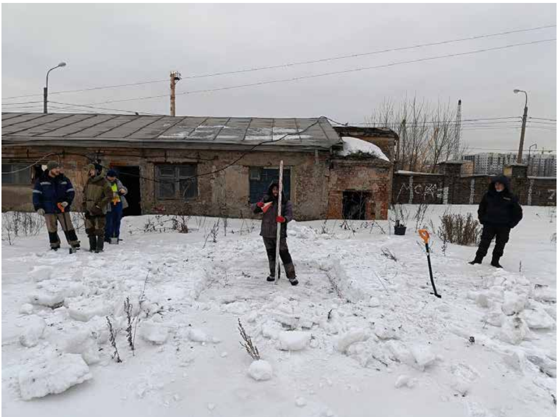
Рис. 73. СПб-2024. Октябрьская наб., 38. Местоположение шурфов 3-4, вид на северо-запад.
