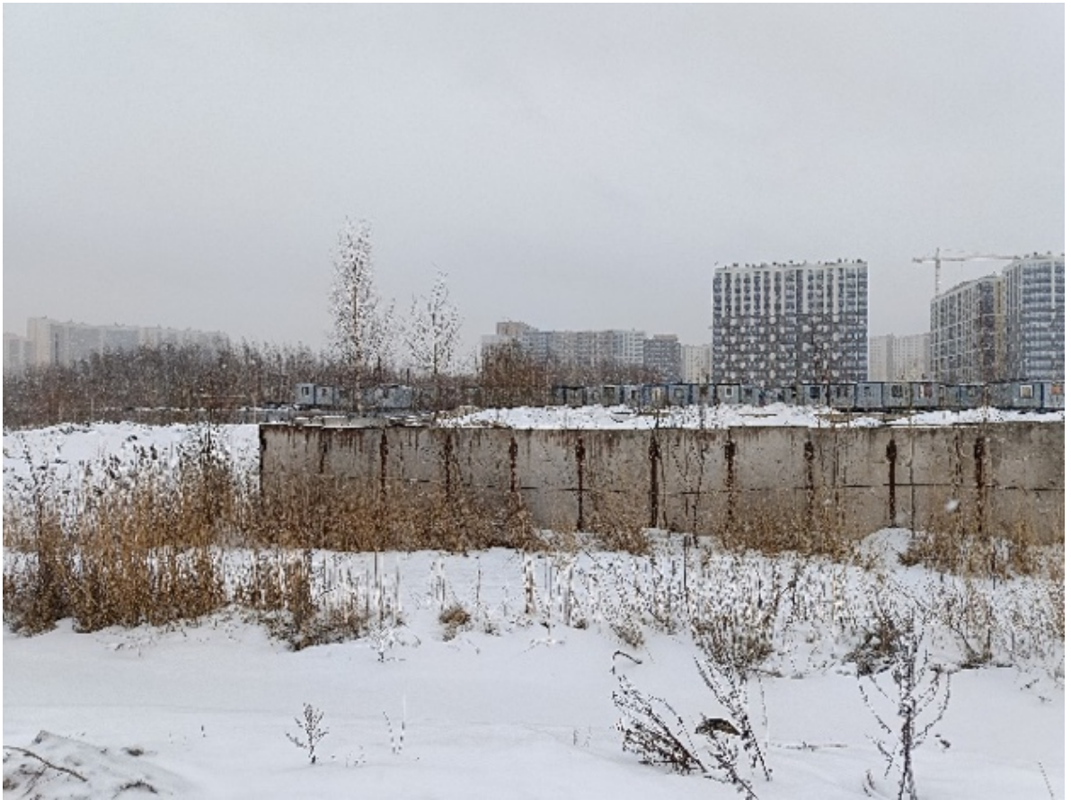
Рис. 58. СПб-2024. Октябрьская наб., 38. Точка фотофиксации 13, вид на восток.
