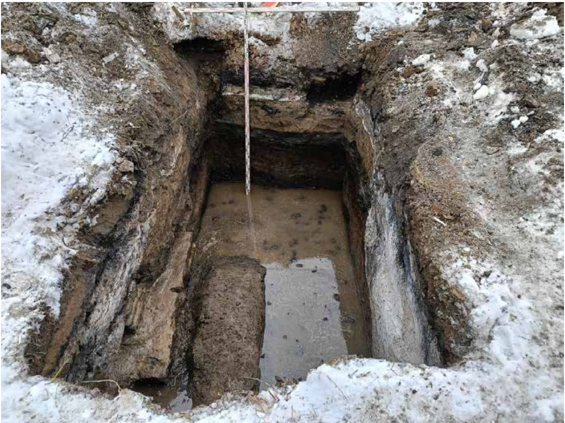
Рис. 65. СПб-2024. Октябрьская наб., 38. Шурфы 1-2, фиксация по уровню окончания работ, вид на северо-запад.
