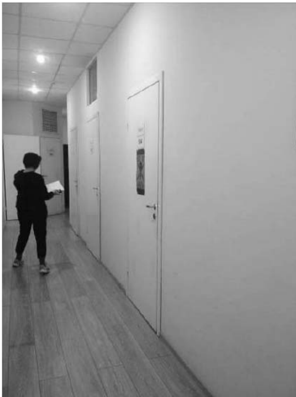
239. «Дом Н.Я. и Ф.Я. Колобовых». Санкт-Петербург, Большой пр. П.С., 16-18; Красного курсанта ул., д.1; Пионерская ул., д.6, литера А. Большой пр. П.С., 18. 5-й этаж. Фрагмент помещения 8-Н. Коридор. Фото: 21.03. 2023.
