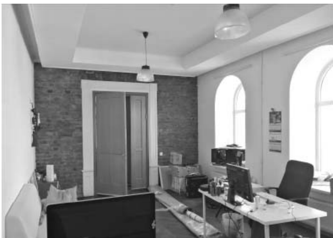
289. «Дом Н.Я. и Ф.Я. Колобова». Санкт-Петербург, Большой пр. П. С., 16-18; Красного курсанта ул., д.1; Пионерская ул., д.6, литера А. Большой пр. П. С., 18. 5-й этаж. Фрагмент помещения 26-Н. Фото: 21.03. 2023.
