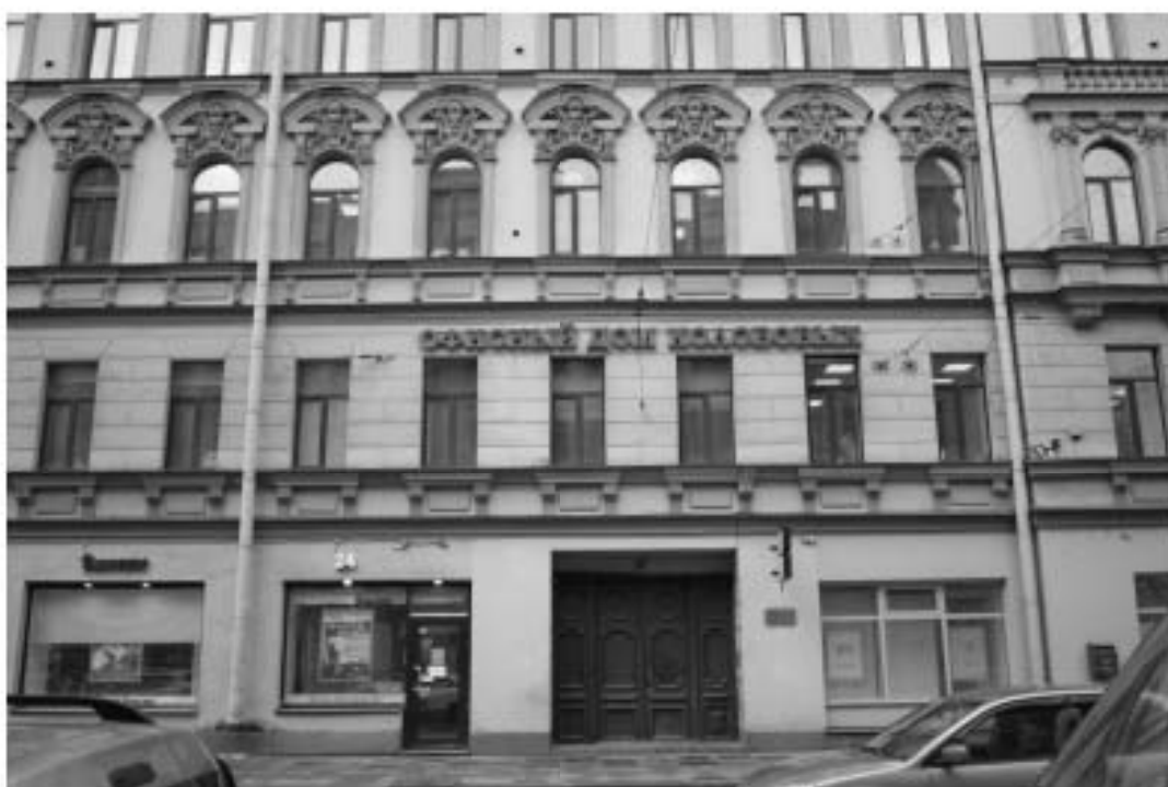
13. «Дом Н.Я. и Ф.Я. Колобовых». Санкт-Петербург, Большой пр. П.С., 16-18; Красно го курсанта ул., д.1; Пионерская ул., д.6, литера А. Лицевой фасад по Большому пр., П.С. Фрагмент. Фото: 21.03.2023.
