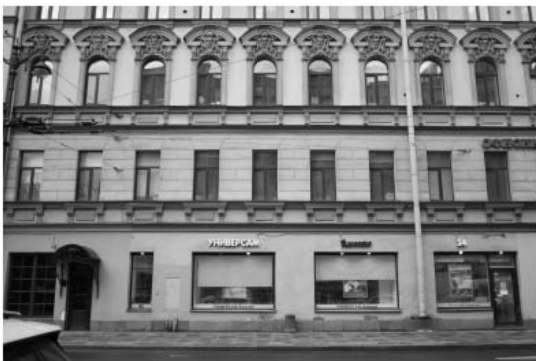
12. «Дом Н.Я. и Ф.Я. Колобовых». Санкт-Петербург, Большой пр. П.С., 16-18; Красно го курсанта ул., д.1; Пионерская ул., д.6, литера А. Лицевой фасад по Большому пр., П.С. Фрагмент. Фото: 21.03.2023.
