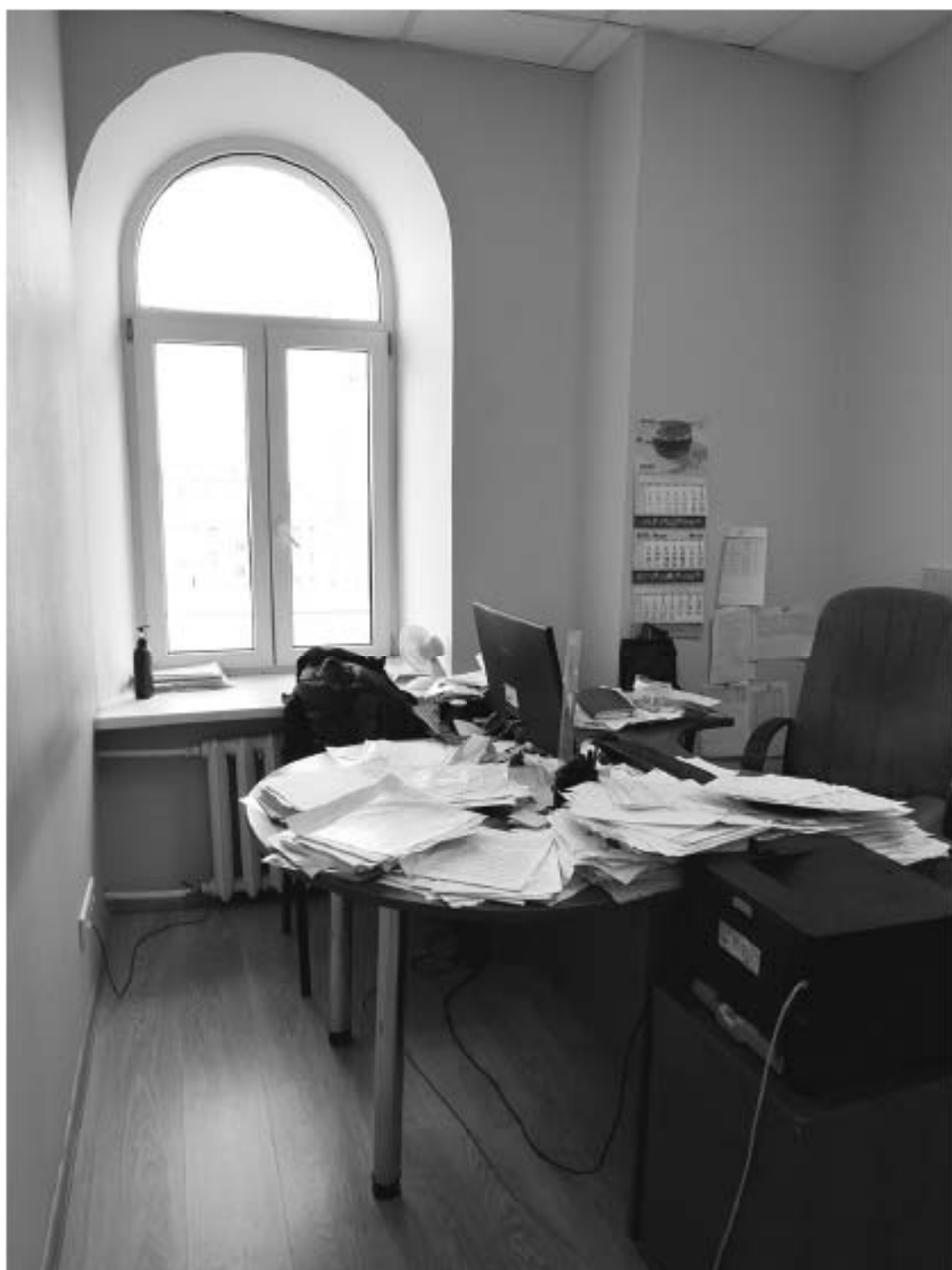
141. «Дом Н.Я. и Ф.Я. Колобовых». Санкт-Петербург; Большой пр. П.С., 16-18; Красного курсанта ул., д.1; Пионерская ул., д.6, литера А. Большой пр. П.С., 18. 4-й этаж. Фрагмент помещения 7-Н. Фото: 21.03. 2023.
