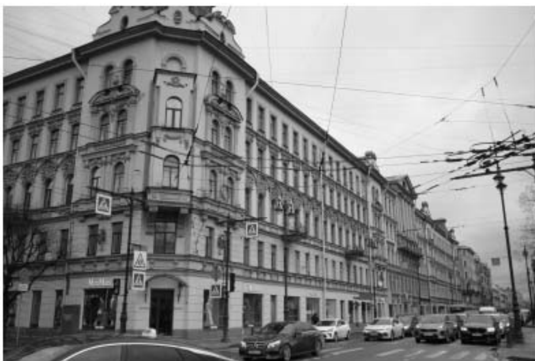
2. «Дом Н.Я. и Ф.Я. Колобовых». Санкт-Петербург, Большой пр. П.С., 16-18; Красногурская ул., д.1; Пионерская ул., д.6, литера А. Вид на лицевые фасады по Большому пр., П.С. и ул. Красногурская. Фото: 21.03.2023.
