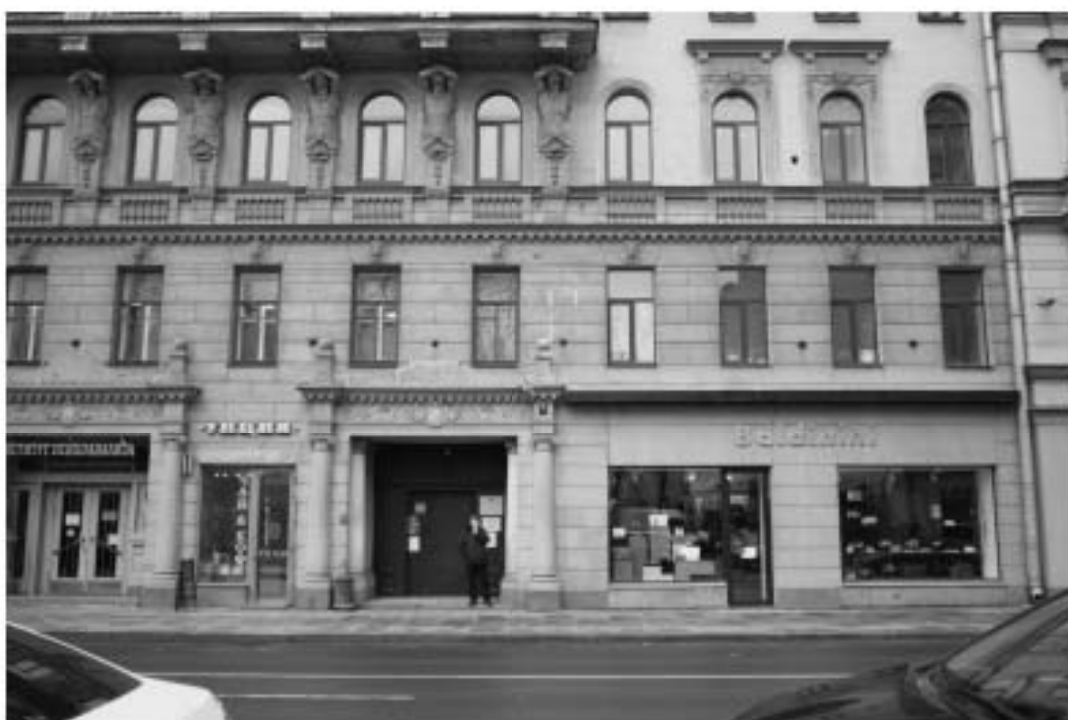
9. «Дом Н.Я. и Ф.Я. Колобовых». Санкт-Петербург, Большой пр. П.С., 16-18; Красного курсанта ул., д.1; Пионерская ул., д.6, литера А. Лицевой фасад по Большому пр., П.С. Фрагмент. Фото: 21.03.2023.
