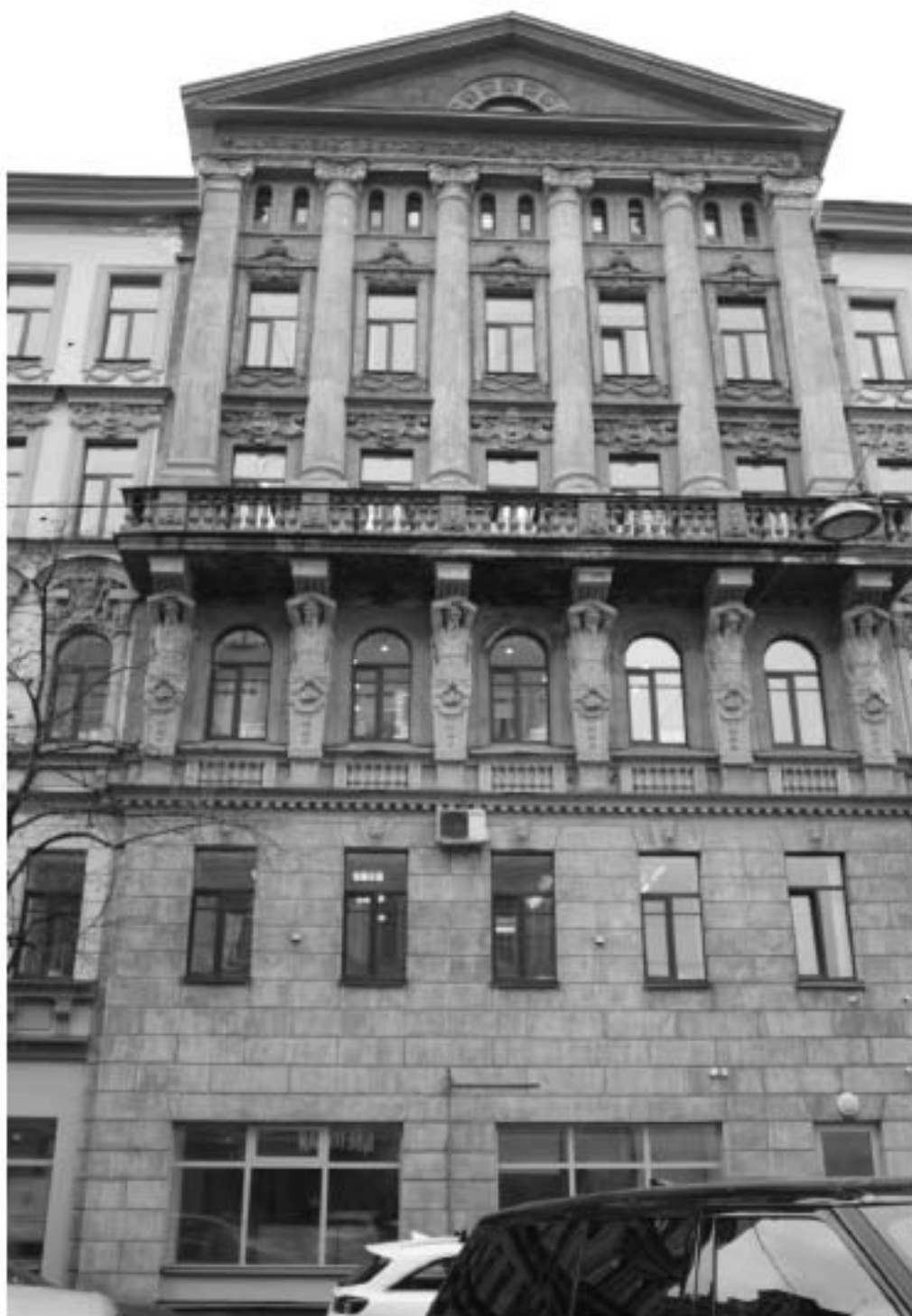
19. «Дом Н.Я. и Ф.Я. Колобовых». Санкт-Петербург, Большой пр. П.С., 16-18; Красного курсанта ул., д.1; Пионерская ул., д.6, литера А. Лицевой фасад по Пионерской ул. Фрагмент. Фото: 21.03. 2023.
