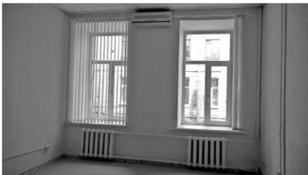
20. «Дом Н.Я. и Ф.Я. Колобова». Санкт-Петербург, Большой пр. П.С., 16-18; Красного курсанта ул., д.1; Пионерская ул., д.6, литера А. Большой пр. П.С., 18. 2-й этаж. Фрагмент помещения 6-Н. Фото: 21.03. 2023.
