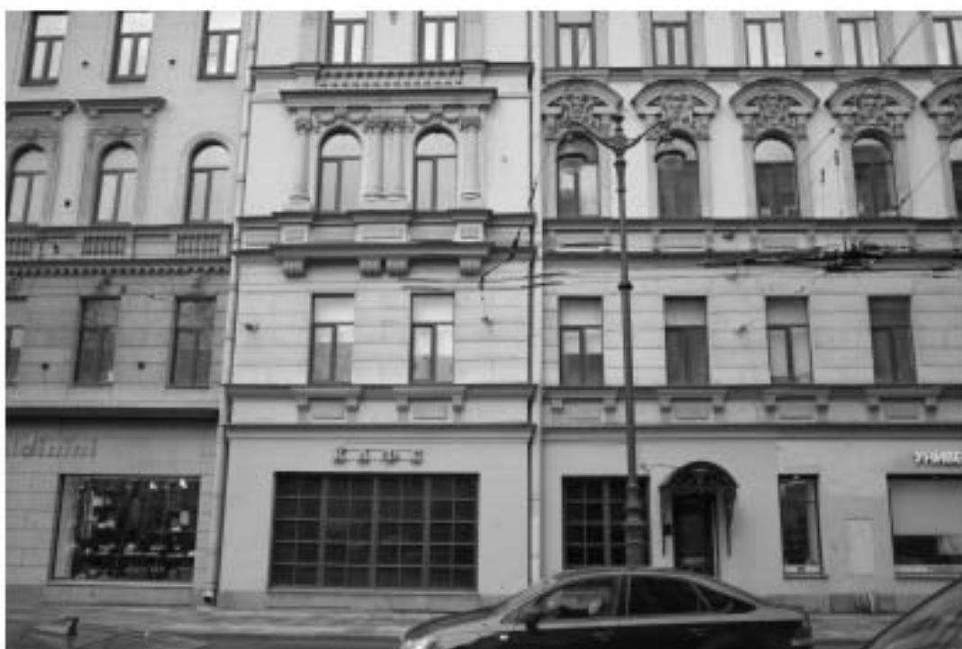
10. «Дом Н.Я. и Ф.Я. Колобовых». Санкт-Петербург, Большой пр. П.С., 16-18; Красного курсафта ул., д.1; Пионерская ул., д.6, литера А. Лицевой фасад по Большому пр., П.С. Фрагмент. Фото: 21.03.2023.
