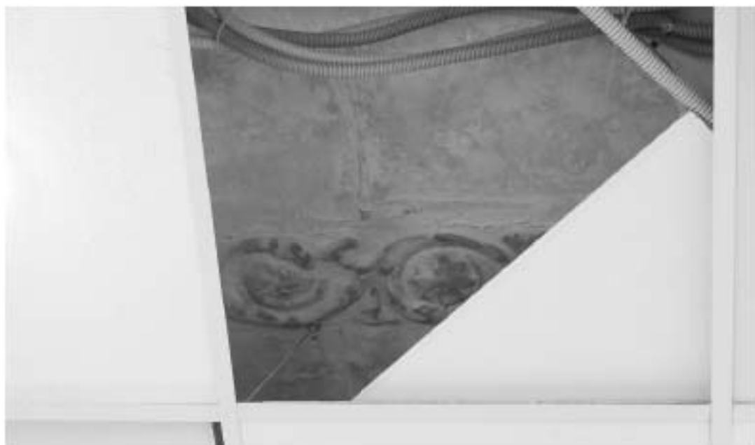
54. «Дом Н.Я. и Ф.Я. Колобова». Санкт-Петербург, Большой пр. П.С., 16-18; Красного курсанта ул., д.1; Пионерская ул., д.6, литера А. Большой пр. П.С., 18. 2-й этаж. Помещение 6-Н. Фрагмент потолка. Фото: 21.03. 2023.
