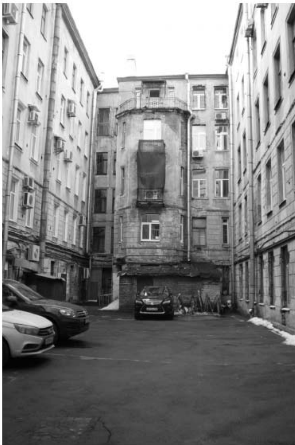
36. «Дом Н.Я. и Ф.Я. Колобовых». Санкт-Петербург, Большой пр. П.С., 16-18; Красного курсанта ул., д.1; Пионерская ул., д.6, литера А. Фрагмент фасадов дворовых корпусов. Фото: 21.03. 2023.
