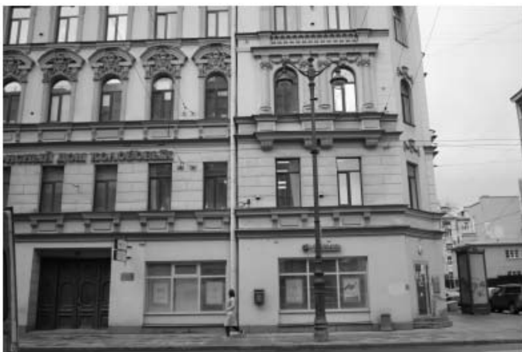
14. «Дом Н.Я. и Ф.Я. Колобовых». Санкт-Петербург, Большой пр. П.С., 16-18; Красно го курсанта ул., д.1; Пионерская ул., д.6, литера А. Лицевой фасад по Большому пр., П.С. Фрагмент. Фото: 21.03.2023.
