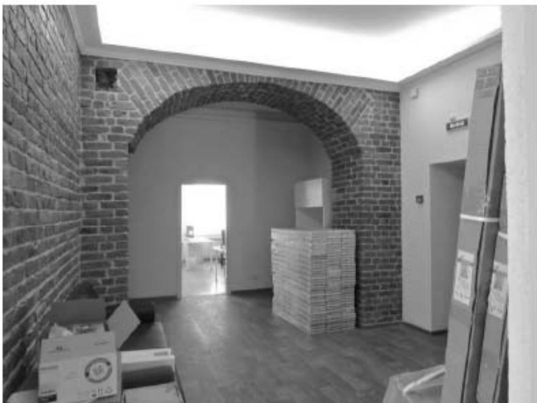
95. «Дом Н.Я. и Ф.Я. Колобовых». Санкт-Петербург, Большой пр. П. С., 16-18; Красного курсанта ул., д.1; Пяперская ул., д.6, литера А. Большой пр. П. С., 18. 3-й этаж. Фрагмент помещения 17-Н. Фото: 21.03. 2023.
