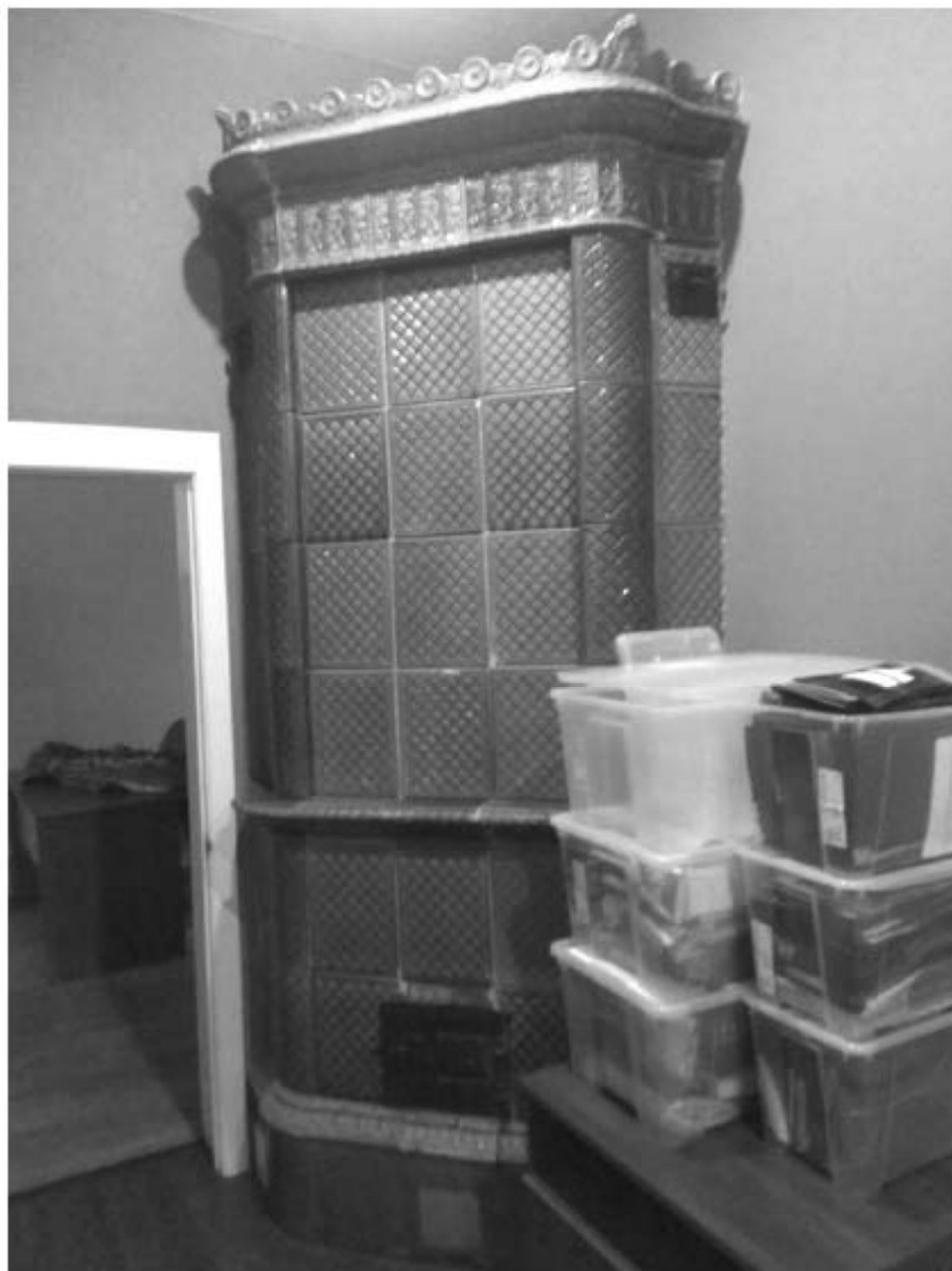
225. «Дом Н.Я. и Ф.Я. Колобовых». Санкт-Петербург, Большой пр. П.С., 16-18; Красного курсанта ул., д.1; Пионерская ул., д.6, литера А. Большой пр. П.С., 18. 5-й этаж. Фрагмент помещения 8-Н. Печь угловая двухъярусная. Фото: 21.03. 2023.
