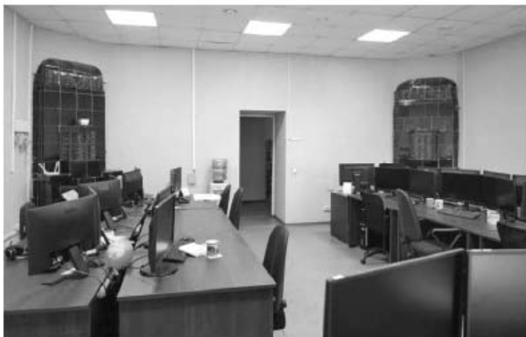
251. «Дом Н.Я. и Ф.Я. Колобова». Санкт-Петербург, Большой пр. П.С., 16-18; Красного курсанта ул., д.1; Пионерская ул., д.6, литера А. Большой пр. П.С., 18. 5-й этаж. Фрагмент помещения 8-Н. Две идентичные печи угловые двухъярусные. Фото: 21.03.2023.
