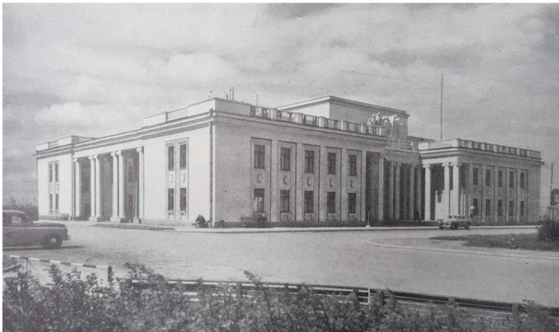
3. Ленинград. Здание аэровокзала. Общий вид. Фотография. 1951 г. Ежегодник «Советская архитектура». Том 3. 1951.
