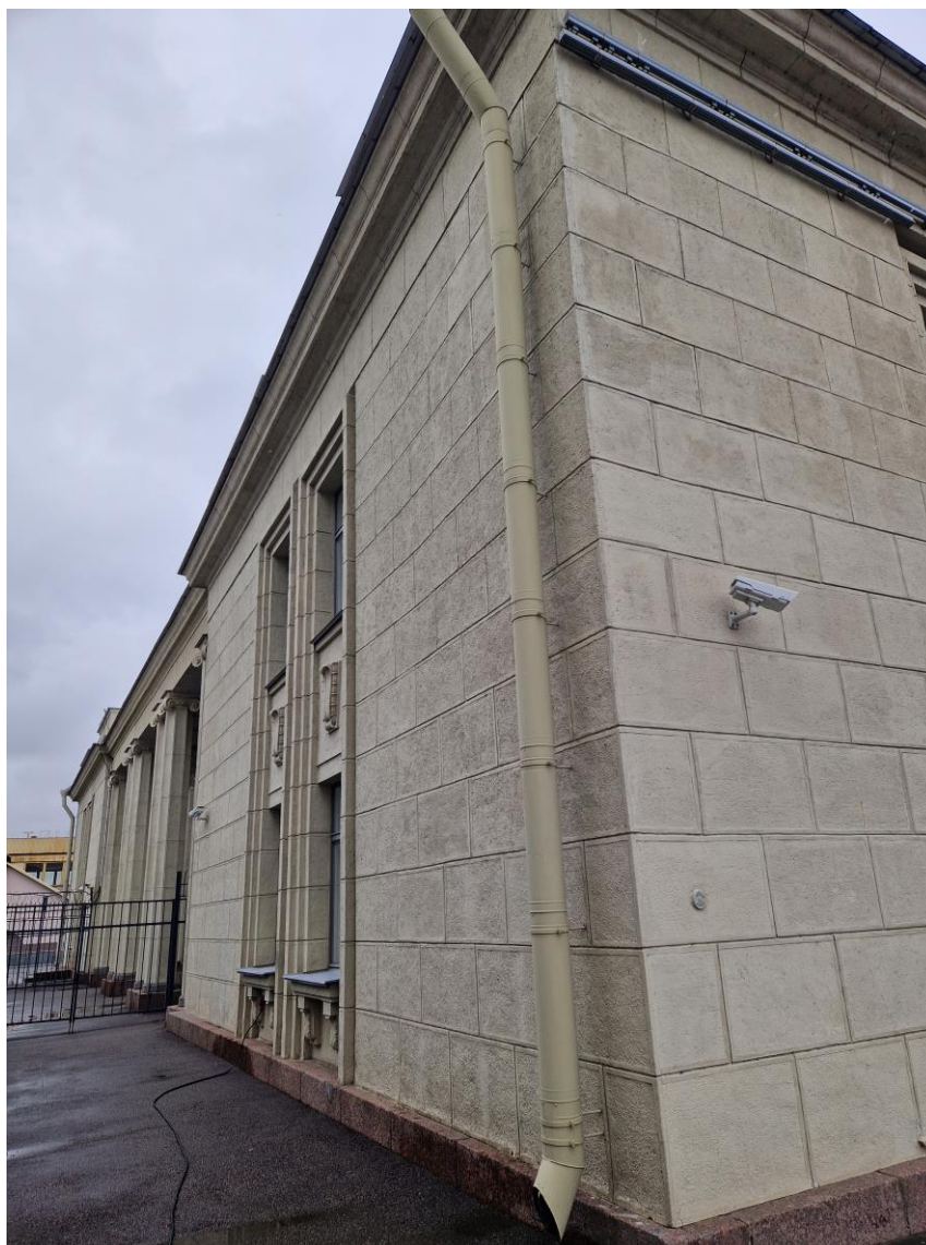
5. Выявленный объект культурного наследия «Здание аэровокзала» по адресу: г. Санкт-Петербург, ул. Стартовая, д. 17, лит. А (Пулково-2, аэропорт). Вид на юго-восточный фасад.
