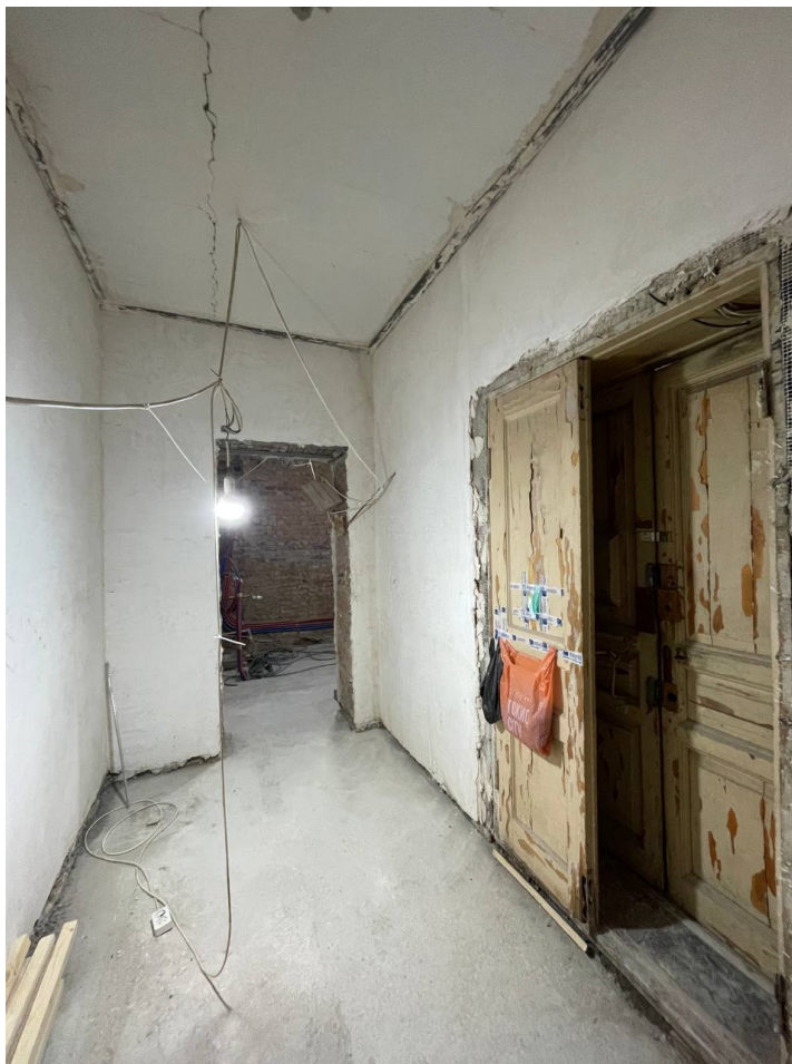
Фото 3. Вид на вход в квартиру №142
