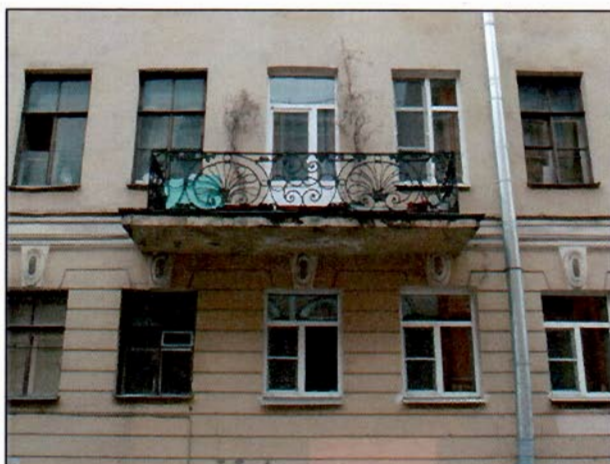
Фото 4. Фрагмент восточного фасада.
