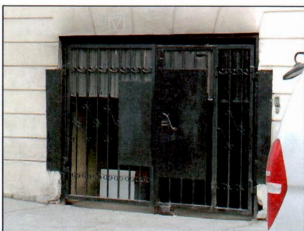
Фото 6. Воротный проезд юго-западного фасада
