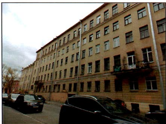
Фото 2. Восточный фасад со стороны ул. Средняя Подъяческая
