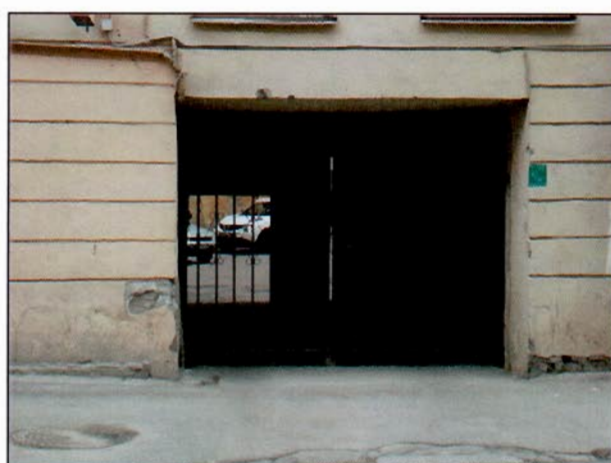
Фото 7. Воротный проезд восточного фасада.
