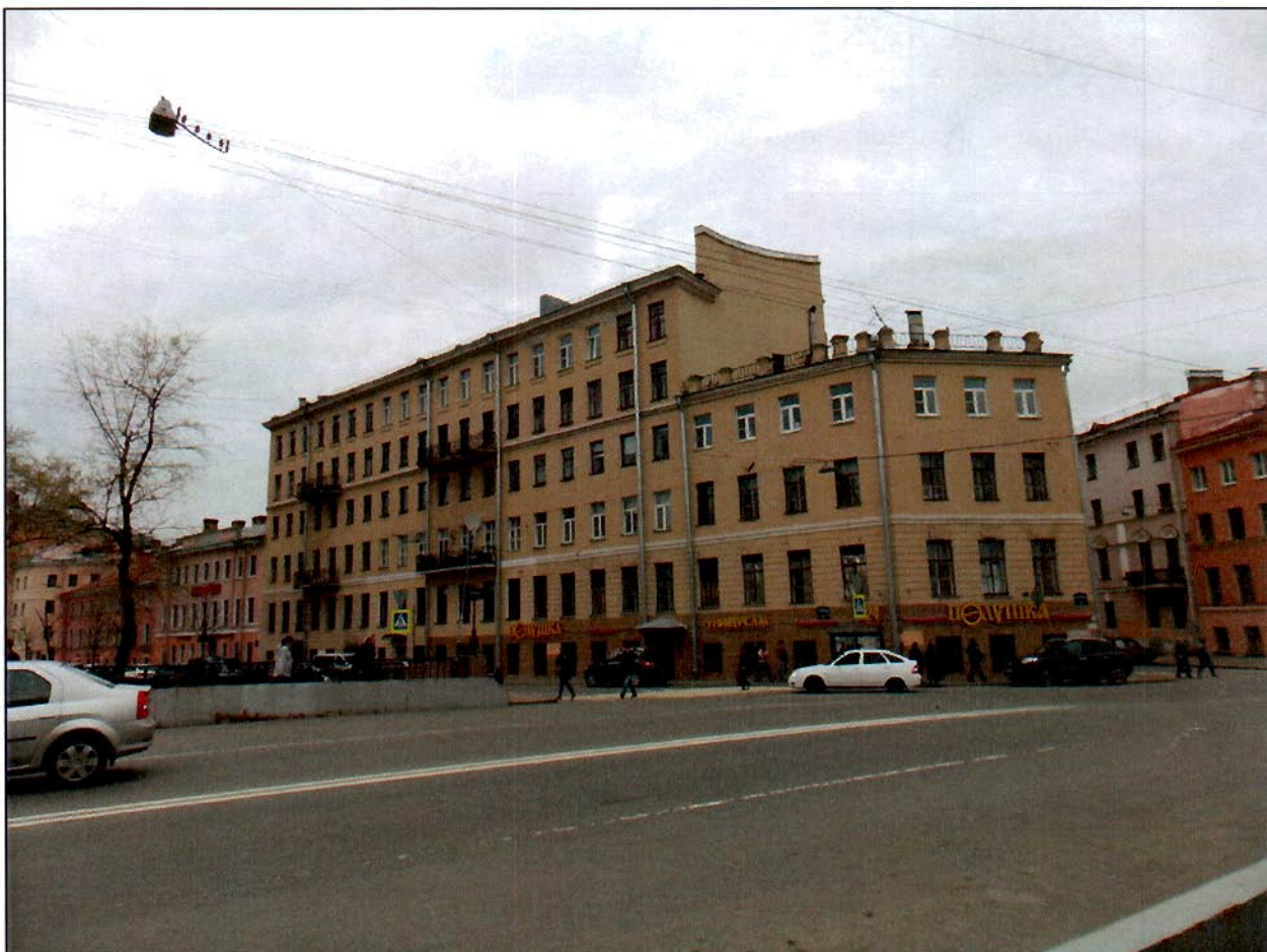
Фото 1. Юго-западный фасад со стороны канала Грибоедова.
