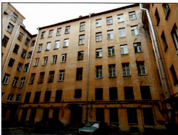
Фото 14. Южный дворовый фасад
