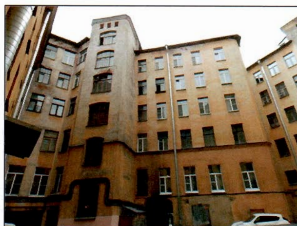
Фото 15. Восточный дворовый фасад.
