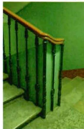
лестница (помещение Л-20): местоположение, габариты, тип (одномаршевая с поворотом), материал ступеней и конфигурация (лещадная плита с валиком); ограждение – местоположение, габариты, конфигурация, материал (металл), техника исполнения (литье), рисунок (вертикальные стойки с перехватами и растительным орнаментом).
