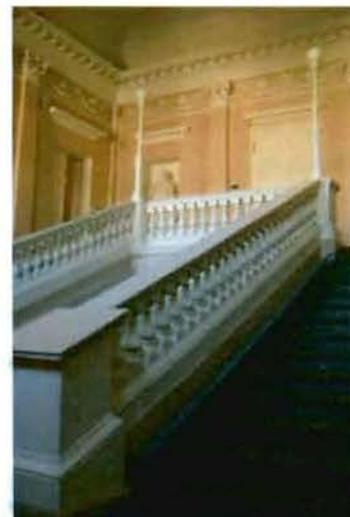
2-я Парадная лестница (помещение Л-16): историческое местоположение, конструкция (на косоурах и двух чугунных колоннах (в уровне 1-го этажа)), тип (маршевая с поворотом), габариты, материал и конфигурация ступеней (лещадная плита с валиком);
