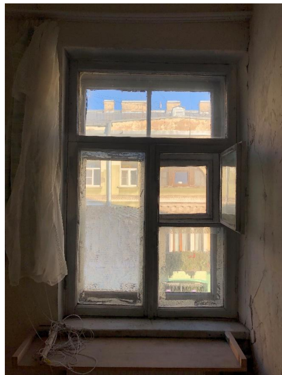
Фото 15. Заполнение оконного проема в помещении № 10.
