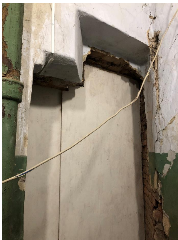
Фото 4. Ниша в помещении № 3.
