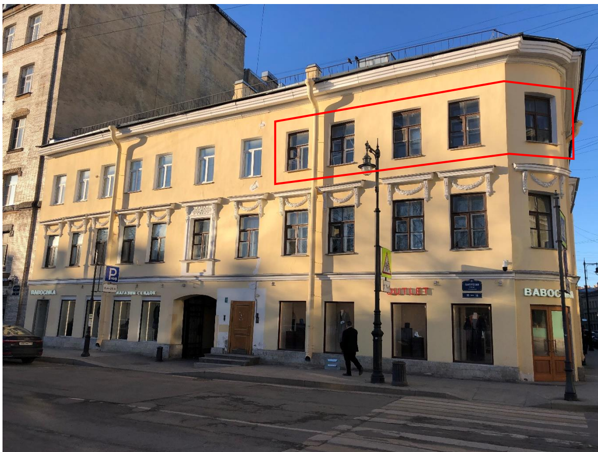
Фото 3. Лицевой фасад по Гангутской улице.
