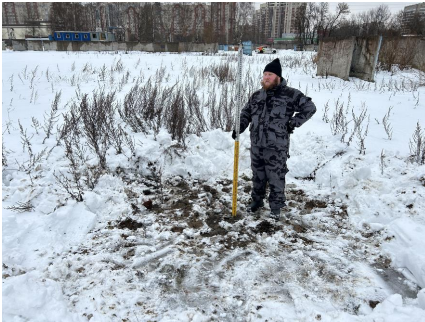
Илл. 47. Санкт-Петербург, Кондратьевский пр. Участок КН 78:10:0005171:3432. Место закладки шурфа 4. Вид с юга.
