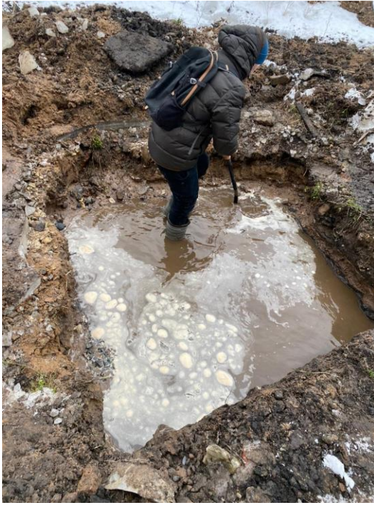
Илл. 43. Санкт-Петербург, Кондратьевский пр. Участок КН 78:10:0005171:3432. Шурф 3. рабочий момент. Вид с юго-запада.
