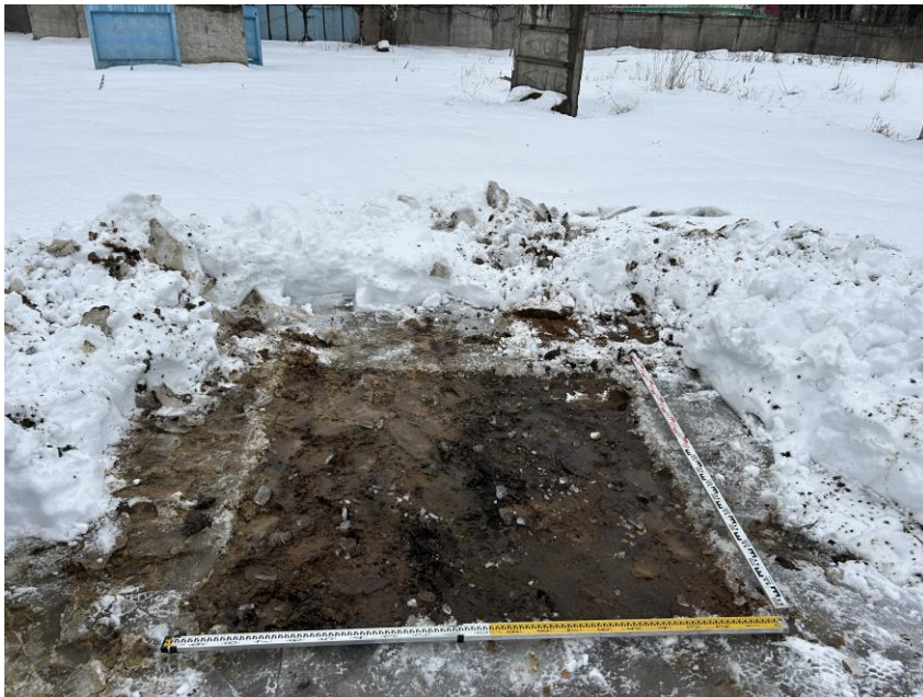
Илл. 35. Санкт-Петербург, Кондратьевский пр. Участок КН 78:10:0005171:3432. Шурф 2. Начало работ. Вид с юга.
