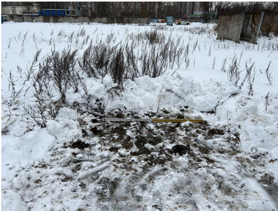
Илл. 48. Санкт-Петербург, Кондратьевский пр. Участок КН 78:10:0005171:3432. Шурф 4. Начало работ. Вид с юга.
