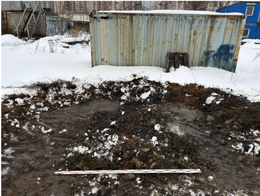
Илл. 33. Санкт-Петербург, Кондратьевский пр. Участок КН 78:10:0005171:3432. Шурф 1 после засыпки. Вид с юга.
