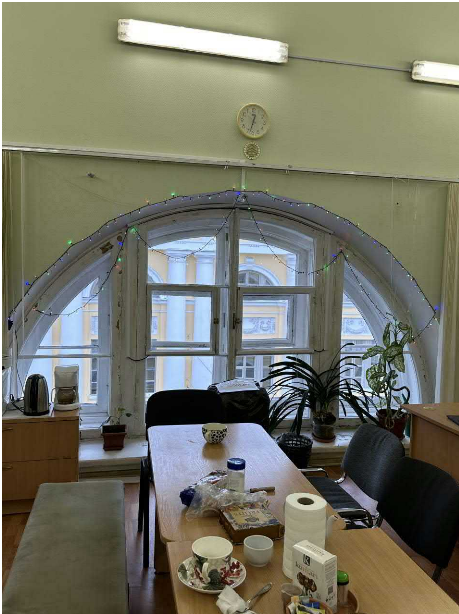
Фото 9. Вид окна ОК-3, в помещении 37-Н (ч.п. 76, 77)
