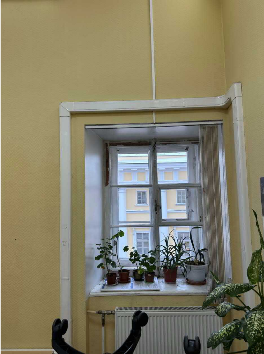
Фото 6. Вид окна ОК-5, в помещении 37-Н (ч.п. 29)
