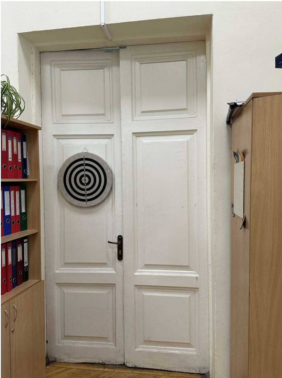
Фото 3. Вид двери Д-2 в помещении 37-Н (между ч.п. 24 и 15)
