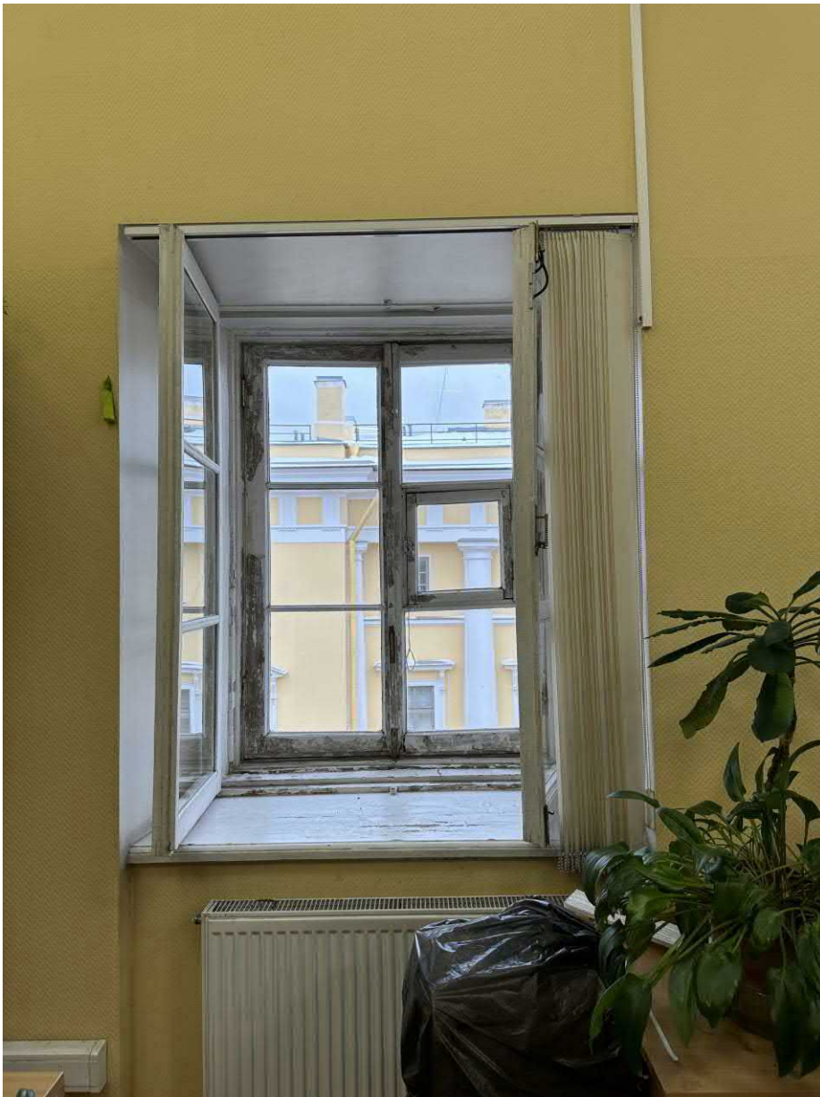
Фото 7. Вид окна ОК-6, в помещении 37-Н (ч.п. 28)
