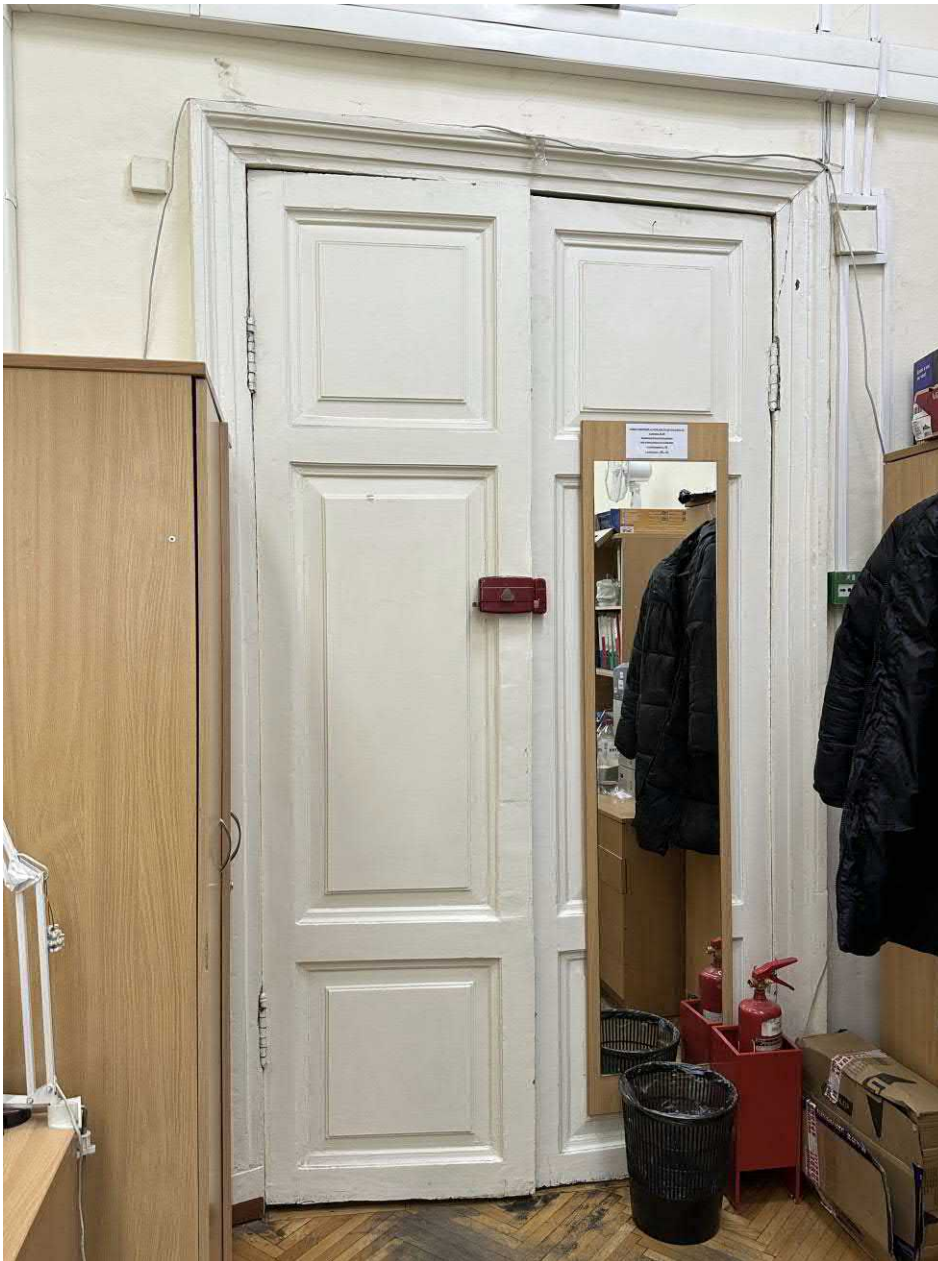
Фото 5. Вид двери Д-1 в помещении 37-Н (ч.п. 15)
