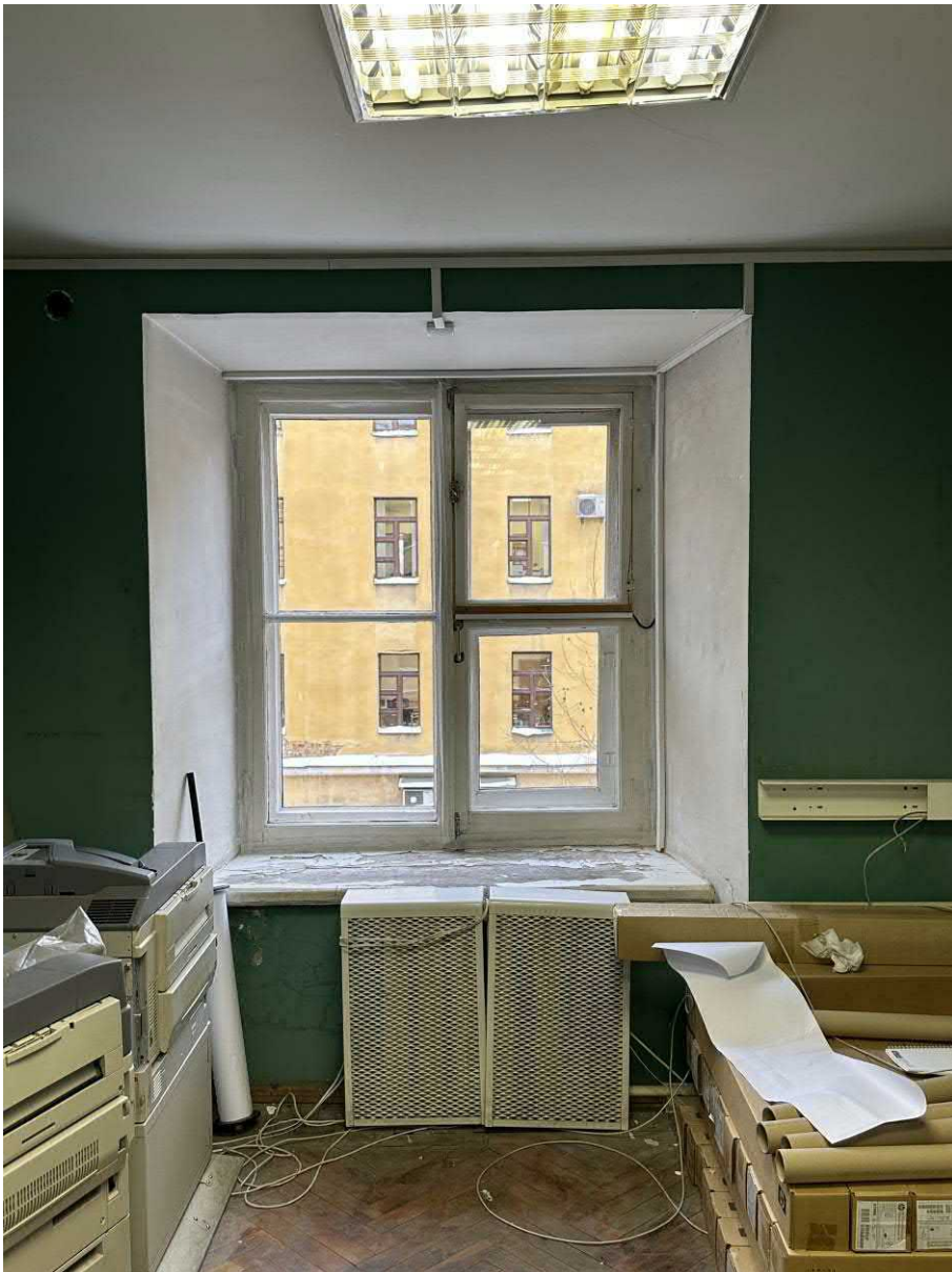
Фото 11. Вид окна ОК-1, в помещении 33-Н
