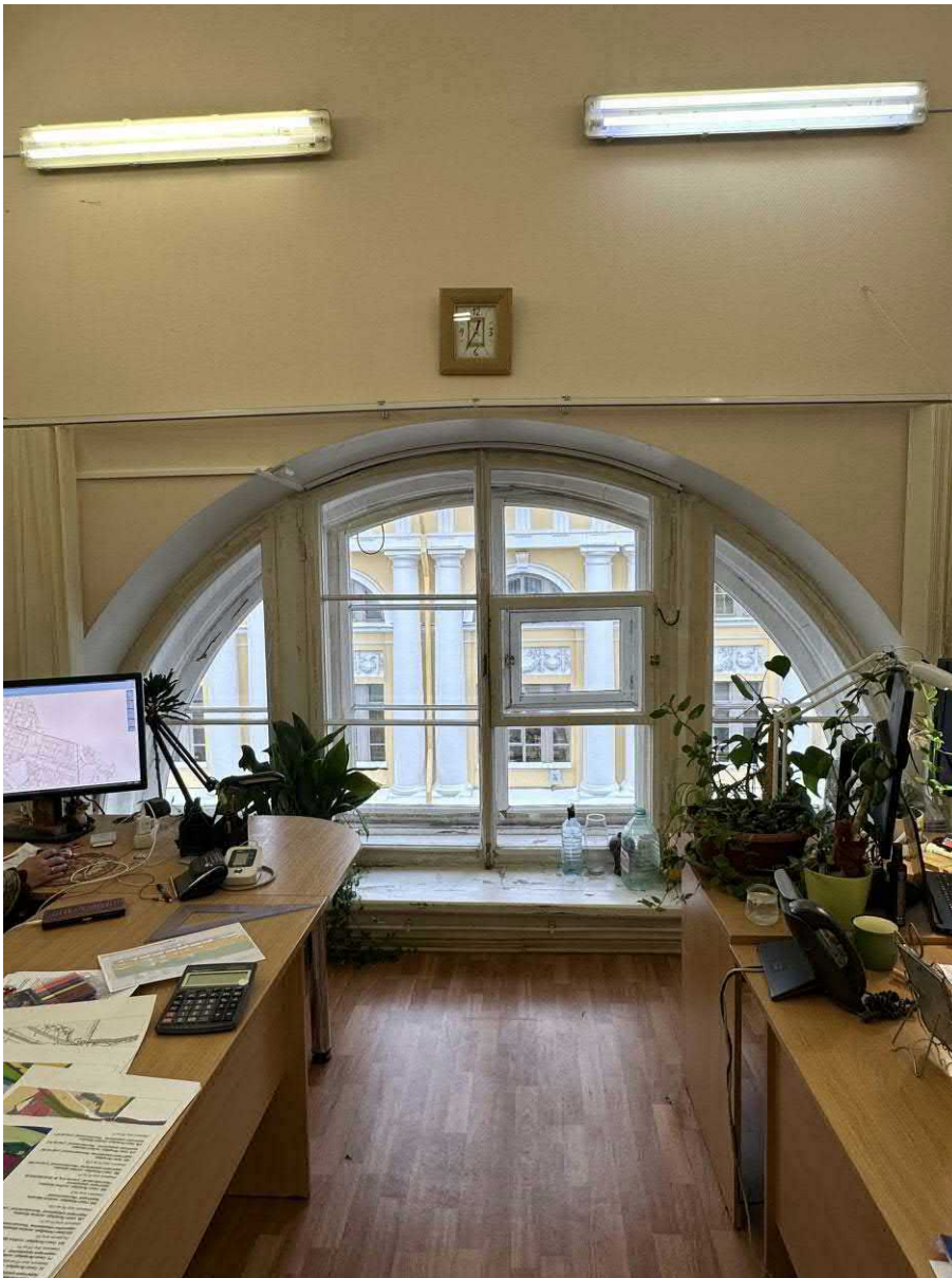
Фото 8. Вид окна ОК-4, в помещении 37-Н (ч.п. 44)
