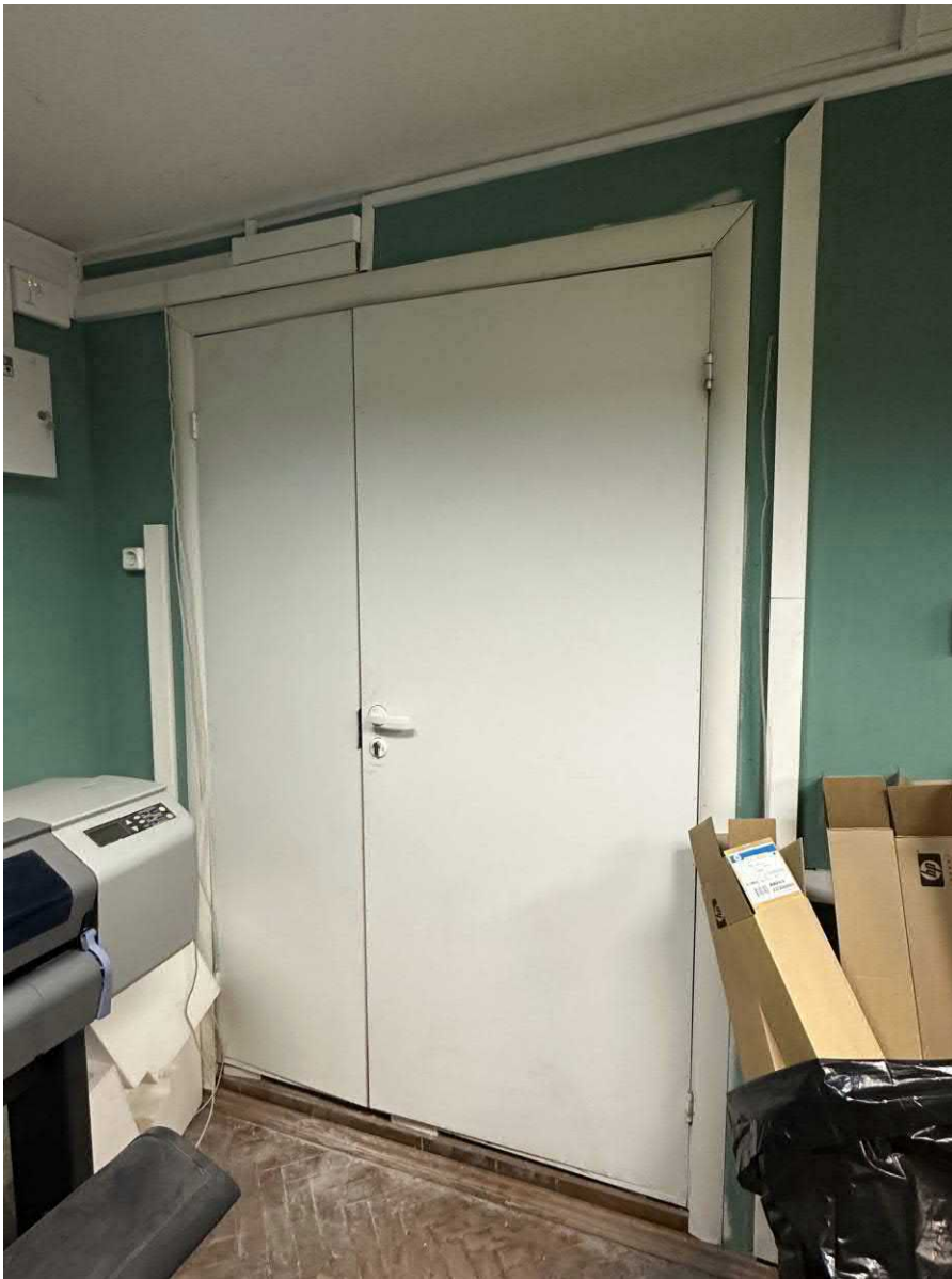
Фото 12. Вид двери Д-4, в помещении 33-Н
