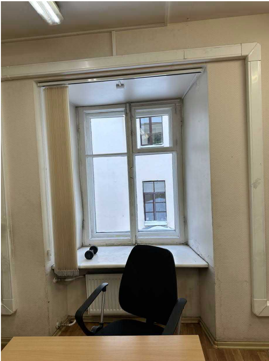
Фото 10. Вид окна ОК-2, в помещении 37-Н (ч.п. 67)
