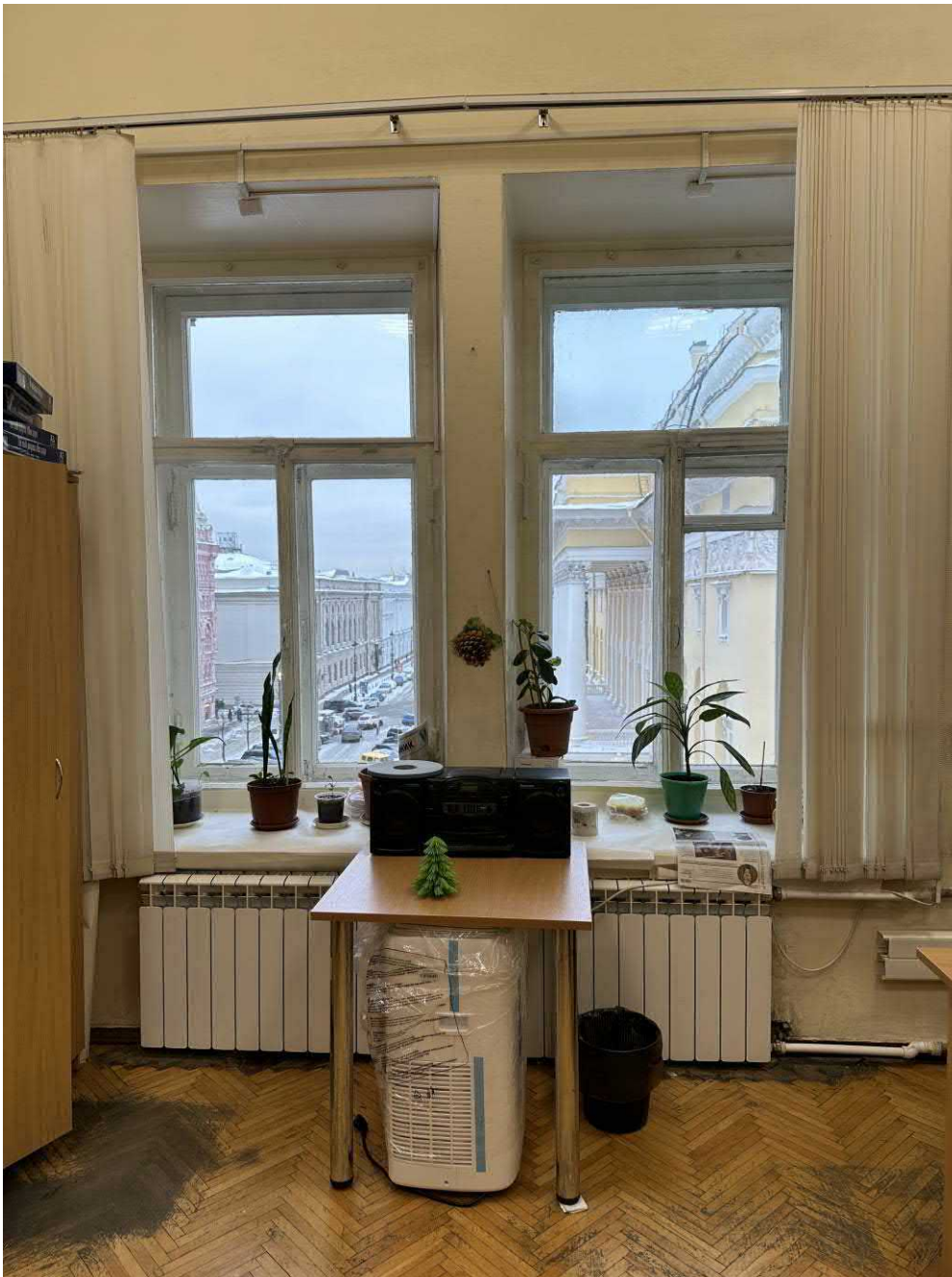
Фото 1. Вид окон ОК-7, ОК-8 в помещении 37-Н (ч.п. 24)
