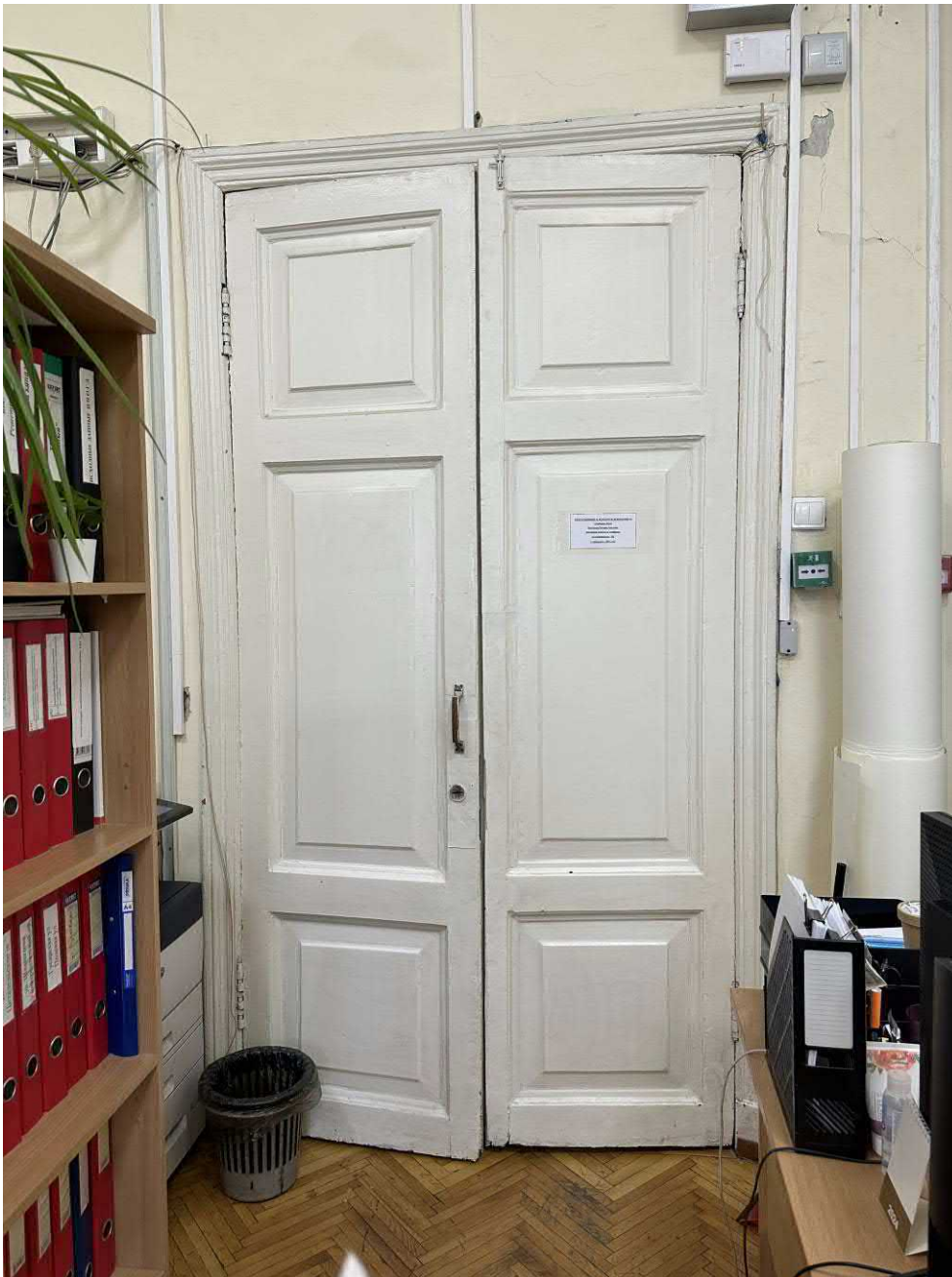
Фото 2. Вид двери Д-3 в помещении 37-Н (ч.п. 24)
