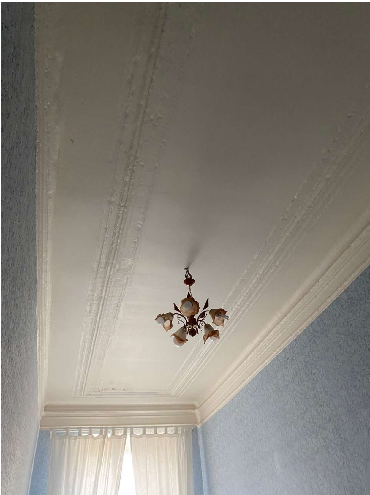
Фото 67. Вид на помещение квартиры № 26 объекта культурного наследия.
