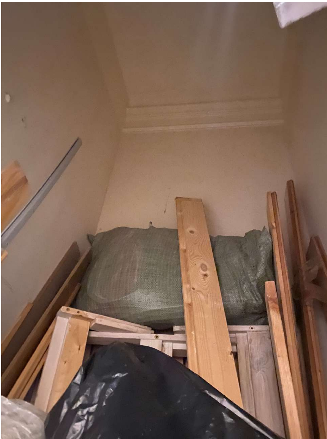
Фото 70. Вид на помещение квартиры № 26 объекта культурного наследия.
