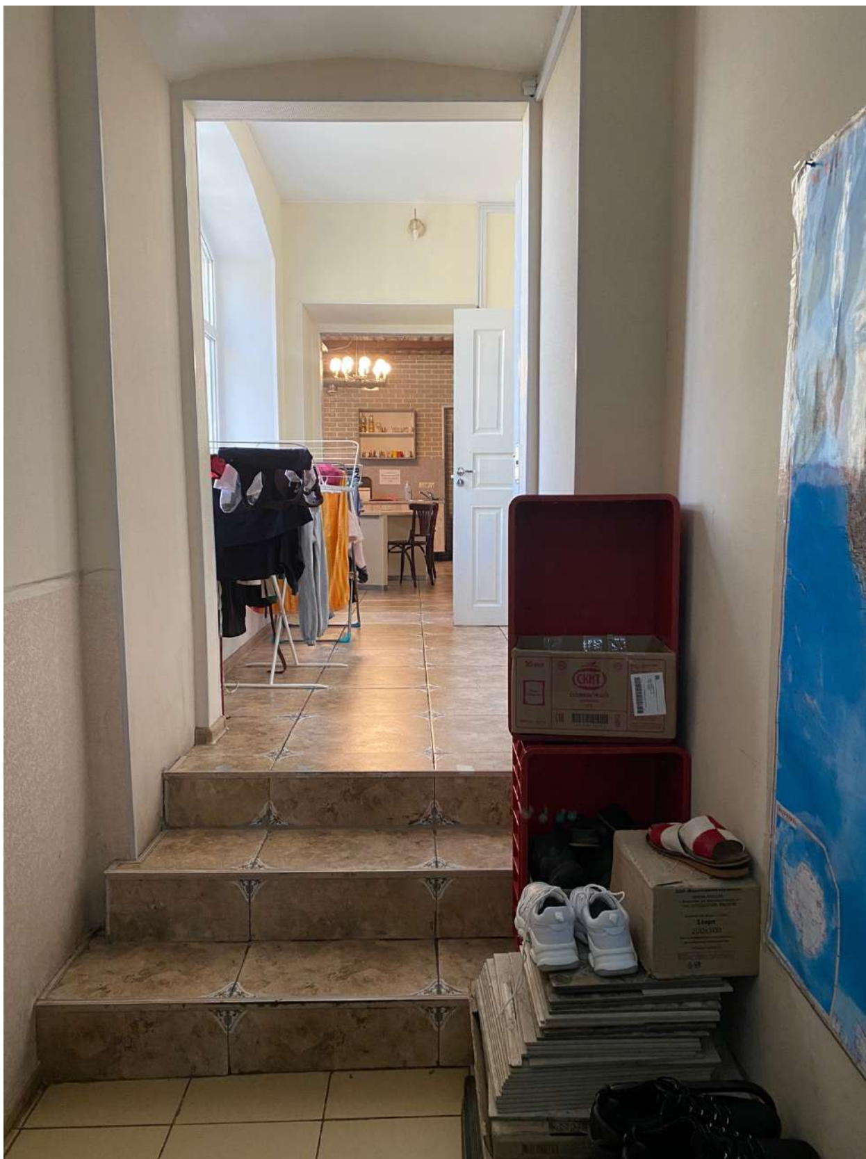
Фото 29. Вид на помещение квартиры № 26 объекта культурного наследия.
