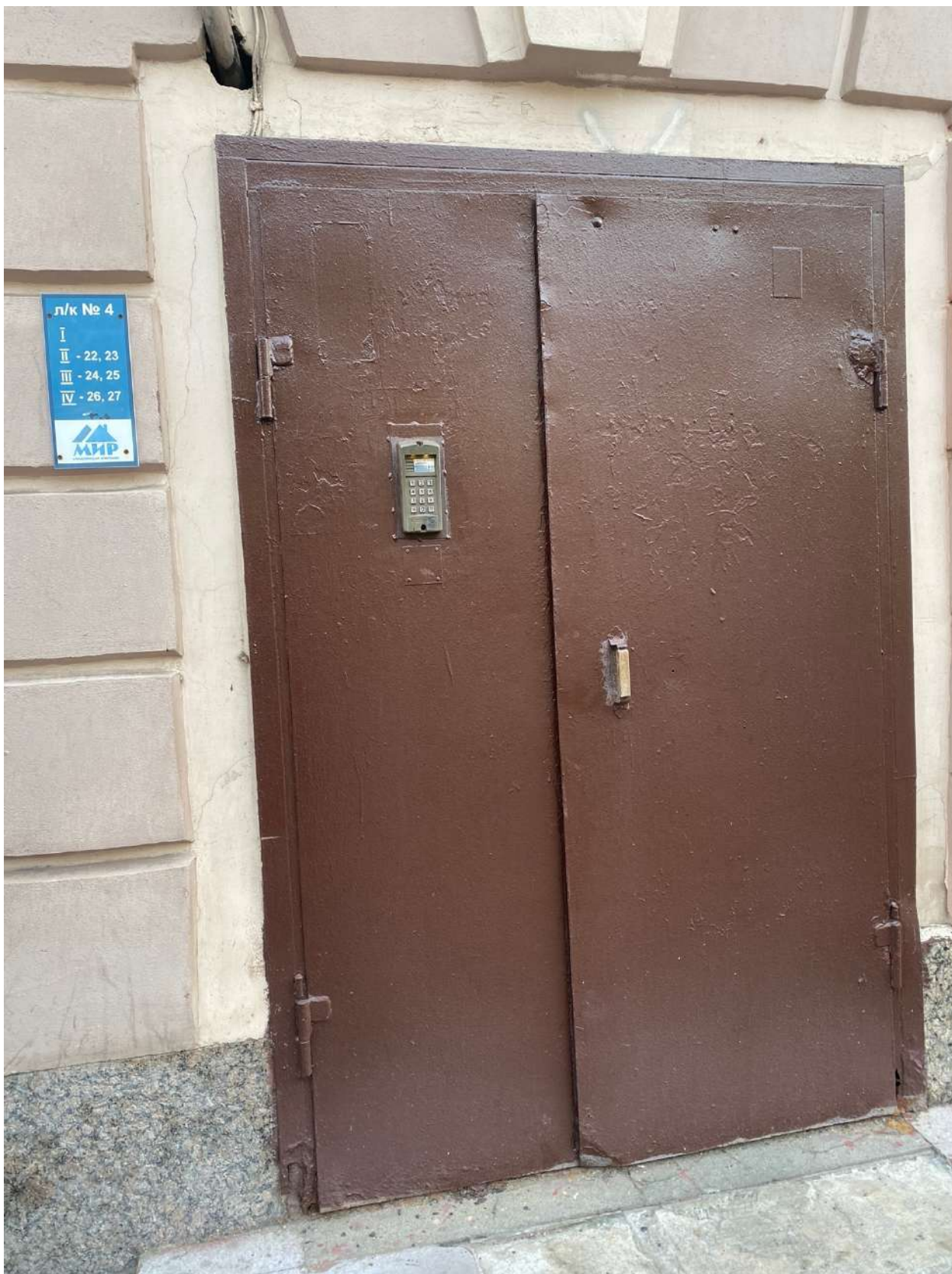
Фото 18. Вид на вход в парадную, ведущую в квартиру № 26 объекта культурного наследия.
