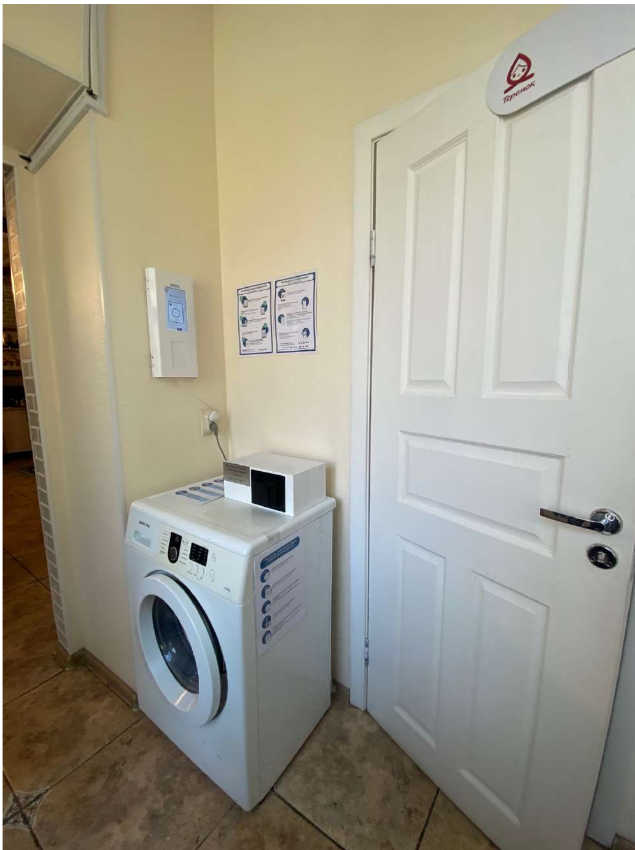
Фото 37. Вид на помещение квартиры № 26 объекта культурного наследия.
