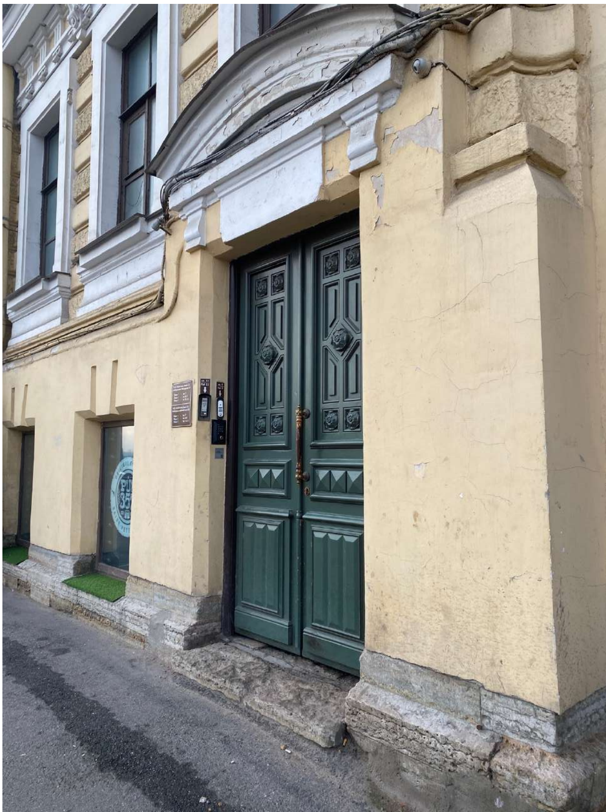
Фото 12. Фрагмент фасада объекта культурного наследия по набережной Макарова.
