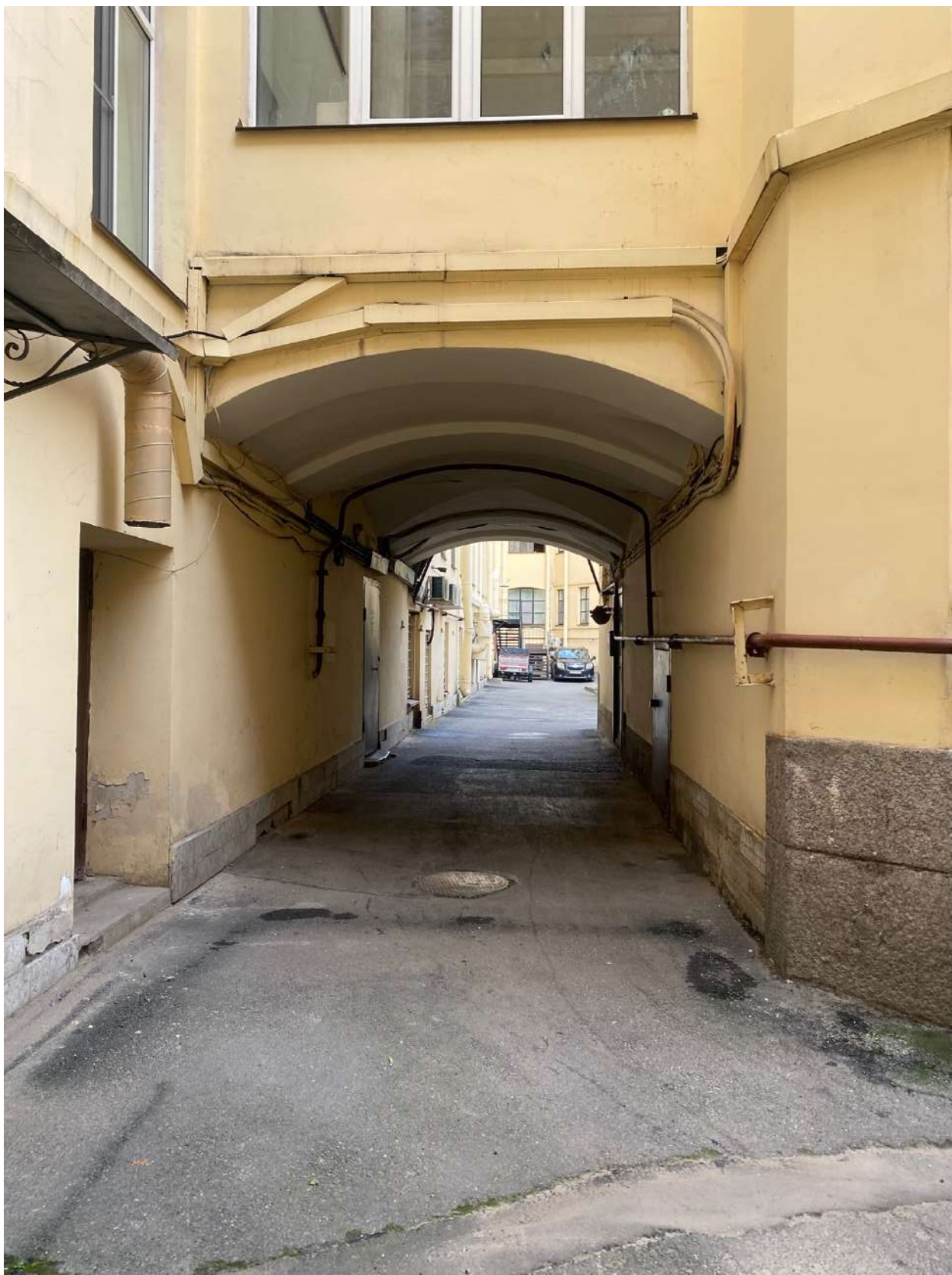
Фото 4. Арка проезда, соединяющая южный и северный дворы объекта культурного наследия.
