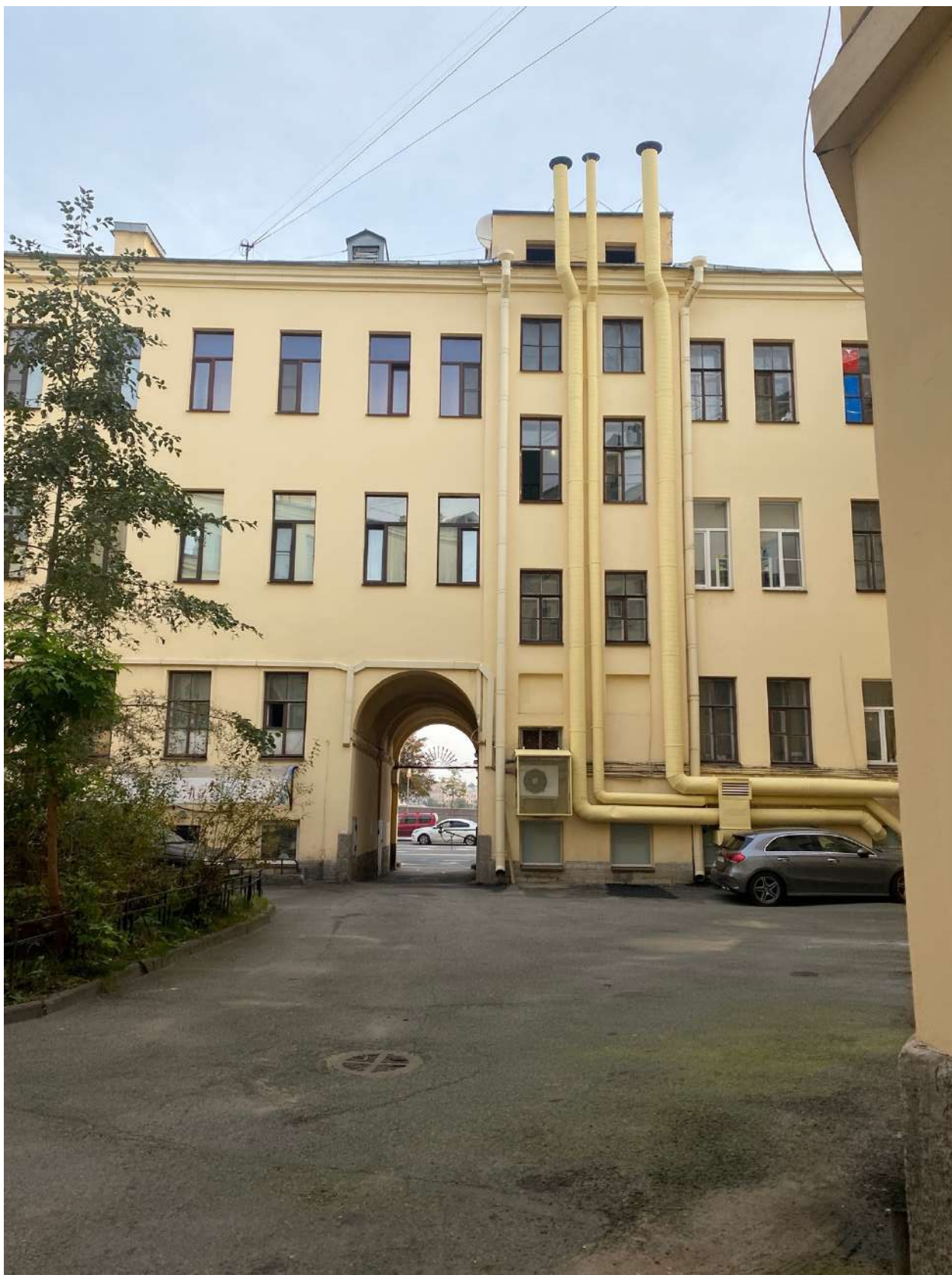
Фото 7. Дворовые фасады северного двора объекта культурного наследия.
