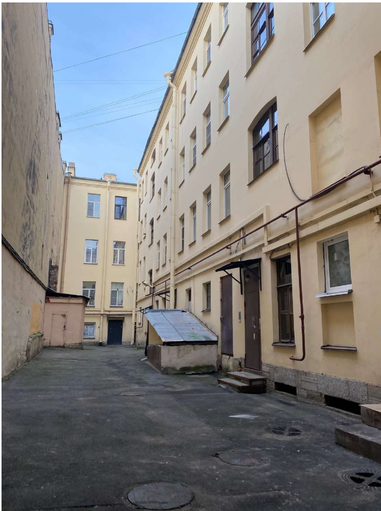
Фото 3. Дворовые фасады южного двора объекта культурного наследия.
