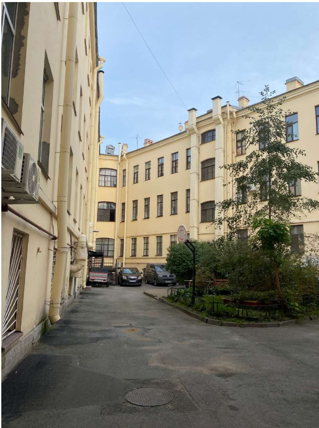
Фото 6. Дворовые фасады северного двора объекта культурного наследия.
