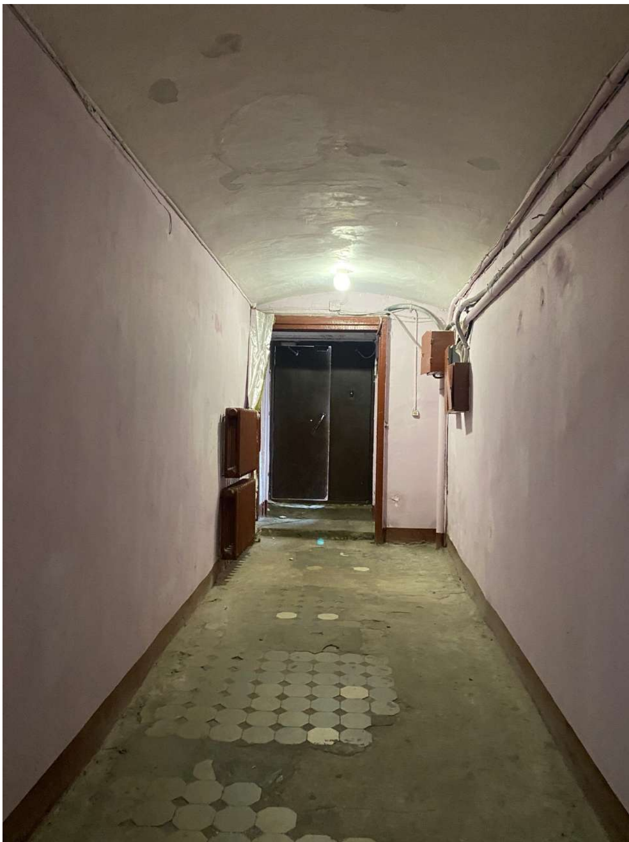
Фото 20. Вид на помещение парадной, ведущей в квартиру № 26 объекта культурного наследия.
