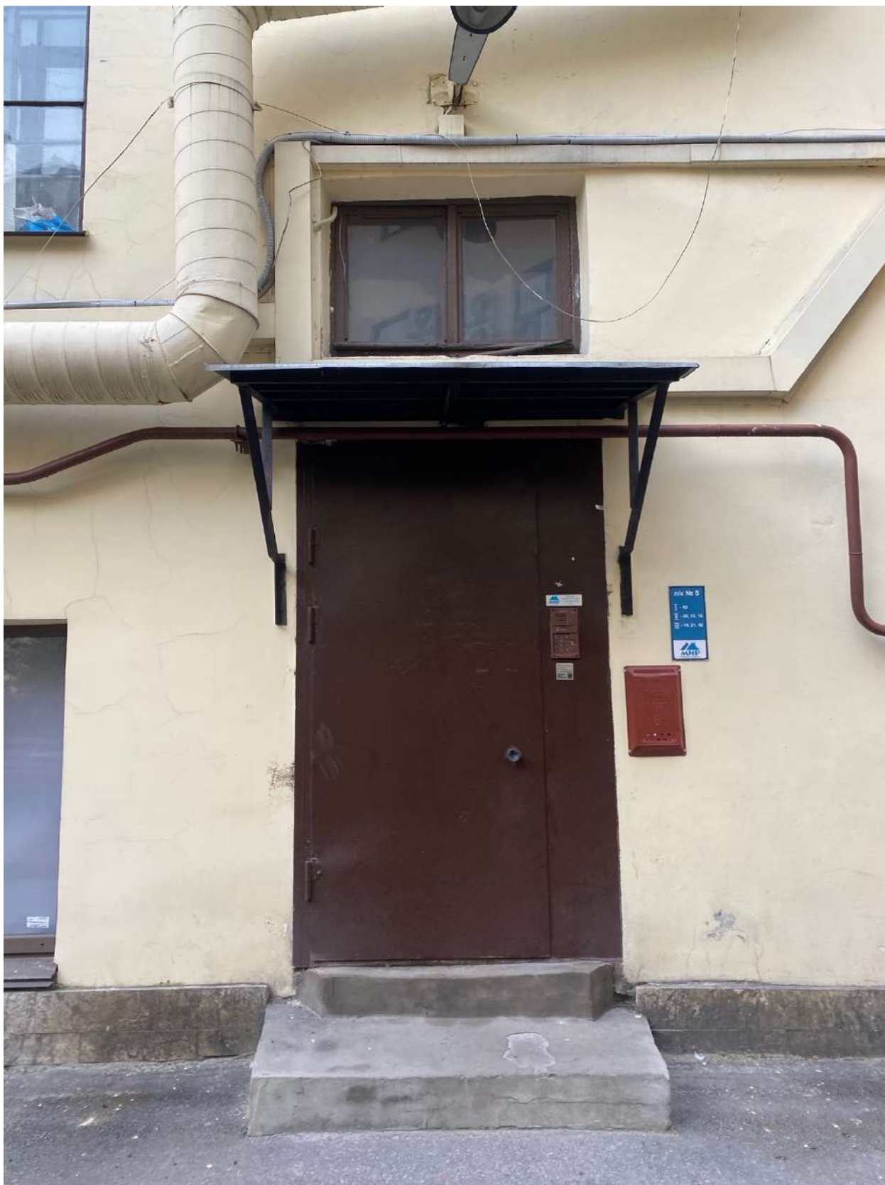
Фото 8. Фрагмент дворового фасада северного двора объекта культурного наследия.
