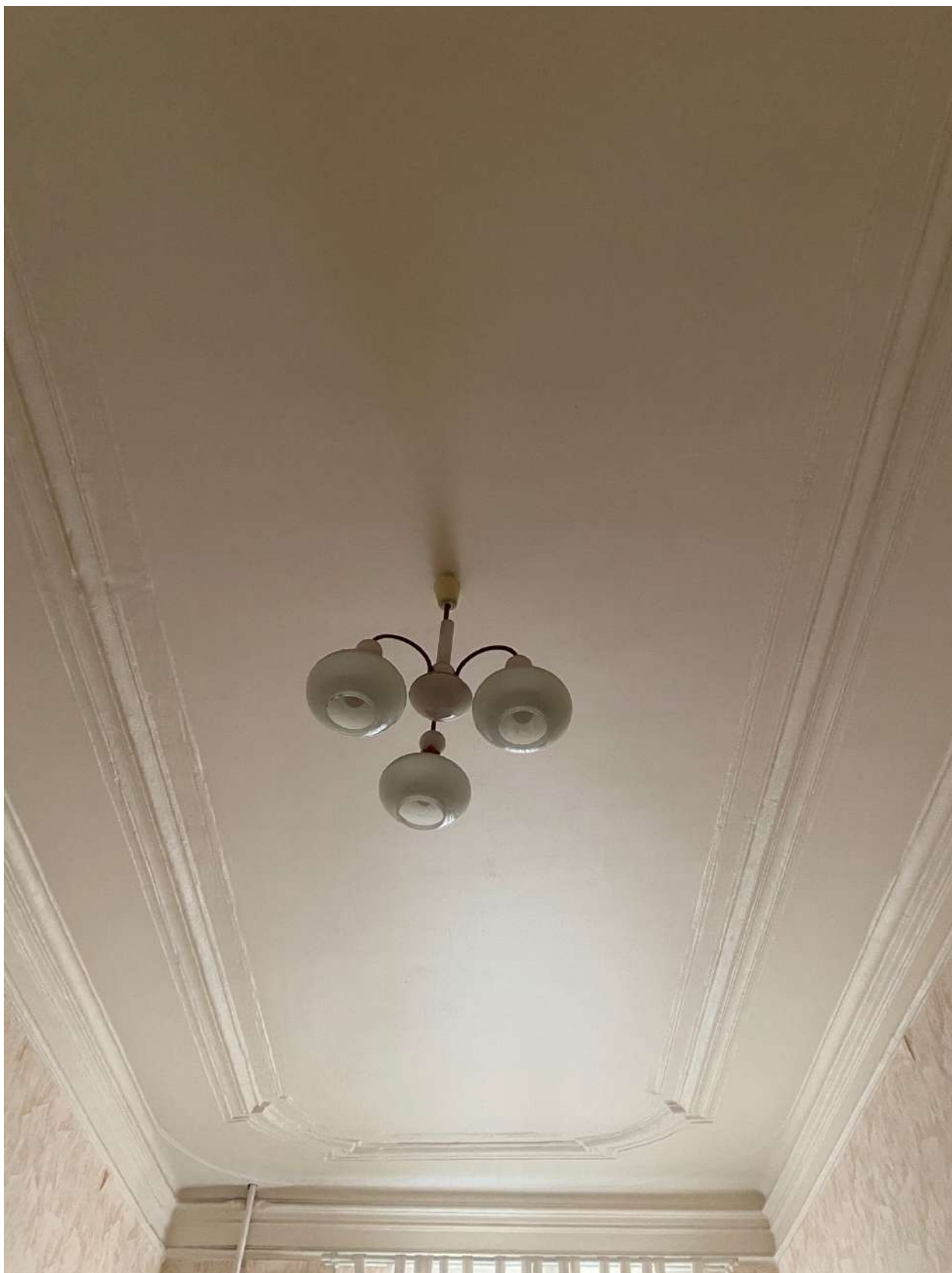
Фото 73. Вид на помещение квартиры № 26 объекта культурного наследия.
