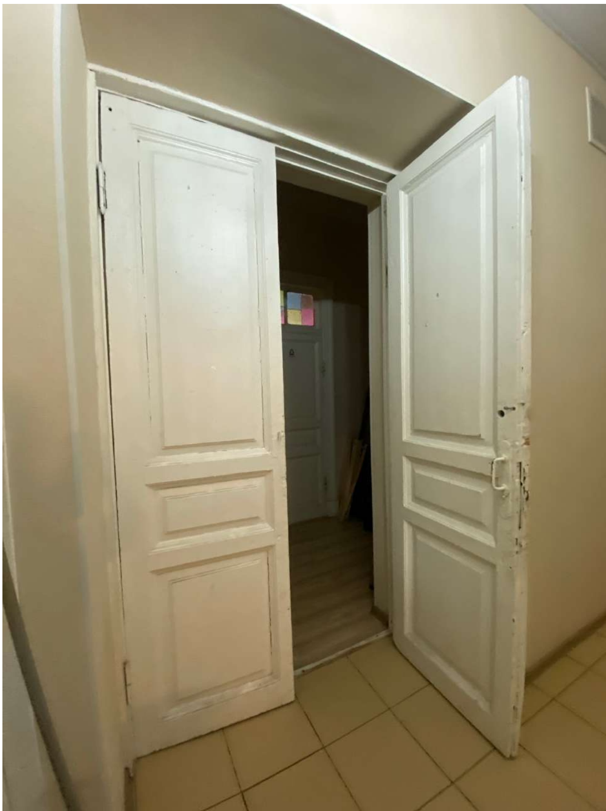
Фото 28. Вид на помещение квартиры № 26 объекта культурного наследия.
