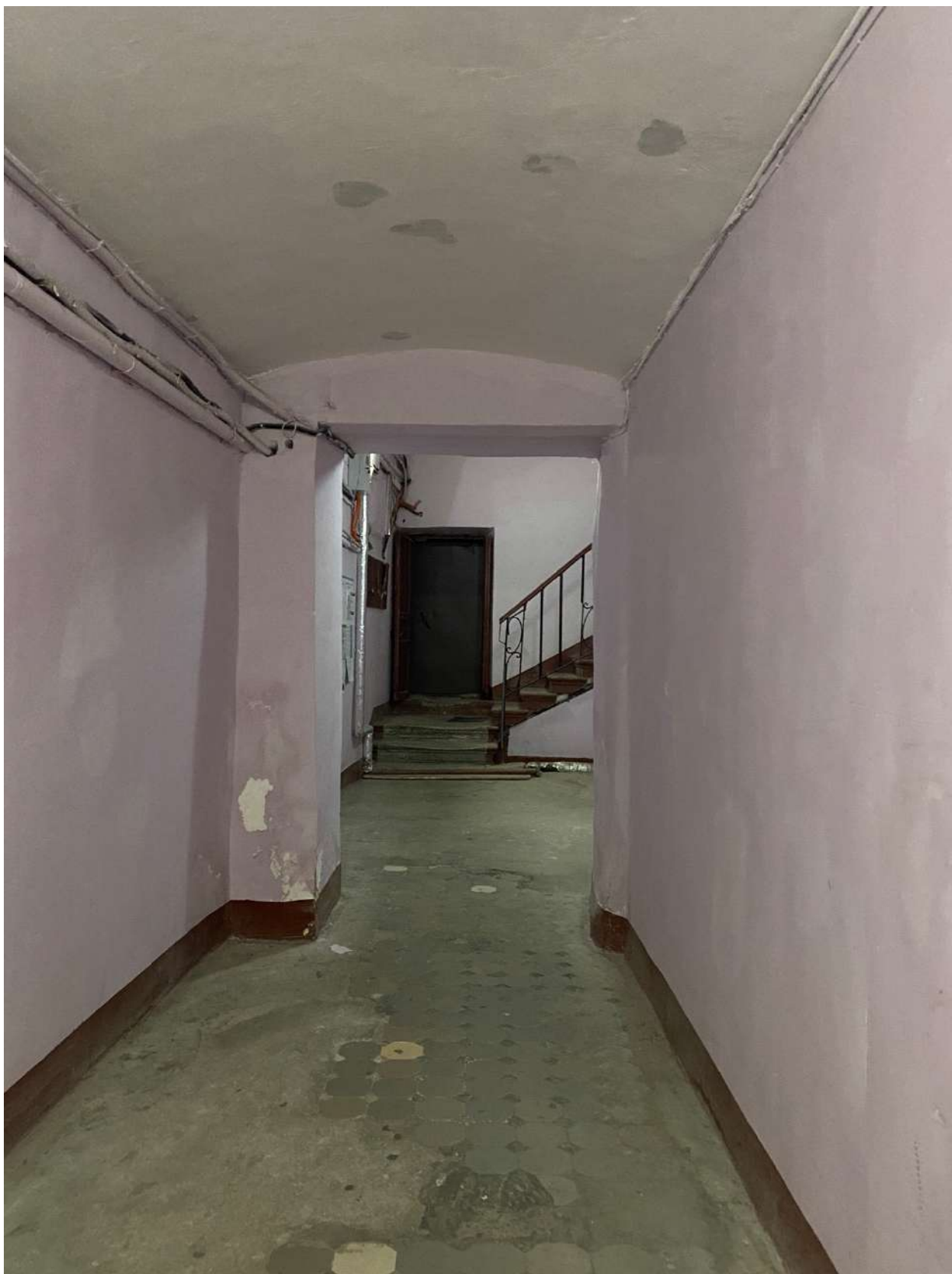
Фото 19. Вид на помещение парадной, ведущей в квартиру № 26 объекта культурного наследия.
