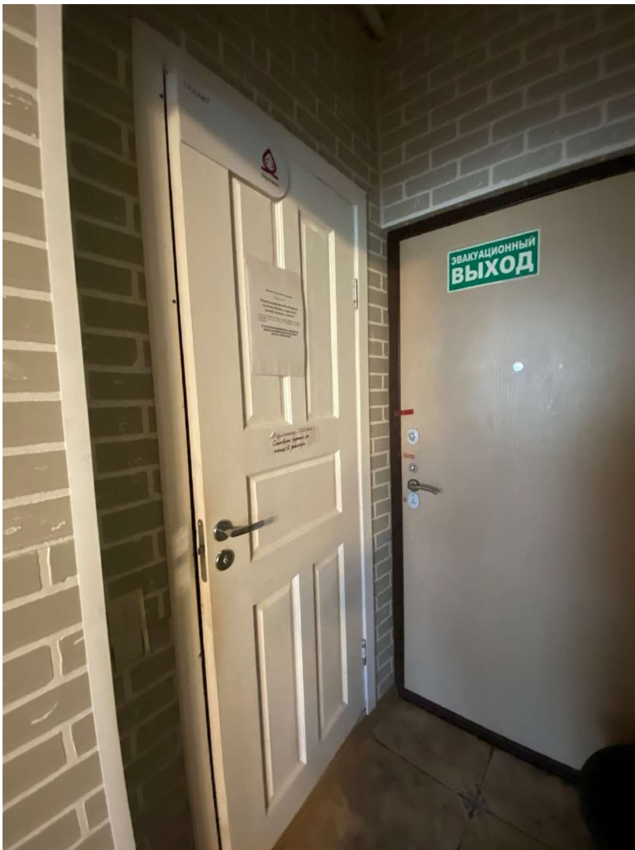
Фото 46. Вид на помещение квартиры № 26 объекта культурного наследия.
