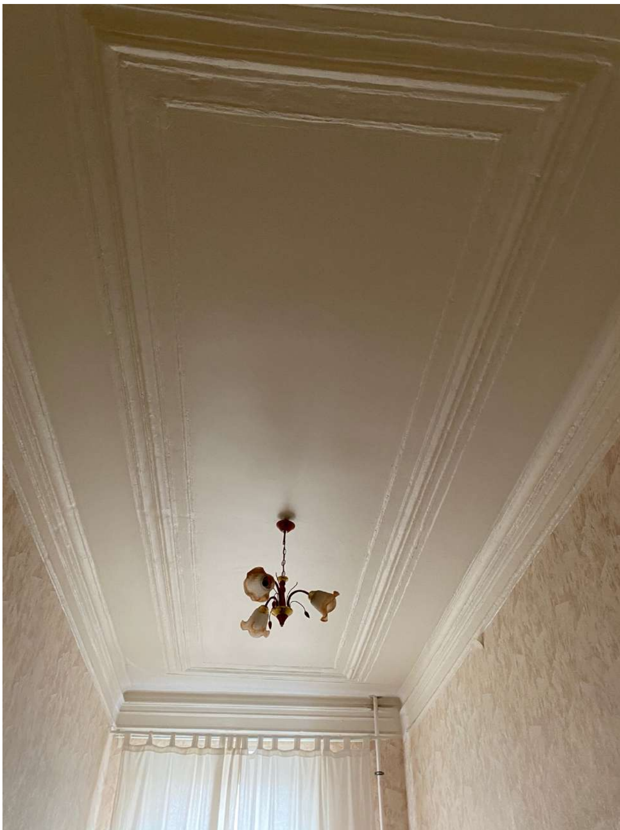
Фото 61. Вид на помещение квартиры № 26 объекта культурного наследия.
