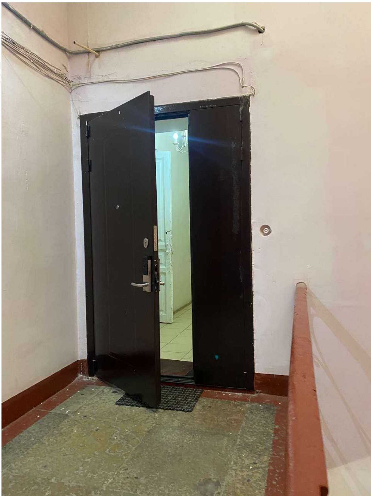
Фото 26. Вход в квартиру № 26 объекта культурного наследия.
