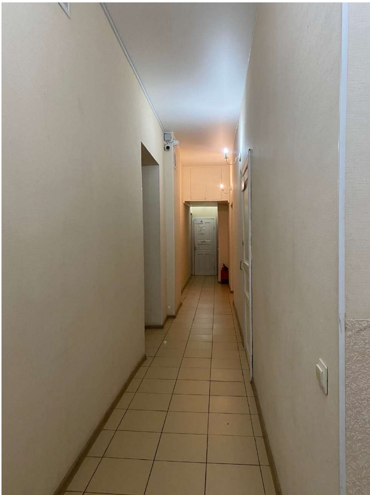
Фото 27. Вид на помещение квартиры № 26 объекта культурного наследия.
