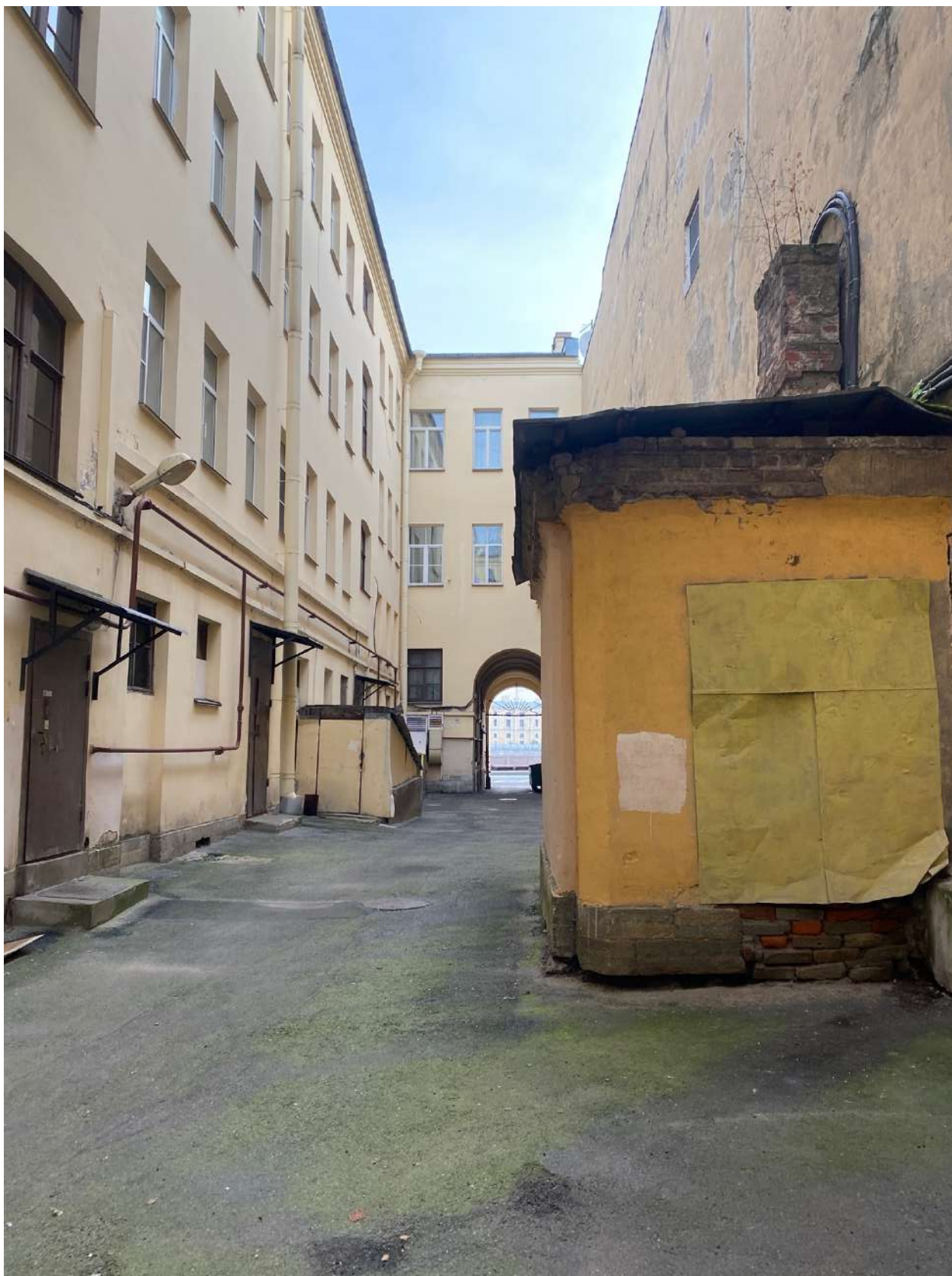
Фото 5. Дворовые фасады южного двора объекта культурного наследия.
