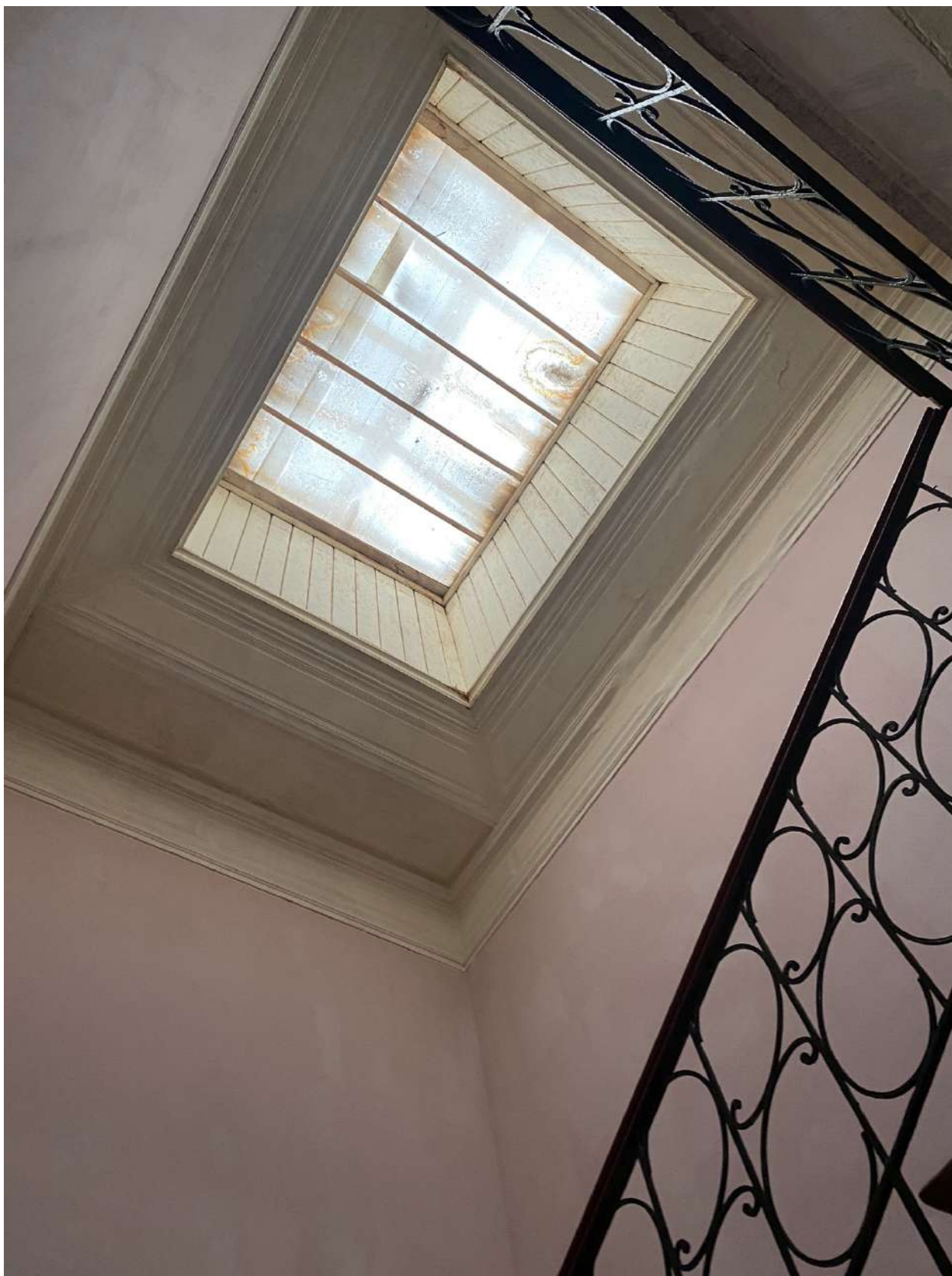
Фото 25. Вид на световой фонарь лестницы, ведущей в квартиру № 26 объекта культурного наследия.
