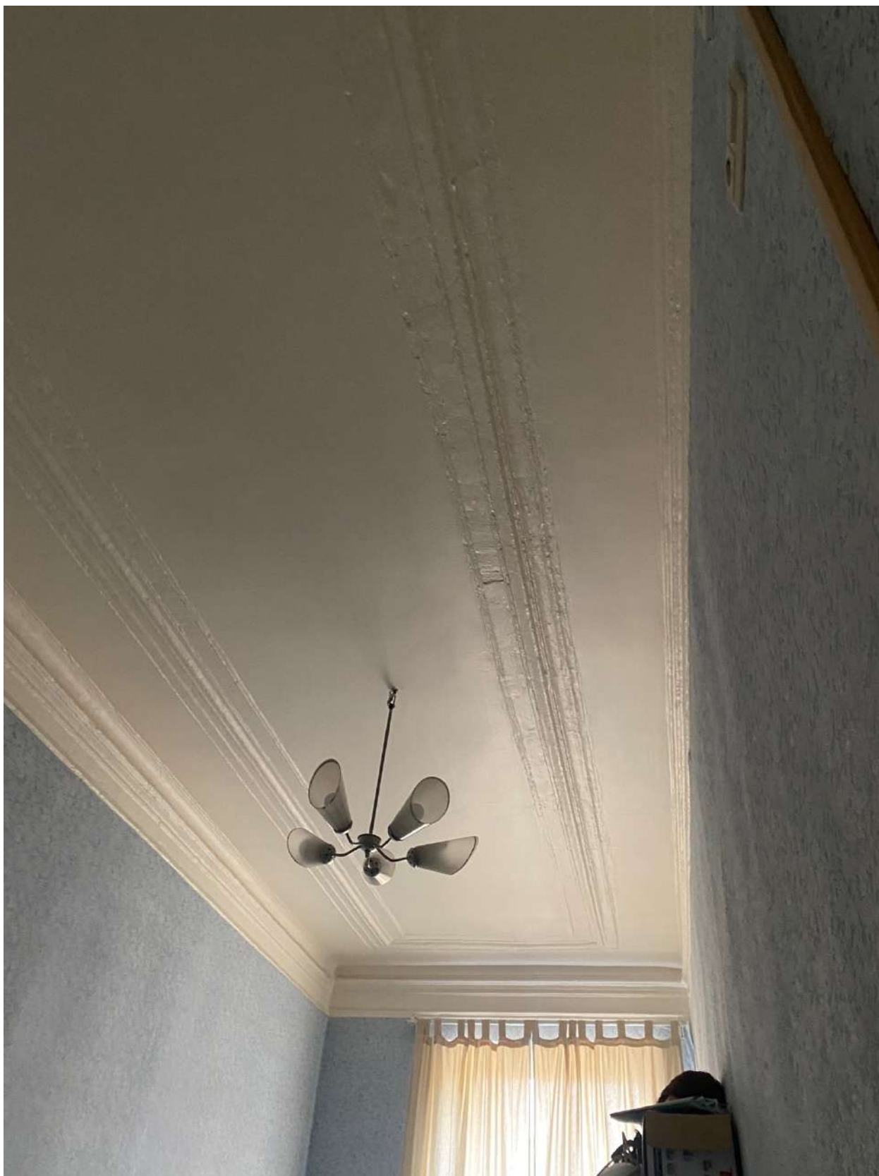
Фото 71. Вид на помещение квартиры № 26 объекта культурного наследия.
