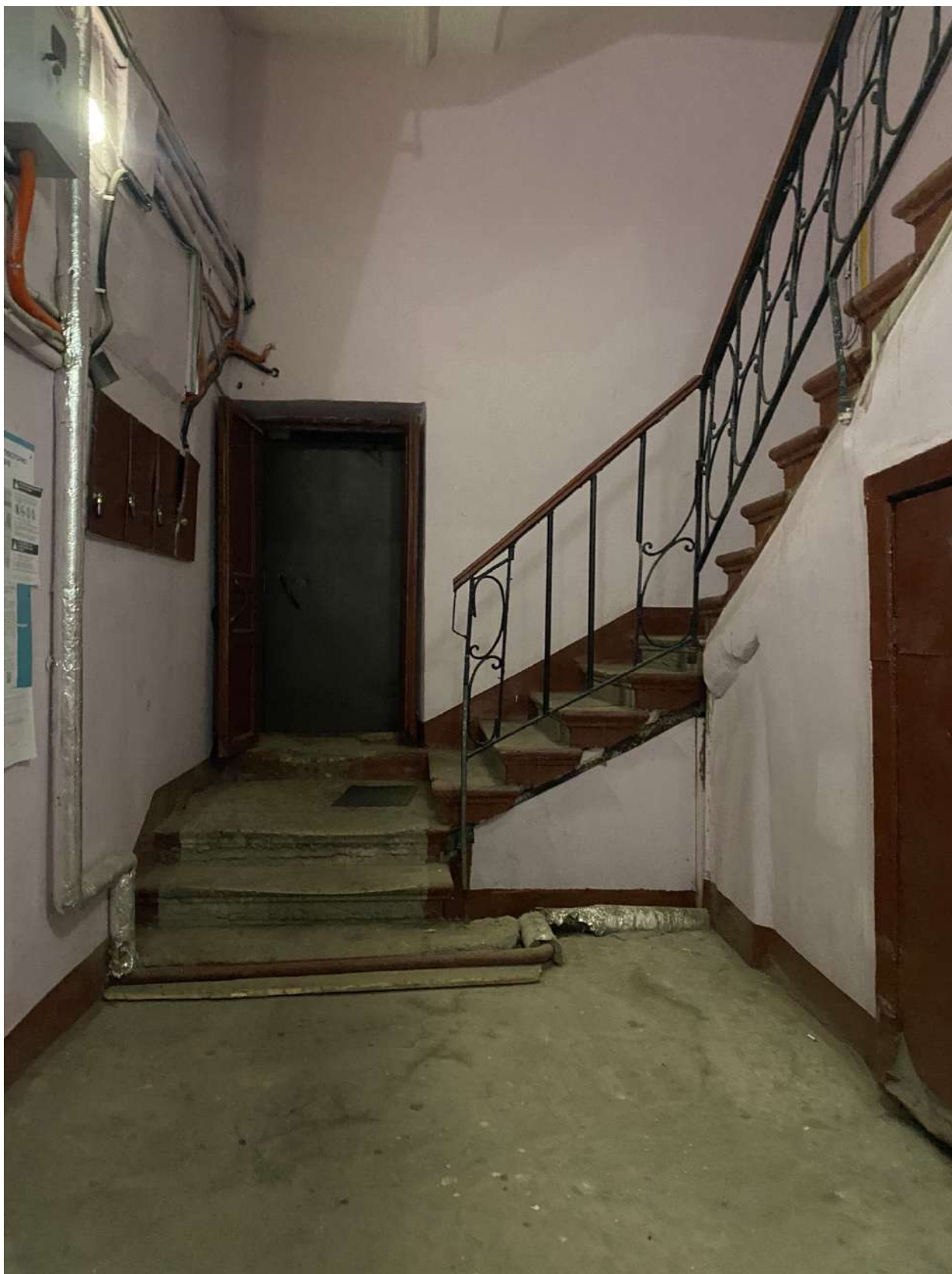
Фото 21. Вид на лестницу, ведущую в квартиру № 26 объекта культурного наследия.
