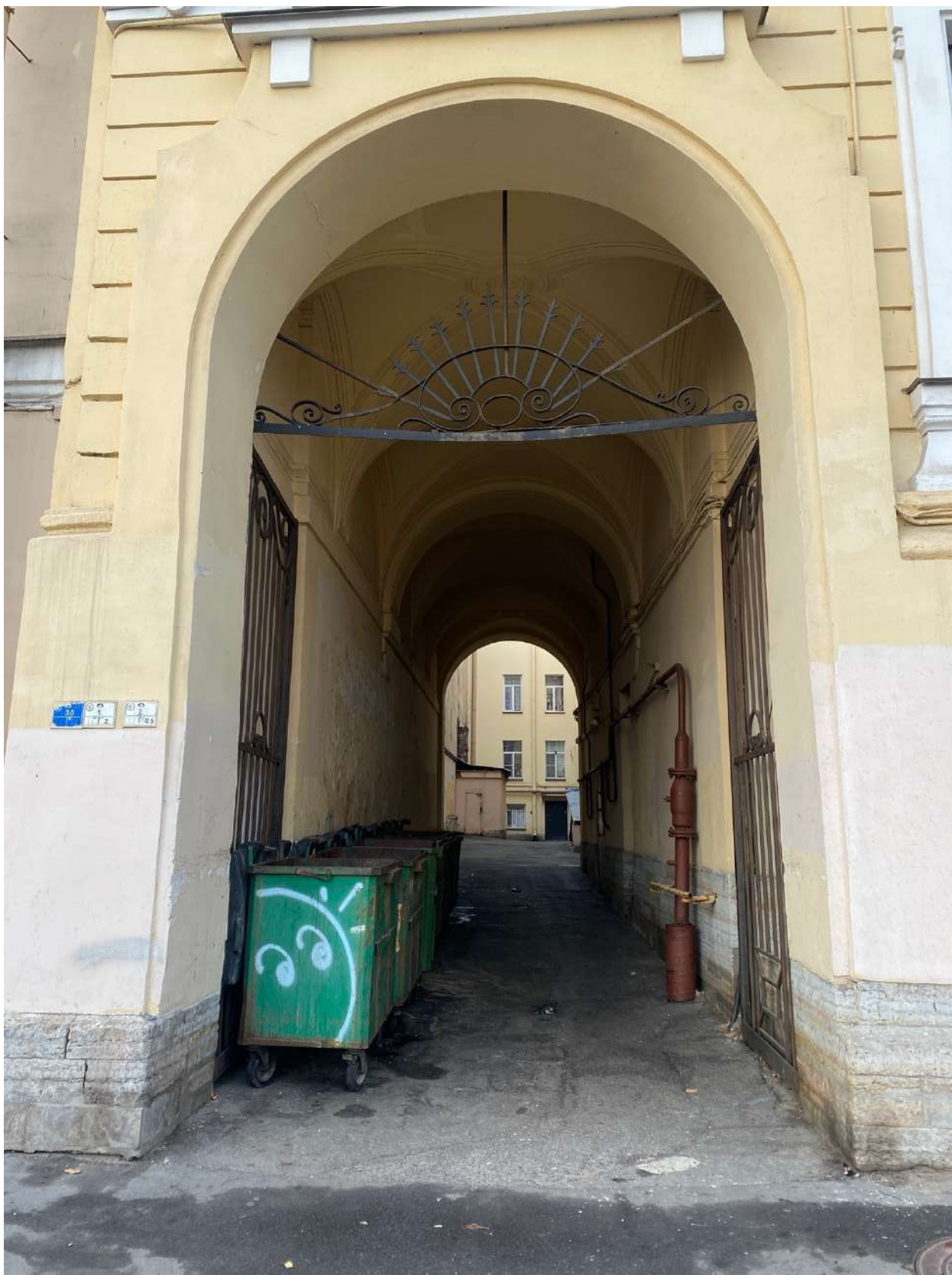
Фото 2. Арка проезда объекта культурного наследия со Тучкова переулка.
