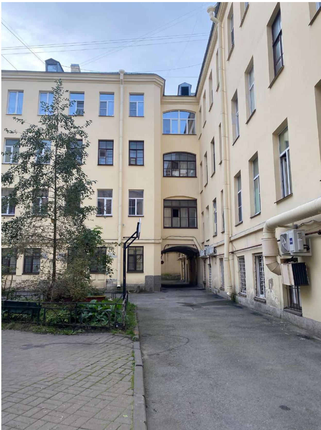
Фото 9. Дворовые фасады северного двора объекта культурного наследия.
