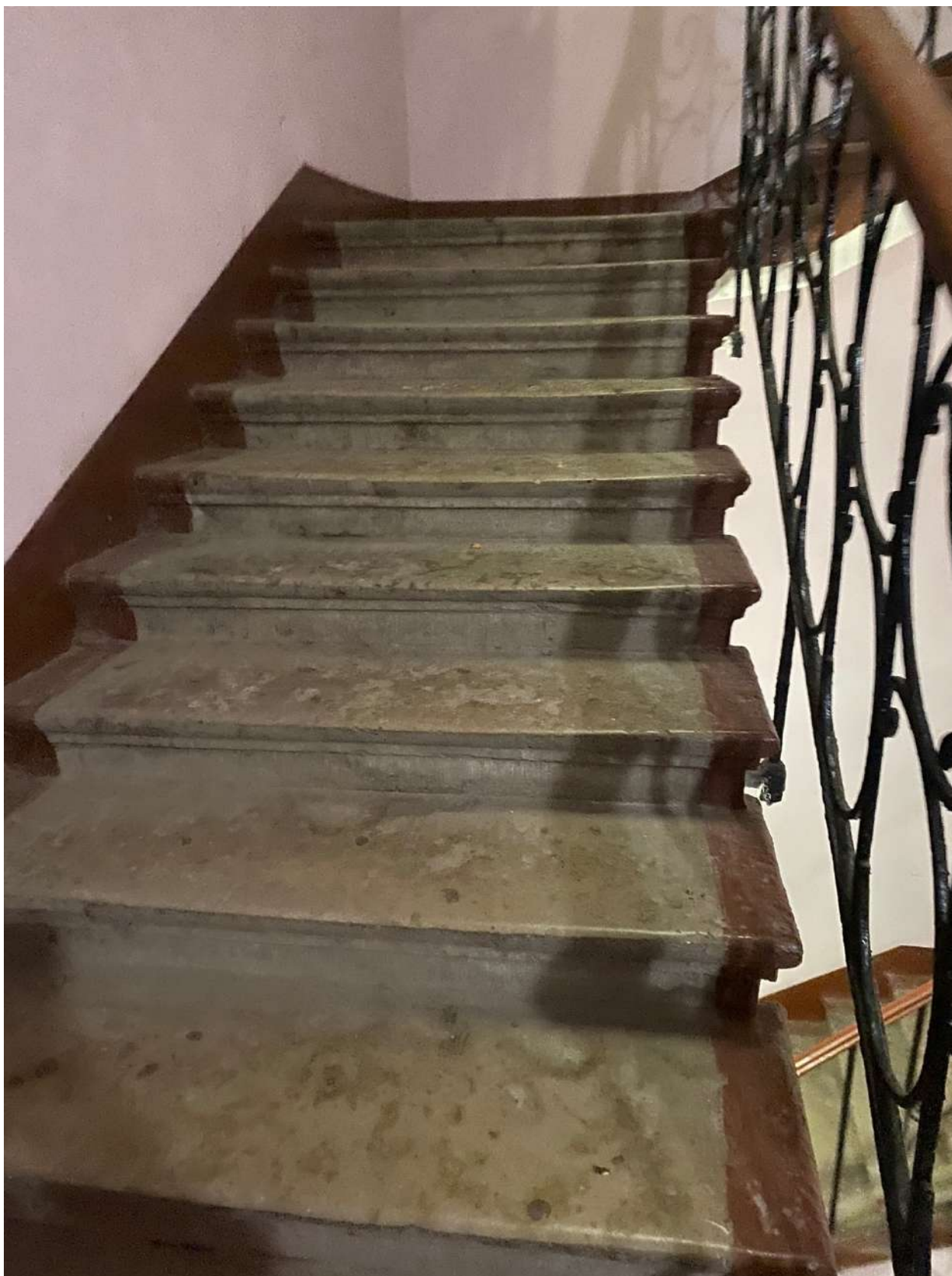
Фото 24. Вид на лестницу, ведущую в квартиру № 26 объекта культурного наследия.
