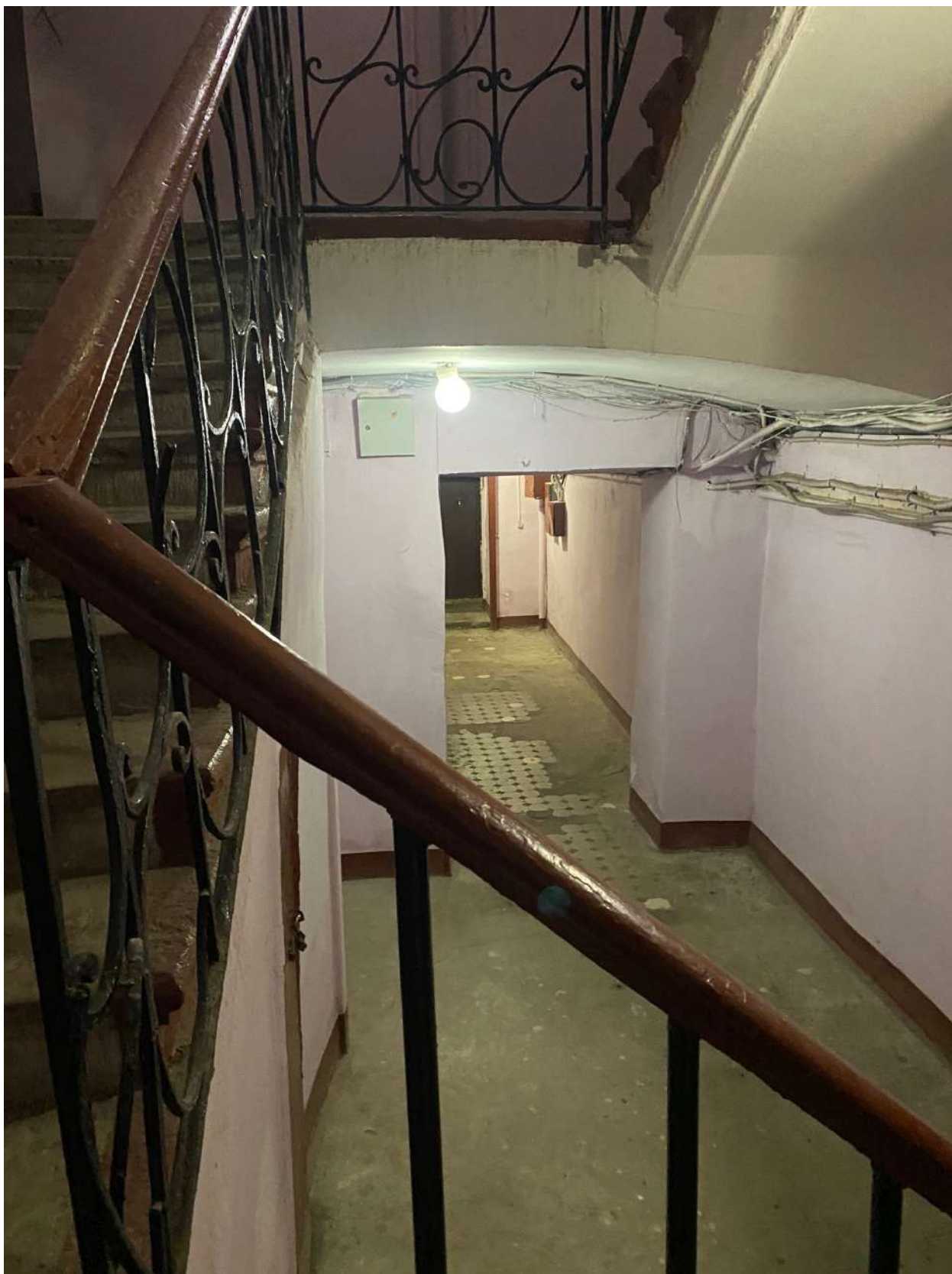
Фото 23. Вид на лестницу, ведущую в квартиру № 26 объекта культурного наследия.
