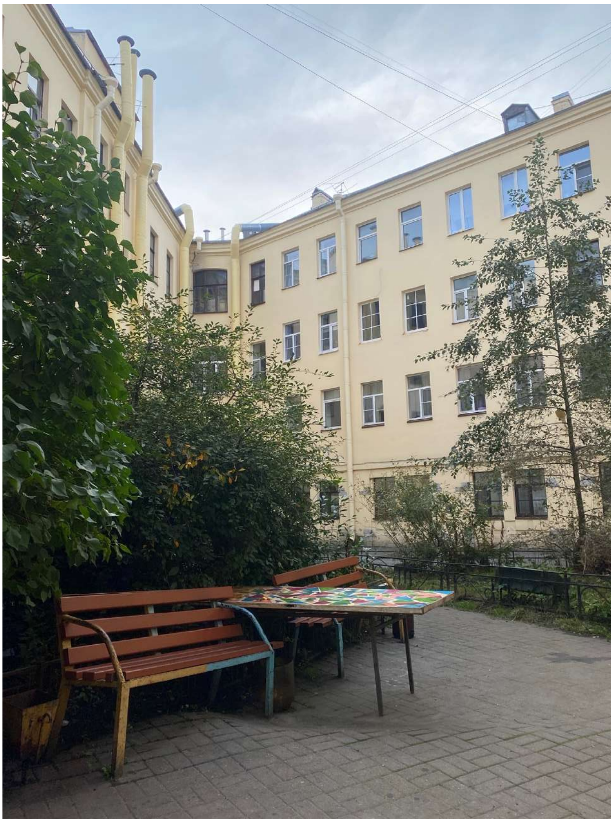
Фото 10. Дворовые фасады северного двора объекта культурного наследия.
