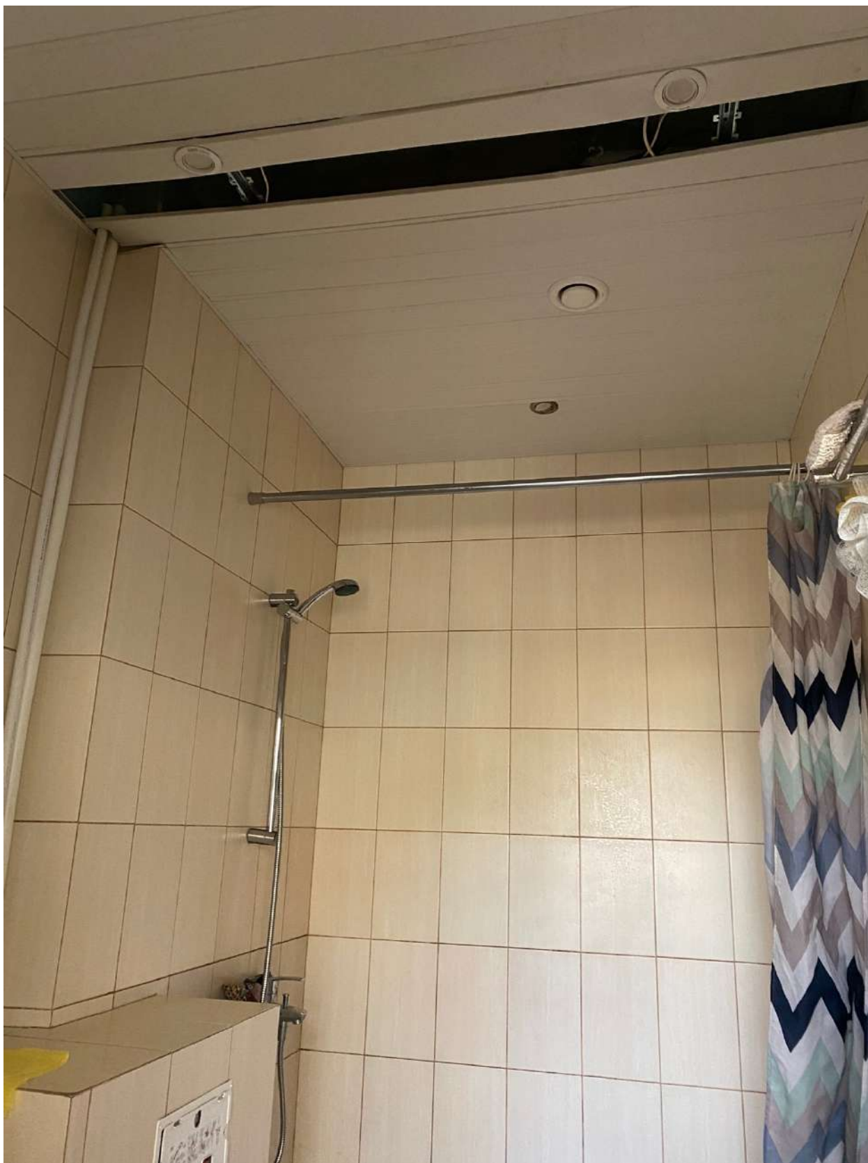
Фото 34. Вид на помещение квартиры № 26 объекта культурного наследия.
