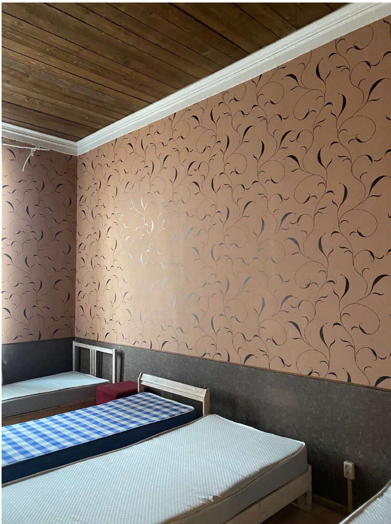
Фото 54. Вид на помещение квартиры № 26 объекта культурного наследия.
