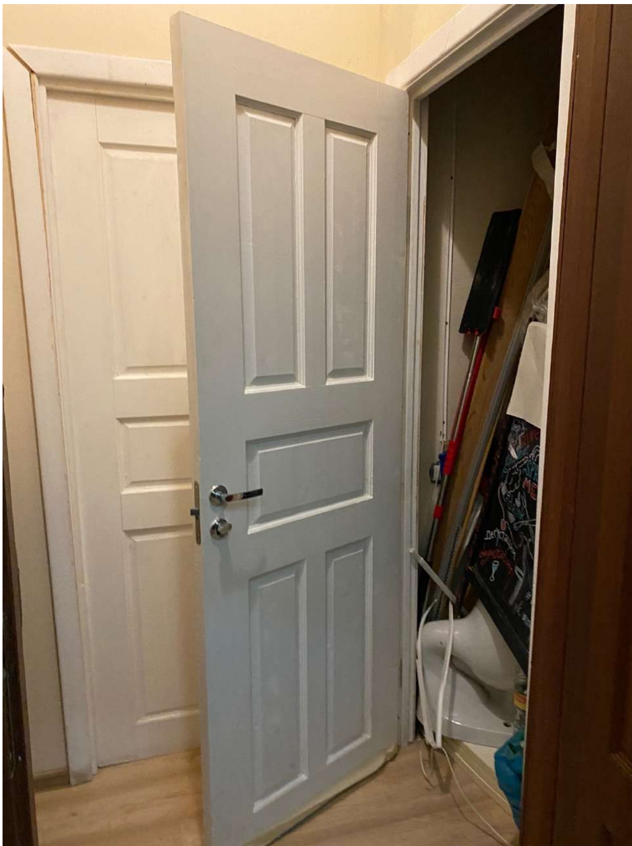
Фото 69. Вид на помещение квартиры № 26 объекта культурного наследия.
