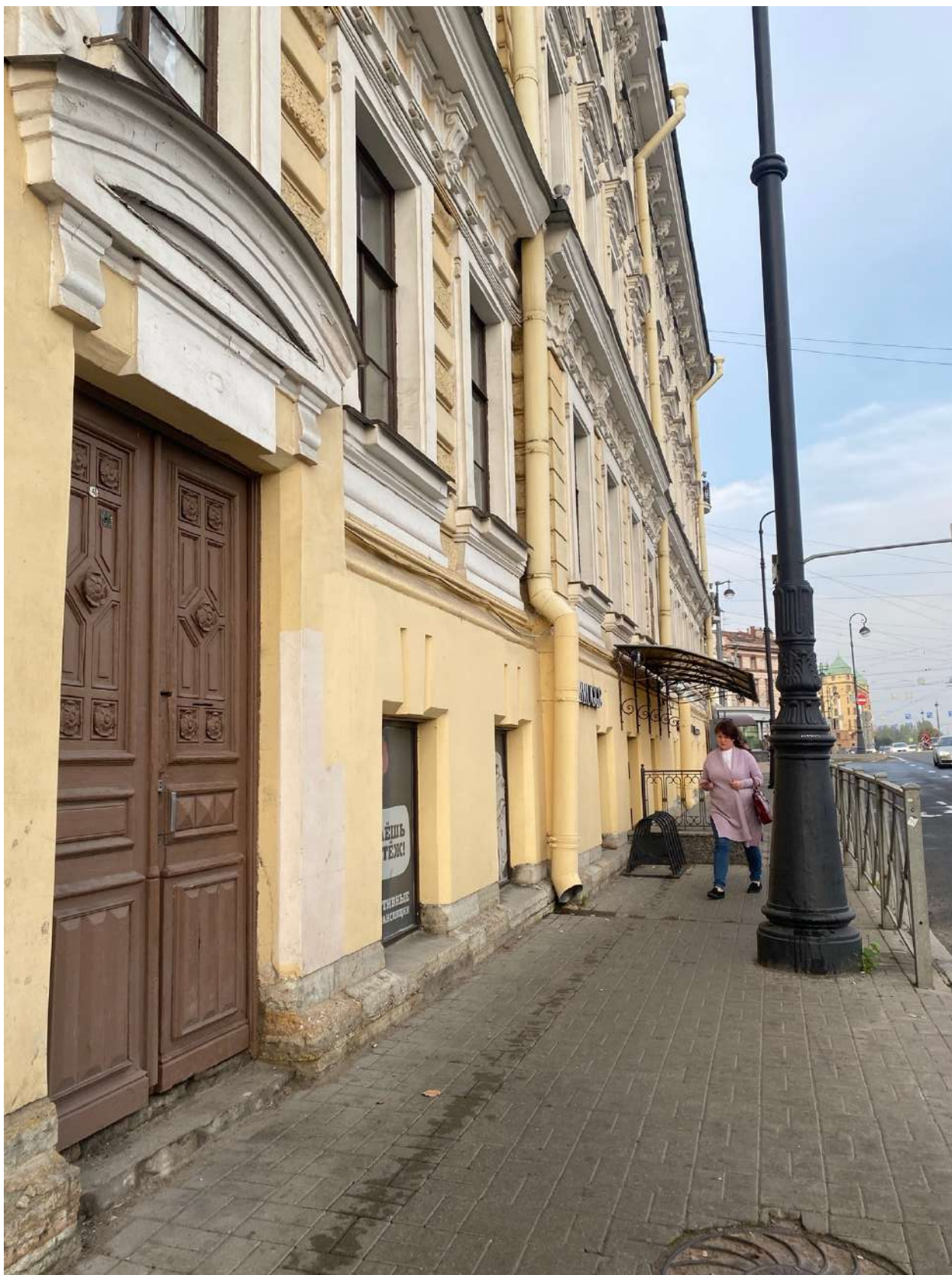
Фото 13. Фрагмент фасада объекта культурного наследия по набережной Макарова.
