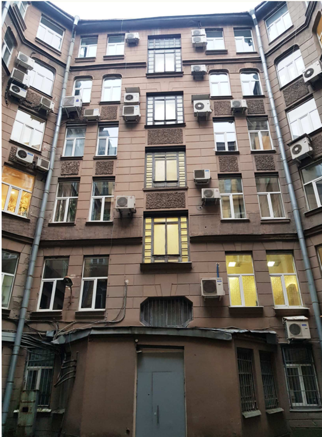
2. Вид дворового фасада.
