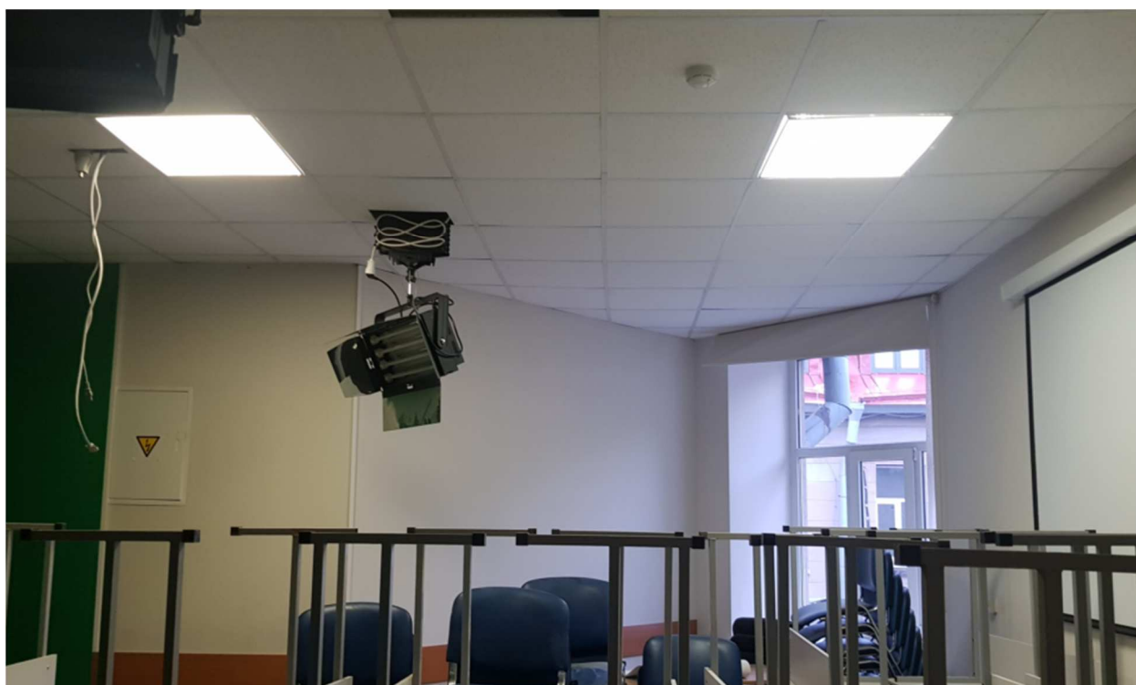
5. 6-й этаж. Помещение северного крыла.
