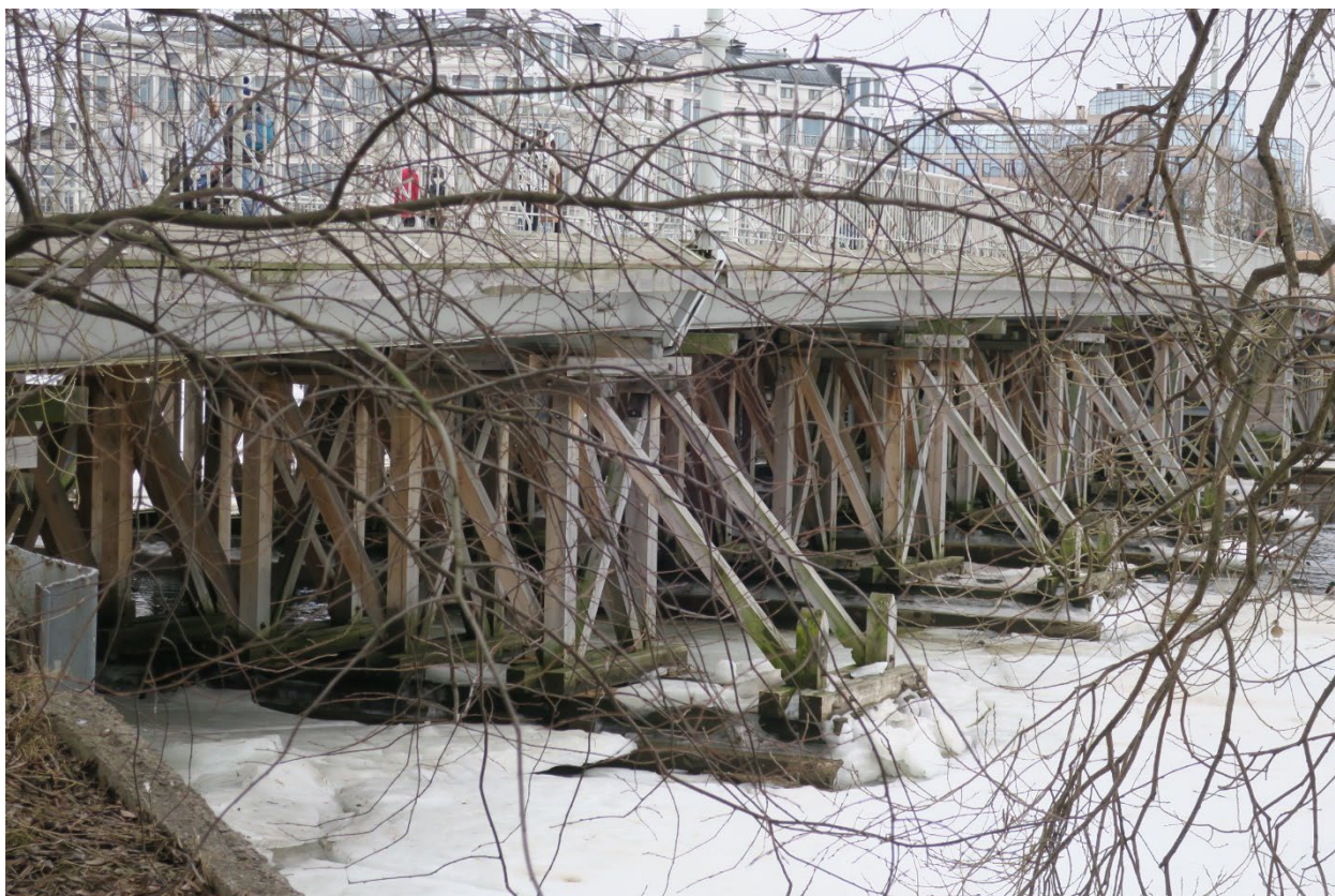
10. Вид с юг-востока на конструкции объекта культурного наследия федерального значения «Мост», расположенный по адресу: г. Санкт–Петербург, 2–й Елагин мост, литера А, входящий в состав объекта культурного наследия федерального значения «Ансамбль Елагина острова»
