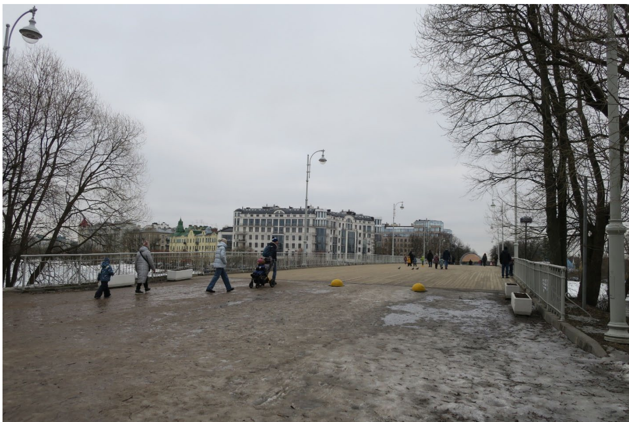
9. Вид с юга на объект культурного наследия федерального значения «Мост», расположенный по адресу: г. Санкт–Петербург, 2–й Елагин мост, литера А, входящий в состав объекта культурного наследия федерального значения «Ансамбль Елагина острова»
