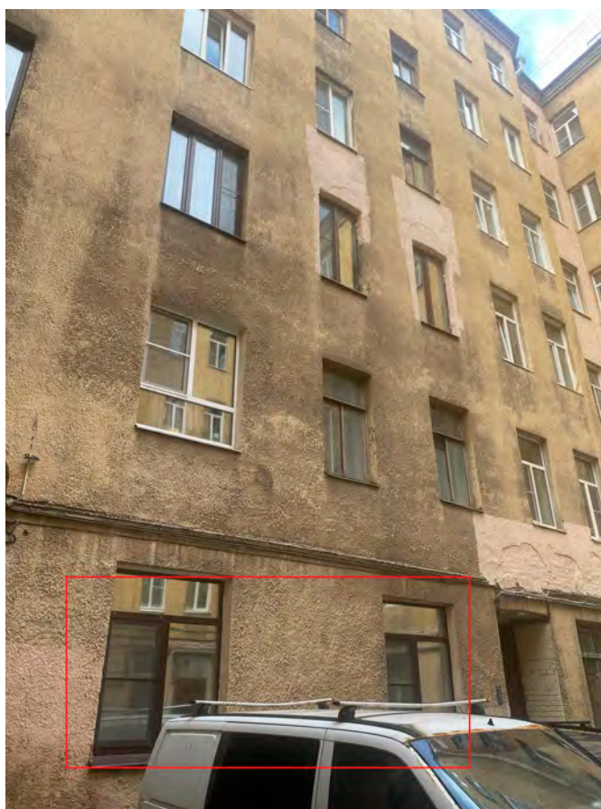
2. Фрагмент дворового фасада выявленного объекта культурного наследия «Дом Ф.В. Шеффера»
