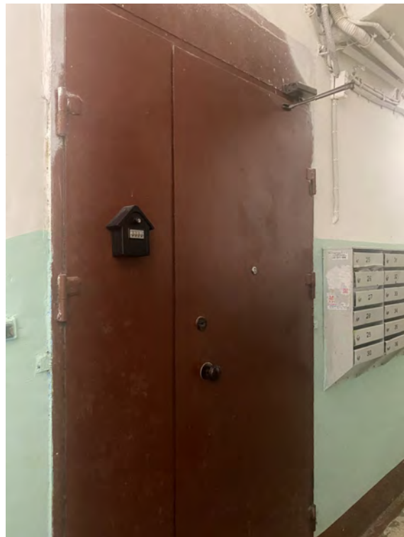
17. Входная дверь со лестничной клетки квартиры 25
