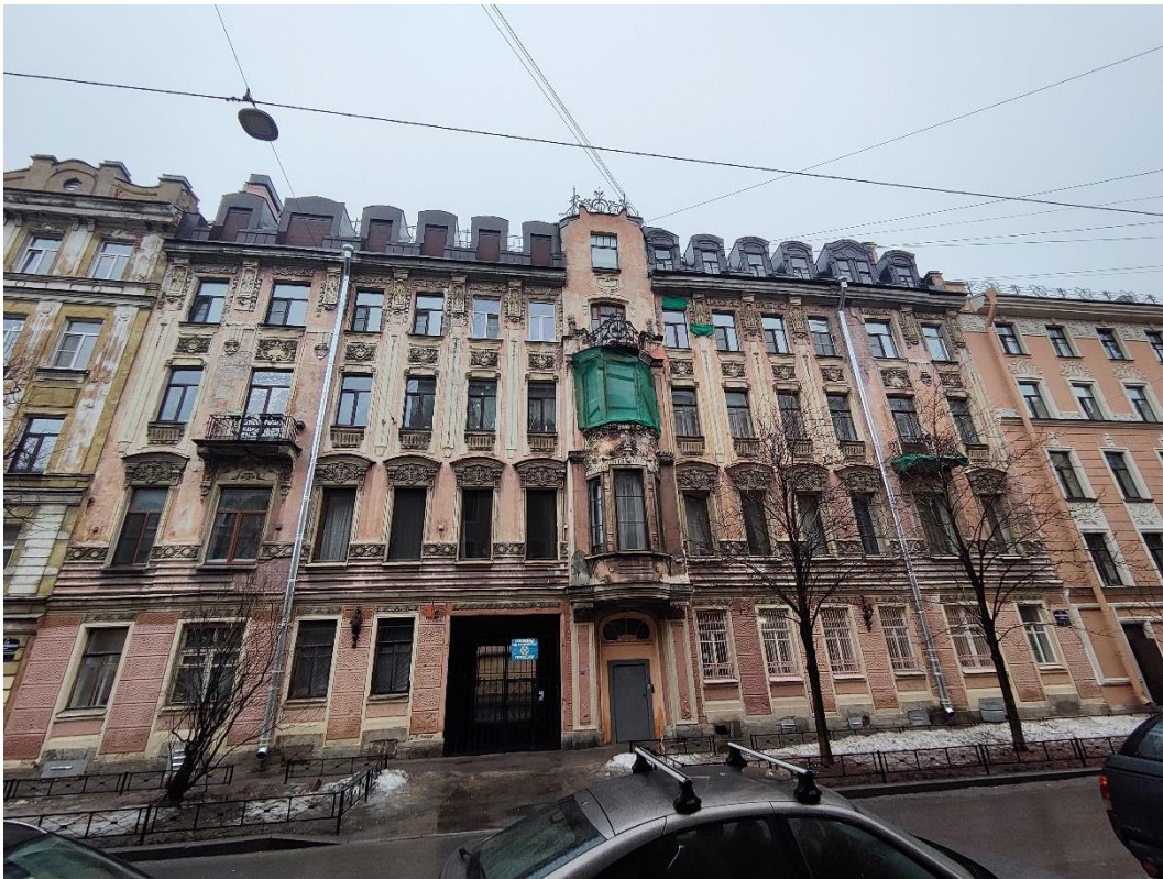
1. «Дом Е.Е. Глухарева», 1905г., 7-я Красноармейская ул., д.7, лит. А. Южный фасад. Общий вид. Фото 16.02.2024г.
