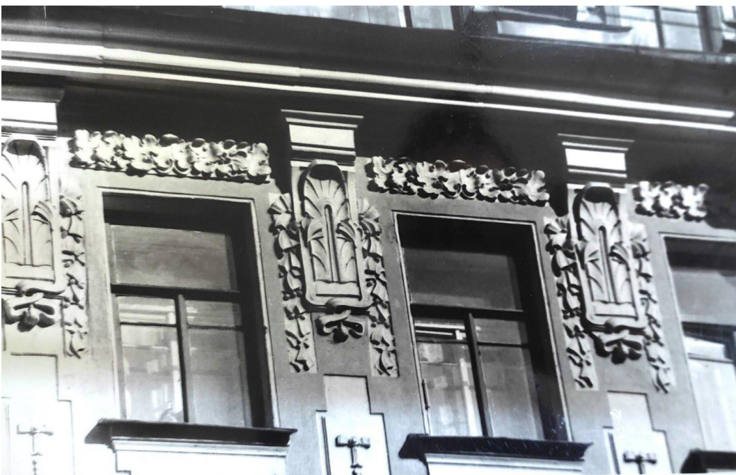
35. Декоративная отделка фасада на уровне 4-го этажа. Фотография. 1990 г. Институт «ЛенжилНИИпроект». Сектор хранения документированной информации Управления организационного обеспечения и контроля КГИОП.
