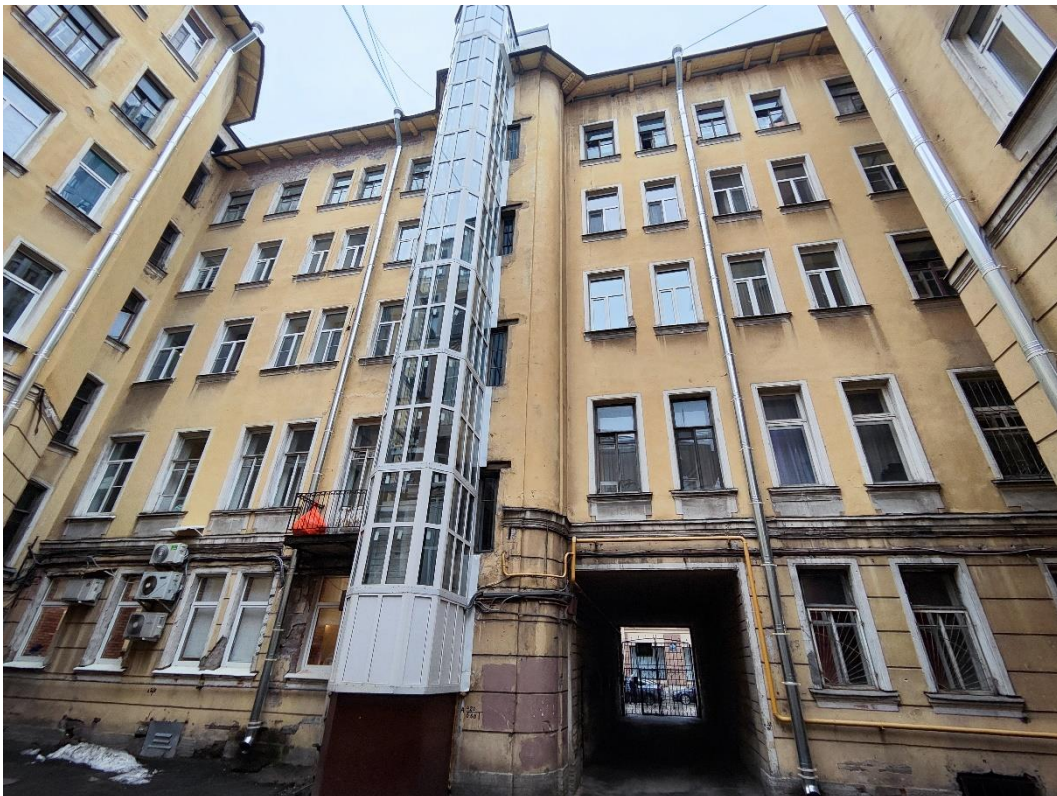
4. «Дом Е.Е. Глухарева», 1905г., 7-я Красноармейская ул., д.7, лит. А. Дворовый фасад. Общий вид. Фото 16.02.2024г.
