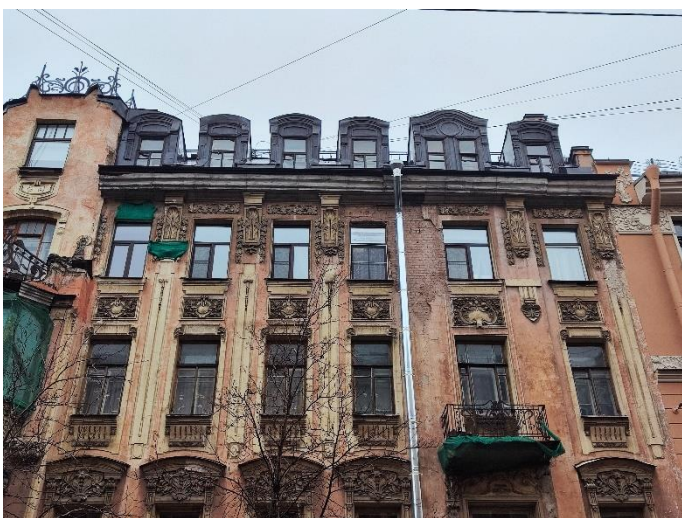
13. «Дом Е.Е. Глухарева», 1905г., 7-я Красноармейская ул., д.7, лит. А. Южный фасад. Фрагмент. Фото 16.02.2024г.
