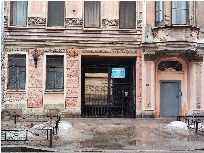
9. «Дом Е.Е. Глухарева», 1905г., 7-я Красноармейская ул., д.7, лит. А. Южный фасад. Фрагмент. Фото 16.02.2024г.
