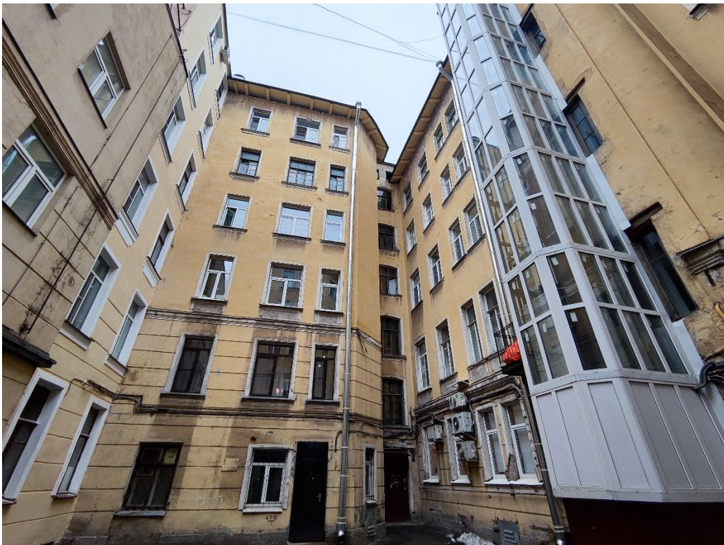
2. «Дом Е.Е. Глухарева», 1905г., 7-я Красноармейская ул., д.7, лит. А. Дворовый фасад. Общий вид. Фото 16.02.2024г.
