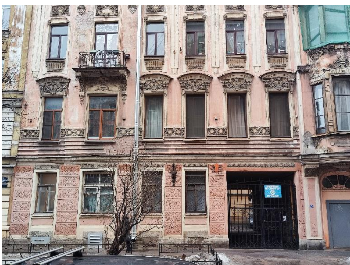
7. «Дом Е.Е. Глухарева», 1905г., 7-я Красноармейская ул., д.7, лит. А. Южный фасад. Фрагмент. Фото 16.02.2024г.
