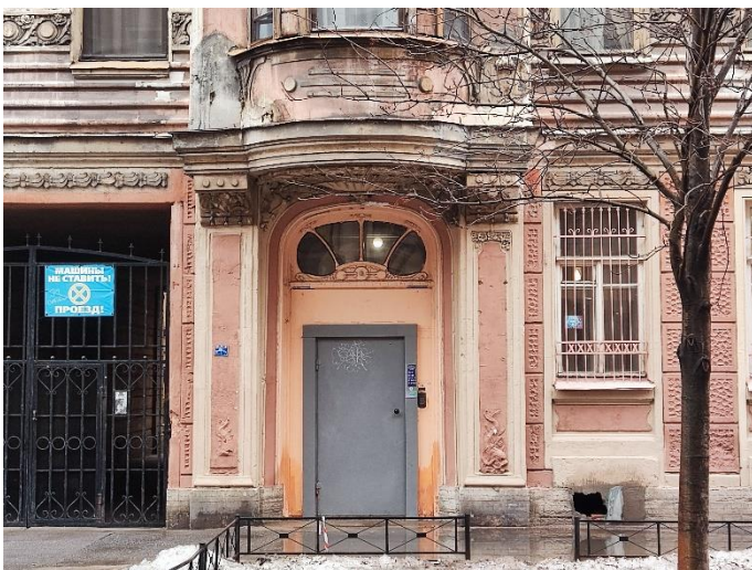
10. «Дом Е.Е. Глухарева», 1905г., 7-я Красноармейская ул., д.7, лит. А. Южный фасад. Фрагмент. Фото 16.02.2024г.
