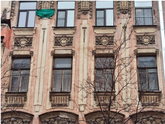
15. «Дом Е.Е. Глухарева», 1905г., 7-я Красноармейская ул., д.7, лит. А. Южный фасад. Фрагмент. Фото 16.02.2024г.
