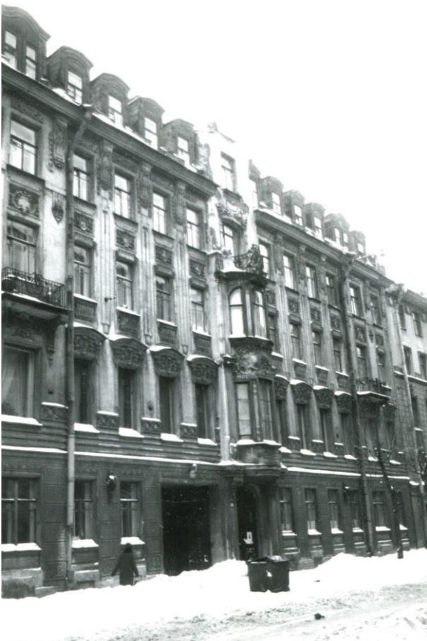
29. Главный фасад. Общий вид. 1983 г. ЦГАКФФД СПб (инв. № Ар 217605).
