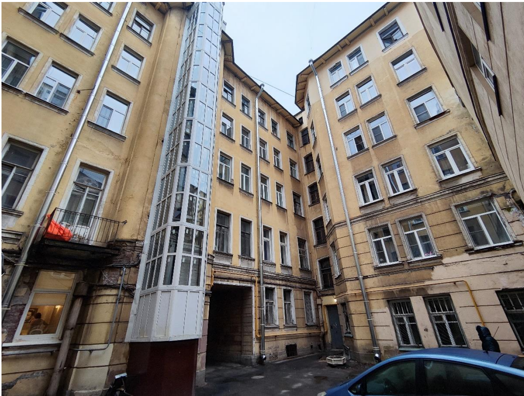
3. «Дом Е.Е. Глухарева», 1905г., 7-я Красноармейская ул., д.7, лит. А. Дворовый фасад. Общий вид. Фото 16.02.2024г.
