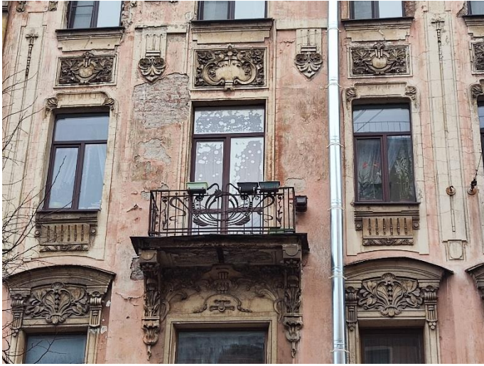
8. «Дом Е.Е. Глухарева», 1905г., 7-я Красноармейская ул., д.7, лит. А. Южный фасад. Фрагмент. Фото 16.02.2024г.
