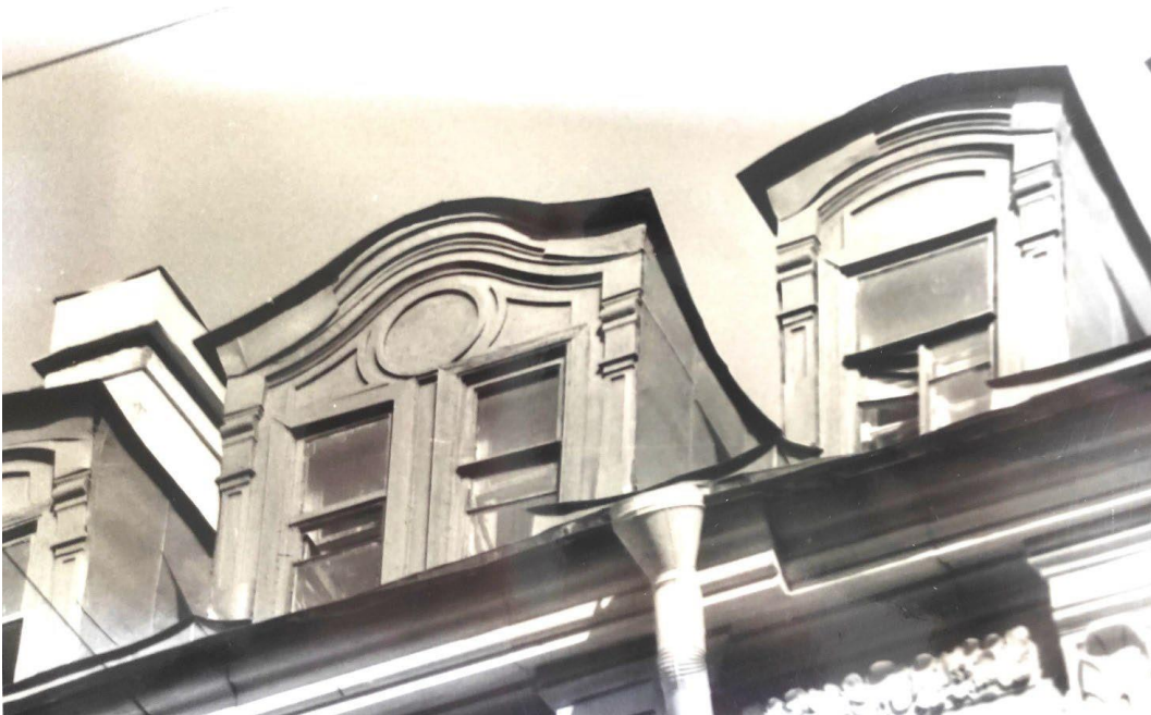
34. Оформление оконных проемов мансардного этажа. Фотография. 1990 г. Институт «ЛенжилНИИпроект». Сектор хранения документированной информации Управления организационного обеспечения и контроля КГИОП.
