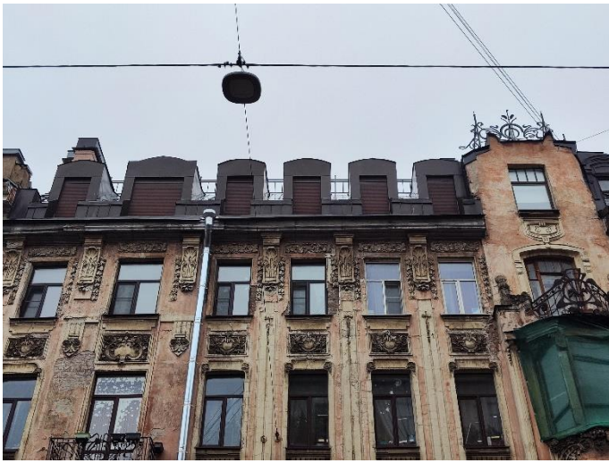
5. «Дом Е.Е. Глухарева», 1905г., 7-я Красноармейская ул., д.7, лит. А. Южный фасад. Фрагмент. Фото 16.02.2024г.
