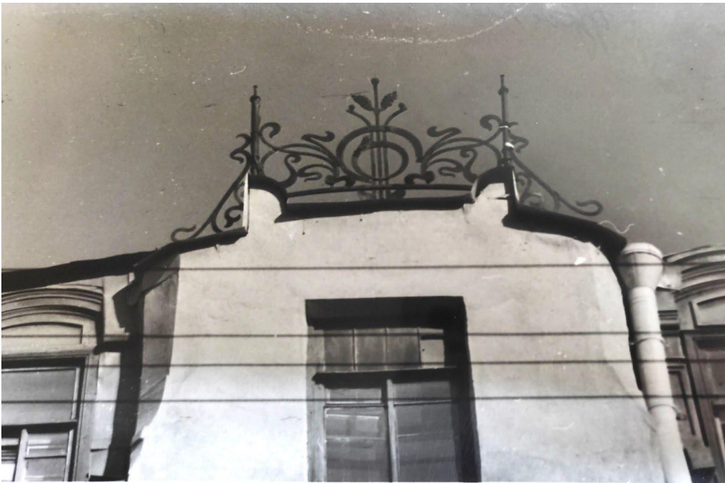
38. Декоративное оформление аттика по центральной оси лицевого фасада. Фотография. 1990 г. Институт «ЛенжилНИИпроект». Сектор хранения документированной информации Управления организационного обеспечения и контроля КГИОП.
