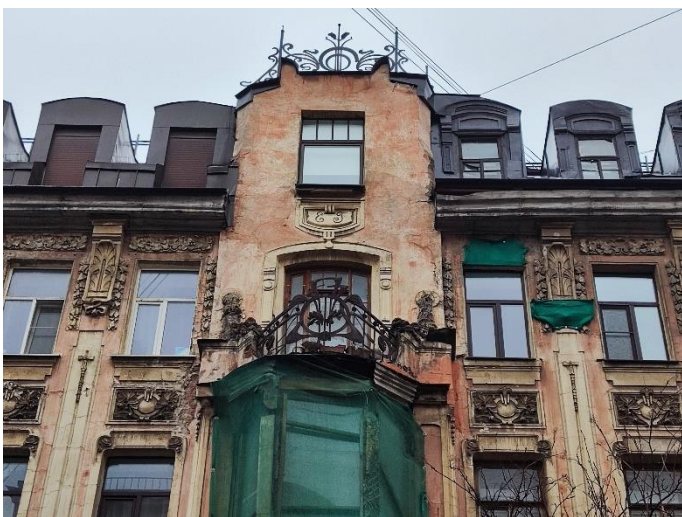
11. «Дом Е.Е. Глухарева», 1905г., 7-я Красноармейская ул., д.7, лит. А. Южный фасад. Фрагмент. Фото 16.02.2024г.
