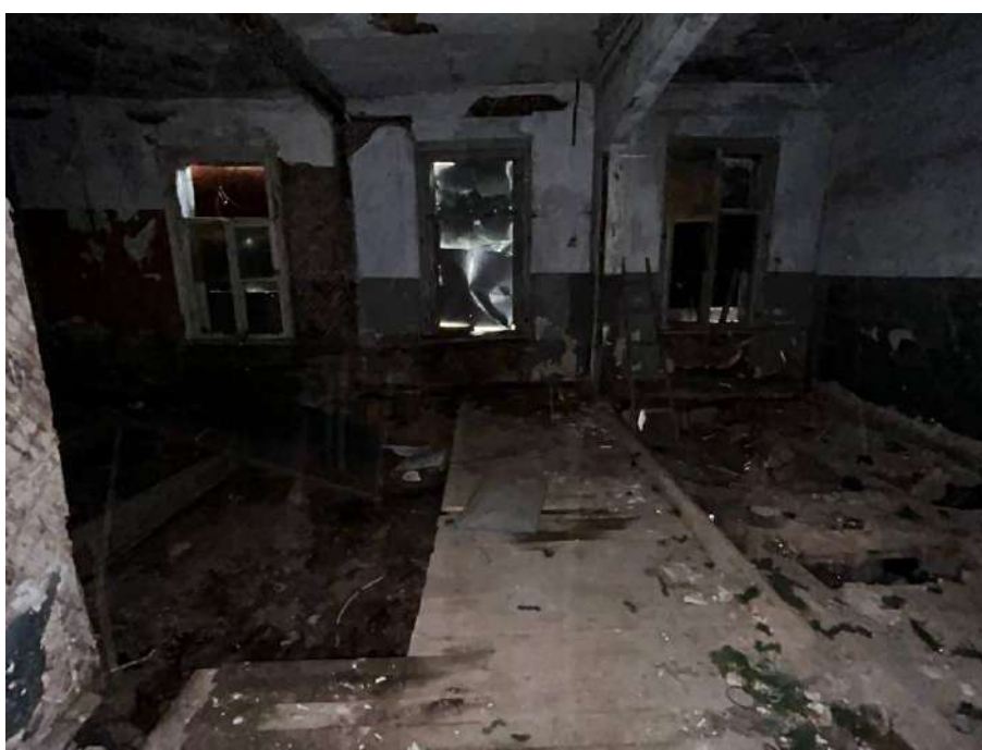
Фото №18. Внутреннее помещение здания.
