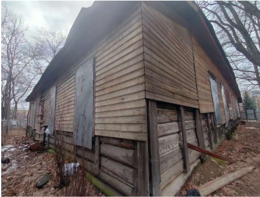
Фото №3. Вид на северный и западный фасады здания, в направлении с северо-запада на юго-восток.
