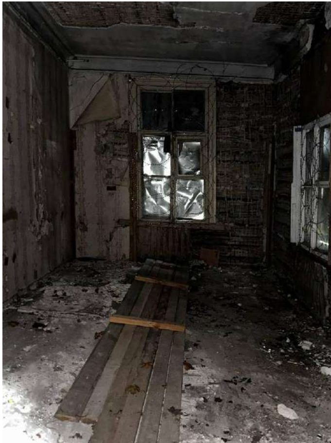
Фото №13. Внутреннее помещение здания.
