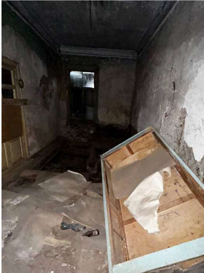
Фото №23. Внутреннее помещение здания.
