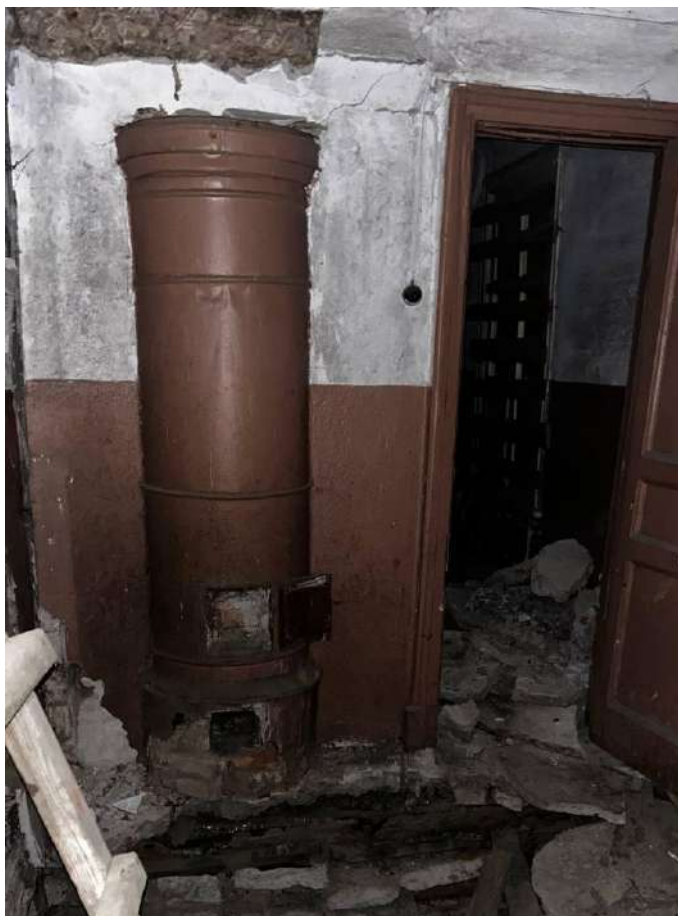
Фото №26. Внутреннее помещение здания.
