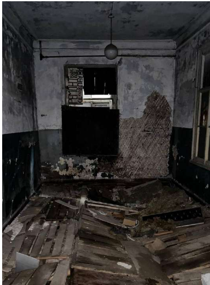
Фото №16. Внутреннее помещение здания.
