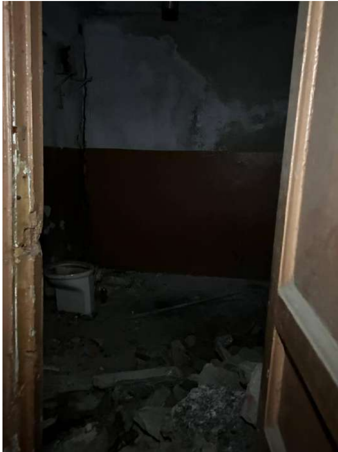
Фото №27. Внутреннее помещение здания.
