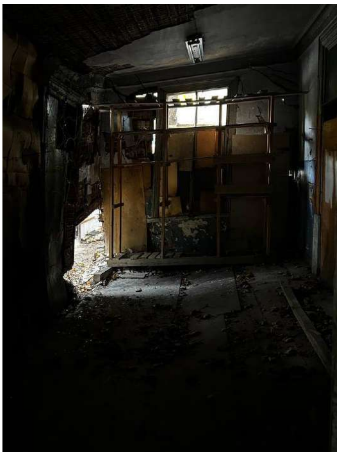
Фото №11. Внутреннее помещение здания.
