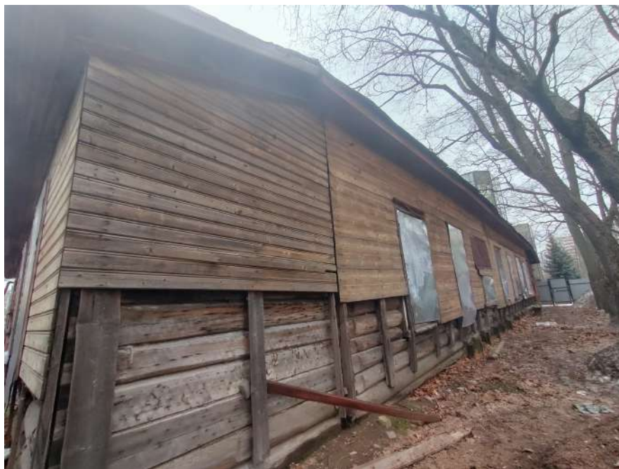
Фото №4. Фрагмент западного фасада здания.
