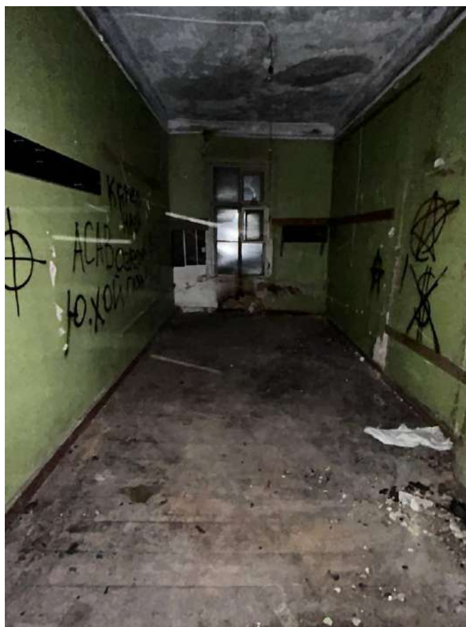
Фото №22. Внутреннее помещение здания.
