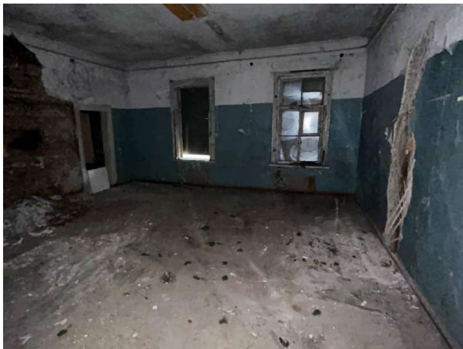
Фото №21. Внутреннее помещение здания.
