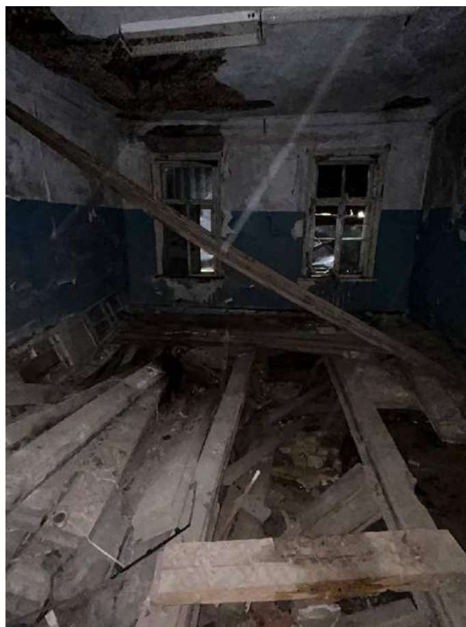
Фото №20. Внутреннее помещение здания.
