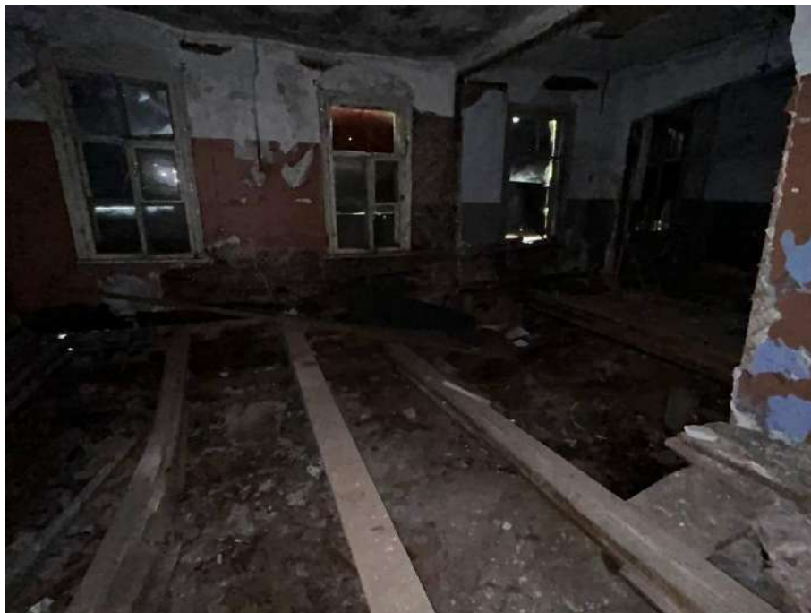
Фото №19. Внутреннее помещение здания.
