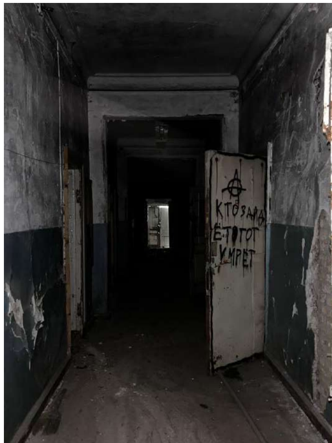
Фото №28. Внутреннее помещение здания, коридор.
