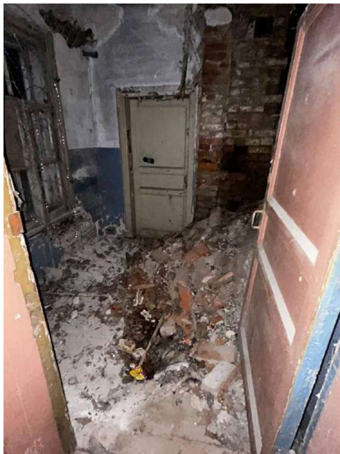
Фото №24. Внутреннее помещение здания.
