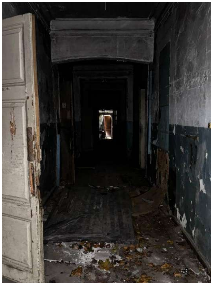
Фото №14. Внутреннее помещение здания, коридор.
