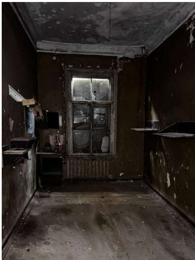
Фото №17. Внутреннее помещение здания.
