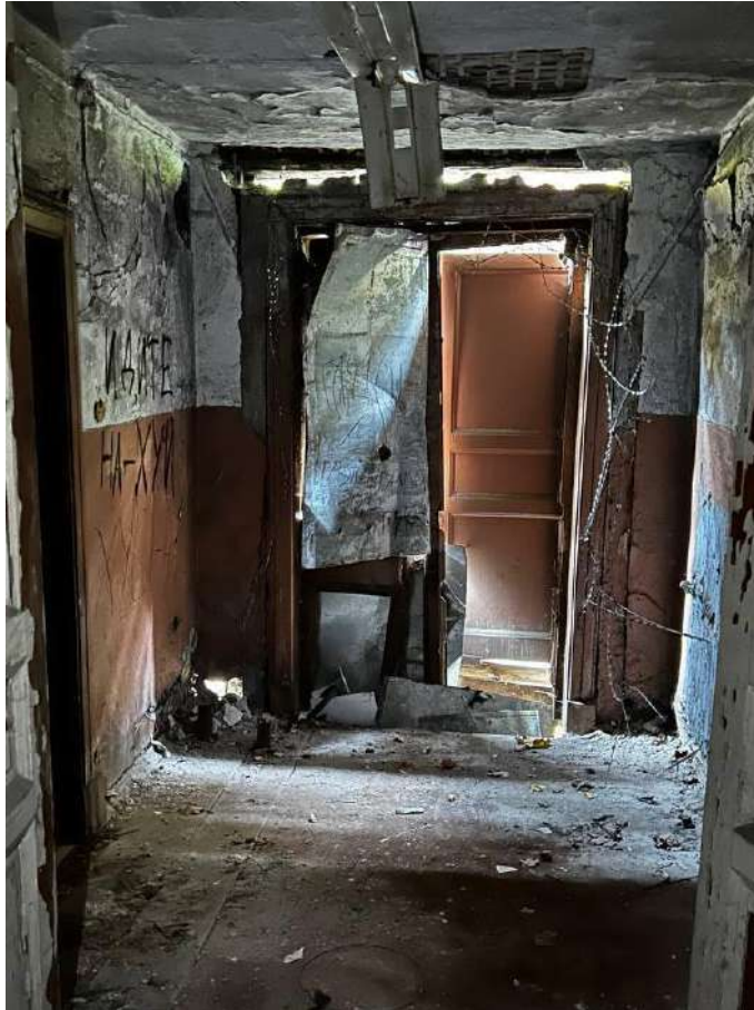
Фото №25. Внутреннее помещение здания, коридор, вход в здание с северного фасада.
