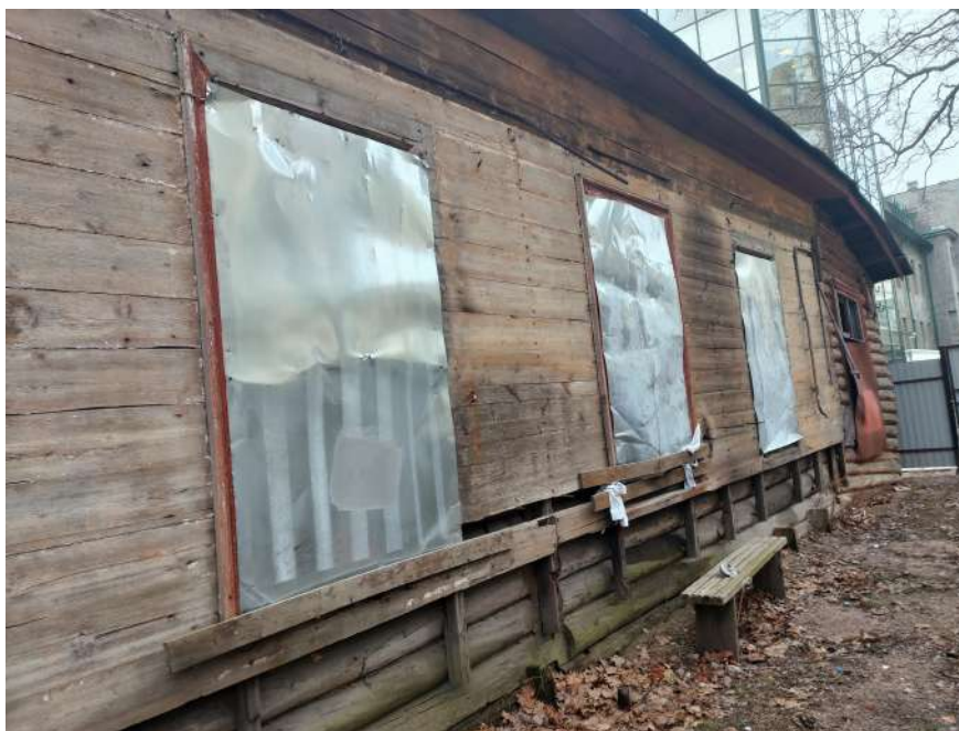
Фото №6. Фрагмент западного фасада здания, вид в направлении с запада на юг.
