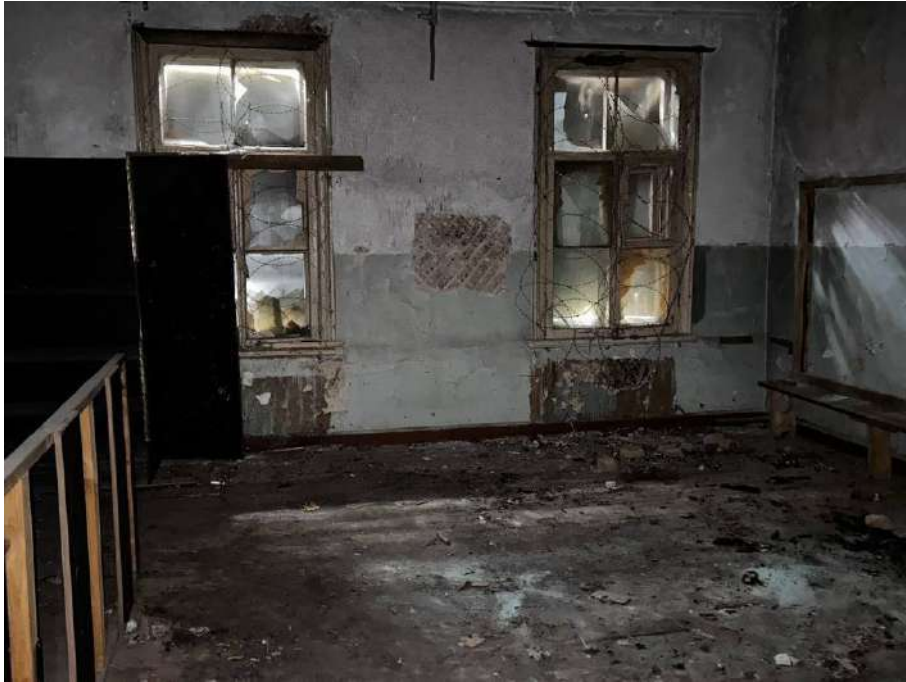
Фото №15. Внутреннее помещение здания.
