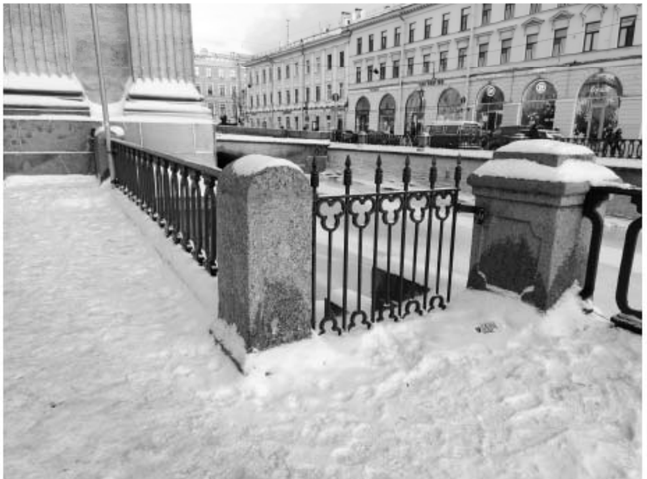
23. Фрагмент ограждения набережной Канала Грибоедова.
