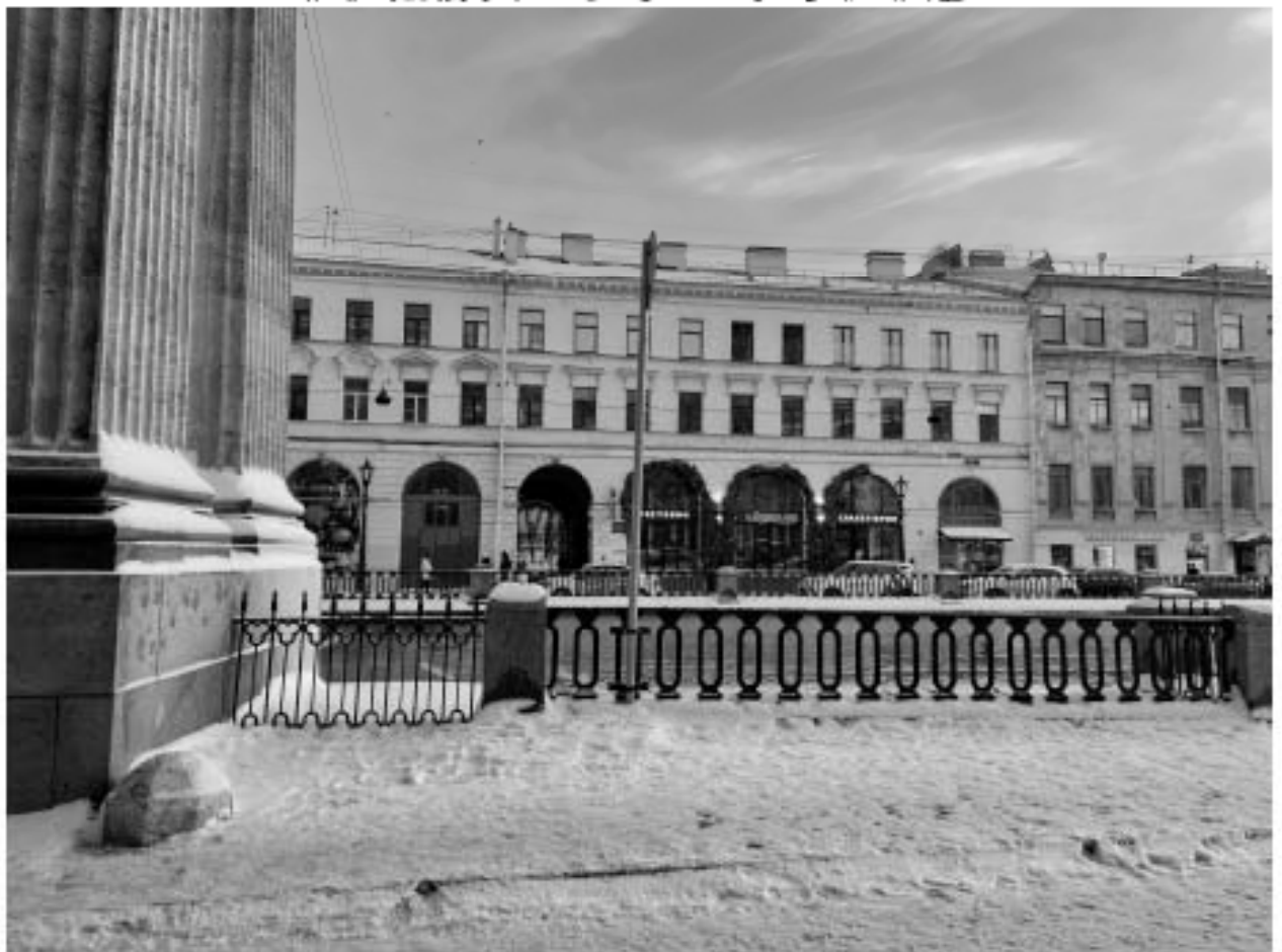
22. Фрагмент ограждения набережной Канала Грибоедова.
