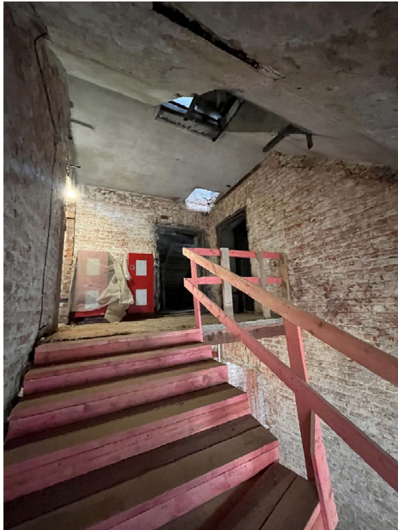
Фото №22. ЛК1, вид на площадку чердака.
