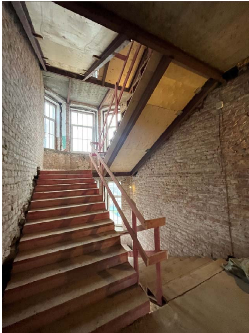
Фото №16. ЛК1, 4 этаж, вид на площадку между 4-ым и 5-ым этажом.
