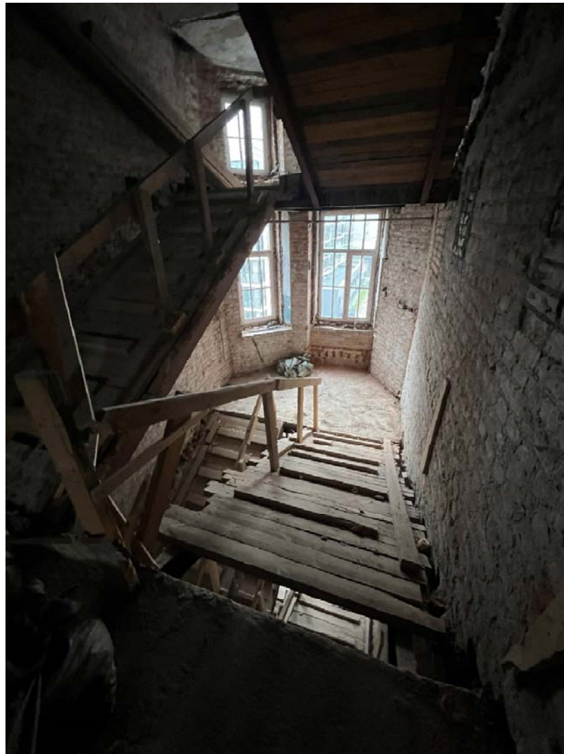
Фото №24. ЛК2. Вид на площадку между 5-ым и 6-ым этажом.
