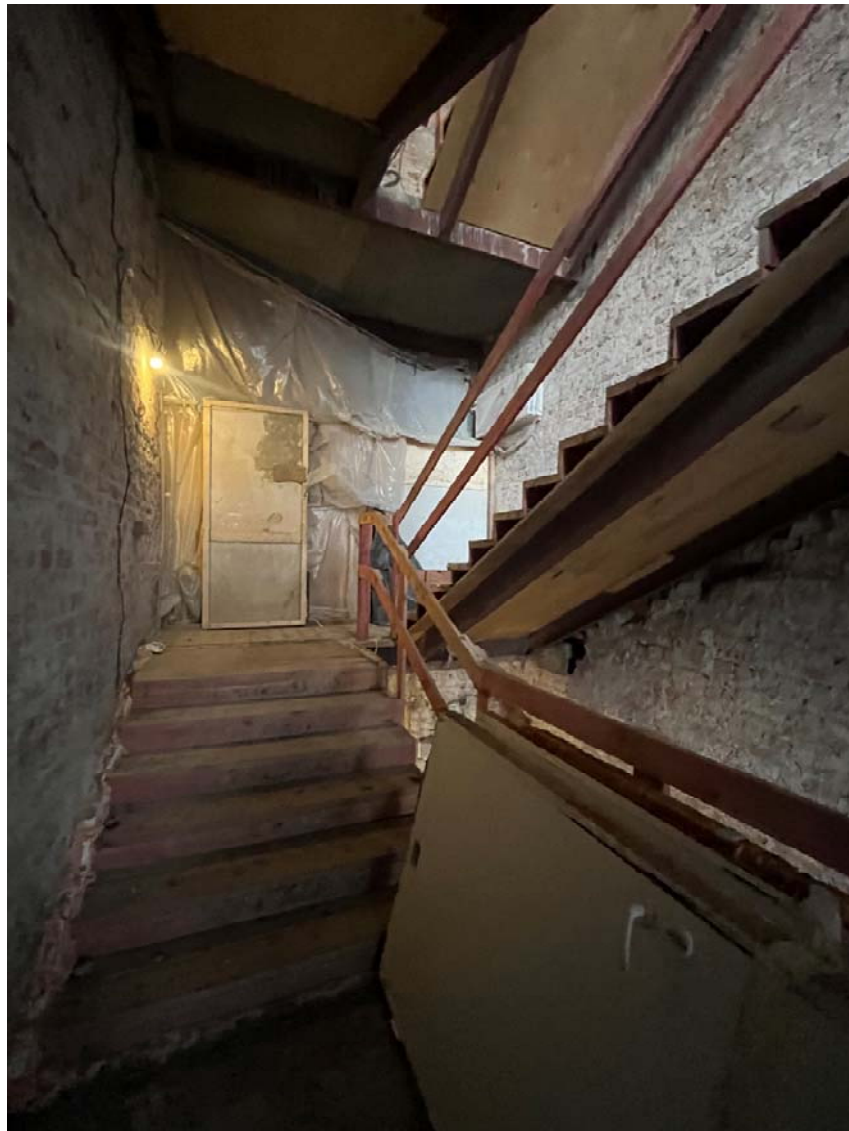
Фото №7. ЛК1, вид на площадку первого этажа.
