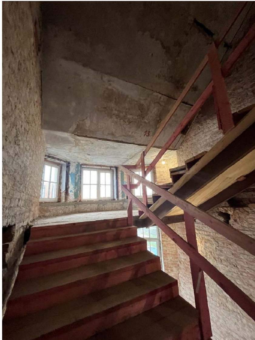
Фото №21. ЛК1, вид на площадку между 6-ым и чердаком.
