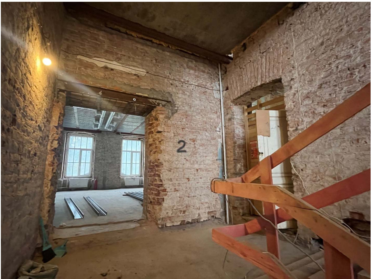
Фото №11. ЛК1, площадка 2-го этажа.
