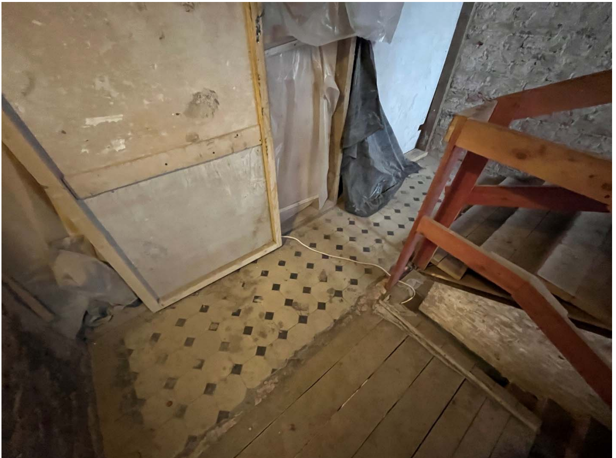
Фото №8. ЛК1, покрытие площадки первого этажа.
