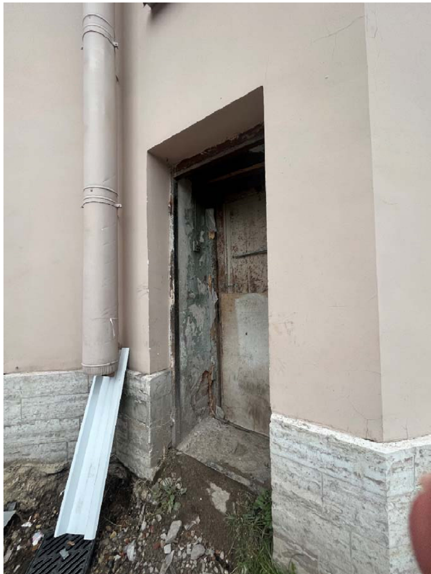
Фото №5. Юго-восточный дворовой фасад, вход в ЛК1.
