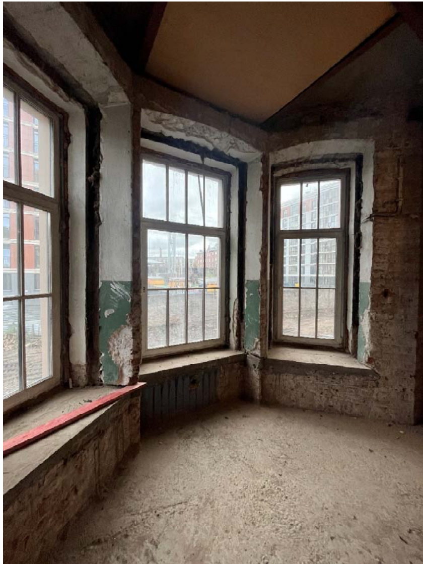
Фото №10. ЛК1, площадка между 1-ым и 2-ым этажом.
