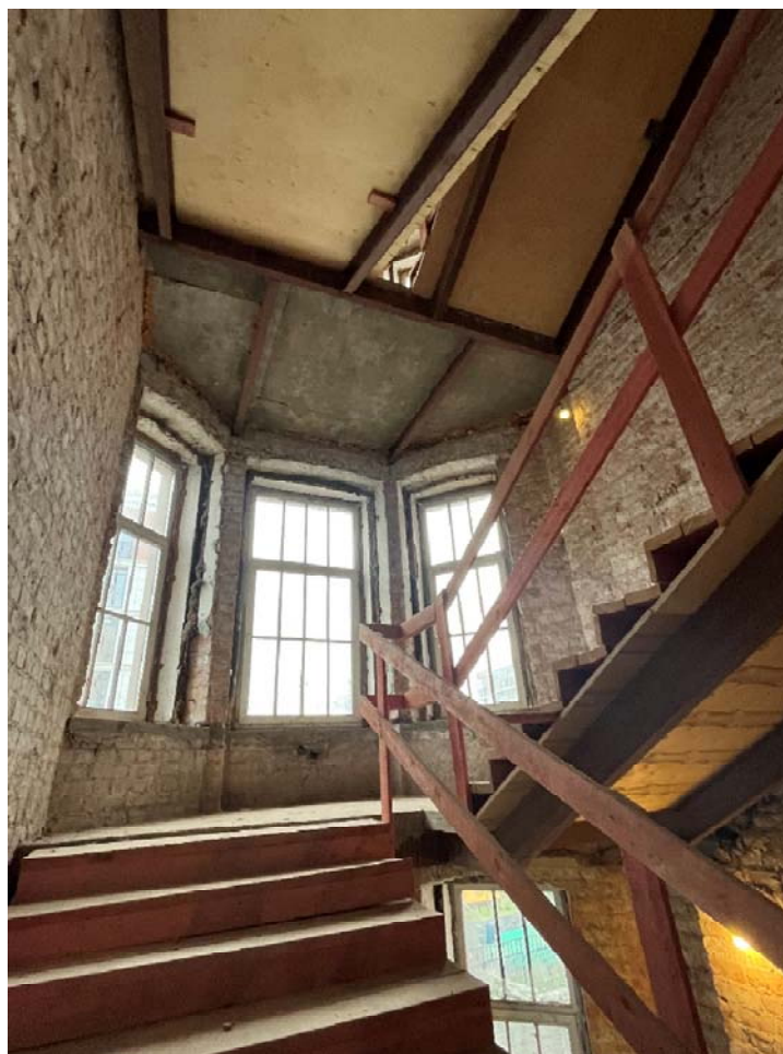
Фото №12. ЛК1, вид на площадку между 2-ым и 3-им этажом.
