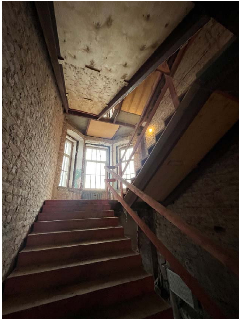
Фото №9. ЛК1, вид на площадку между 1-ым и 2-ым этажом.
