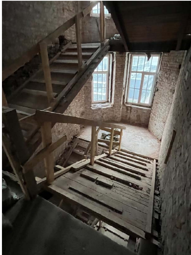
Фото №26. ЛК2. 5-ый этаж, вид на площадку между 4-ым и 5-ым этажом.
