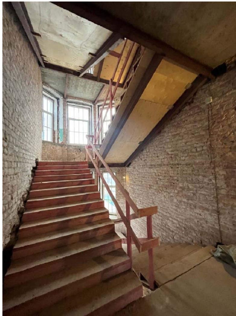
Фото №14. ЛК1, 3-ий этаж, вид на площадку между 3-им и 4-ым этажом.
