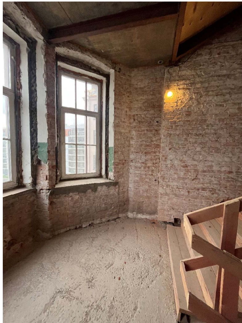
Фото №17. ЛК1, площадка между 4-ым и 5-ым этажом.
