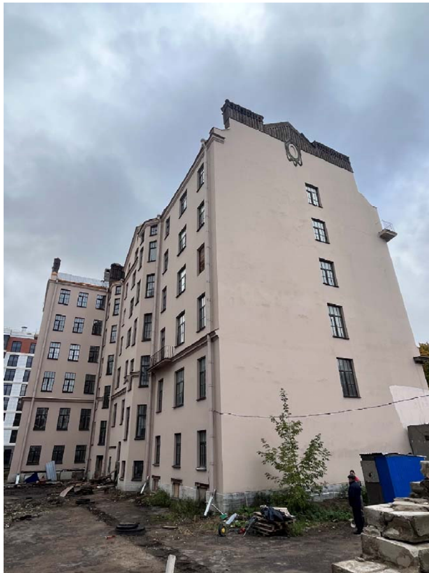
Фото №3. Северо-восточный торцевой фасад.
