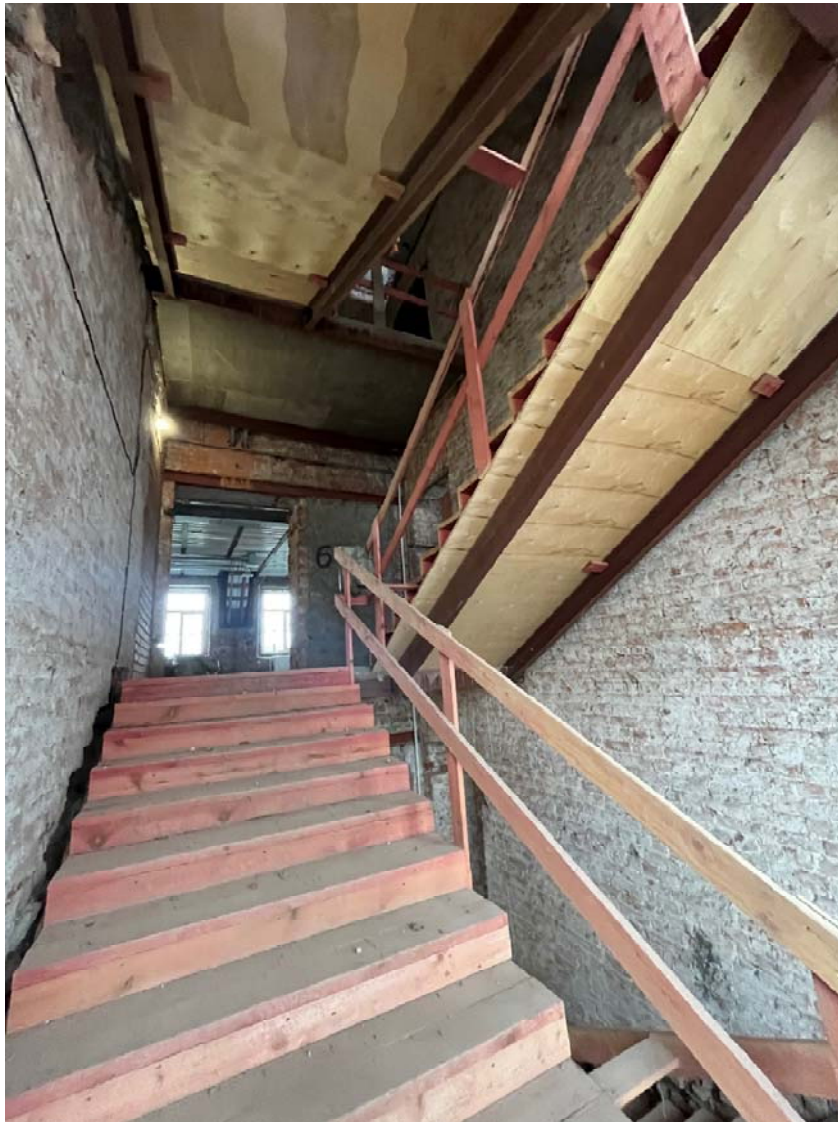
Фото №20. ЛК1, вид на площадку 6-го этажа.
