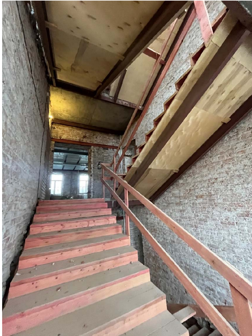
Фото №18. ЛК1, вид на площадку 5-го этажа.
