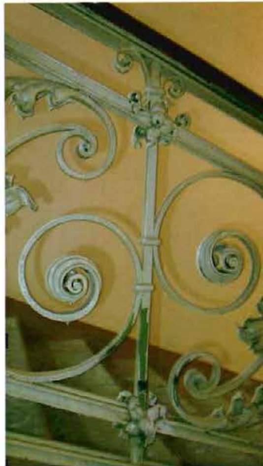
9. Внутренняя планировочная структура объекта культурного наследия. Фрагмент кованного ограждения центральной лестничной клетки.
