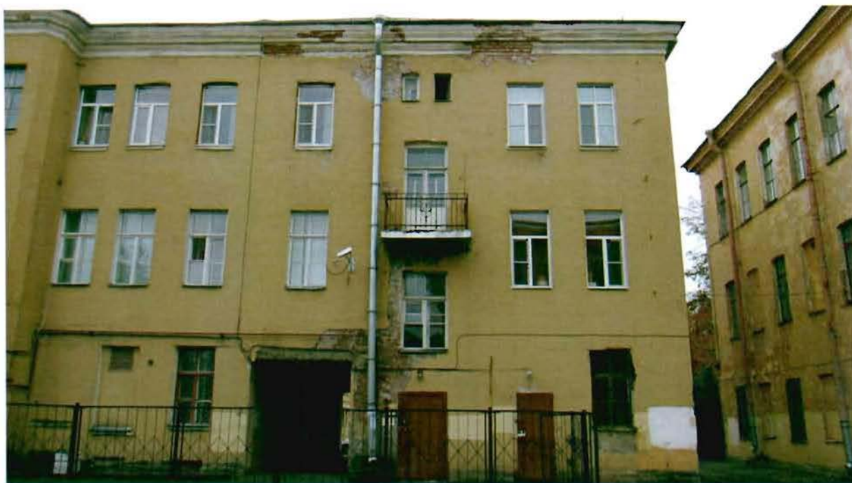
3. Фрагмент северного фасада объекта культурного наследия. Западная часть.
