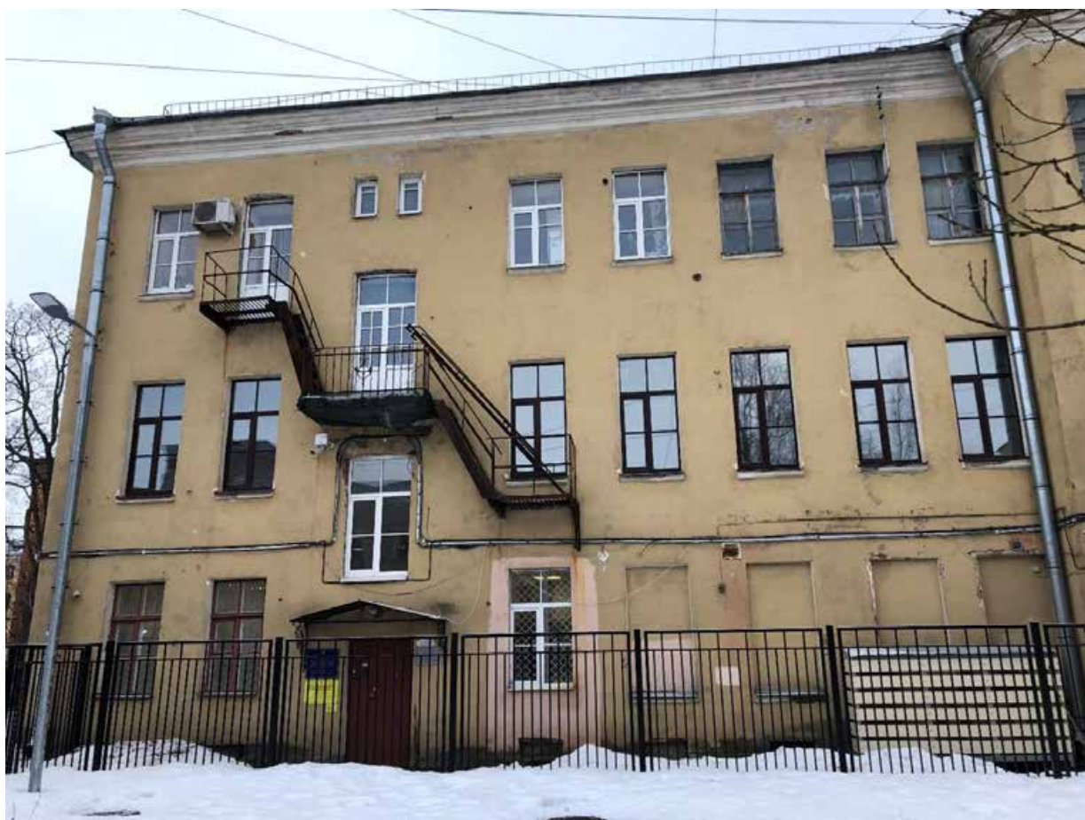
Фото 7. Часть дворового фасада.
