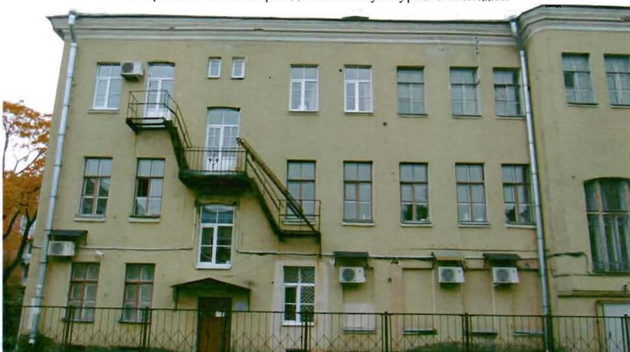
2. Фрагмент северного фасада объекта культурного наследия. Восточная часть.
