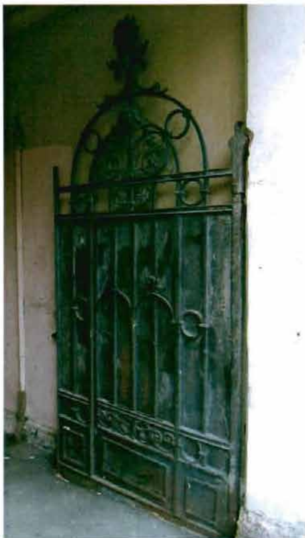
6. Восточная створка ворот объекта культурного наследия
