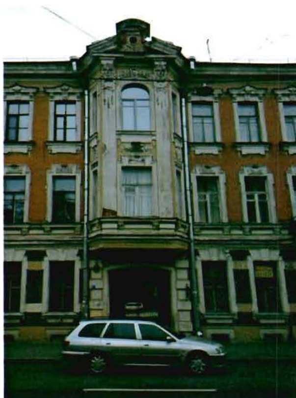
5. Фрагмент южного фасада объекта культурного наследия.
