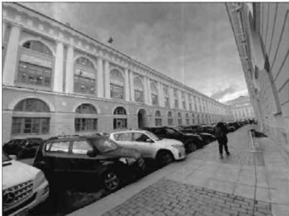
10. Лицевой фасад (ул. Звездного Росси). Фото от 19.11.2021 г.
