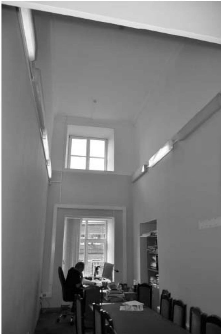
Фото 6. 3 этаж, пом. 28-Н (34), под пом. 38-Н (33).
