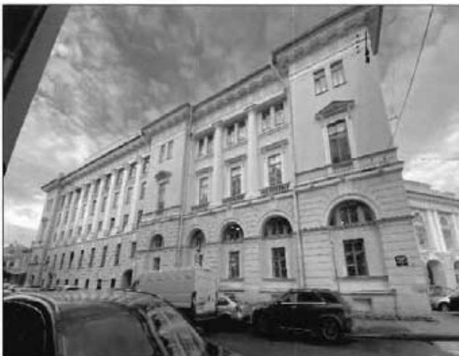
4. Общий вид на южный фасад со стороны Торгового переулка. Фото от 19.11.2021 г.
