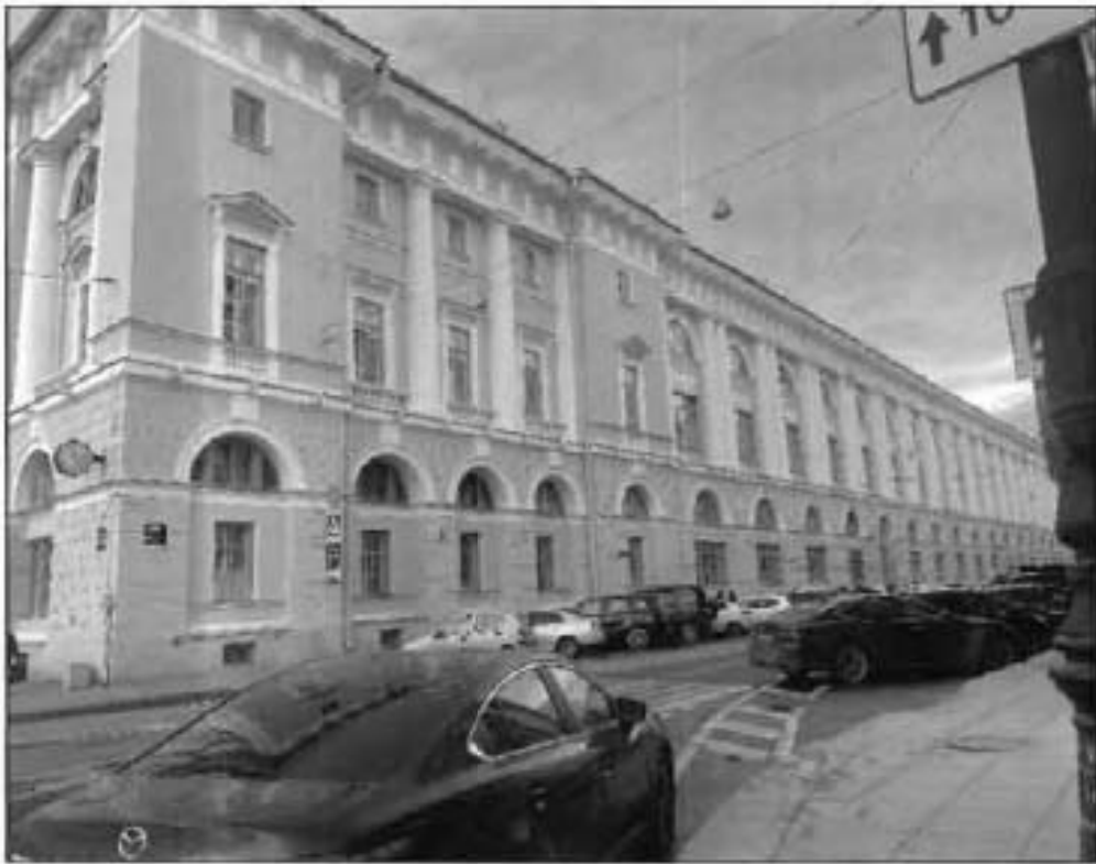
9. Лицевой фасад (ул. Звездного Росси). Фото от 19.11.2021 г.
