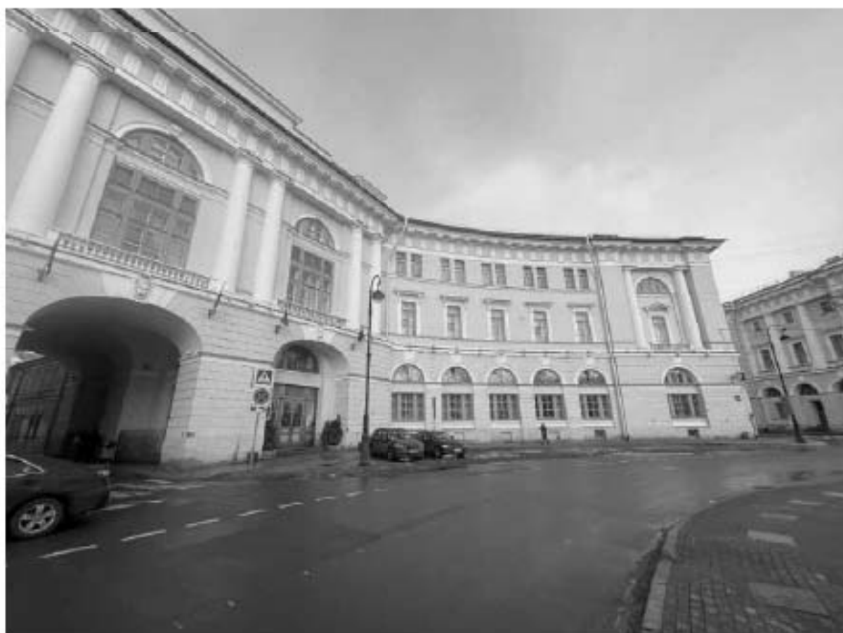
Фото 1. Юго-восточный лицевой фасад, обращен на площадь Ломоносова.
