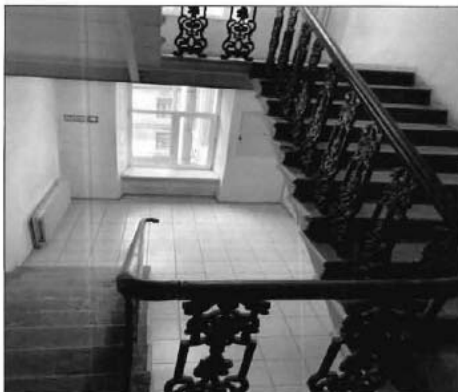
45. Двухмаршевая служебная лестница в юго-западной части корпуса по пл. Островского пом. 37-Н в уровне 3-го этажа. Фото от 19.11.2021 г.
