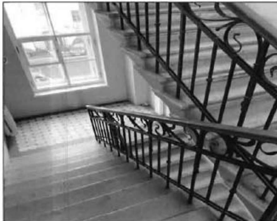
30. . Служебная двухмаршевая лестница (2ЛК). Метлахская плитка лестничных площадок. Фото от 16.11.2021 г.
