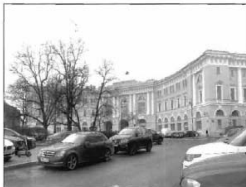
2. Южный фасад объекта культурного наследия, вид со стороны пл. Ломоносова. Фото от 19.11.2021 г.
