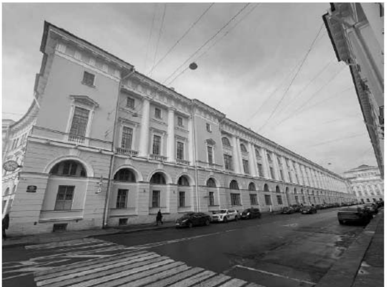
Фото 2. Юго-восточный лицевой фасад, обращен на площадь Ломоносова.
