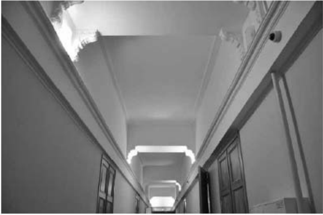
Фото 2. 3 этаж. пом. 28-Н, коридор.
