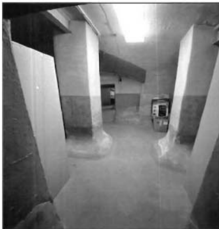
52. Пилоны подвальных помещений. Фото от 19.11.2021 г.
