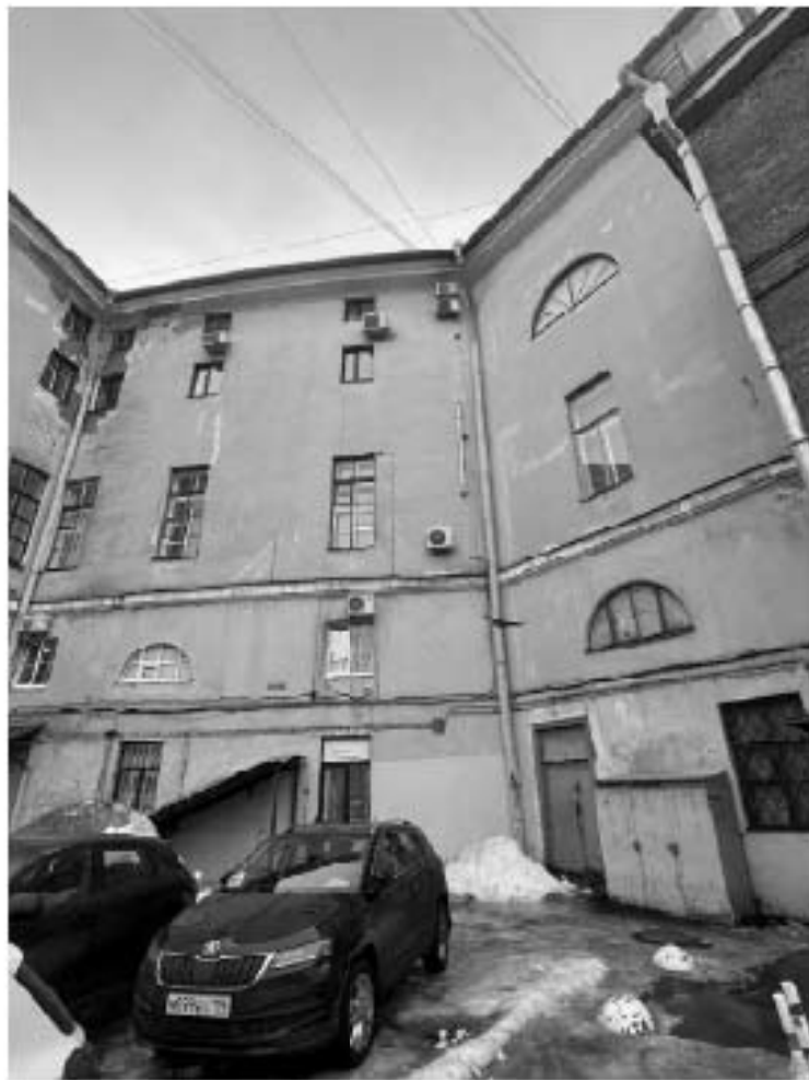
Фото 3. Южный дворовый фасад.
