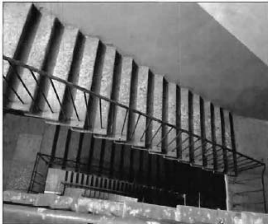
42. Двухмаршевая лестница (центральный дворовый флигель (центральный внутренний двор № 1). Фото от 17.11.2021 г.
