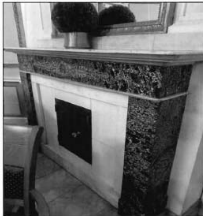
50. Фрагмент печи-камина, парного, углового, двухъярусного (пом. 27-Н (6)). Фото от 16.11.2021 г.
